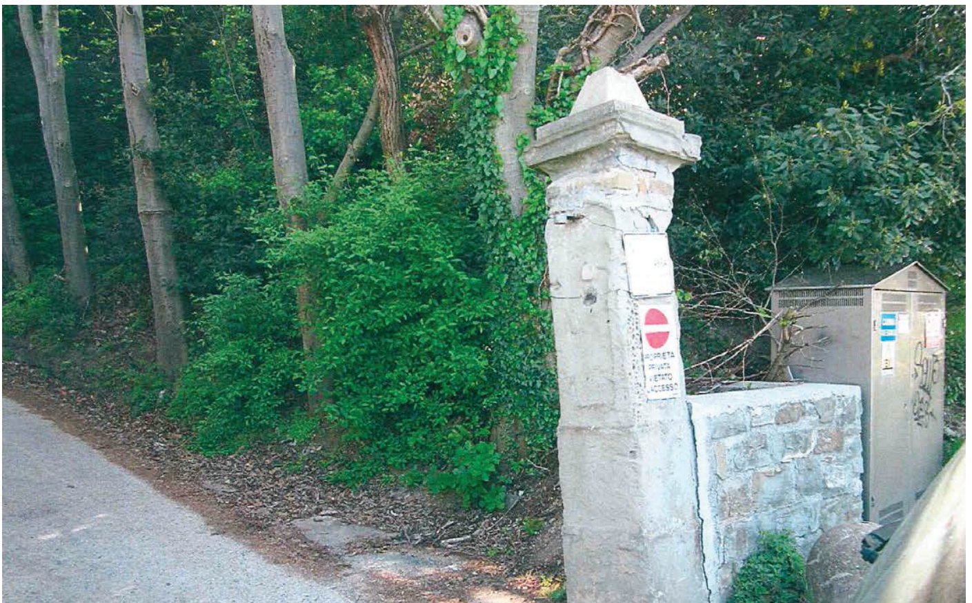
FOTO 06 - Accesso al lotto di intervento
