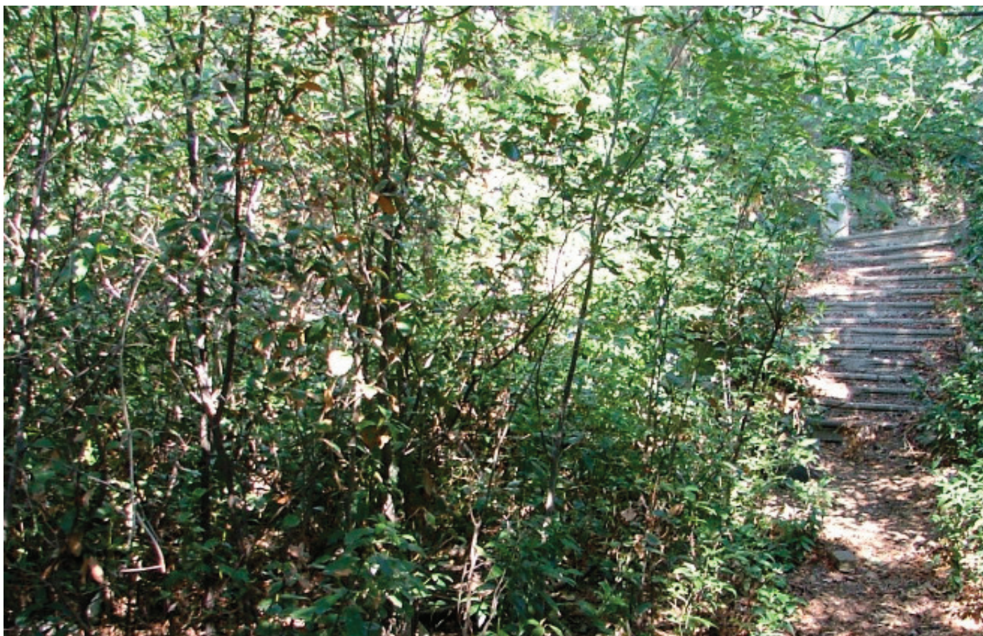
FOTO 18 - Scala dissestata e presenza di fitta vegetazione arbustiva
