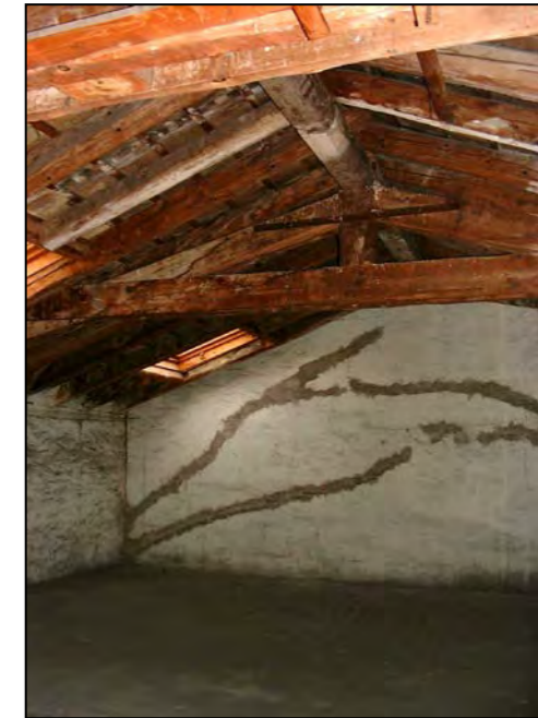
Struttura del tetto
