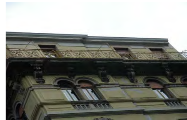
parapetto in ferro lavorato con motivo ornamentale all'ultimo piano
