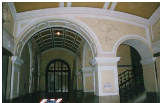
atrio d'ingresso (immagine alla data del rilievo)
