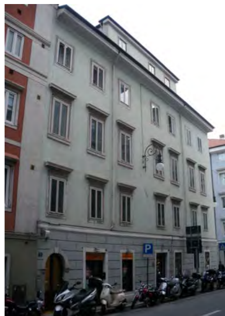
Facciata su via Milano
