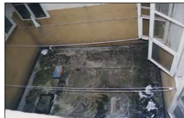
cavedio chiuso al primo piano (immagine alla data del rilievo)
