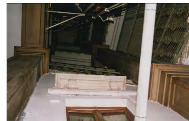
Vista del vuoto interno alla scala
