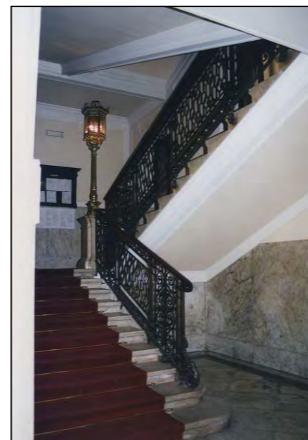
Scala a due rampe parallele e contrapposte
