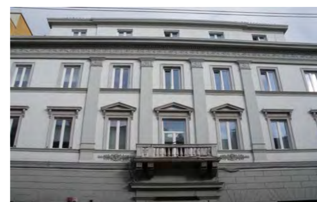
Parte centrale della facciata
