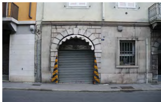
foratura del piano terra ad uso di un locale a parcheggio per autovetture
