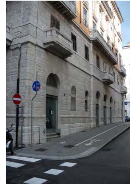
via Trento - particolare del basamento
