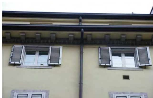
particolare della gronda e sottogronda
