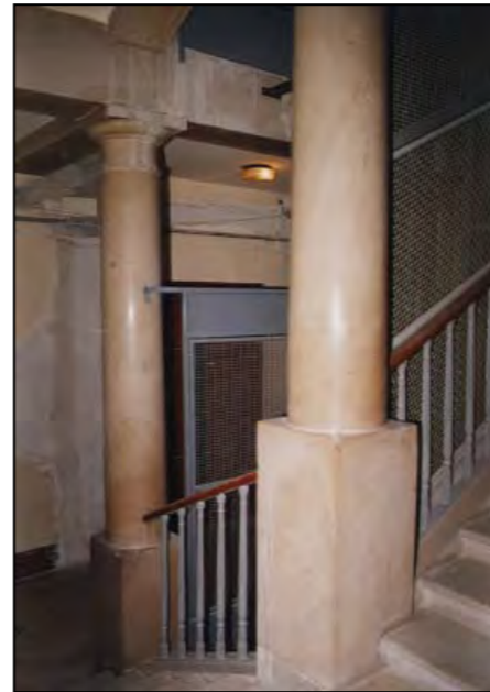
Vano scala a 3 rampe ortogonali con colonne agli angoli di giroscala (fotografia del 2000)
