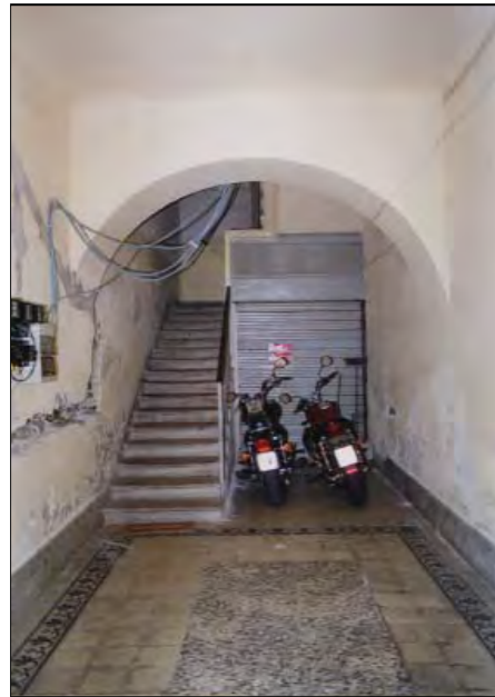
Atrio d'ingresso (immagine alla data del rilievo)
