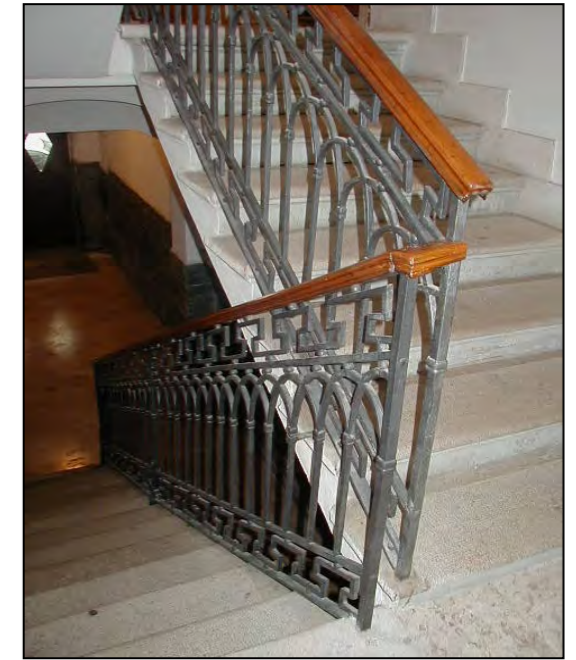
Particolare corpo scala
