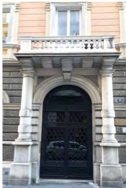
via P. da Palestrina 4 Portone d'ingresso
