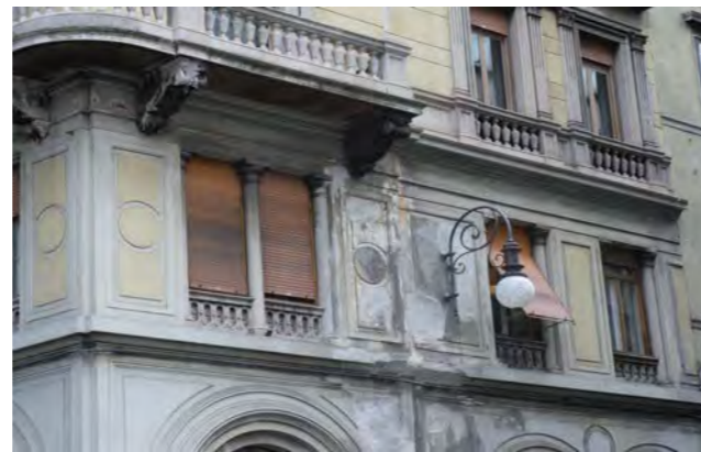
rappezzamento in facciata
