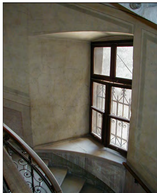
Finestra su vano scale
