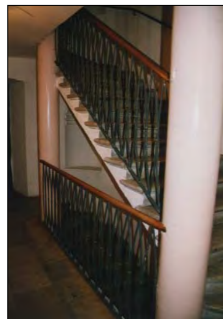
Scala e pianerottolo (immagine alla data del rilievo)
