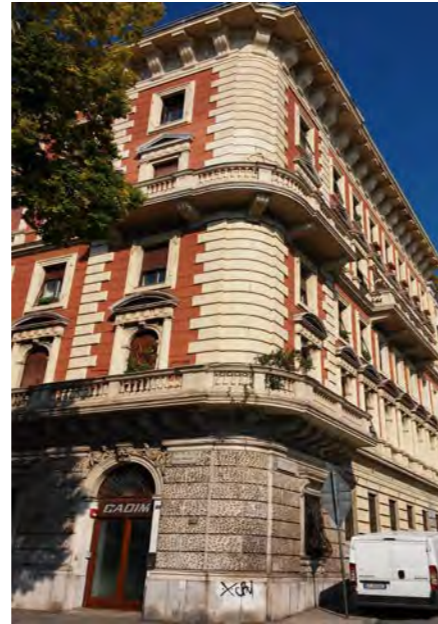
Soluzione d'angolo tra viale Miramare e via A. Gazzoletti
