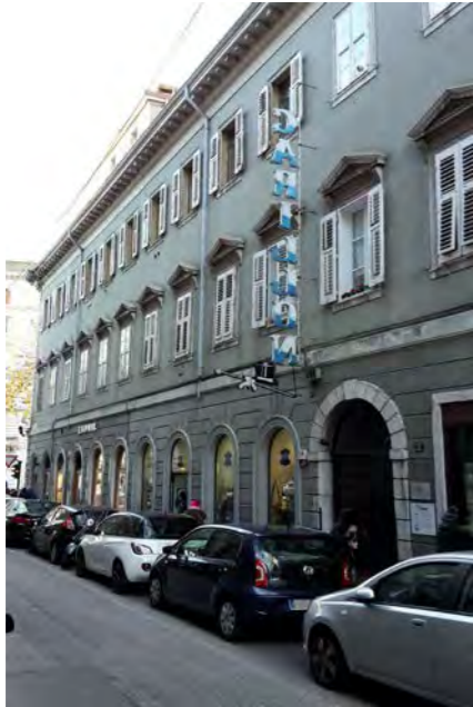
Facciata su Via San Francesco d'Assisi
