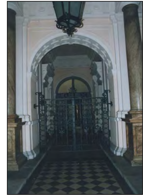
Androne alla corte con chiusura a cancello in ferro battuto
