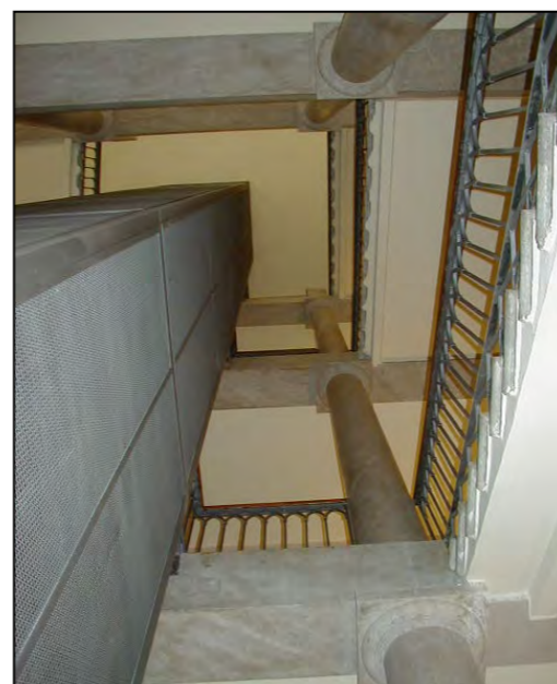
Vano scala con ascensore
