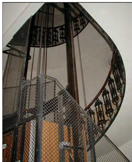
Corpo scala via Ghega 1
