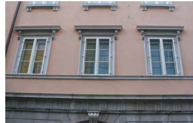
tipologia dei serramenti al primo piano
