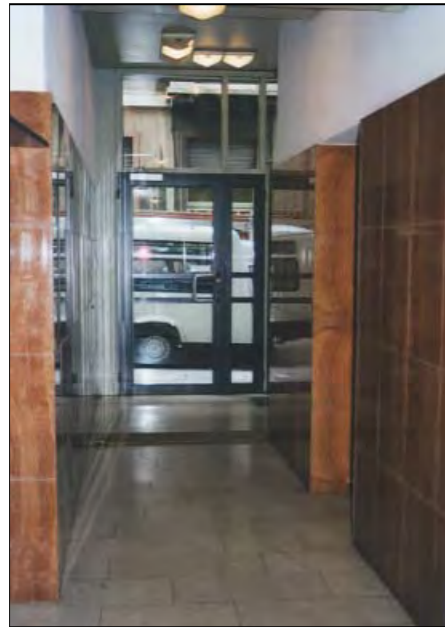
atrio d'ingresso (immagine alla data del rilievo)
