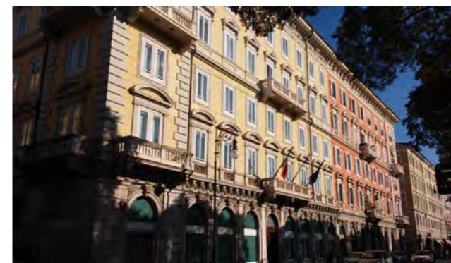
viale Miramare 19 e 17
