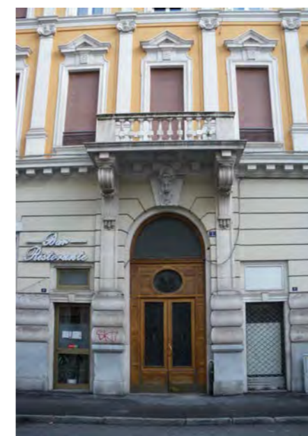
Ingresso sulla via B. Cellini
