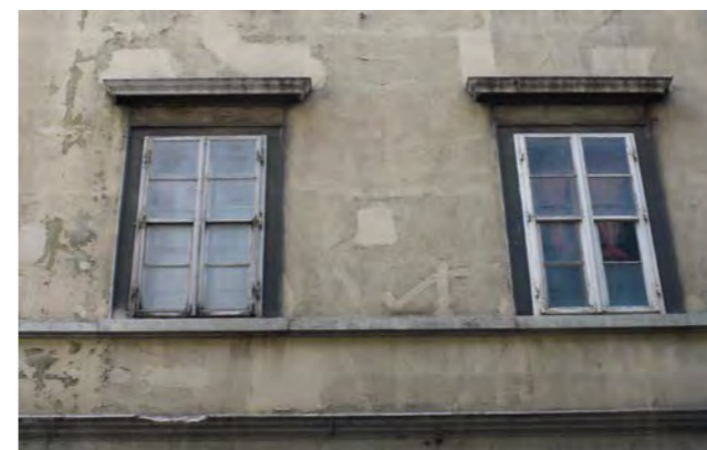
via Milano 13 - particolare di due serramenti di finestra con "sali-scendi" dello sportello inferiore
