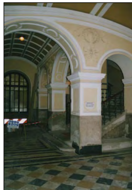
atrio d'ingresso (immagine alla data del rilievo)
