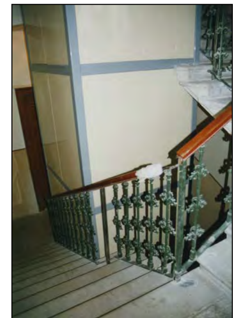
vano scala (immagine alla data del rilievo)
