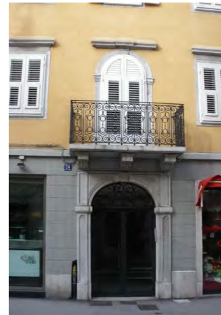
via Roma 24 - particolare dell'ingresso con sopostante balconcino e parapetto in ferro lavorato
