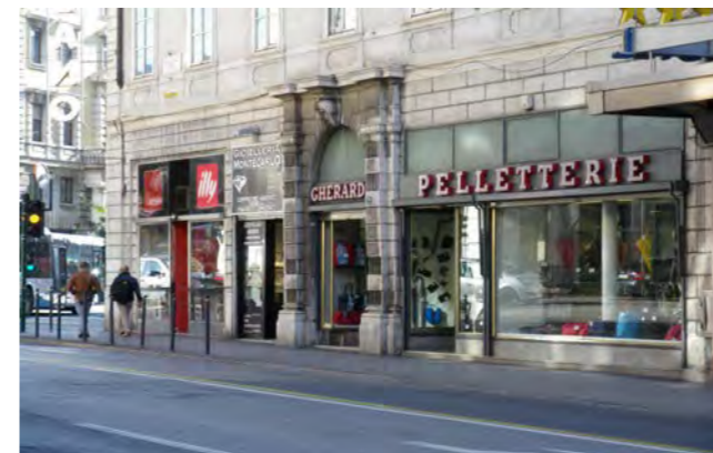
via C. Ghega 19 alterazione del piano terra
