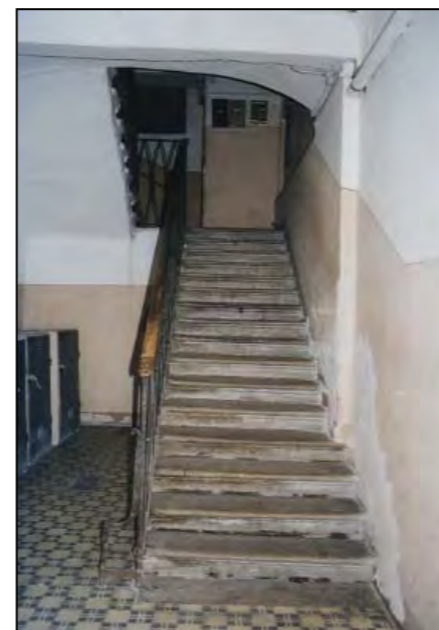
Atrio d'ingresso e scala dell'edificio con cod. an. 1541 (nota: la prima rampa permette l'accesso al vano della scala dell'edificio con cod. anagr. 1543)
