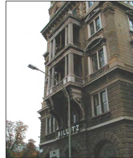
Particolare delle logge
