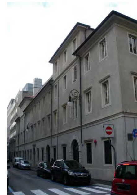
via Torrebianca 6 L'edificio è stato completamente ristrutturato e quindi trasformato all'interno.
