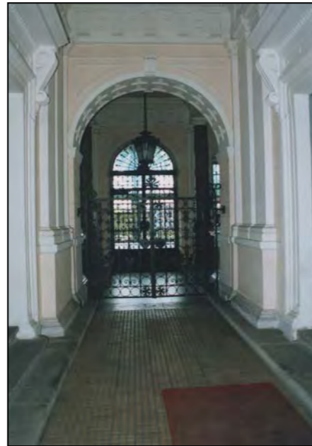
Androne ripreso dalla corte verso l'arco d'uscita
