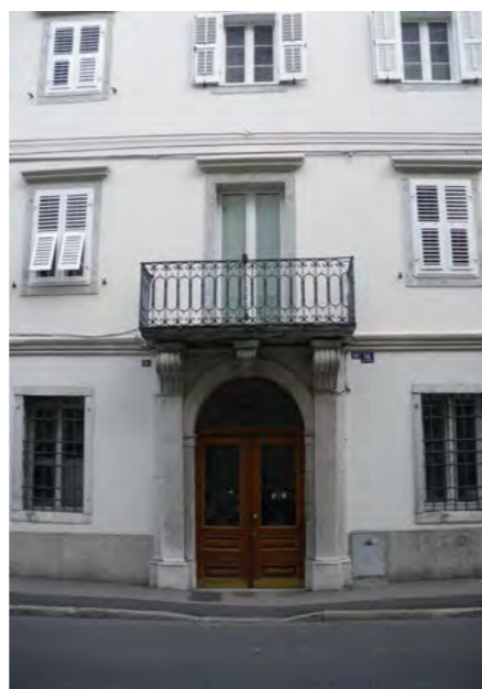
via Valdirivo 14 - particolare dell'ingresso con soprastante balconcino e parapetto in ferro lavorato
