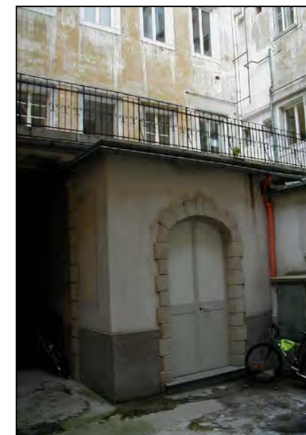
Corte interna (fotografia del 2000)
