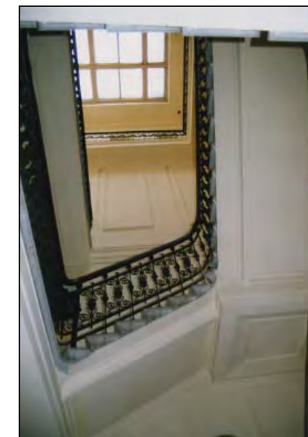
vano scala (immagine alla data del rilievo)
