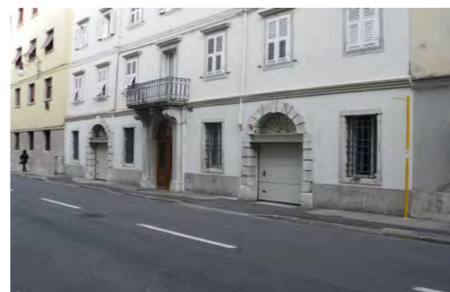
via Valdirivo 14 - alterazione dei fori al piano terra
