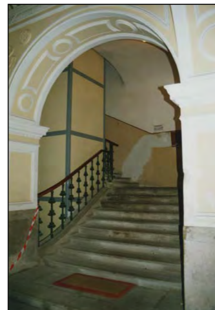
vano scala (immagine alla data del rilievo)
