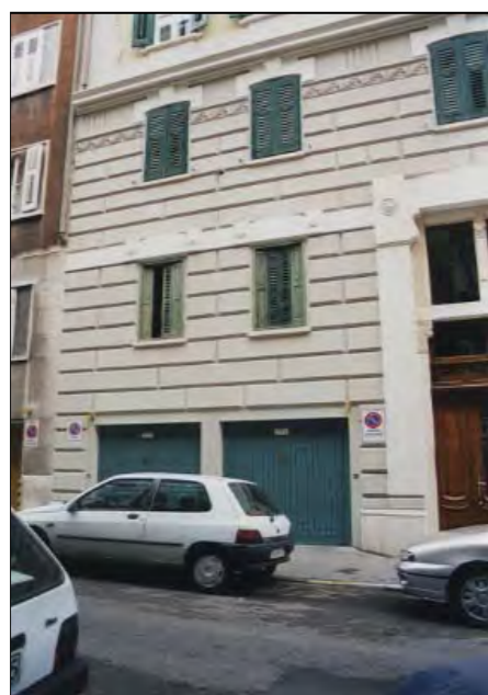
Le aperture modificate al pianoterra
