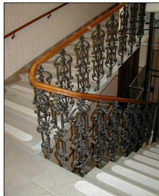
Particolare corpo scale via della Geppa 2
