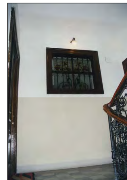
Particolare finestra sul pianerottolo, con vetri a piombo
