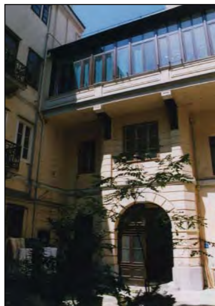
corte interna (immagine alla data del rilievo)
