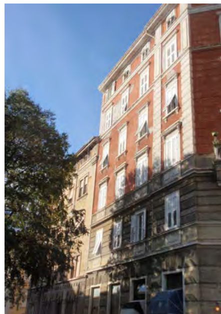
via Udine 26 prospetto su campo Belvedere
