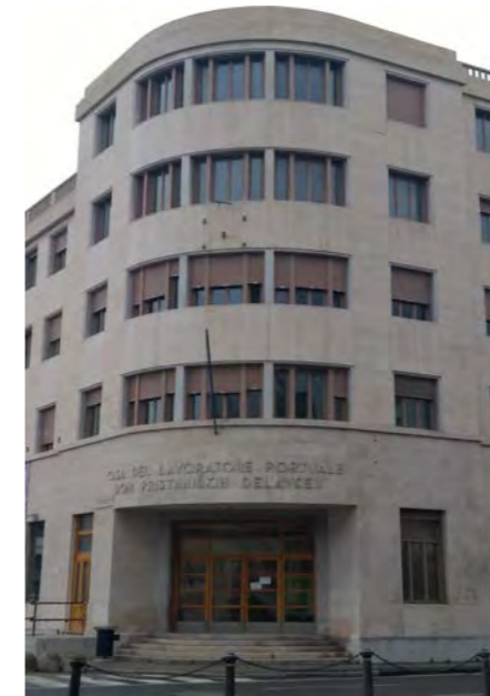
facciata su corso C. Cavour - particolare
