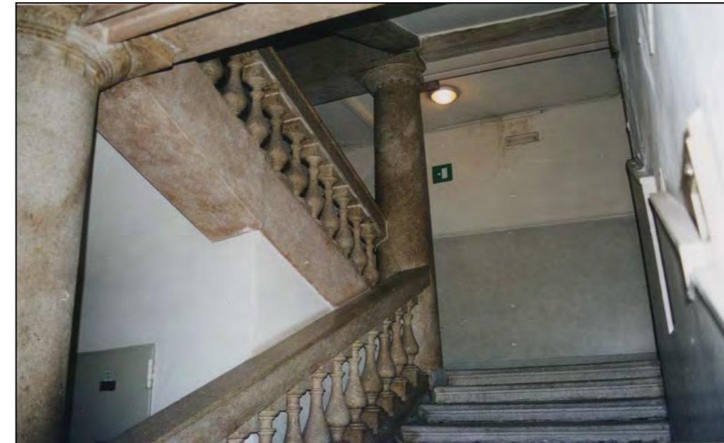
Particolare - vano scale (foto alla data del rilievo)
