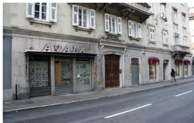
alterazione dei fori al piano terra lungo via Roma
