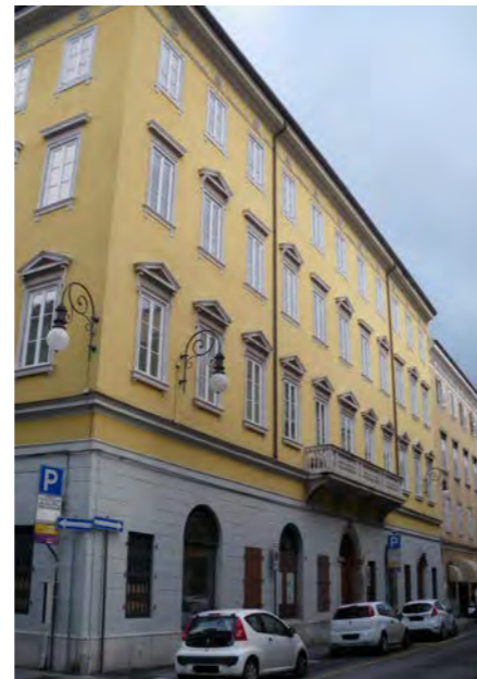
Prospetto su via Torrebianca 8
