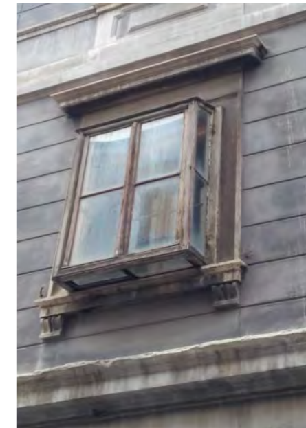
via Torrebianca 32 - particolare
