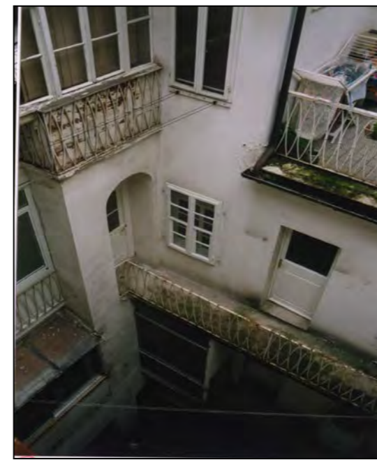
Particolare del cavedio
