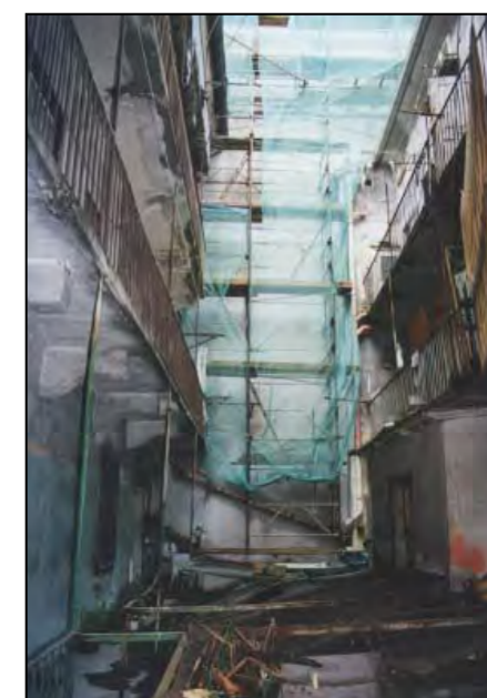
Cavedio e ballatoi
