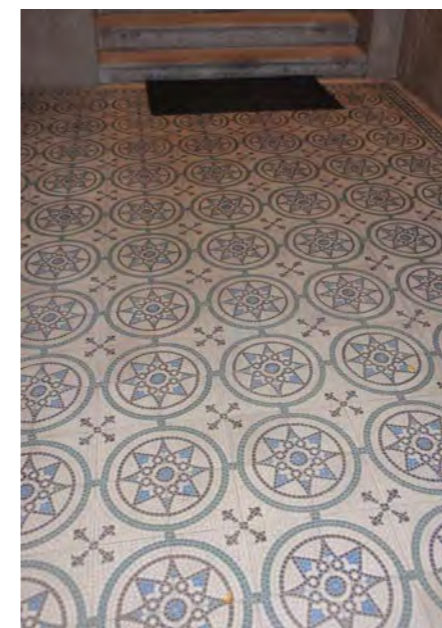
via G. Boccaccio 5 particolare pavimentazione atrio d'ingresso
