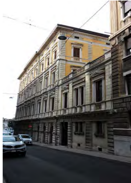
Prospetto su via S. Anastasio; in vista anche l'adiacente civico 4
