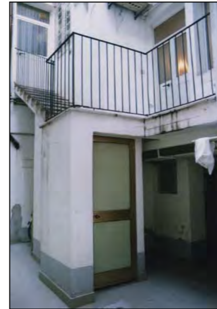
Corte interna (immagine alla data del rilievo)
