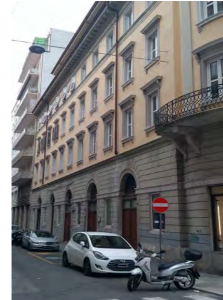
facciata su via del Lavatoio.
