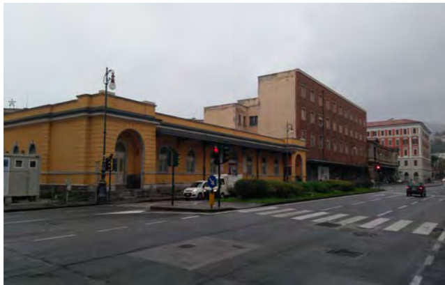
posizionamento lungo corso C. Cavour
