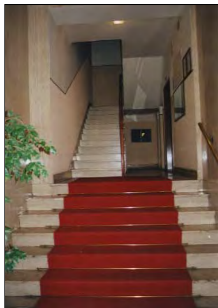
atrio d'ingresso e scala (immagine alla data del rilievo)
