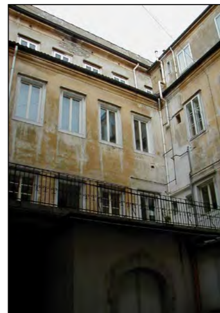
Corte interna (fotografia del 2000)
