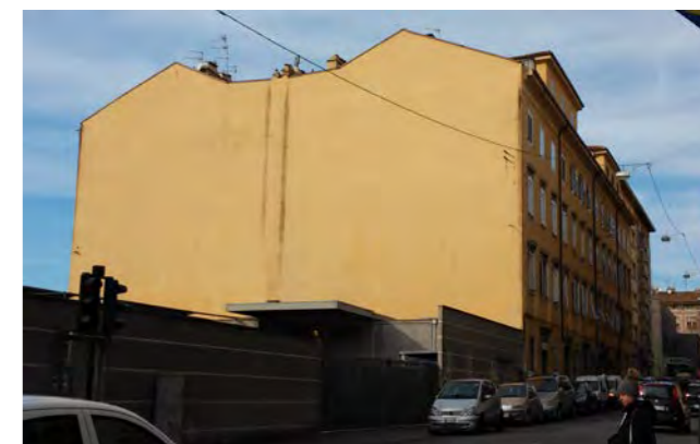
prospetto laterale cieco an. 1887
