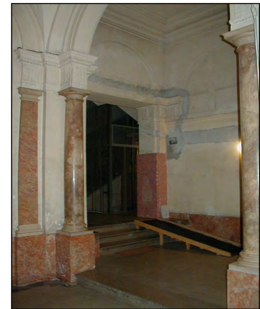
Atrio d'ingresso sulla via Ghega
