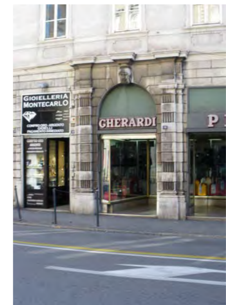
via C. Ghega 19 alterazione del piano terra
