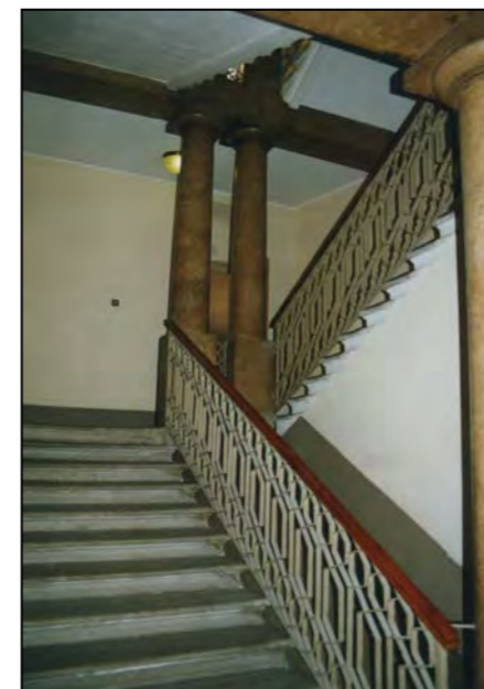
Vano scala (immagine alla data del rilievo)
