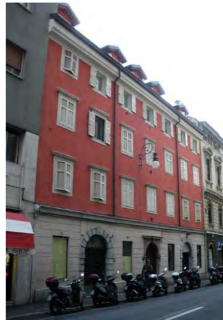
prospetto lungo via Valdirivo
