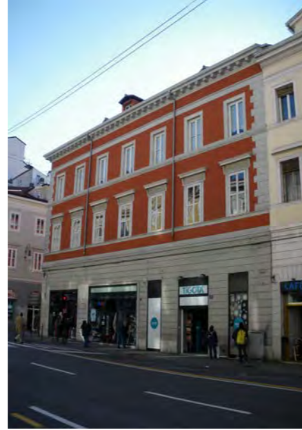
Facciata su via C. Ghenga
