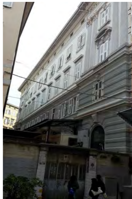
particolare dei lavori di muratura a chiusura della pensilina in ferro
