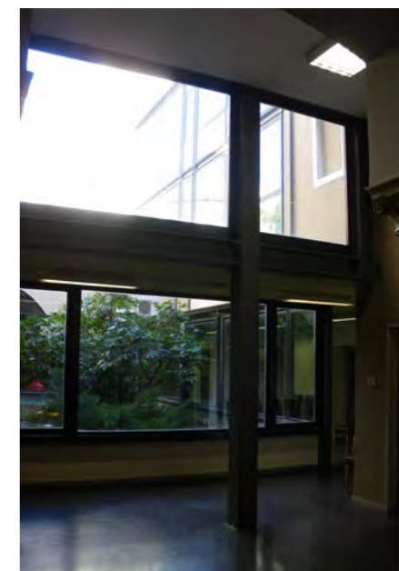
attacco tra la parte storica dell'edificio ed il recente ampliamento - particolare
