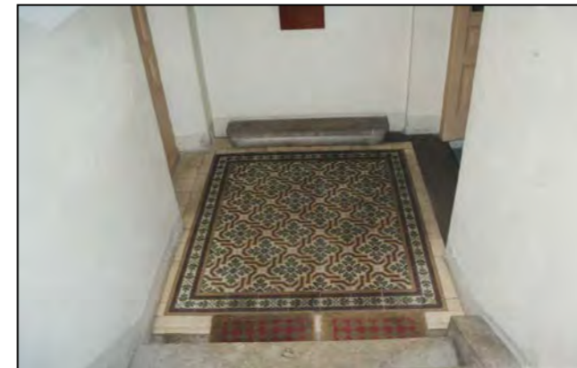
Particolare pavimentazione pianerottolo
