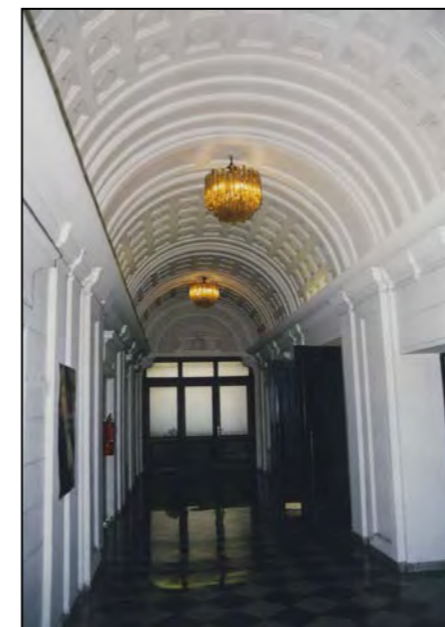
Androne d'ingresso alla data del rilievo
