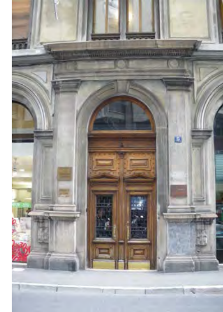
via F. Filzi 15 - portone di ingresso
