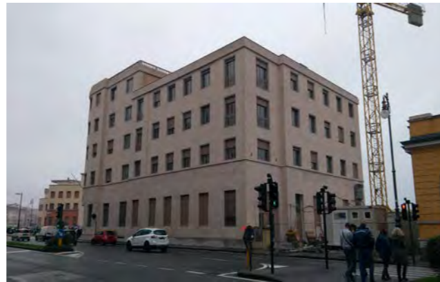
prospetto lungo corso C. Cavour
