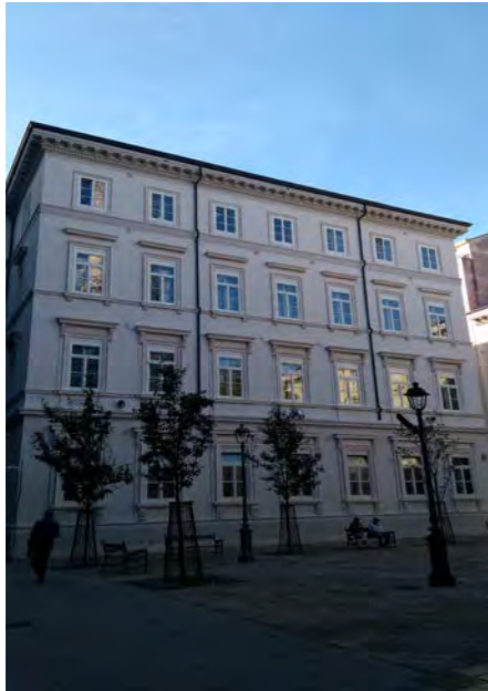
Facciata su largo O. Panfili
