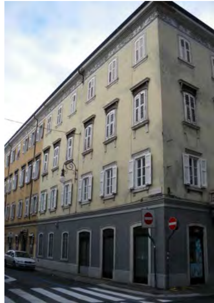
Prospetto su via Torrebianca
