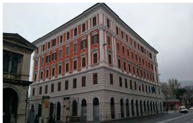
posizionamento lungo corso C. Cavour
