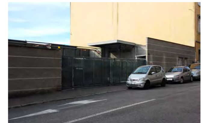
via Udine 16 - ingresso area carico/scarico merci su cui prospetta la facciata laterale cieca dell'edificio di via Udine 18
