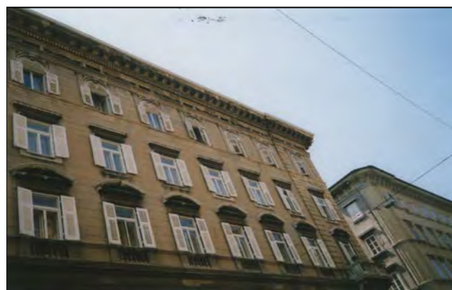
Particolare del prospetto su via del Coroneo
