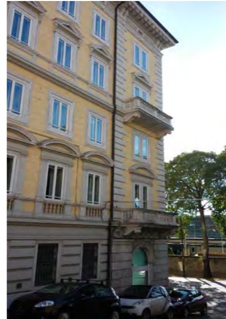
Elemento d'angolo - vista da via L. Ariosto
