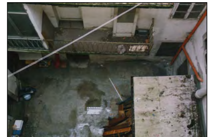
Particolare dall'alto del cavedio
