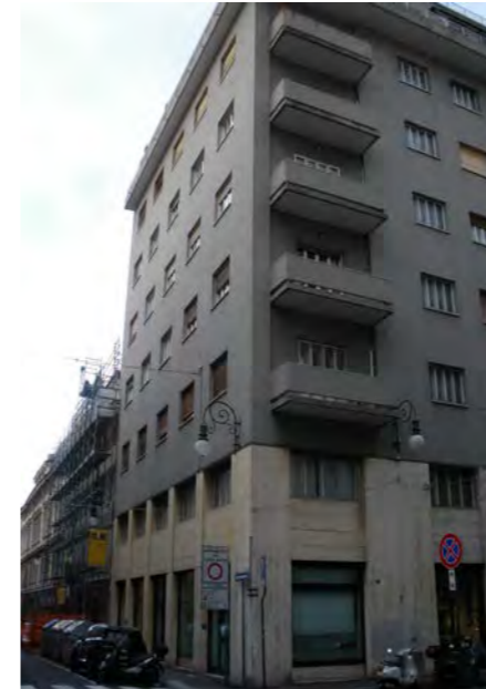
facciata su via Torrebianca
