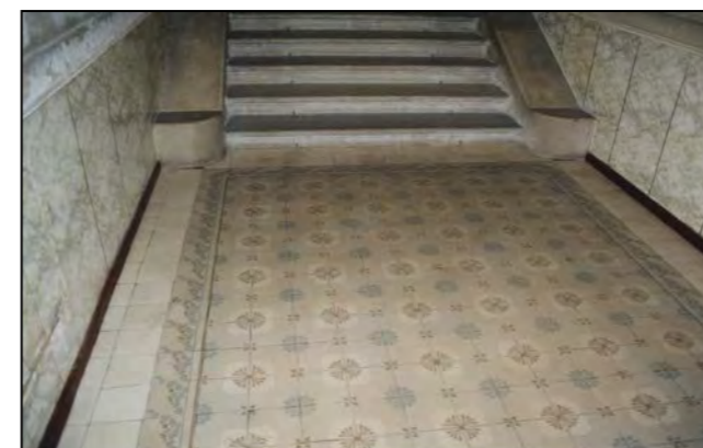
via V. Monti 1 / via Udine 44 Pavimentazione atrio d'ingresso
