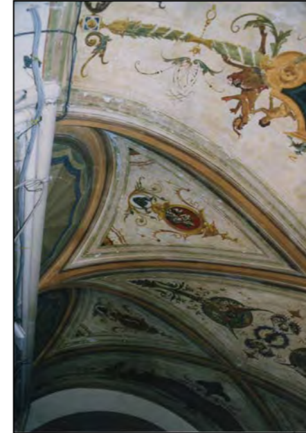
Particolare del soffitto dell'atrio d'ingresso (fotografia del 2000)
