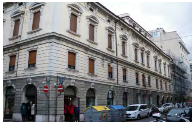
facciata su via Torrebianca
