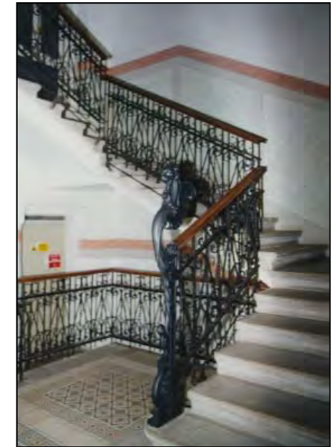
Scala a tre rampe ortogonali
