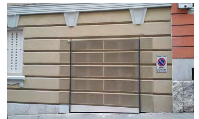
Particolare accesso all'autorimessa su via G. Boccaccio
