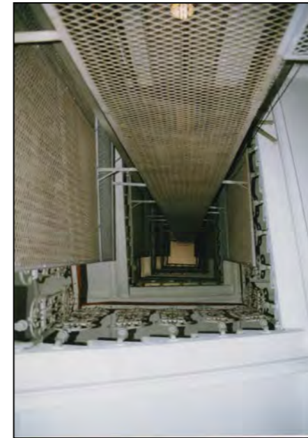
Tromba della scala (immagine alla data del rilievo)
