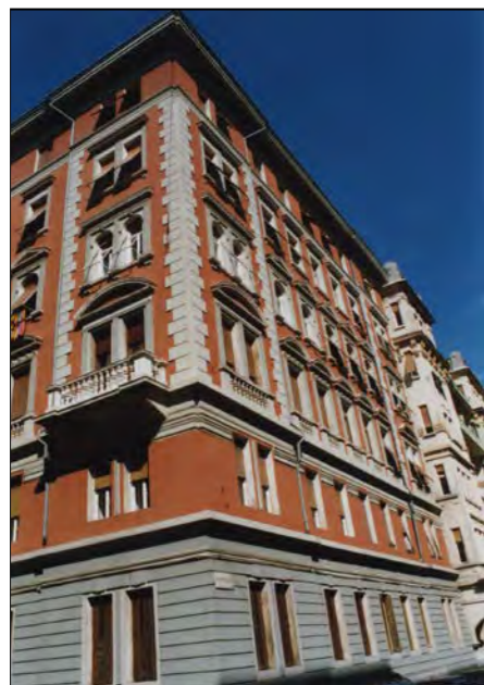
Particolare d'angolo sulla via di Tor San Piero
