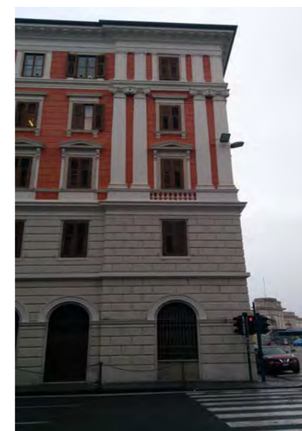
facciata su corso C. Cavour - particolare
