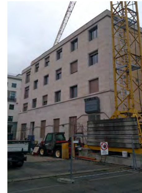
facciata lungo il passaggio scoperto che separa l'edificio dall'anagrafico 6174
