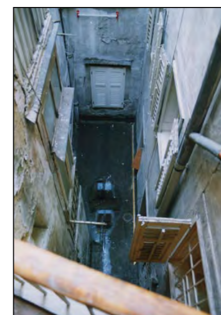
Corte interna fotografia del 2000
