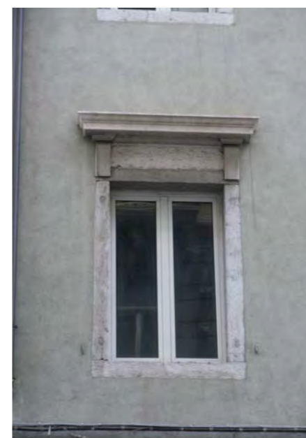
serramento e riquadro della finestra in via Milano 29
