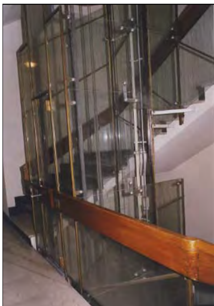
vano ascensore (immagine alla data del rilievo)
