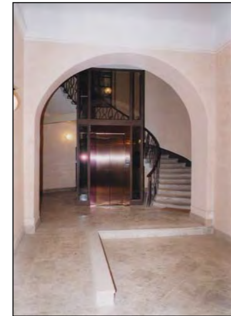
Atrio d'ingresso sostituito nei materiali da rivestimento (fotografia del 2000)
