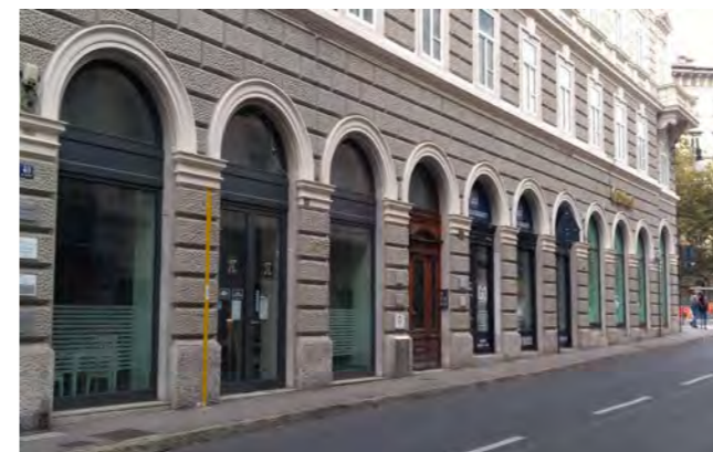
via Milano - fori al piano terra
