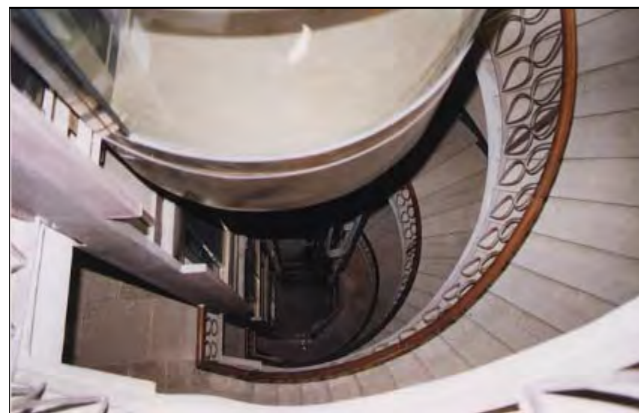
Vano scala con impianto dell'ascensore nel fuso centrale di risulta
