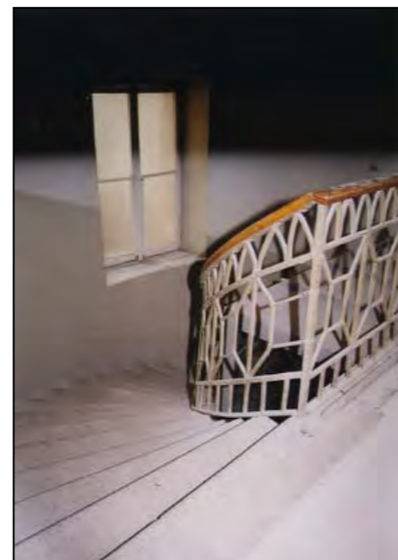
Particolare prima rampa
