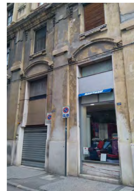
vetrina e box auto con alterazione del foro architettonico lungo la via San Lazzaro
