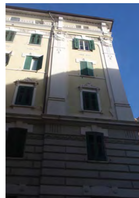
via G. Boccaccio 7 particolare corpo d'angolo
