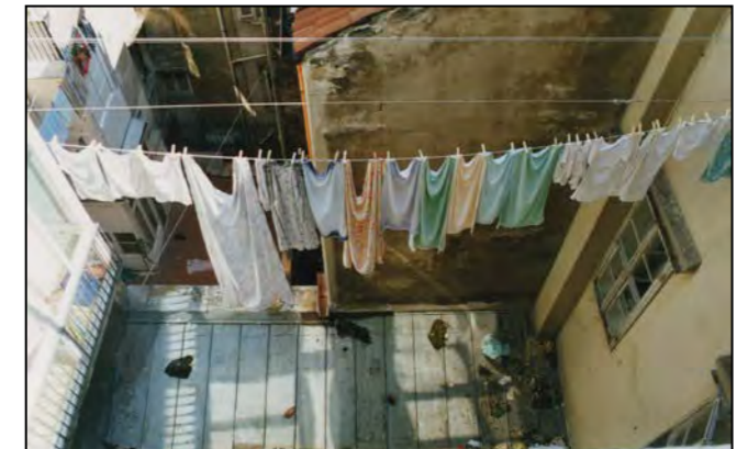
Cavedio interno (immagine alla data del rilievo)
