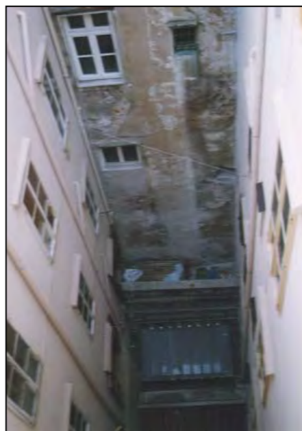
cavedio (immagine alla data del rilievo)
