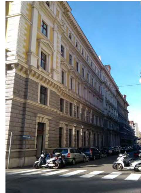
facciata su via G. Galatti
