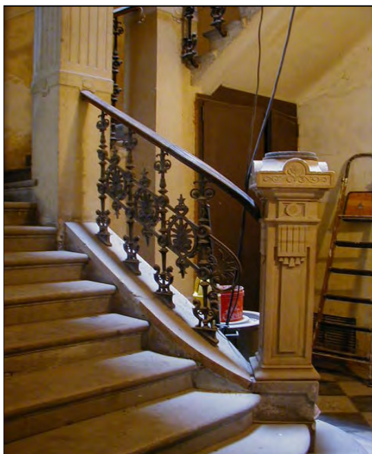
Particolare corpo scala in stile Liberty
