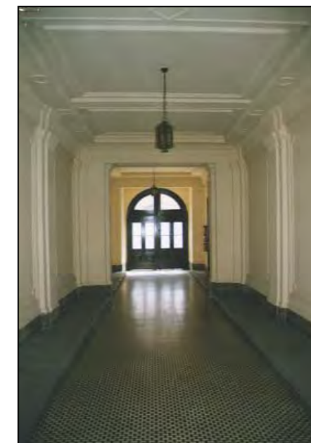
androne d'ingresso (immagine alla data del rilievo)
