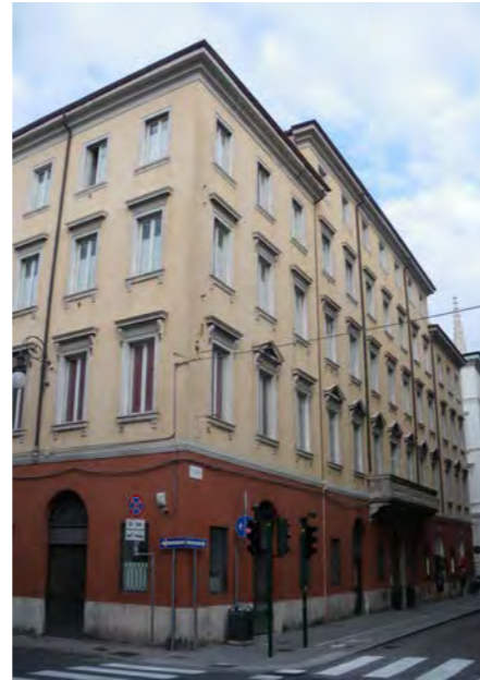
facciata lungo via Trento
