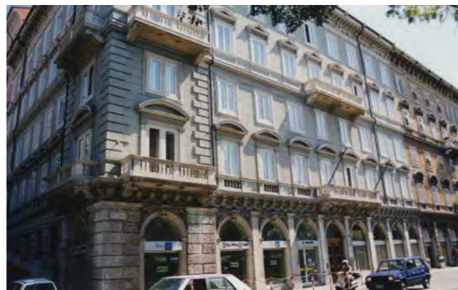
Prospetto su viale Miramare alla data del rilievo
