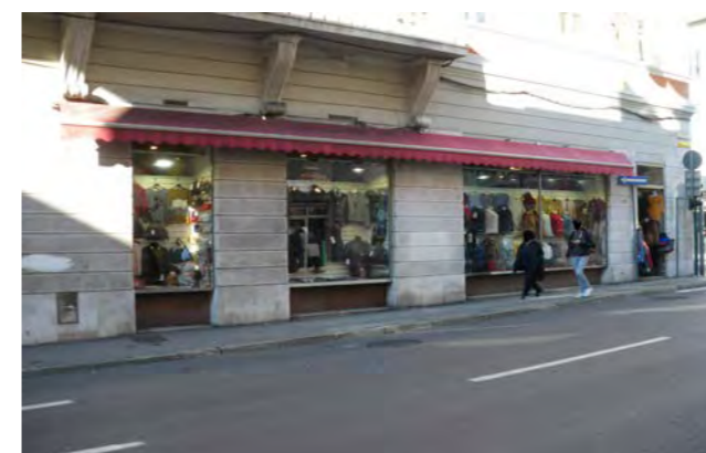
Alterazione del pianoterra
