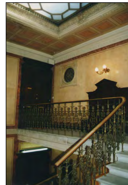
Ultima rampa particolare decorazione soffitto e lucernaio
