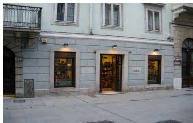
particolare dei fori commerciali lungo la via XXX Ottobre
