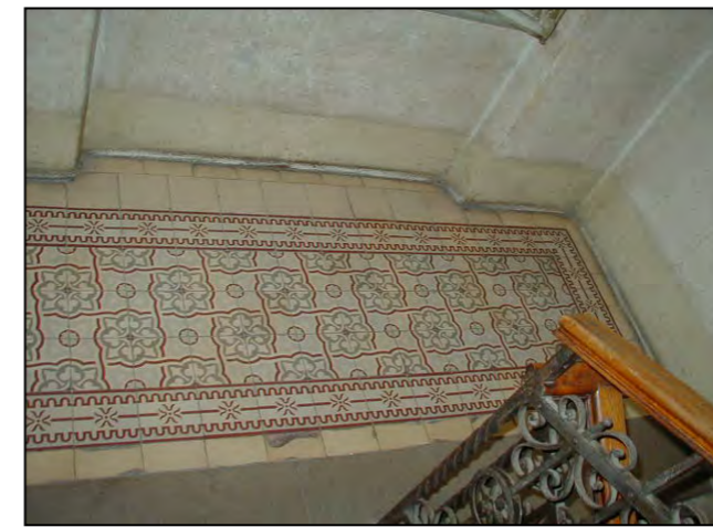
Particolare pavimentazione dei pianerottoli
