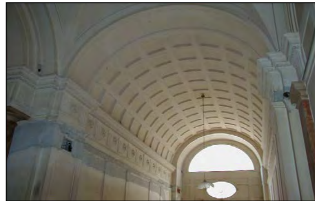
Atrio d'ingresso sulla via C. Ghega
