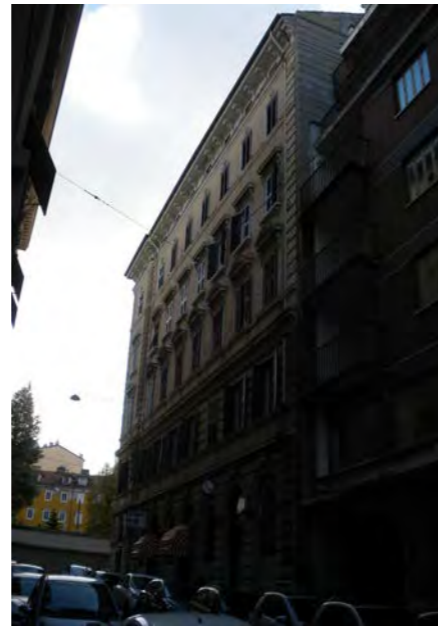
Facciata sulla via L. Ghiberti
