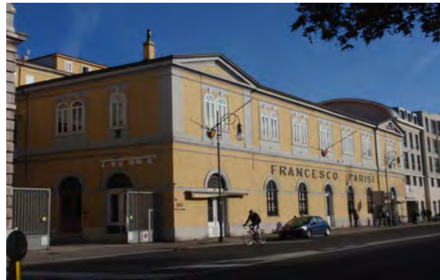
viale Miramare 5 - Palazzina Parisi
