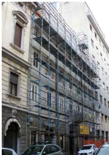
facciata su via Torrebianca
