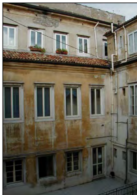
Facciata corte interna (fotografia del 2000)
