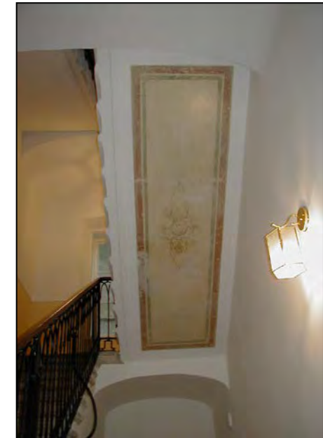
Decorazione sotto rampa
