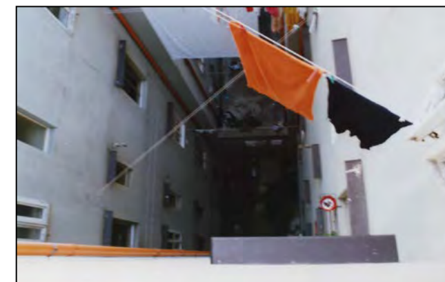
Particolare del cavedio
