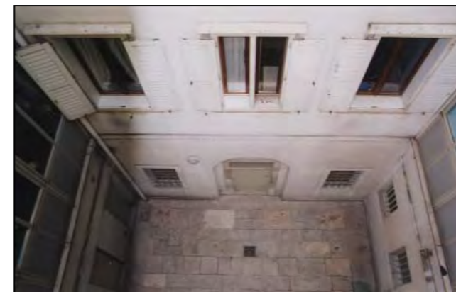
Chiostrina con pavimentazione in lastre di pietra
