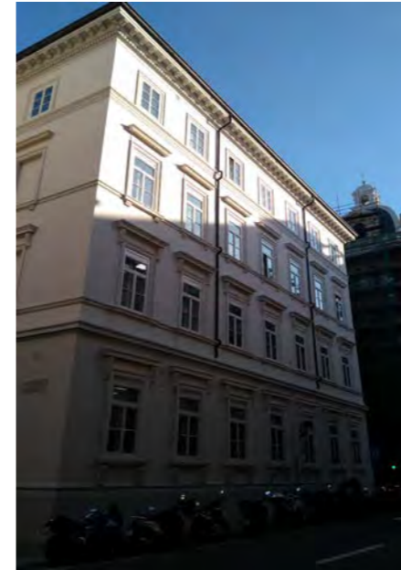
Facciata su via Milano
