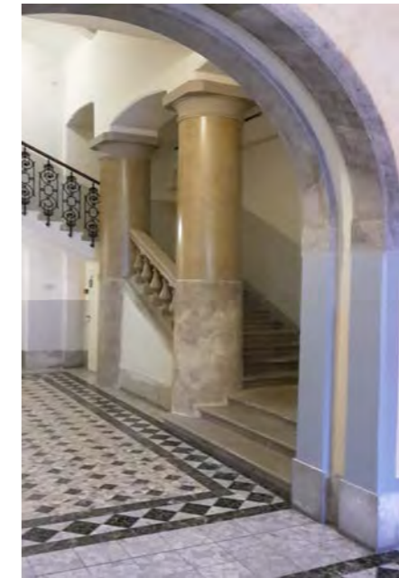
vano scala a 3 rampe ortogonali con scalini in pietra
