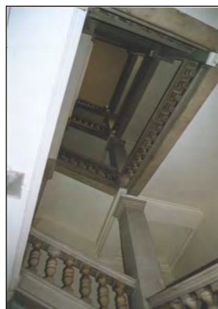
Vano scala quadrangolare a 3 rampe ortogonali con balaustra in marmo e scalini in pietra
