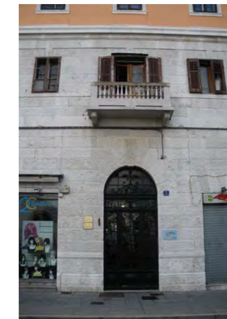
portone d'ingresso su via C. Ghega 3
