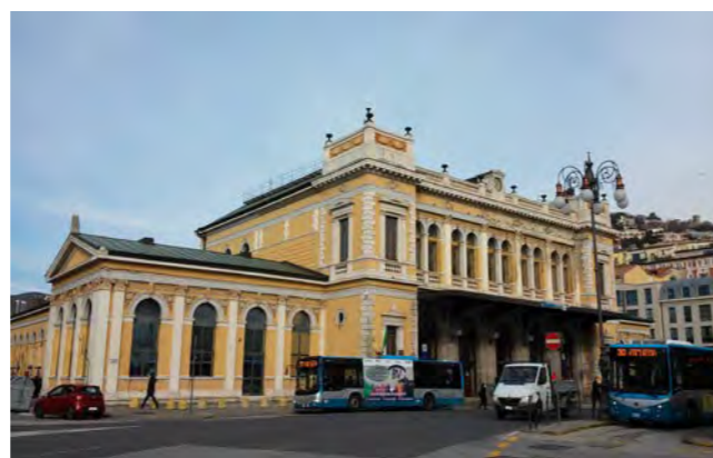
facciata principale e corpo laterale su via F. Gioia
