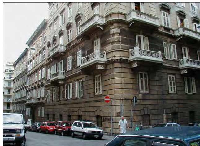
Particolare del prospetto alla data del rilievo
