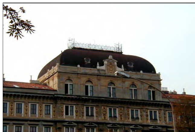
Particolare del tetto a padiglione
