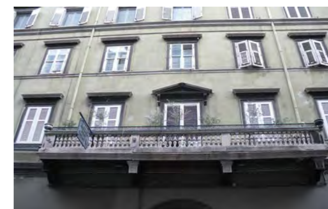
particolare del poggiolo al piano nobile
