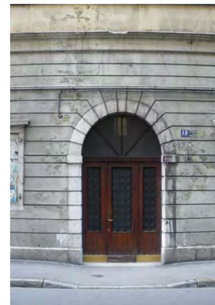
via Milano 13 - particolare dell'ingresso
