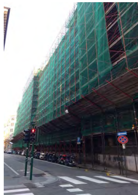
manutenzione in corso in largo O. Panfilì
