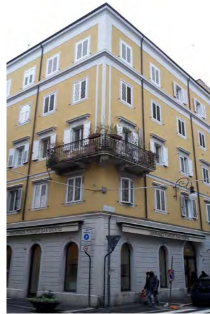
via di Torre Bianca - via della Zonta
