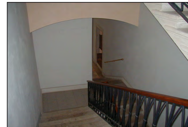
Particolare del corpo scala
