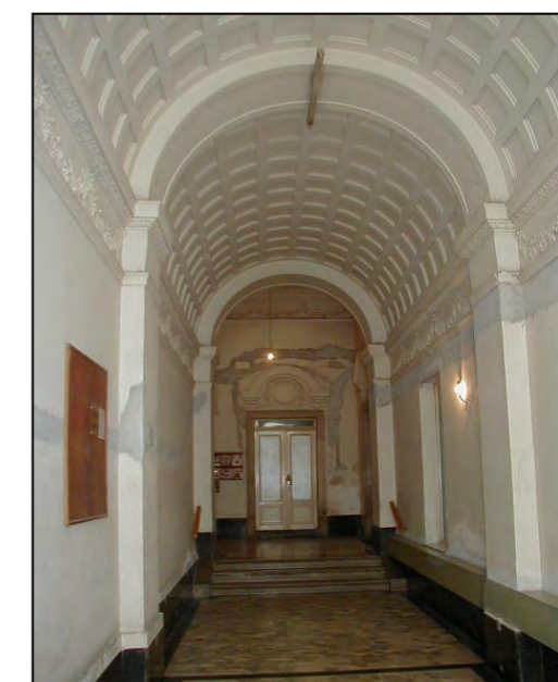
Atrio d'ingresso sulla via B. Cellini
