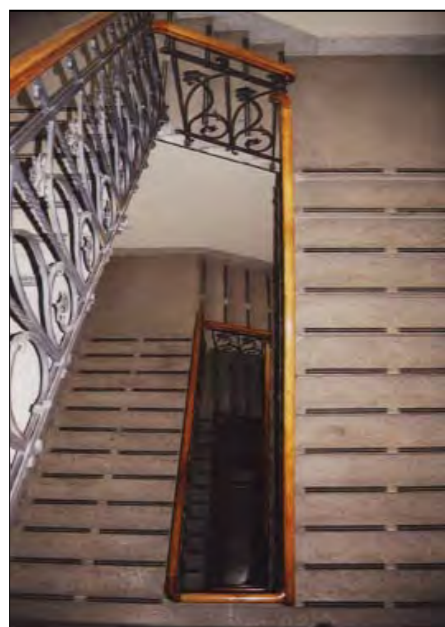
Vano scala a tre rampe ortogonali, originale in pietra, a sbalzo
