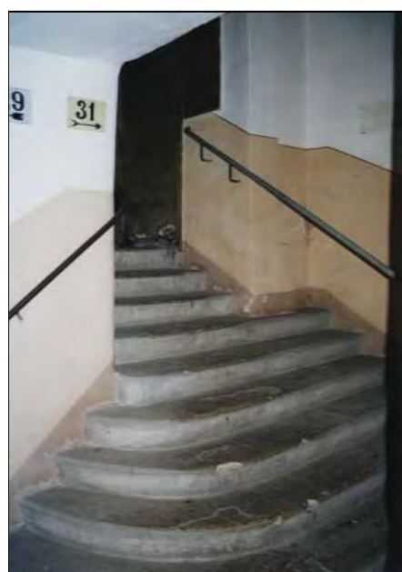
Gradini che conducono al vano scala del civico n. 31
