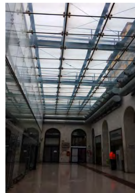
spazio servizi con copertura piana trasparente e intelaiatura di sostegno metallica di recente realizzazione
