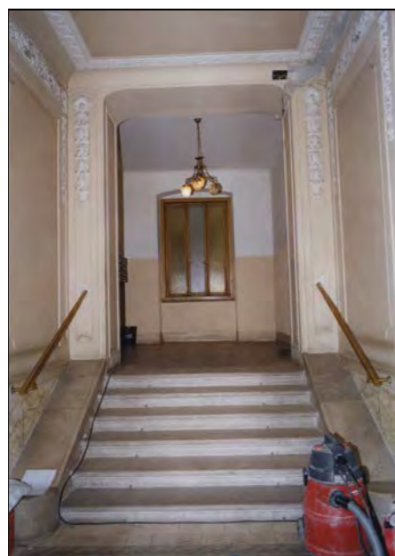
via V. Monti 1 / via Udine 44 Atrio d'ingresso
