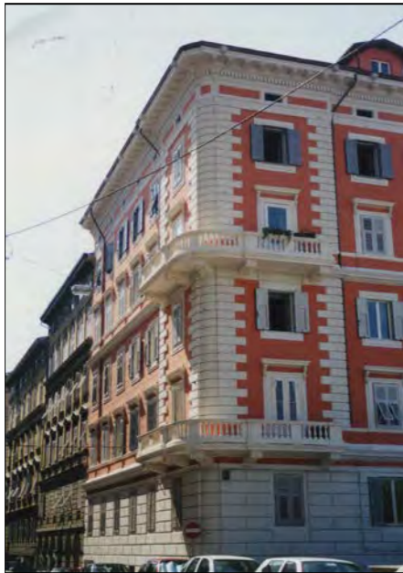
Prospetto su via Ariosto
