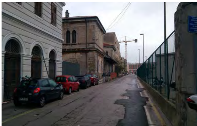
posizionamento lungo il fronte secondario prospettante su "ex bretella di collegamento con il porto vecchio"
