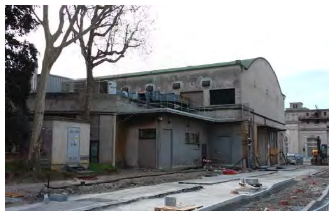
prospetto posteriore dopo la rimozione dei container a servizio dell'attività teatrale e inizio lavori di sistemazione della piazza Libertà
