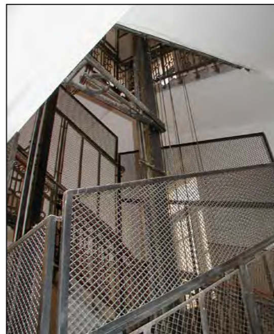
Particolare corpo scala
