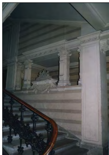
Sistema decorativo sul vano scala (fotografia del 2000)
