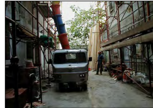
via C. Ghega 8 - corte interna - immagine alla data del rilievo
