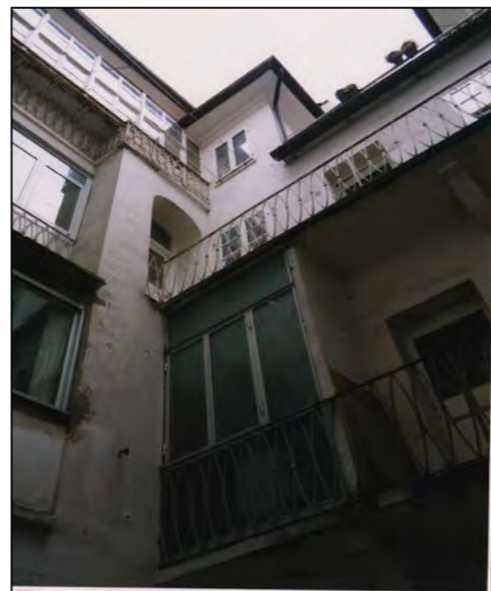
Particolare del cavedio
