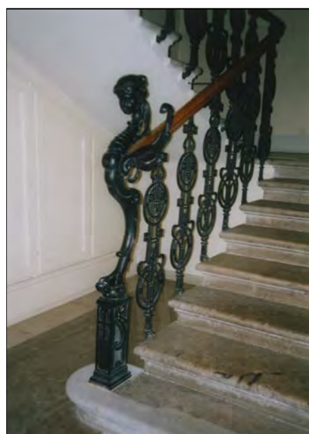
Particolare scala (pianoterra)
