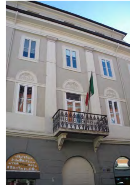
Particolare di facciata su via Roma
