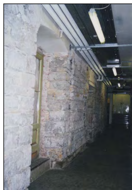
Il pianoterra ospita i servizi tecnici e i vani tecnologici. A seguito di lavori di ristrutturazione, è attualmente visibile la struttura muraria in blocchi di masegno
