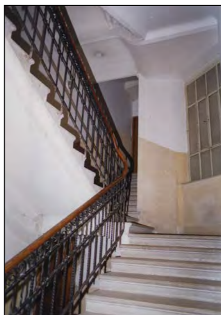
via V. Monti 1 / via Udine 44 Corpo scala a rampe parallele con rampa a gomito
