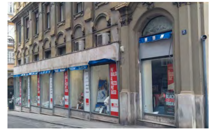
alterazioni al piano terra lungo la via Torrebianca
