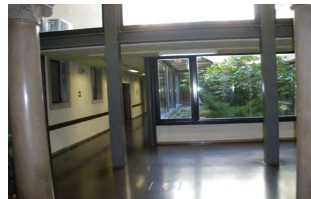
attacco tra la parte storica dell'edificio ed il recente ampliamento - particolare
