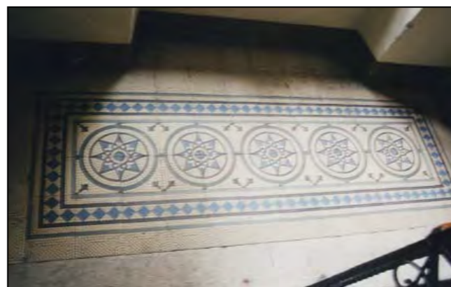
La pavimentazione nei pianerottoli, mantenutasi originali
