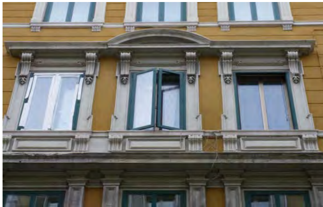
Particolare serramenti esterni e paramento murario
