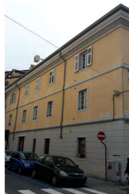
via di Torre Bianca - via Trenta Ottobre
