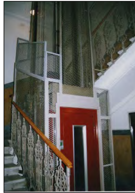
Corpo scala e ascensore (immagine alla data del rilievo)
