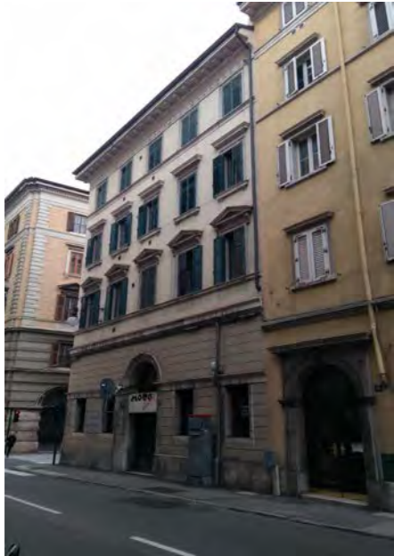
Facciata su via Milano
