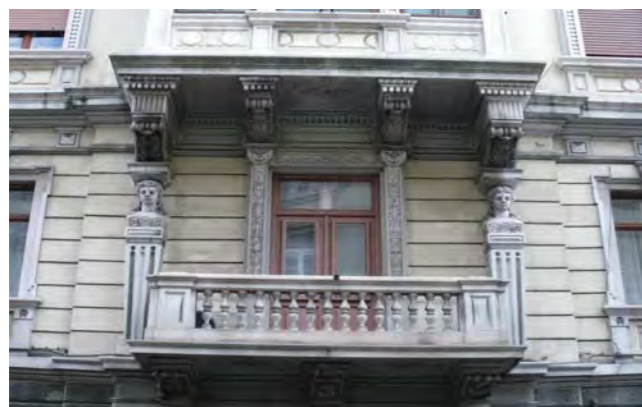
facciata su via Roma - particolare del balcone al primo piano
