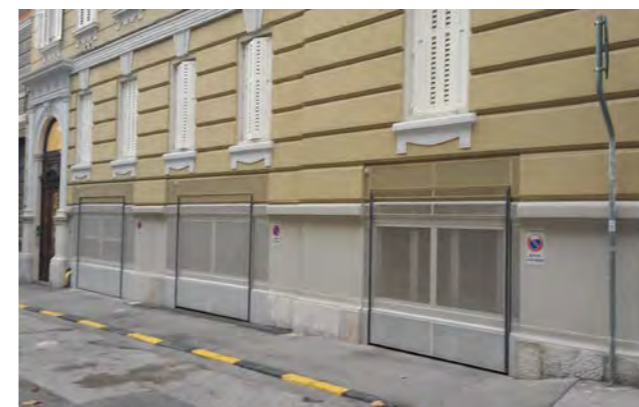
Particolare serie di accessi alle autorimesse su scala al Belvedere
