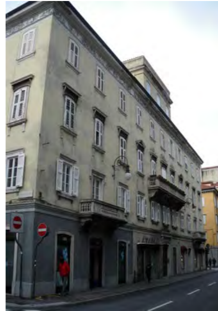
Prospetto su via Roma
