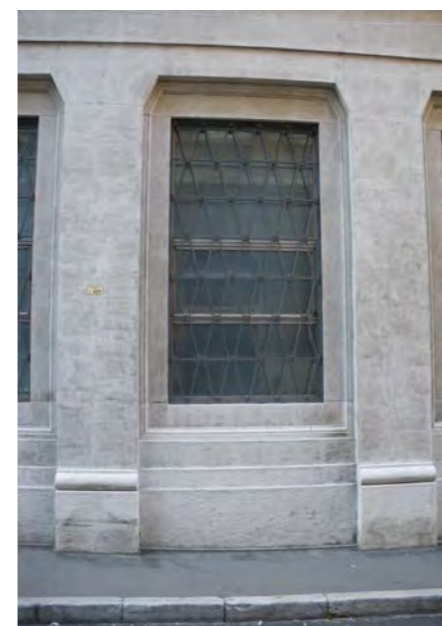
via A. e F. Nordio 11 - particolare del piano terra
