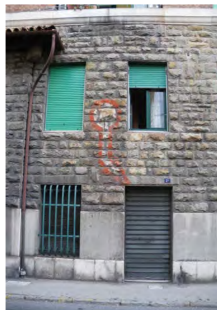
via A. Canova 2 - particolare delle forature
