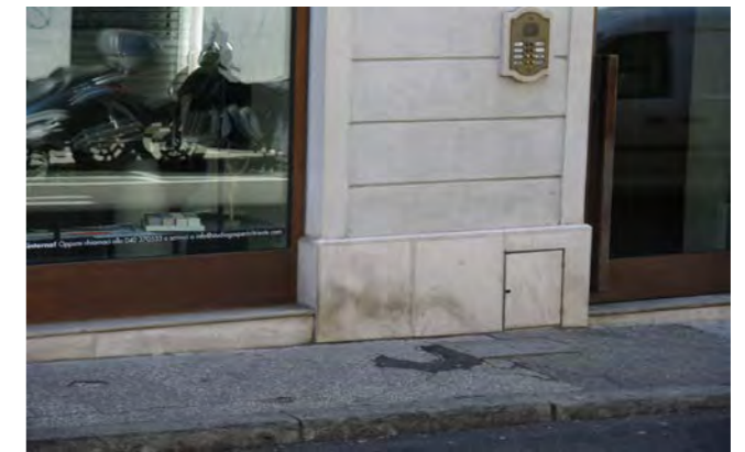
mimetizzazione della nicchia per impianto di adduzione
