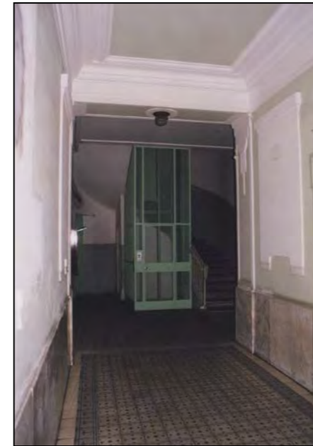
Scala anulare e ascensore (fotografia alla data del rilievo)
