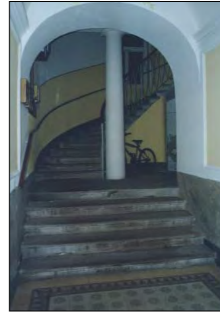
Atrio d'ingresso (fotografia alla data del rilievo)
