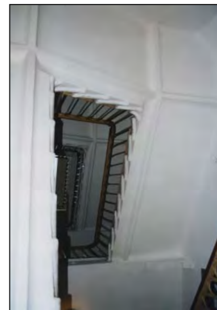
Vano scala (fotografia alla data del rilievo)
