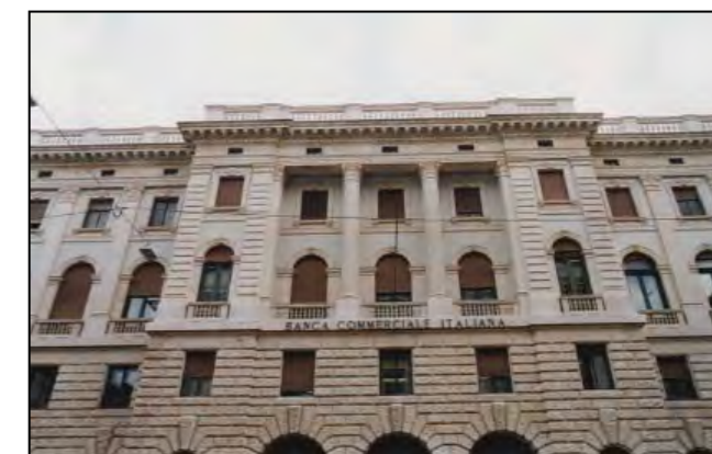
Particolare facciata principale
