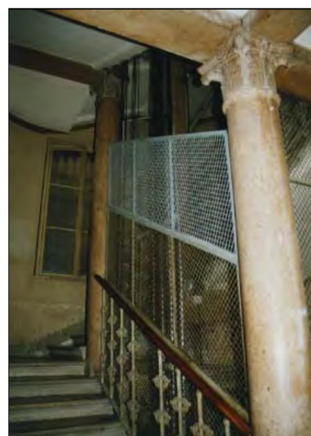
Corpo scala su colonne e travature in pietra
