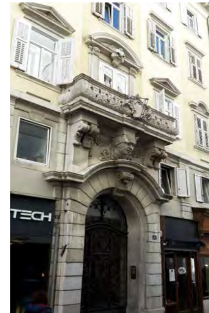
particolare del portale di via A. Ponchielli 3
