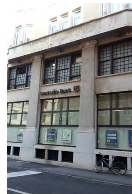
via Mazzini 20 - particolare della facciata
