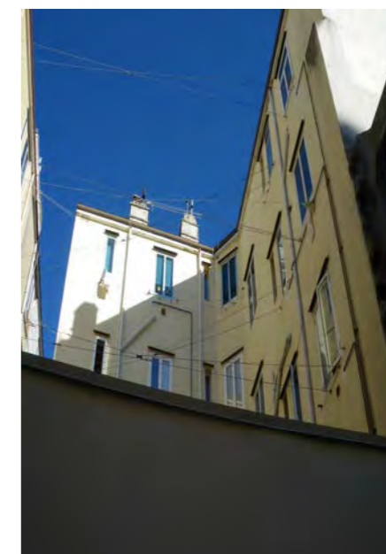
via della Maiolica 6 - facciata postica
