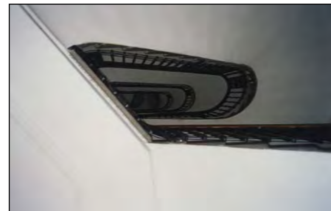
Scala con andamento ellittico vista dal basso
