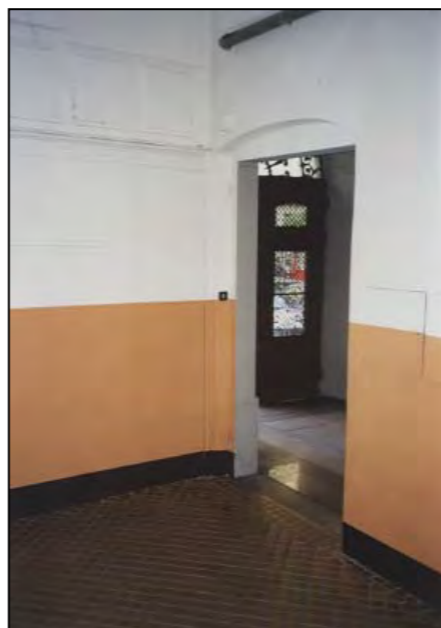
Apertura che mette in comunicazione l'androne principale con il suo vano scala
