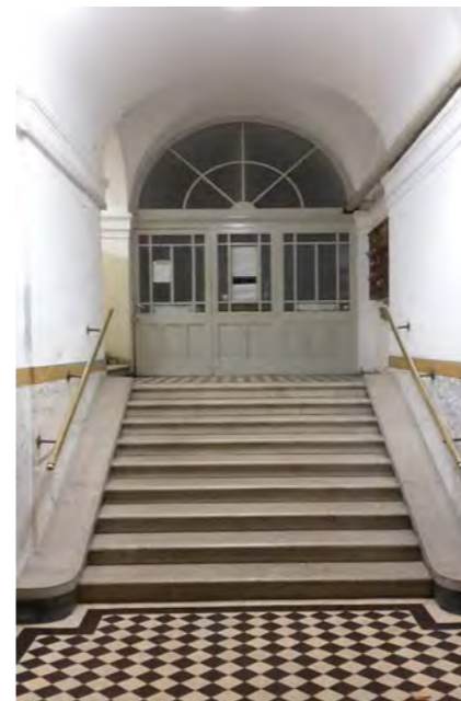
viale XX Settembre 39 - corpo scala
