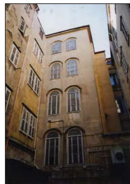
Corte interna ( fotografia del 2000)
