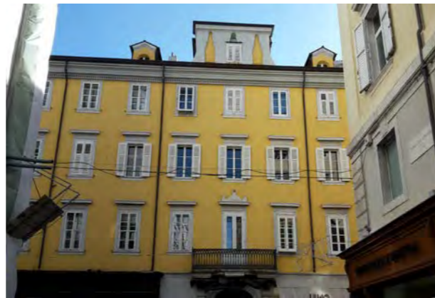
Particolare facciata su via San Lazzaro
