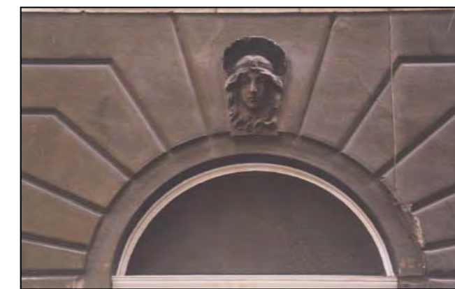
particolare - panduro su arco al pianoterra
