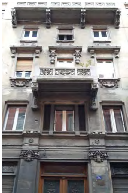
via G. Brunner 4 - particolare della facciata
