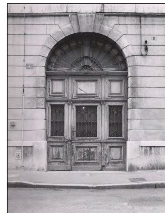
particolare del portone laterale in legno
