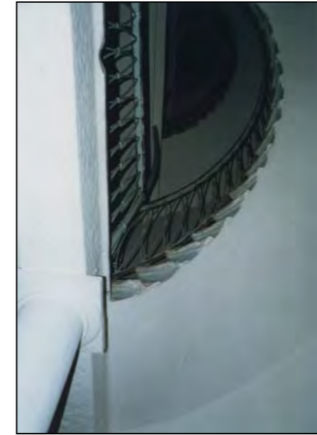
particolare della scala (fotografia alla data del rilievo)
