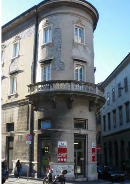
via San Maurizio 15 - particolare della soluzione architettonica dell'edificio
