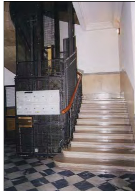
Ingresso e vano scala
