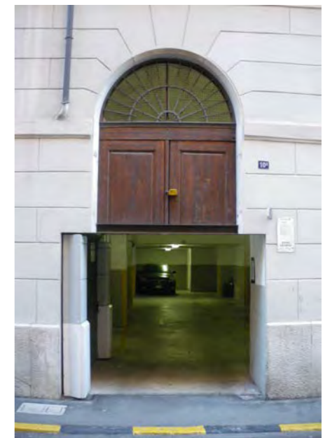
apertura del garage al piano terra
