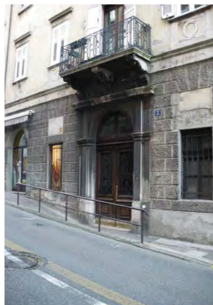
via G. Gatteri 13 - particolare dell'ingresso, del poggiolo e dell'abbassamento stradale in corrispondenza dell'ingresso
