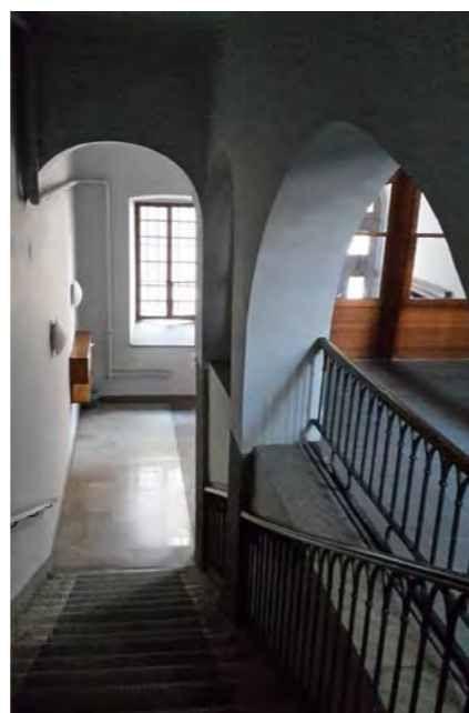
particolare del corpo scala
