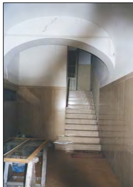
atrio d'ingresso e scala (fotografia alla data del rilievo)
