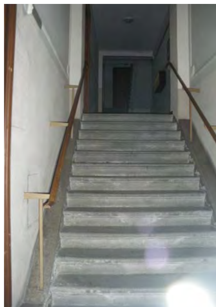
via C. e G. Stuparich 14 - ingresso e vano scala
