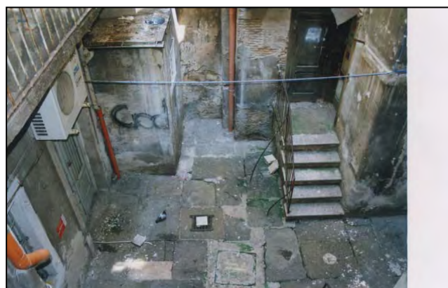
via R. Timeus 12 - corte interna (immagine alla data del rilievo)
