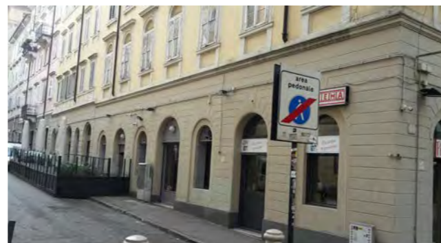
via Paduina - particolare delle forature al piano terra
