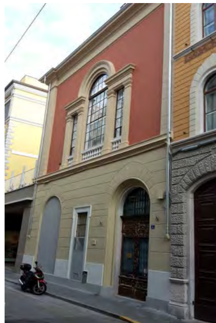
Facciata su via San Francesco d'Assisi (fotografia gennaio 2019)
