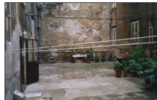
Corte interna (immagine alla data del rilievo)
