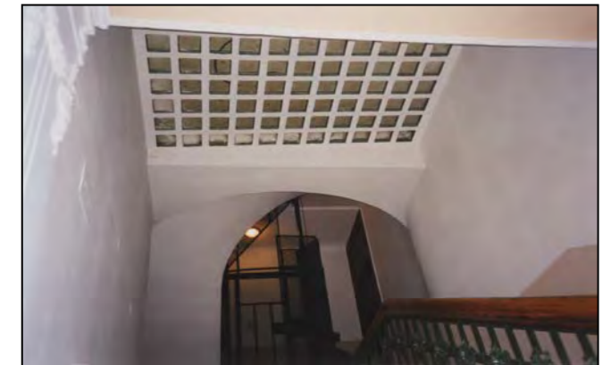
Copertura in vetro-cemento, al di sopra della quale vi è il cavedio di servizio
