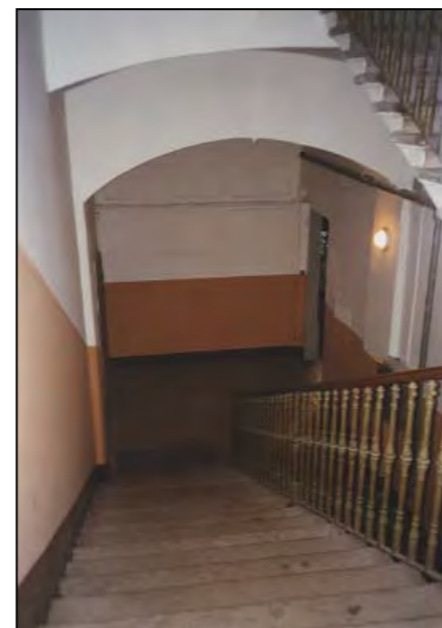
Particolare del vano scala
