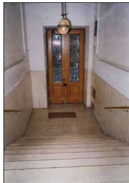
Atrio d'ingresso: il rivestimento dell'ingresso è stato sostituito risultando incongruente con l'epoca di costruzione
