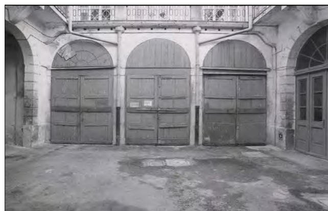
il primo cortile verso il mare, al piano terra sono ancora visibili le rimesse per le carrozze e la pavimentazione in lastroni di arenaria
