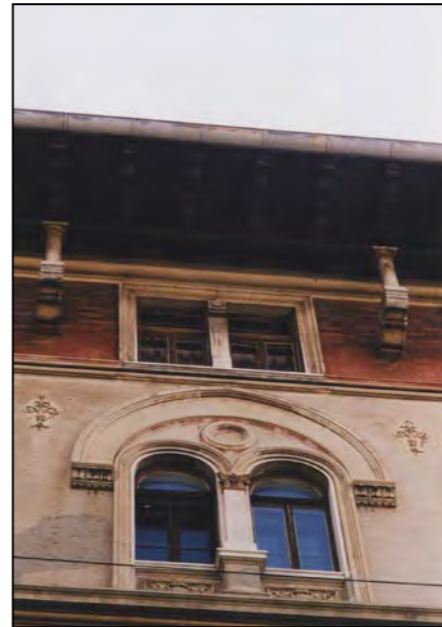
Particolare della bifora e della sporgenza della copertura in legno
