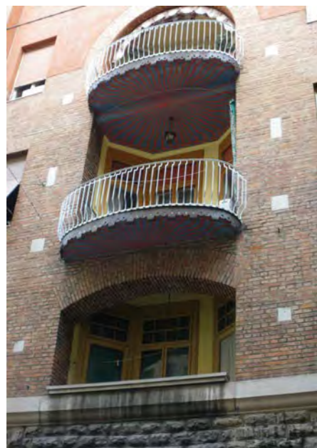
Particolare dei balconi
