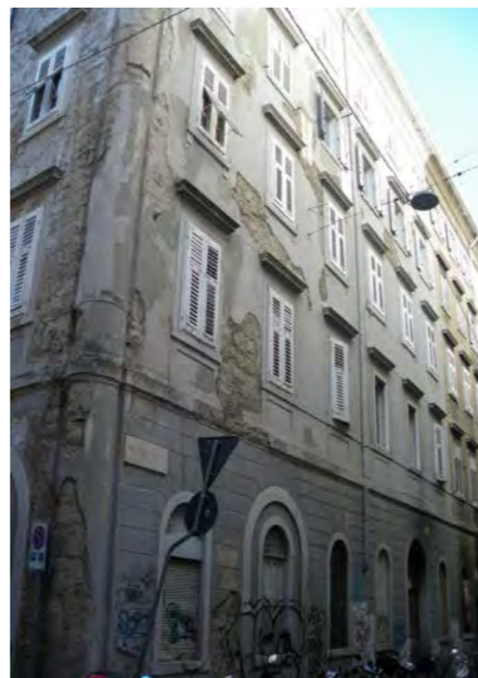
via della Maiolica 14 - facciata su via della Sorgente
