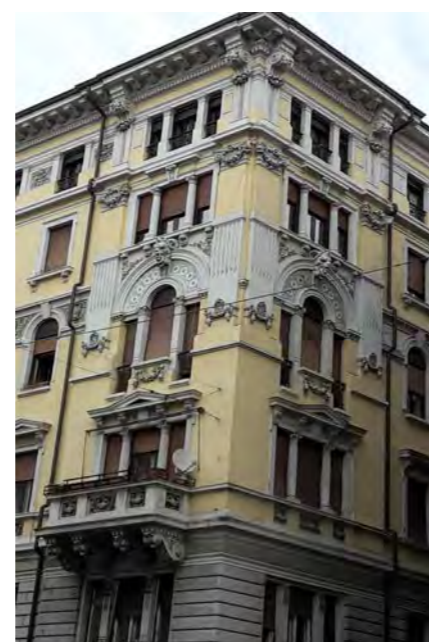
via G. Carducci 30 - particolare dell'angolo dell'edificio
