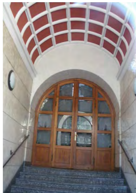
piazza dell'Ospitale 7 - particolare della prima rampa del vano scala e dell'atrio con volta a botte decorata con quadrati a rilievo
