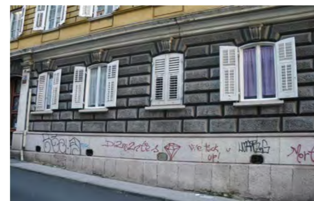
serramenti al piano terra
