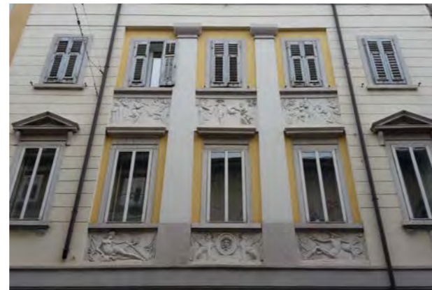
via della Ginnastica 3 - particolare della facciata
