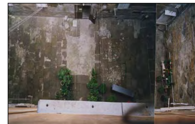
Corte interna (immagine alla data del rilievo)
