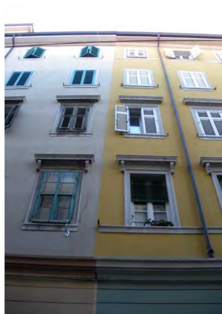
attacco tra via della Fonderia 3 e via della Fonderia 1
