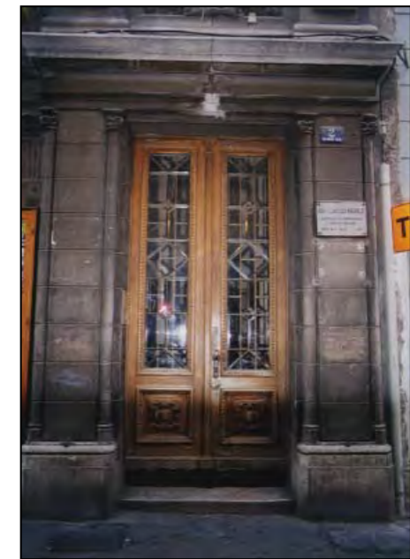
Particolare del portone d'ingresso
