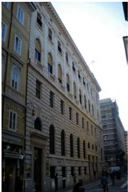
Facciata su via Dante Alighieri
