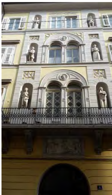
via R. Timeus 4 - particolare della facciata
