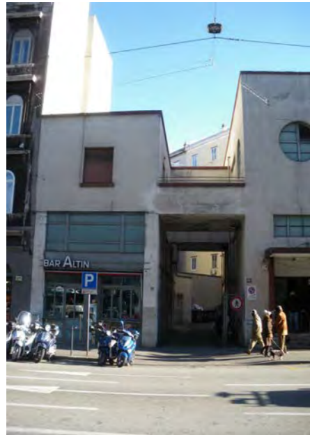
mercato comunale - accesso automezzi per il rifornimento lungo via Carducci
