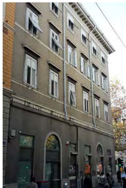
Facciata su via San Francesco d'Assisi
