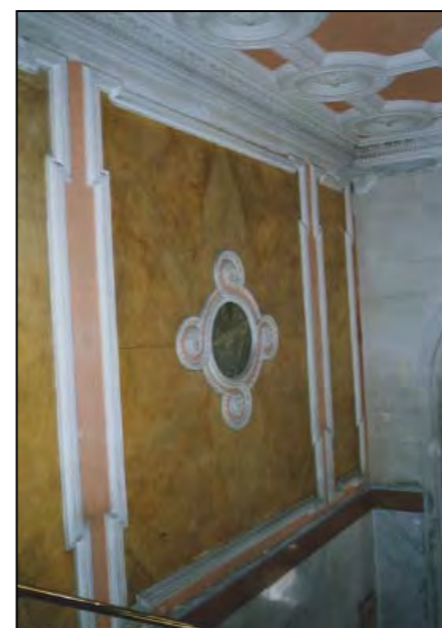
Particolari finiture dell'atrio d'ingresso
