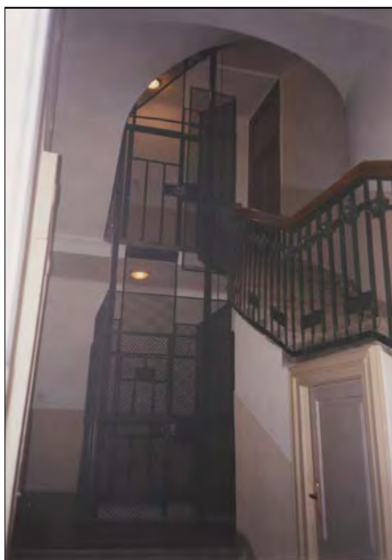
Scala e ascensore all'interno della tromba della scala
