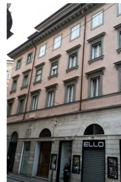
via E. Tarabocchia 1 - facciata
