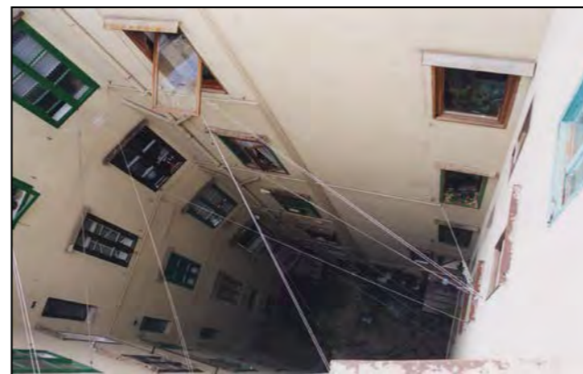
Cavedio (fotografia alla data del rilievo)
