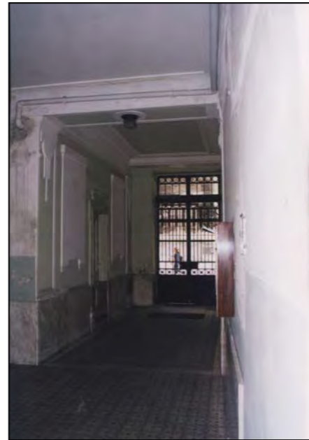
Atrio d'ingresso (fotografia alla data del rilievo)
