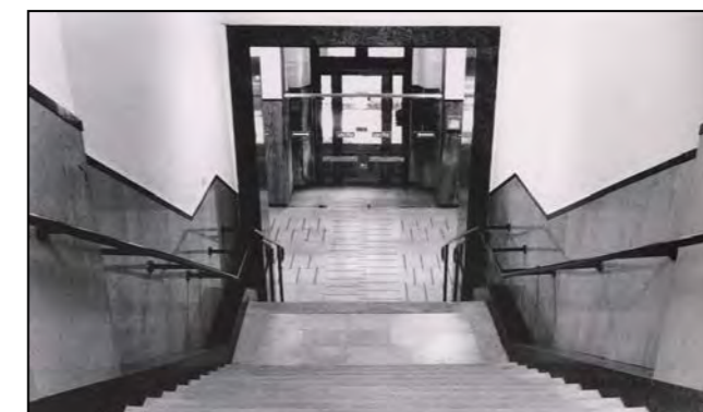
l'ingresso su via Genova 4, la struttura è stata chiaramente modificata alla metà del '900
