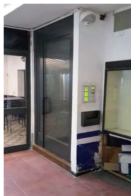
Portone d'ingresso al civico 23 di viale XX Settembre
