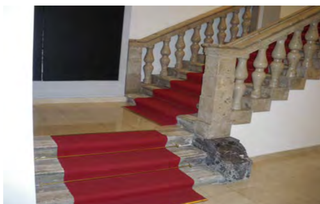
via A. e F. Nordio 11 - particolare dell'atrio e del corpo scala principale
