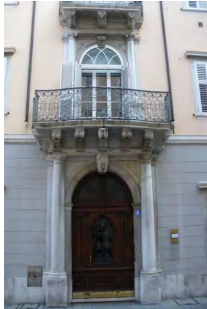
Particolare portale d'ingresso
