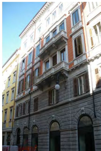
Facciata su via Mazzini
