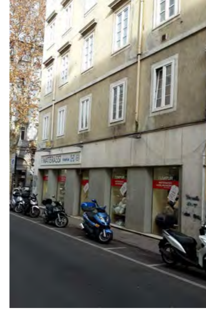
Particolare - pianoterra su viale XX Settembre e su via R. Timeus (nota: l'alterazione sia nelle forature, sia nel paramento murario nascosto dall'inserimento del marmo. Tutto senza alcun rapporto con il sovrastante prospetto).
