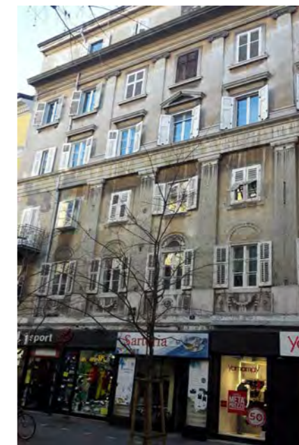
viale XX Settembre 9 - facciata
