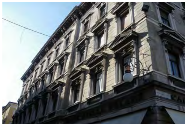
Facciata su via Dante Alighieri
