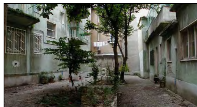
via F. Crispi 23 - corte interna (immagine alla data del rilievo)
