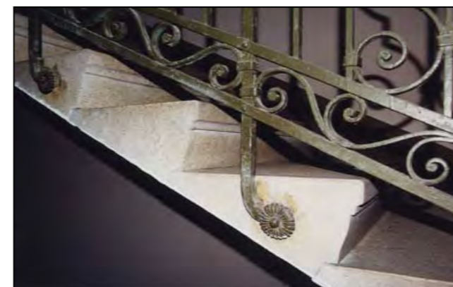
Particolare dei gradini autoportanti e balaustra in ferro battuto
