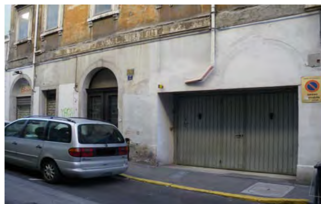
via F. Crispi 17 - alterazione di una foratura al piano terra
