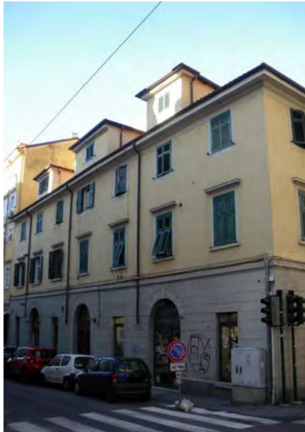
facciata su via della Ginnastica
