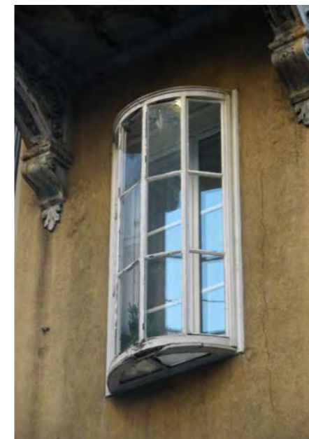
particolare di un serramento
