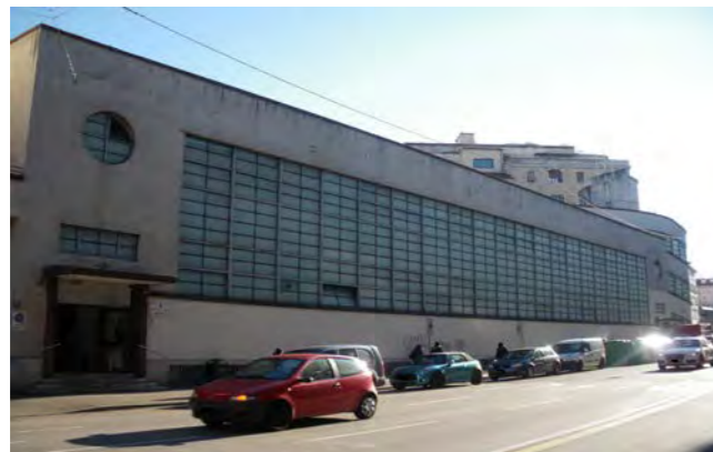
via Carducci 36 mercato comunale - I prospetti esterni presentano un'unica grande vetrata a nastro interrotta alla curva ad ovolo dove fasce orizzontali di cemento e vetro seguono l'andamento elicoidale della rampa interna. I due ingressi sono appena sottolineati da una pensilina e da una cornice rossa in mattoni, come pure il marcadavanzale e il limite superiore della facciata. Lo zoccolo della costruzione è scandito da un rivestimento con lastre di pietra di Monrupino. Il volume dell'edificio si sviluppa orizzontalmente; l'unico elemento verticale è la torretta elicoidale.
