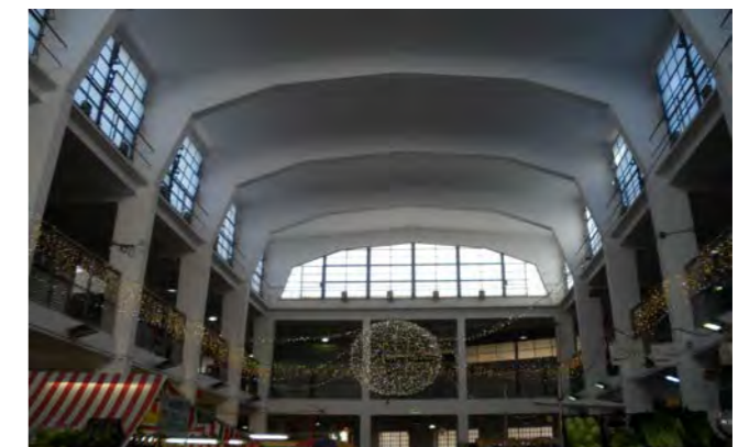
mercato comunale - All'interno il pianoterra a base triangolare è a pianta libera; al primo piano il solaio si interrompe sullo spazio centrale che rimane vuoto fino al lucernaio. L'edificio costituisce stilisticamente un esempio razionalista e domina la scena della piazza il cui progetto esecutivo è rimasto incompiuto dopo lo sventramento degli anni '30 nel quadro di una più generale politica di risanamento edilizio e di collegamento tra le strade del Friuli e dell'Istria. Si propone la conservazione integrale.
