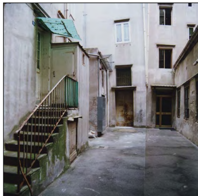
via della Maiolica 10-12 (immagine alla data del rilievo) - destra si intravede il manufatto a un piano interno alla corte, a sinistra un edificio abitato, in fondo il civico 12.
