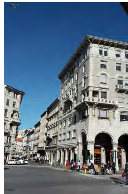
via G. Gallina - Ponte della Fabra
