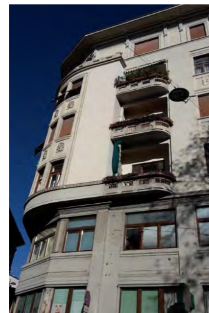
via C. e G. Stuparich 2 - particolare della facciata
