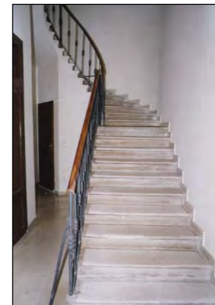
Vano scala secondario
