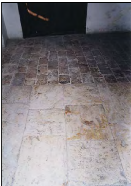
Pavimentazione pianerotto ultimo piano (originale in pietra)
