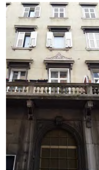
via E. Tarabocchia 5 - particolare della facciata
