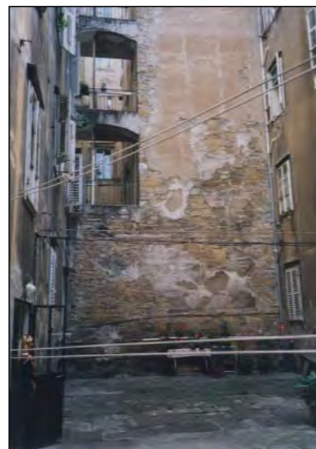
Corte interna (immagine alla data del rilievo)
