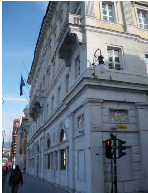
Particolare della facciata principale
