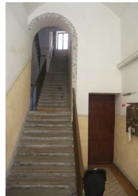
via della Sorgente 9 - ingresso e vani scala
