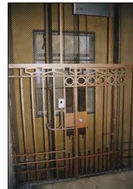
Particolare - gabbia ascensore (nota. La finestra dietro)
