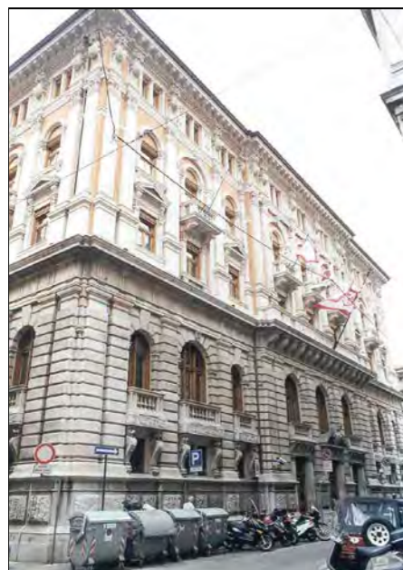
Facciata su via Cassa di Risparmio
