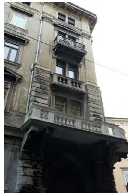
Via della Ginnastica 1 - particolare della facciata
