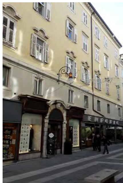
Facciata su via Dante Alighieri
