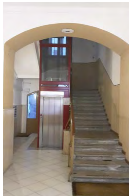
Atrio e vano scala con ascensore
