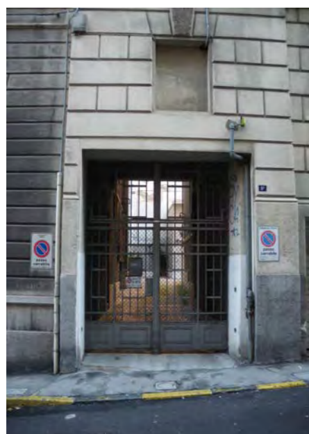
via G. Brunner 8 - cancellata d'ingresso alla corte
