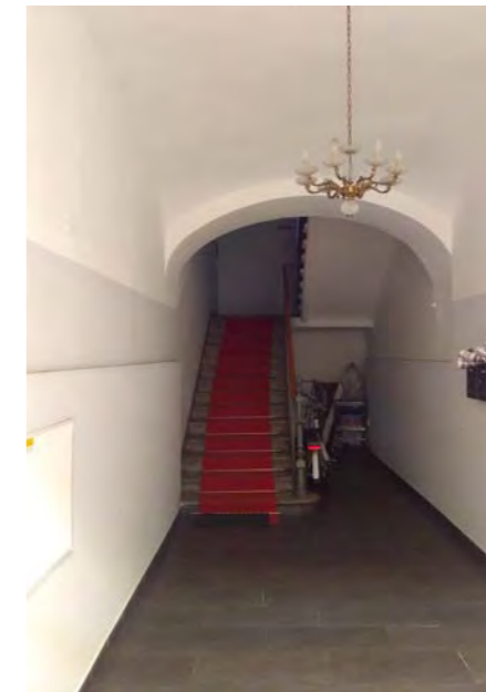
via San Maurizio 5 - ingresso e vano scala
