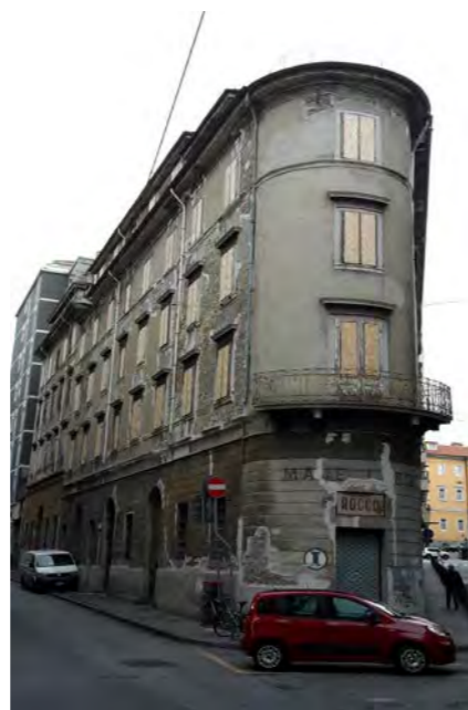
Facciata su via S. Slataper
