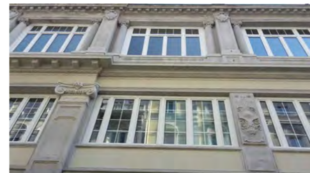
Particolare - forature ed infissi esterni
