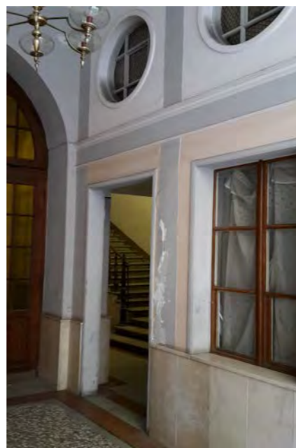
via G. Gatteri 6 - atrio con accesso al vano scala
