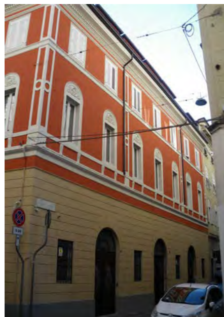
prospetto su via della Maiolica
