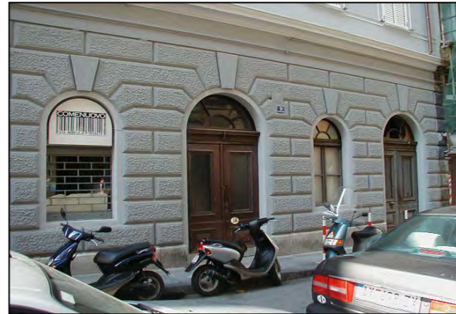
Particolare del pianoterra
