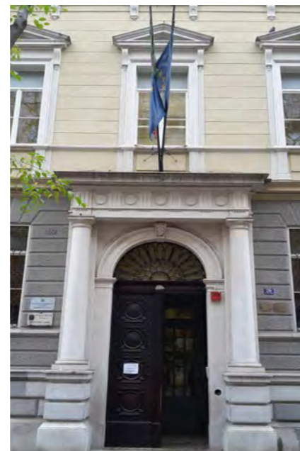
Particolare portone d'ingresso su viale XX Settembre 26
