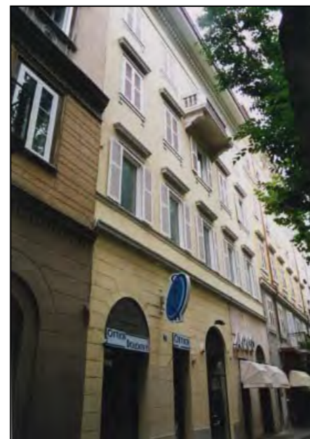
Facciata su viale XX Settembre
