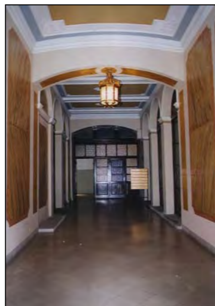
Corte interna - la corte e i prospetti sono in mediocre stato conservativo, ma l'assenza di manomissioni costituisce un valore da preservare.
