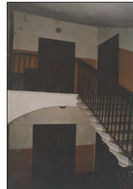
corpo scala via della Maiolica 17 (immagine alla data del rilievo)
