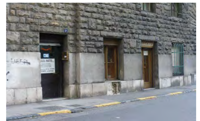
via A. Canova 2 - locali commerciali al p.t.
