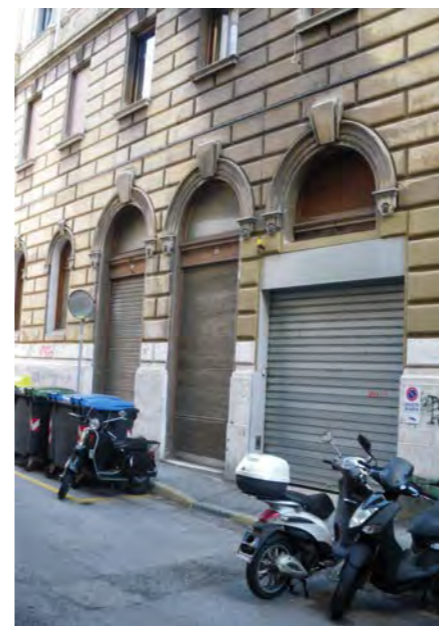
via F. Crispi 29 - alterazione di foratura al piano terra
