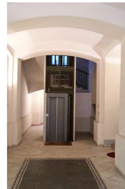
via San Francesco d'Assisi 23 - particolare dell'atrio
