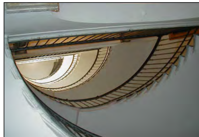
Particolare del vuoto del corpo scala
