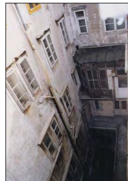
All'interno del cavedio rimangono rilevabili al 1° piano un ballatoio ed al 2° piano una veranda in legno.
