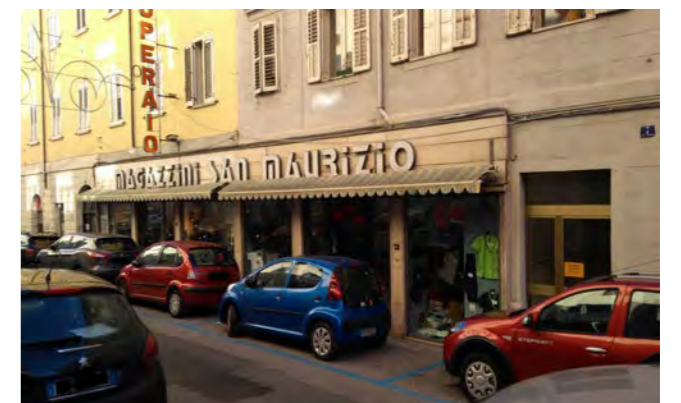
via San Maurizio 9; 7 - particolare dell'alterazione delle forometrie al piano terra
