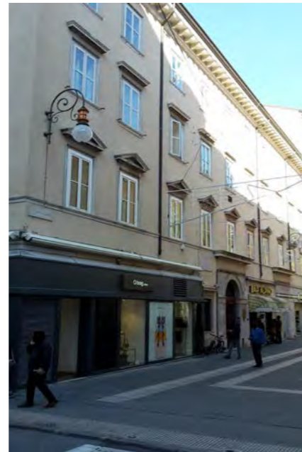
facciata su via S. Lazzaro
