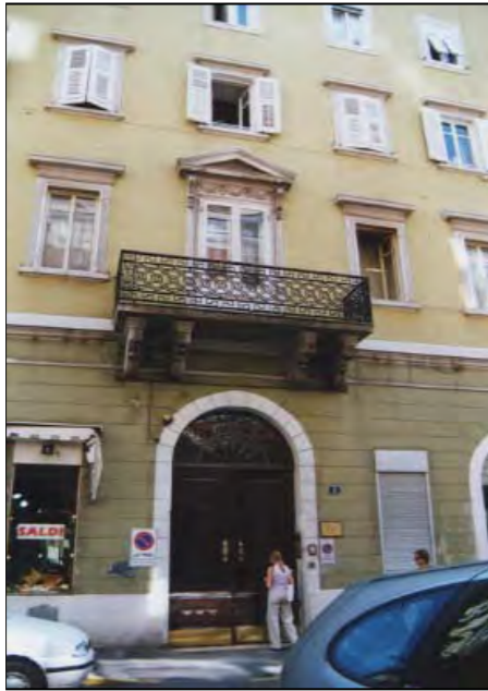
Facciata su via San Francesco d'Assisi
