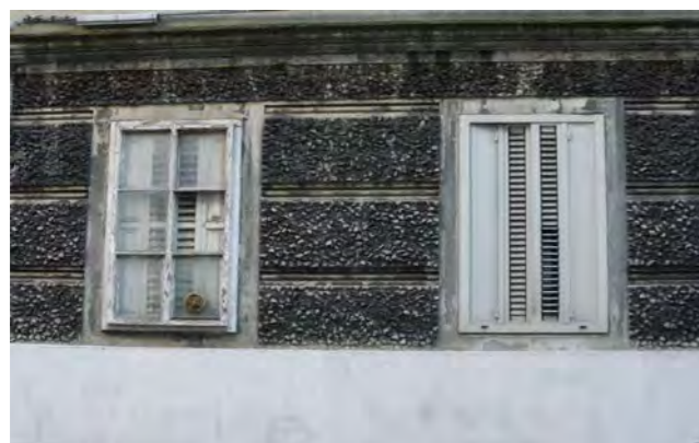
particolare di serramenti al piano terra
