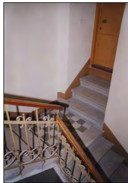
Vano scala (fotografia del 2000)
