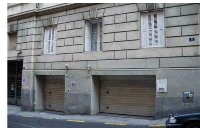
via G. Brunner 8 - alterazione dei fori al piano terra
