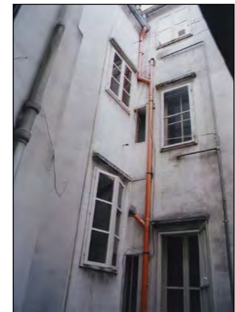
Cavedio verso l'edificio di via Roma 12
