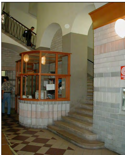
Corpo scala a tre rampe ortogonali
