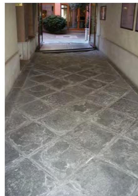
pavimentazione in pietra dell'androna
