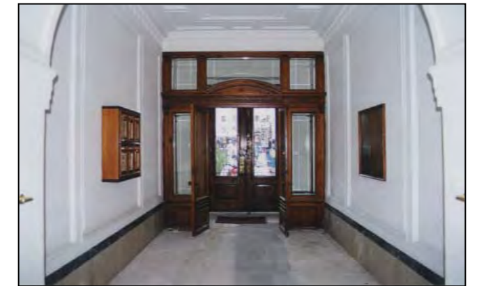
L'ingresso è caratterizzato dalla presenza di decorazioni in gesso e dalle porte in legno.
