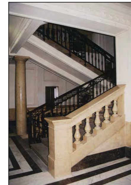
viale XX Settembre 1 corpo scala
