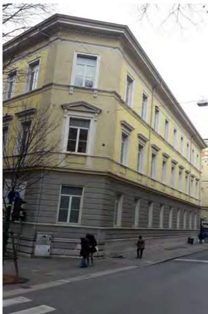
Prospetto su via G. Gatteri
