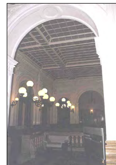
Particolari dello scalone al 1° piano
