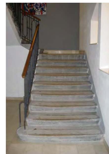
via A. e F. Nordio 11 - particolare dell'atrio e del corpo scala principale
