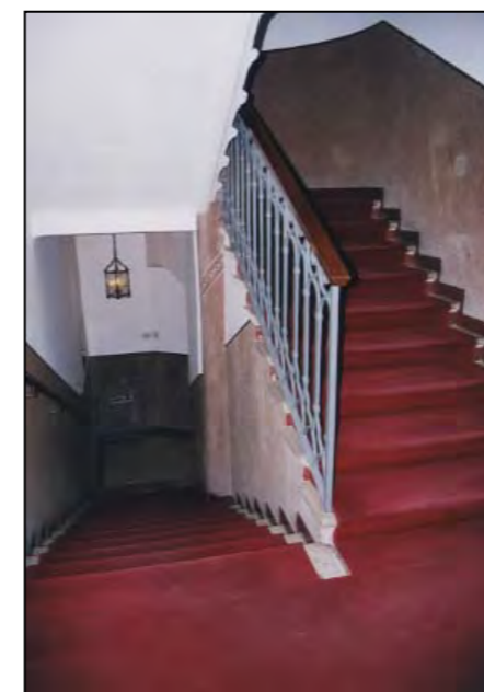
Vano scala via Genova 12
