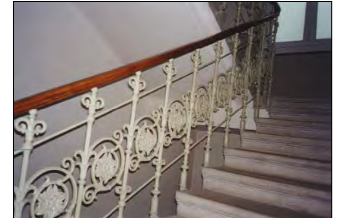
Particolare della ringhiera della scala
