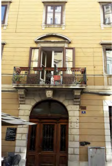
Particolare della facciata e del portone d'ingresso
