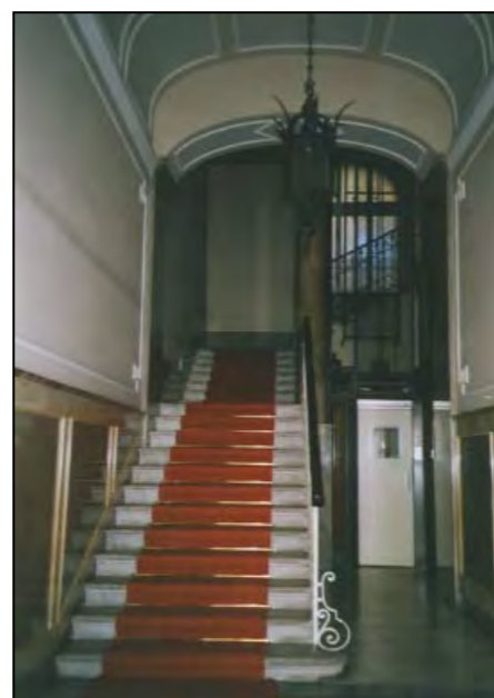
Rampa di rialzo e vano scala a 3 rampe ortogonali
