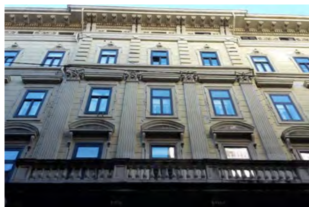
via della Ginnastica 31 - particolare della facciata,
