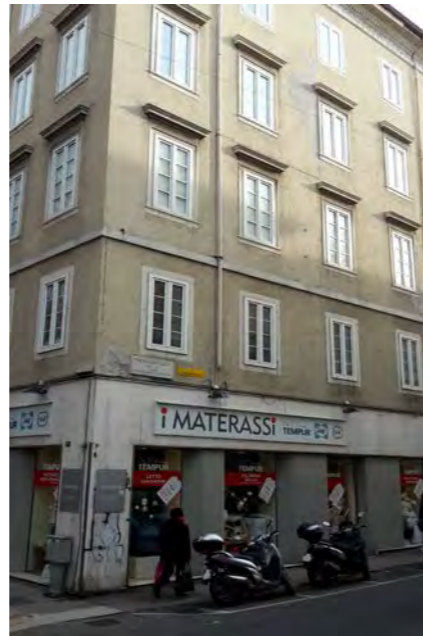
Particolare - pianoterra su viale XX Settembre e su via R. Timeus (nota: l'alterazione sia nelle forature, sia nel paramento murario nascosto dall'inserimento del marmo. Tutto senza alcun rapporto con il sovrastante prospetto).
