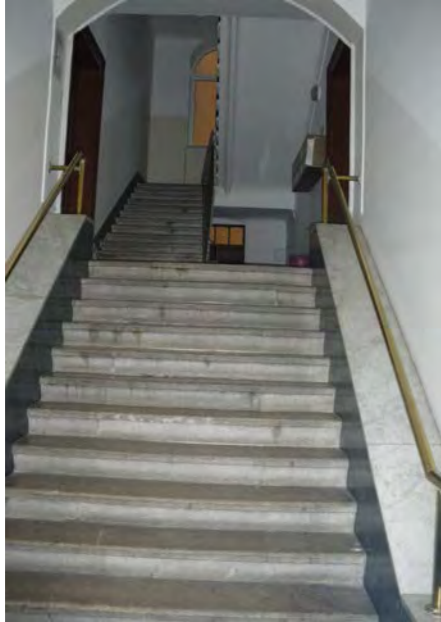
via Ginnastica 45 - ingresso e vano scala
