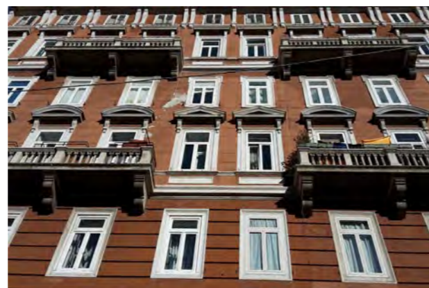
via C. e G. Stuparich 4 - particolare della facciata
