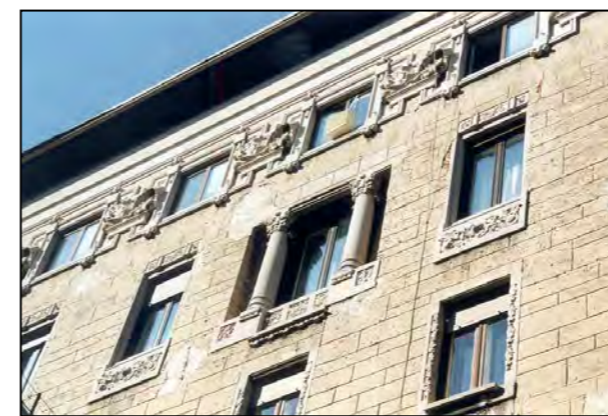
Particolare - forature e paramento murario
