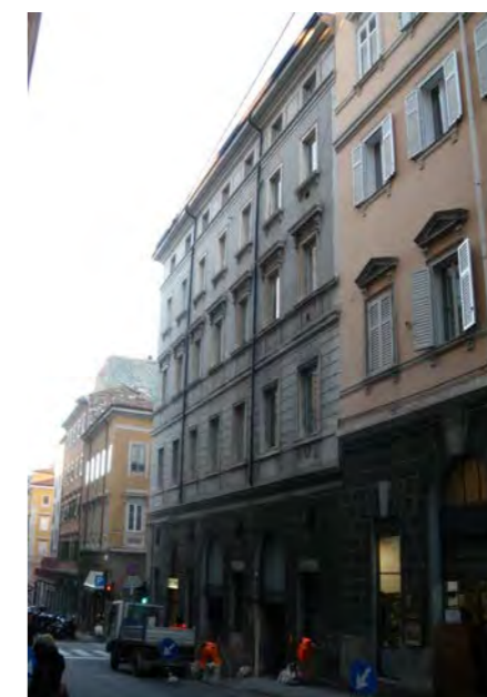
via G. Brunner 10 - prospetto su via della Ginnastica
