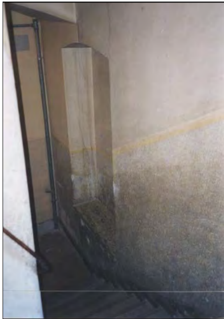
Finestra murata su vano scala
