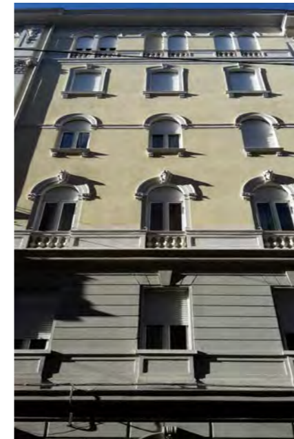
particolare delle forature
