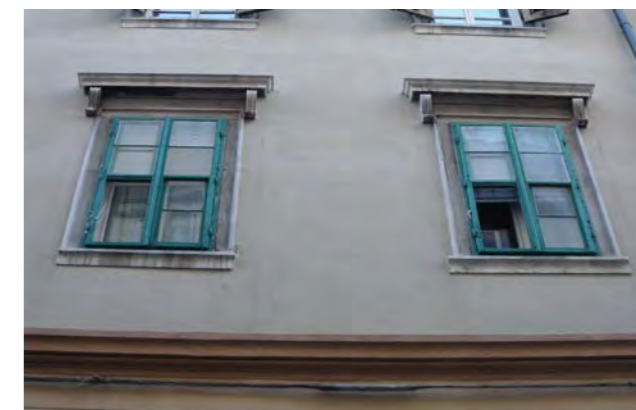
via Fonderia 3 - serramenti in legno a due ante, quattro specchiature con "saliscendi" dello sportello inferiore ancora in uso.
