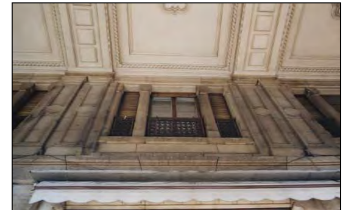
Particolare del trattamento dell' amezzo nel porticato.
