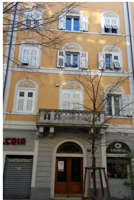
viale XX Settembre 13 - facciata
