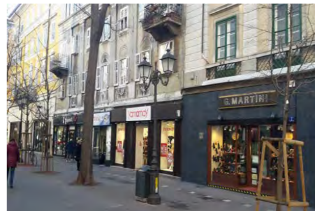
Particolare delle alterazioni del piano terra
