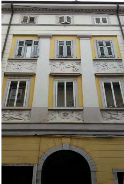
via della Ginnastica 3 - particolare della facciata
