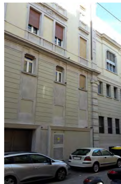
via F. Crispi 4 - facciata
