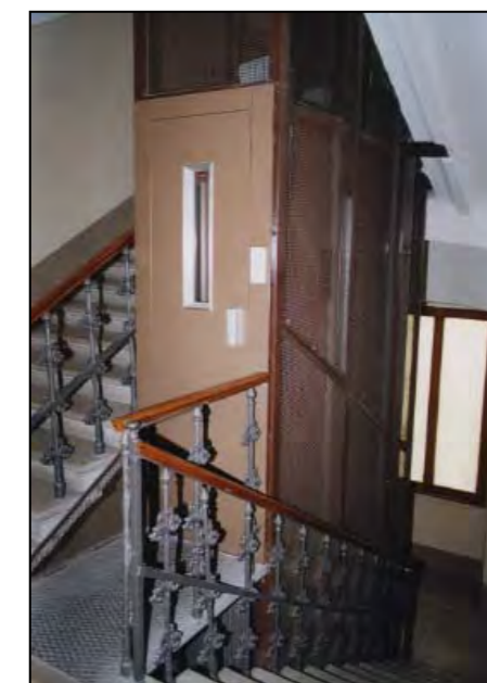
Vano scala trasversale a rampe parallele
