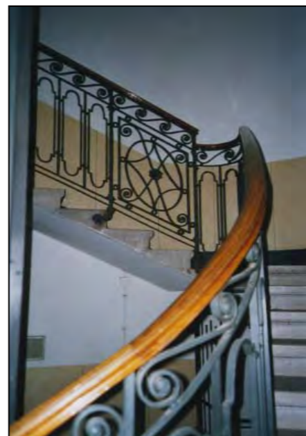
Particolare - ringhiera della scala
