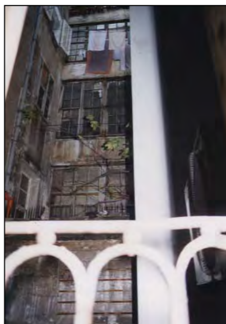
Cavedio - particolare della facciata e il cavedio interno con ballatoio di collegamento e verande in legno
