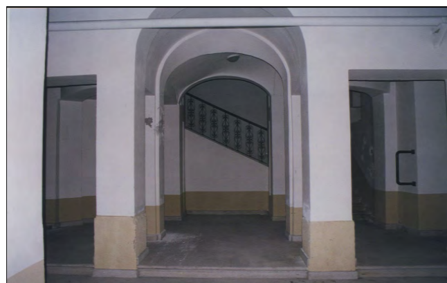
il piano terra su via della Cassa di Risparmio
