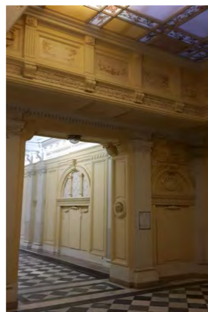
Particolare della sala di disimpegno con accesso all'androne
