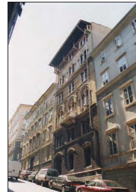
via D. Rossetti 11 (fotografia alla data del rilievo)
