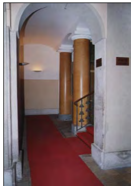
vano scala trasversale a rampe parallele
