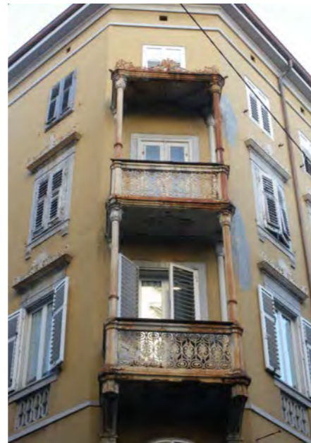
particolare dei poggioli
