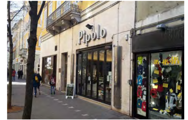
Particolare delle alterazioni del piano terra su viale XX Settembre
