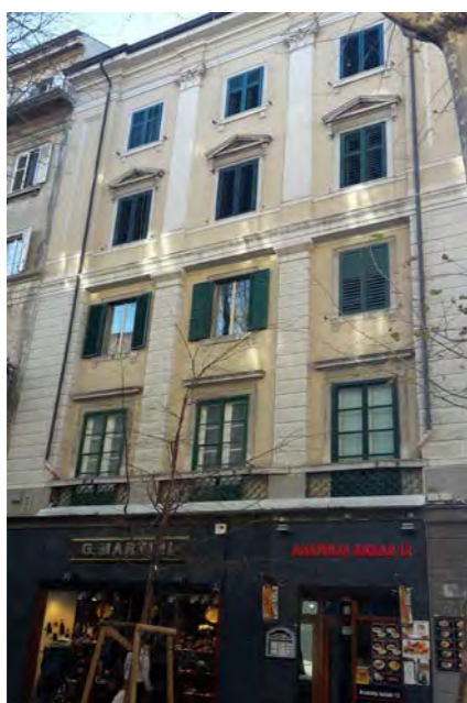
viale XX Settembre 7 - facciata
