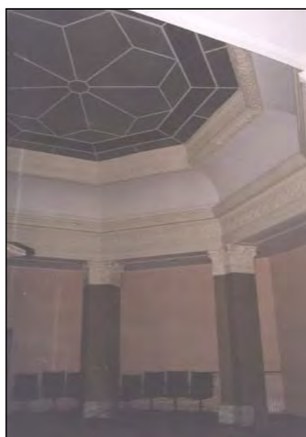
La copertura in vetro policromo della sala
