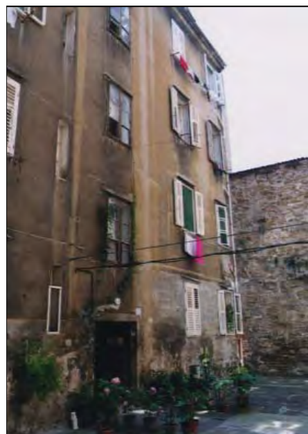
Facciata su corte interna (immagine alla data del rilievo)
