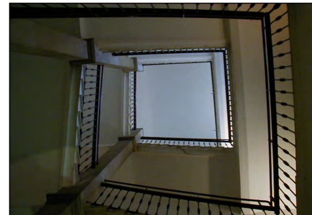
Particolare vano scala visto dal basso
