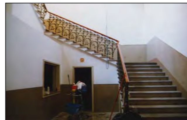
Scalone a 3 rampe ortogonali (fotografia alla data del rilievo)
