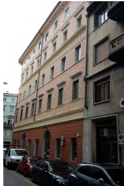
Facciata su via U. Polonio
