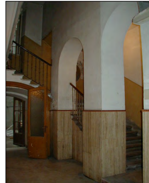
Corpo scala a tre rampe ortogonali
