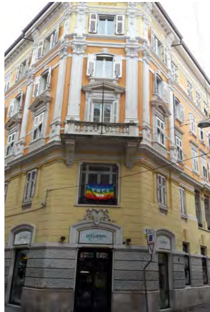
Soluzione d'angolo tra la via E. Tarabocchia e la via delle Erbette
