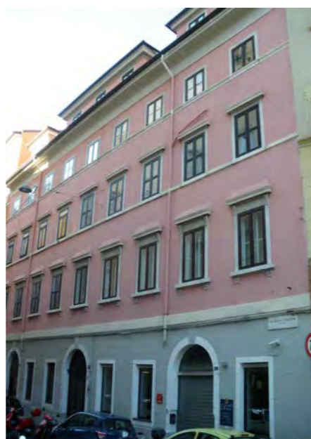
via della Fonderia 12
