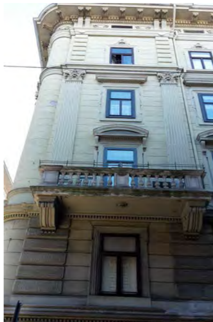
via della Ginnastica 31 - particolare della facciata
