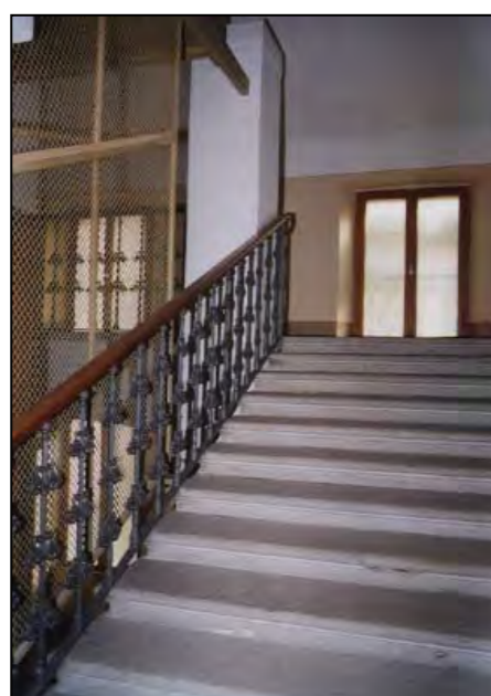
Vano scala a tre rampe ortogonali
