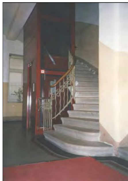
Scala con ascensore
