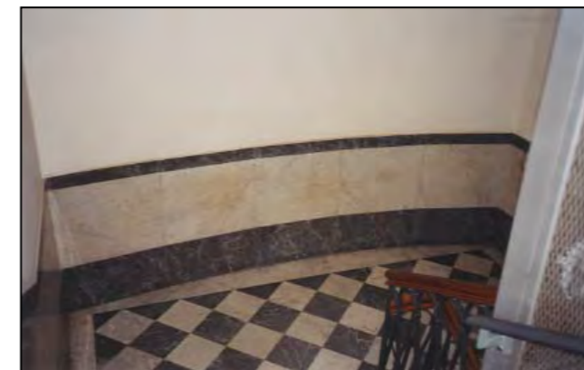
particolare del pianerottolo
