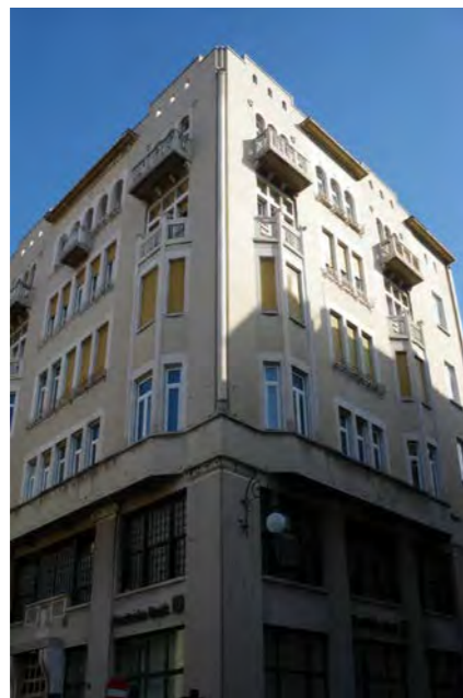
particolari delle facciate - via Roma 7 e via Mazzini 20
