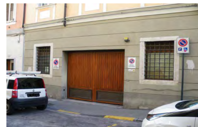
via del Toro 14 - alterazione del piano terra
