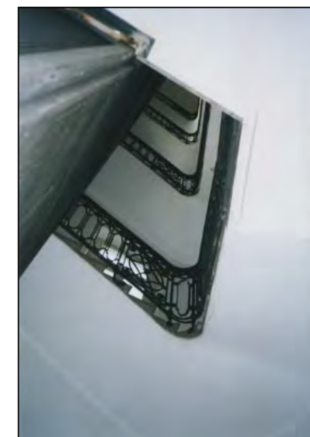
Particolare - tromba della scala, vista dal basso
