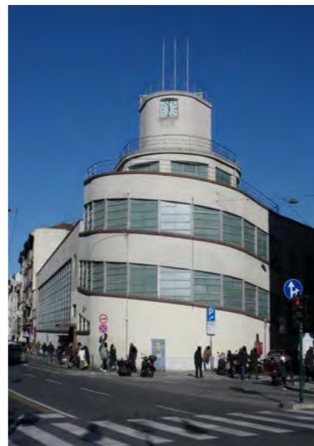
via Carducci 36 mercato comunale - I prospetti esterni presentano un'unica grande vetrata a nastro interrotta alla curva ad ovolo dove fasce orizzontali di cemento e vetro seguono l'andamento elicoidale della rampa interna. I due ingressi sono appena sottolineati da una pensilina e da una cornice rossa in mattoni, come pure il marcadavanzale e il limite superiore della facciata. Lo zoccolo della costruzione è scandito da un rivestimento con lastre di pietra di Monrupino. Il volume dell'edificio si sviluppa orizzontalmente; l'unico elemento verticale è la torretta elicoidale.
