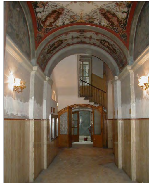
Androne e uscita sulla corte interna
