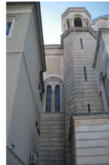
particolare del prospetto su piazza S. Antonio
