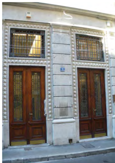
via A. e F. Nordio 11 - particolare del portone d'accesso allo stabile ed un asecondo ad una attività al pianoterra
