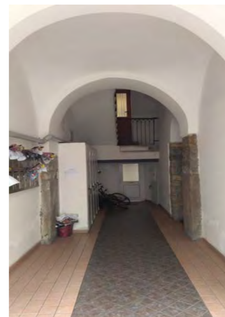
via San Maurizio 9 - ingresso e vano scala
