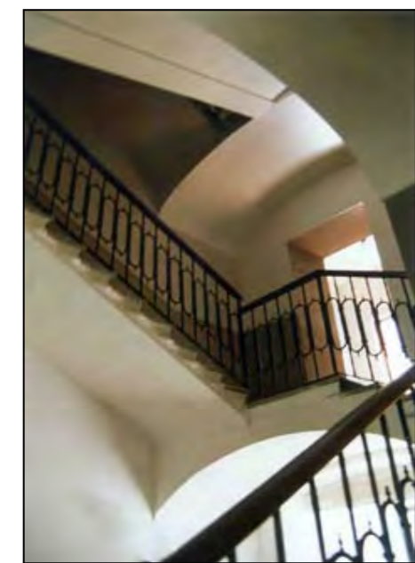
Vano scala a 3 rampe ortogonali
