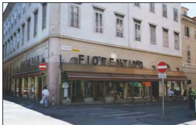
Alterazione al piano terra
