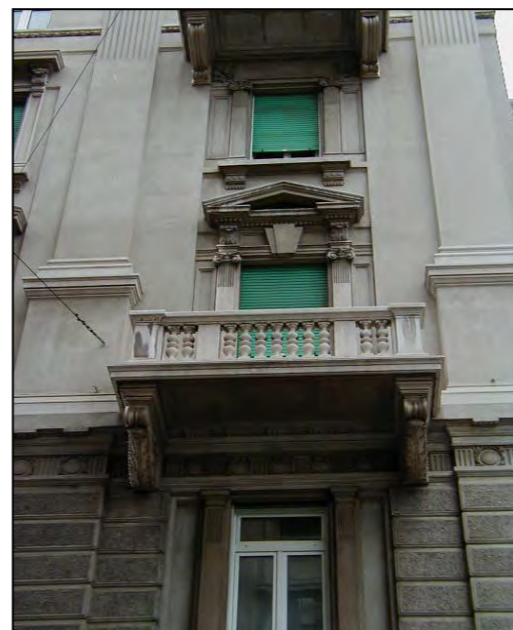
Particolare dei serramenti esterni
