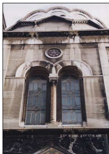
particolare della finestra
