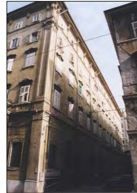
Facciata su androna privata
