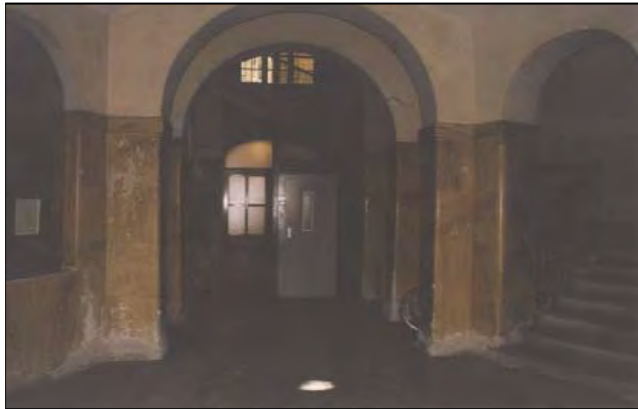
Androne d'ingresso (alla data del rilievo)
