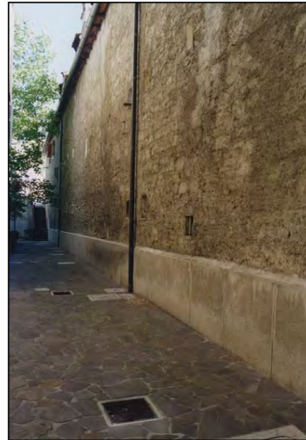
via della Cereria 7 - 5 - 3 prospetto retrostante
