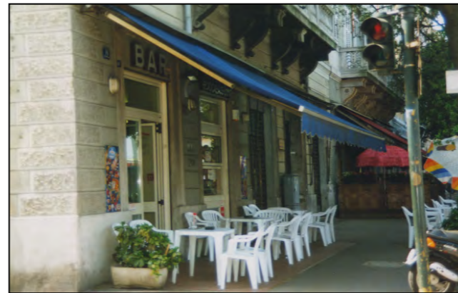
particolare - pianoterra riva N. sauro 16
