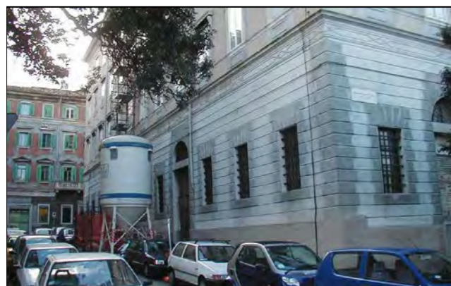
particolare facciata al pianoterra
