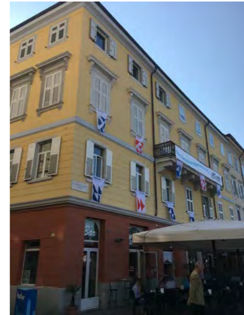
Particolare di facciata su riva N. Sauro
