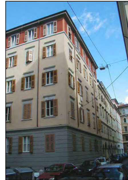
via dei Fabbri 5
