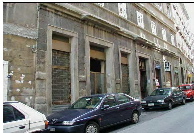
particolare pianoterra, via SS. Martiri 6
