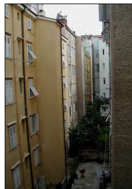
vuoto di risulta tra an. 188 ed an. 192
