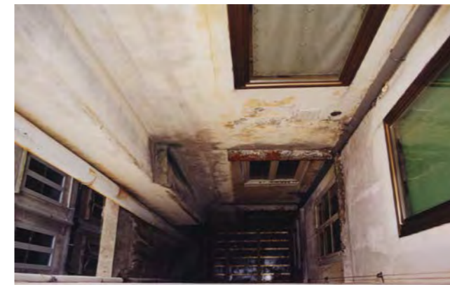
Particolare del cavedio - al piano terra risulta chiuso da un lucernaio
