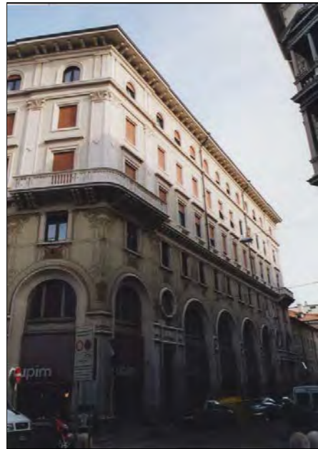
via San Lazzaro 2 e 4 - facciata
