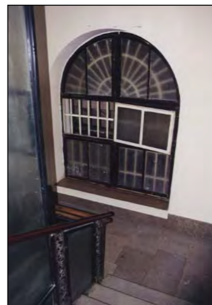
Particolare del corpo scala
