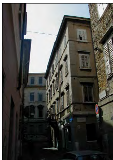
via del Bastione 3 / via F. Venezian 17
