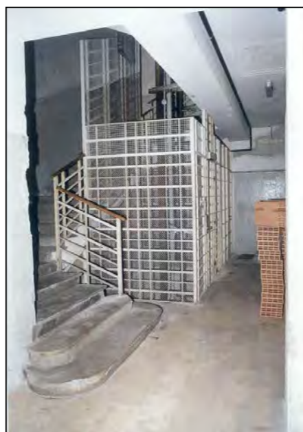
via Mercato vecchio 1 - vano scala
