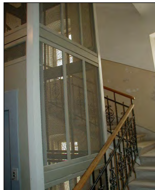
Particolare del corpo scala
