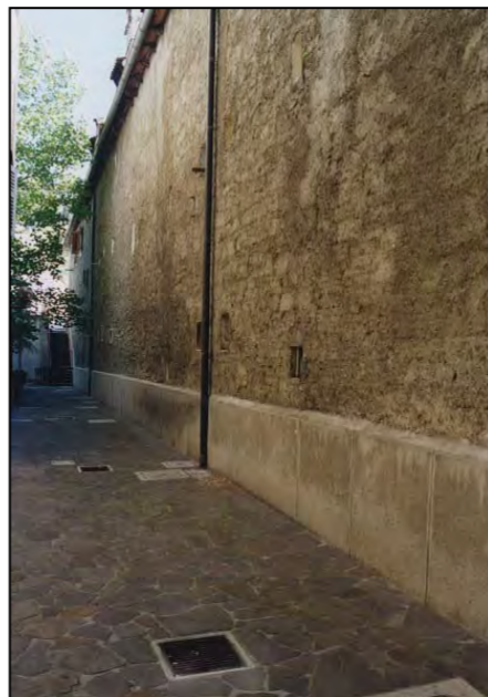
via della Cereria 7 - 5 - 3 prospetto retrostante
