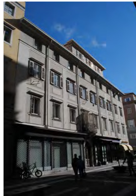
Particolare facciata su via San Nicolò
