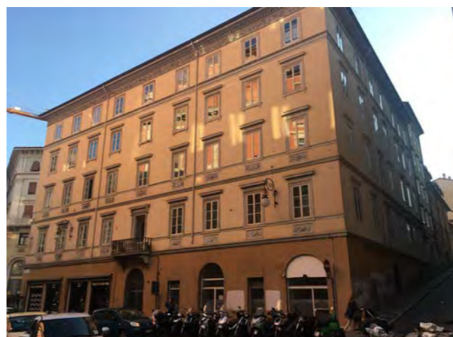
Facciata su piazza S. Benco
