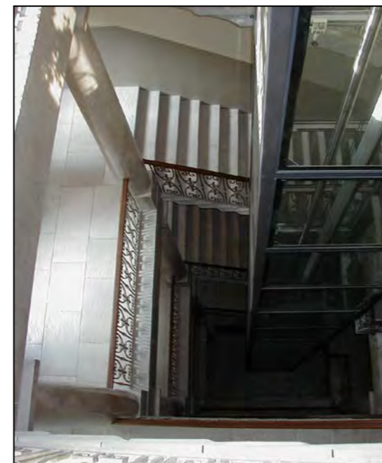
Particolare vuoto interno al corpo scala
