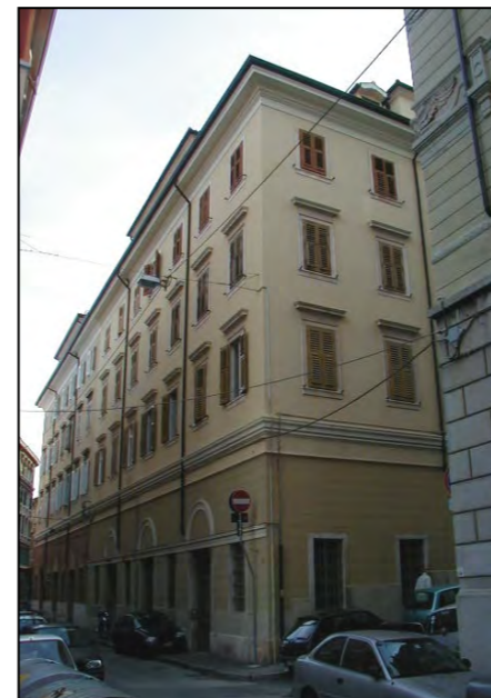
via dei Fabbri 4
