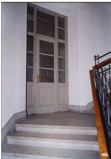
via Santa Caterina 1 - vano scala
