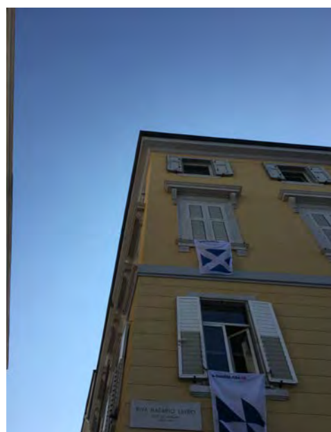
Particolare di facciata su riva N. Sauro
