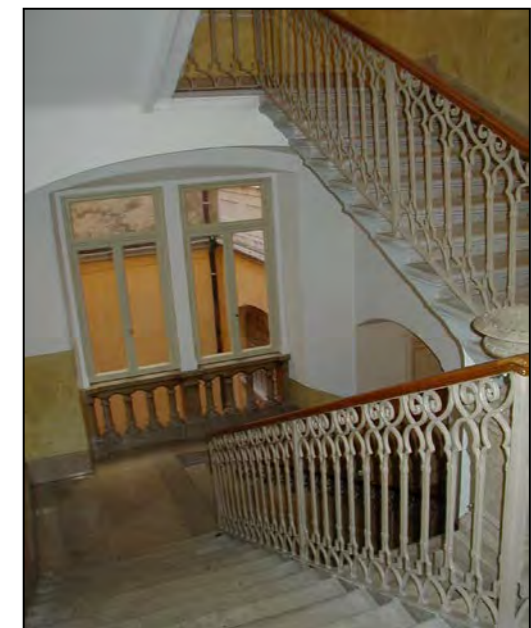
Particolare corpo scala
