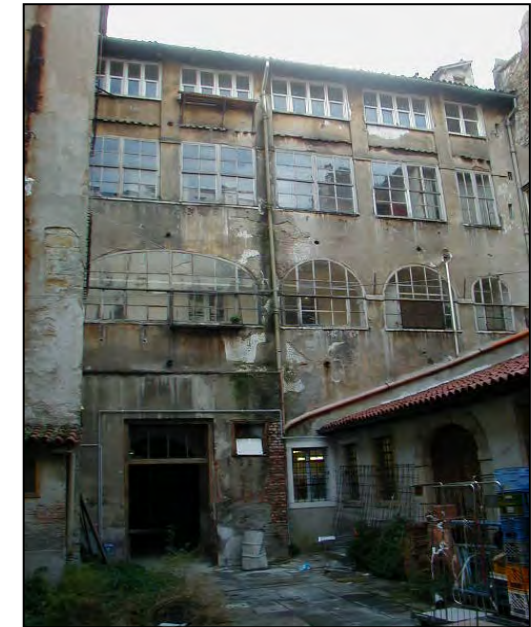
Cortile interno (fotografia alla data del rilievo)
