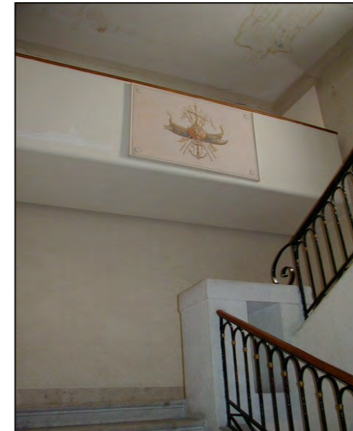
Particolare ultimo piano del corpo scala an. 49
