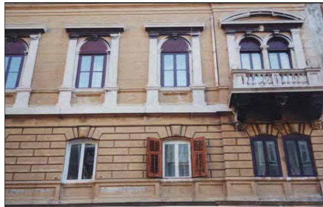
Particolare serramenti esterni
