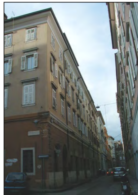
via dei Fabbri 2 - 4
