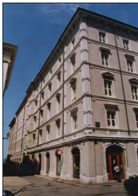
Prospetto laterale su via dell'Arsenale
