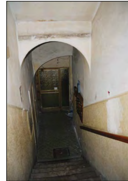
Atrio d'ingresso: parte relativa all'accesso alla scala
