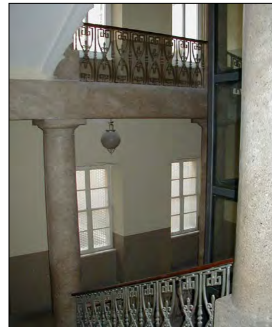
Particolare corpo scala
