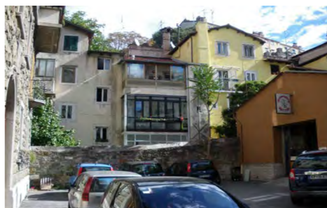
via F. Cappello: le facciate, interne al cortile, delle case operaie hanno bussole e latrine
