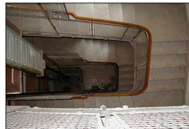
Particolare del corpo scala
