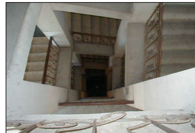
Corpo scala visto dall'alto (fotografia alla data del rilievo)
