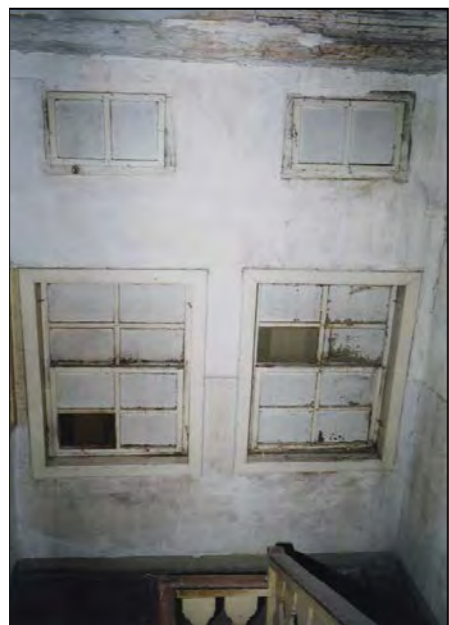
Particolare finestratura pianerottolo
