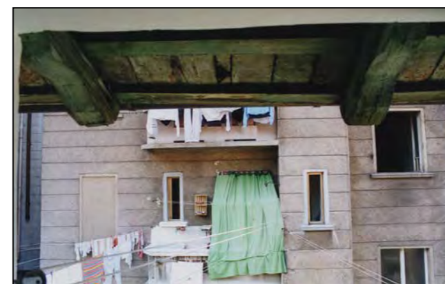
Lo sporto del tetto in legno verso il cortile e l'ultima rampa delle scale in legno, sono elementi comuni a tutte le case a schiera della via S. Michele dal civ. 13 al civ. 29 (immagine alla data del rilievo)
