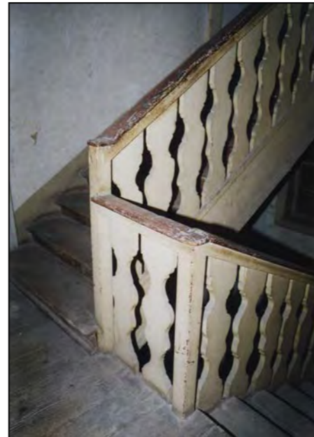
Particolare balaustra in legno
