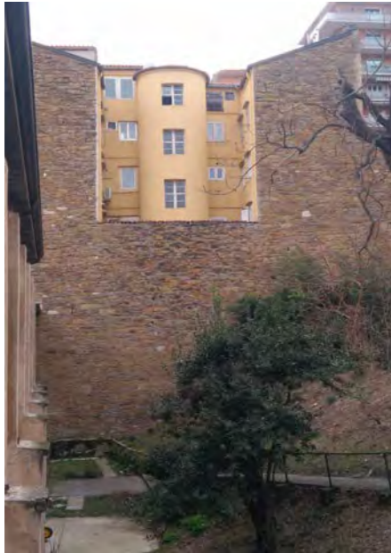
via della Cereria 13 - facciata postica con pianerottolo del corpo scala aggettante e semicircolare
