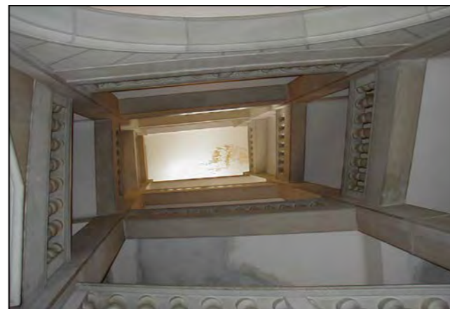
Corpo scala visto dal basso
