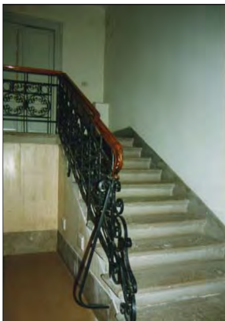
Particolare - scale a rampe parallele
