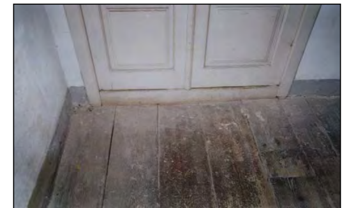
Particolare pavimentazione pianerottolo in tavolato di legno
