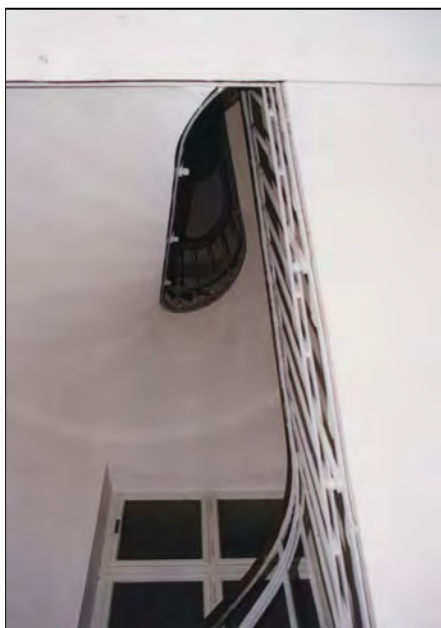
Vano scala secondario
