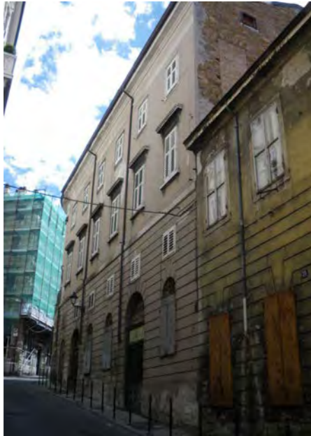
Prospetto su via Venezian
