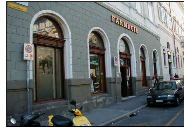
Particolare dei serramenti del piano terra
