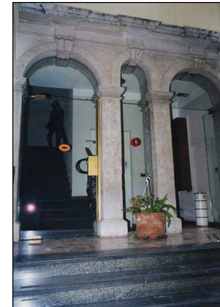
corso Italia 21, corte interna - ingresso edificio All'edificio si accede attraverso la corte, rimaneggiata impiegando materiali incoerenti con le caratteristiche tipologico-costruttive del manufatto
