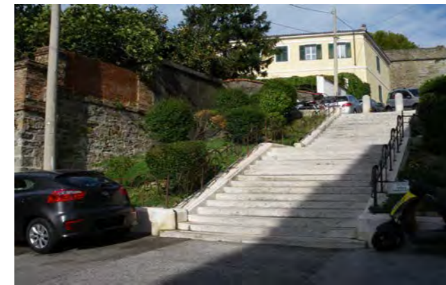
Il sistema di muratura chiude l'isolato lungo la scala Winckelmann.
