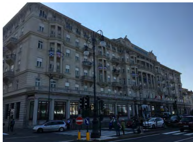
particolare facciata su riva del Mandracchio
