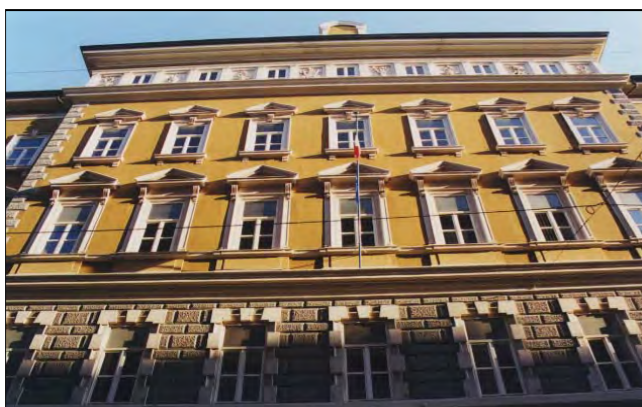
particolare facciata via Diaz
