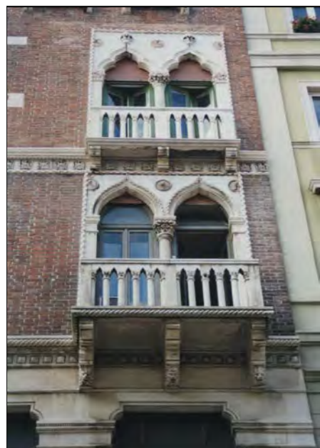
Particolare di una bifora in facciata
