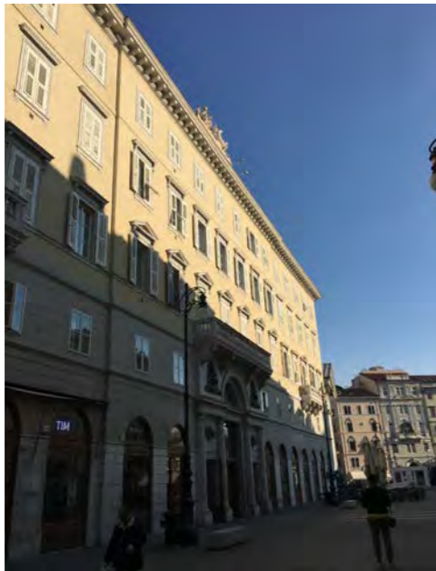
Ingresso alla galleria da piazza della Borsa
