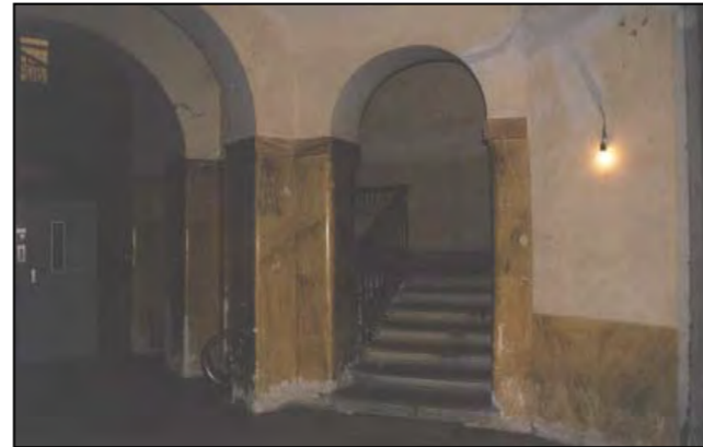
Androne d'ingresso (alla data del rilievo)
