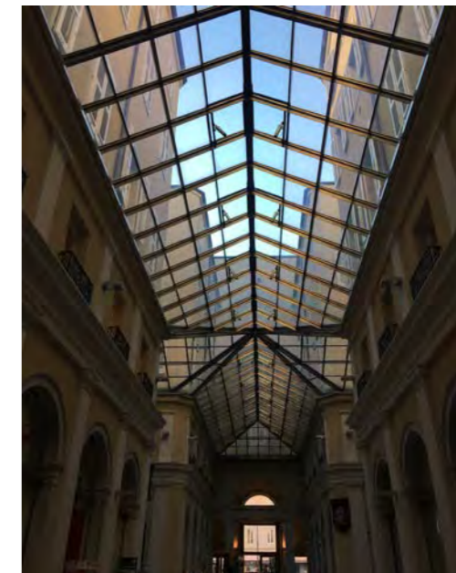
Particolare della galleria
