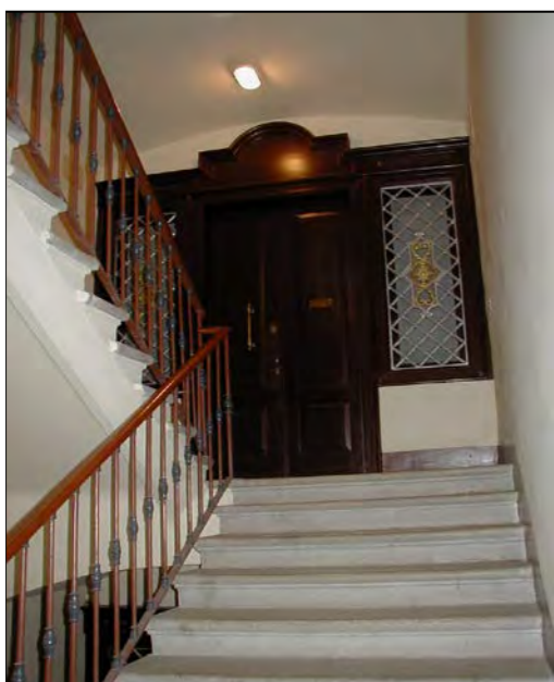
Particolare primo corpo scala
