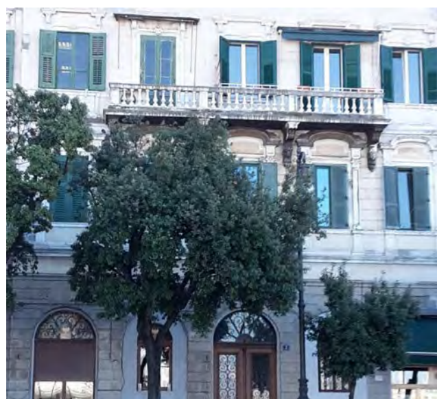
particolare della facciata- riva Grumula 2
