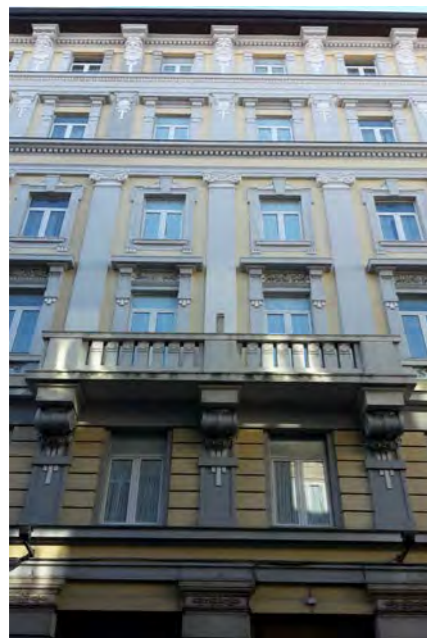
via A. Diaz 14 - particolare della facciata
