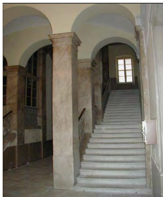
Particolare corpo scala
