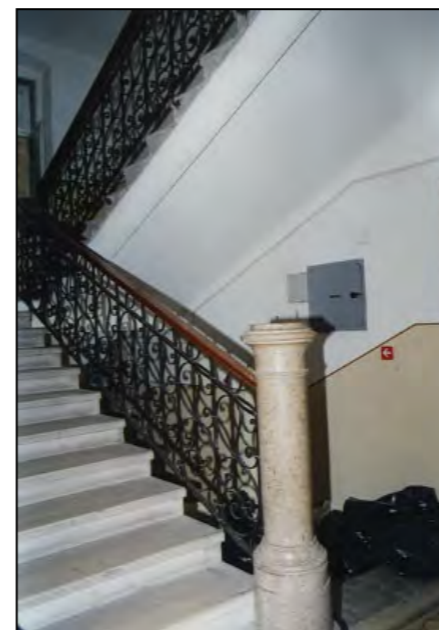
Scala a rampe parallele
