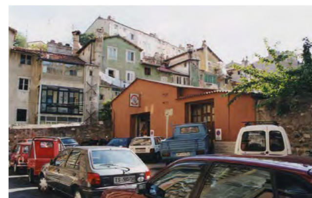
via F. Cappello 2: edificio per attività artigianali
