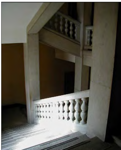
Particolare del corpo scala
