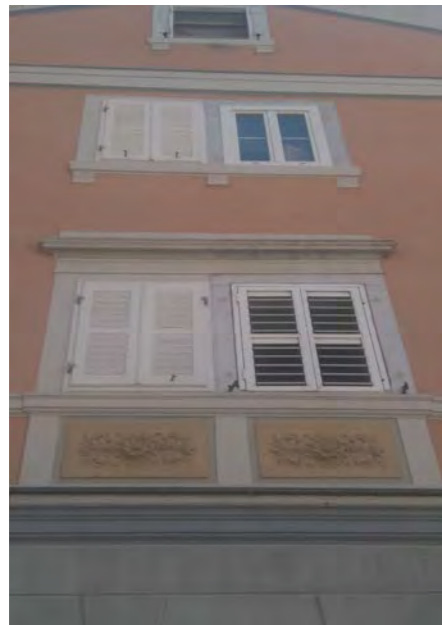
Prospetto su via della Cereria con finte persiane ("scuri") in malta - particolare
