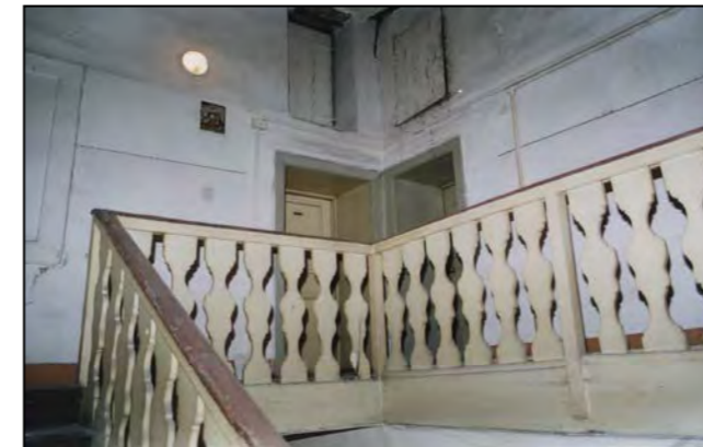
Vano scale in legno
