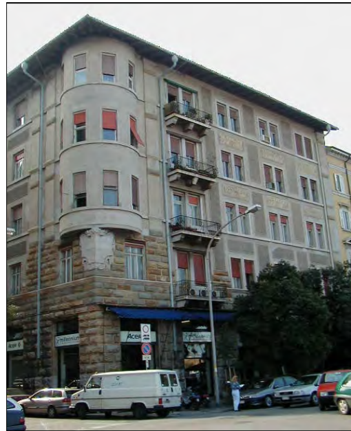
Prospetto su riva Grumula
