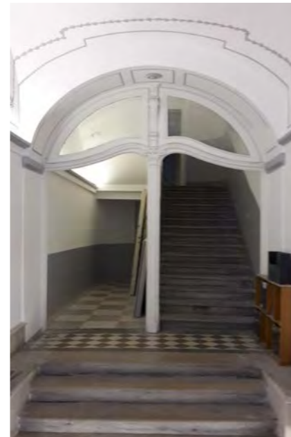
via Mazzini 21 - atrio e corpo scala
