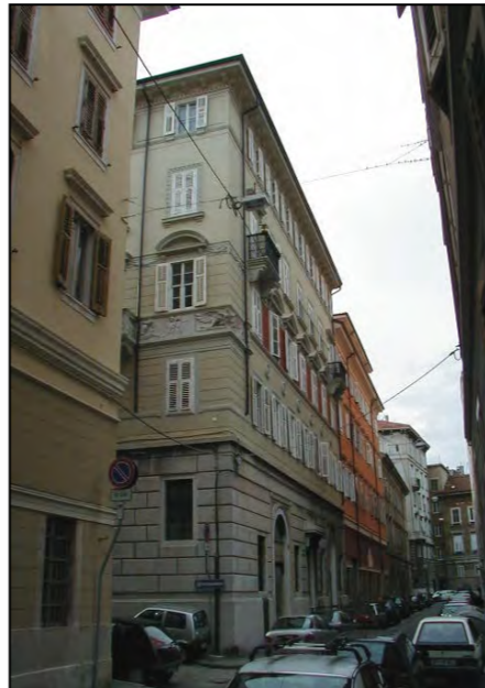
via dei Fabbri 8 - 6
