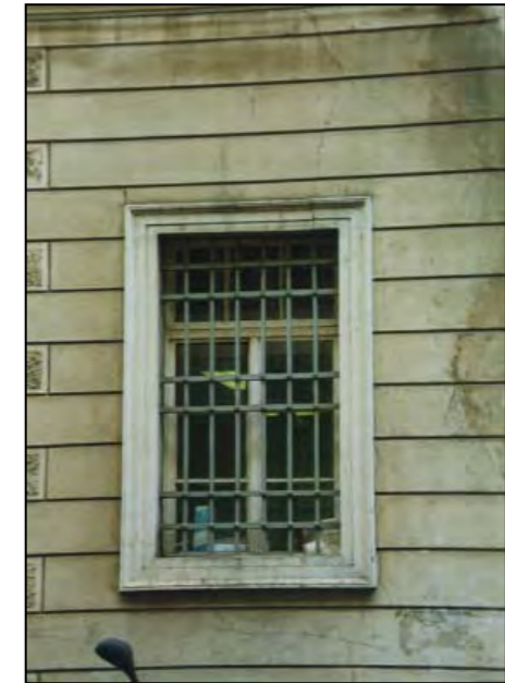
Particolare - serramento esterno
