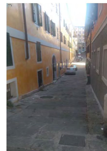
pavimentazione in pietra lungo via Cereria
