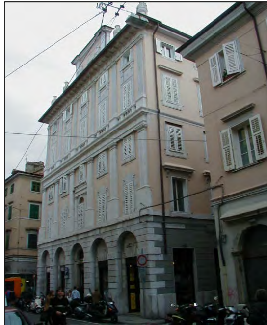
Prospetto principale su via di Cavana
