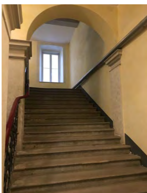
Particolare del corpo scala
