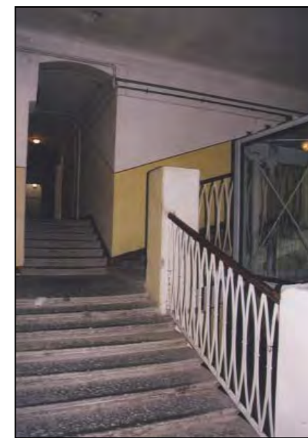
Vano scala ultimo piano
