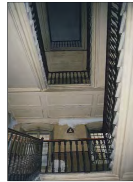
Vano scala (fotografia alla data del rilievo)
