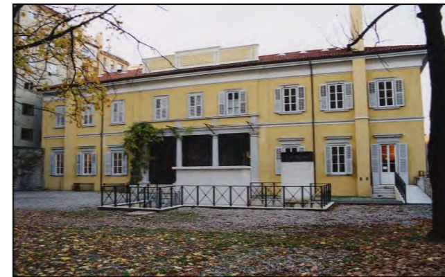
Palazzo "Brambilla - Morpurgo": facciata interna, in primo piano centrale termica
