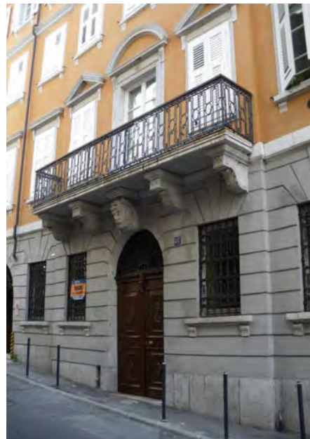
Prospetto su via Venezian 23
