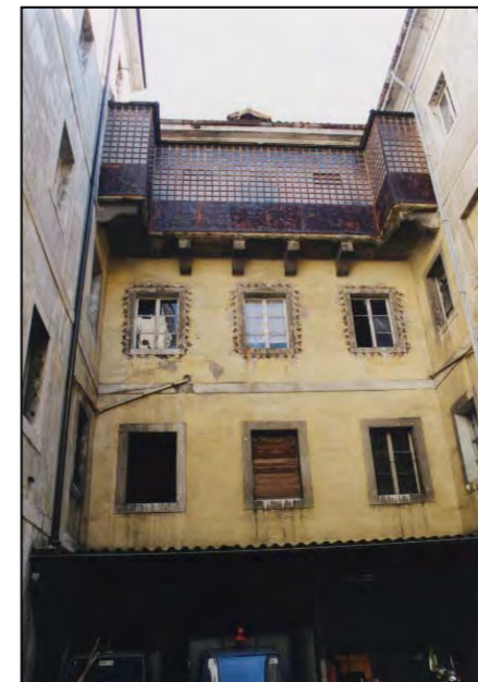
via Tigor 2 cortile interno (immagine alla data del rilievo)
