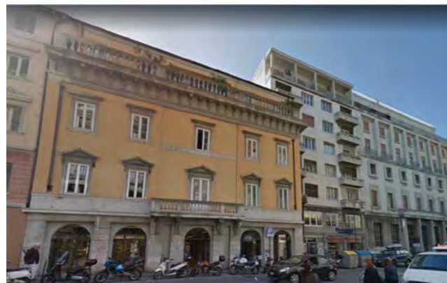
Prospetto su corso Italia 9
