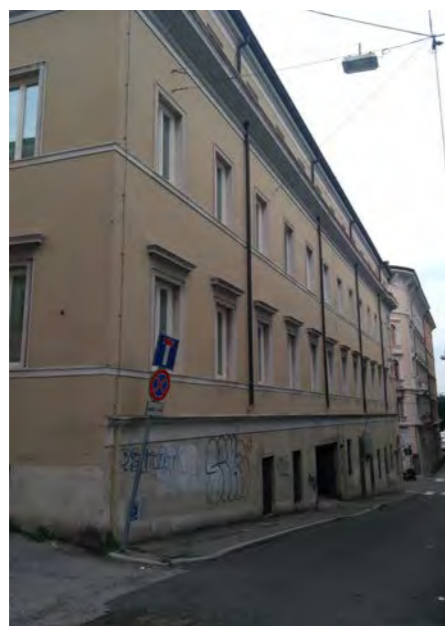
anagrafico 91. Facciata in via Belpoggio 3/1
