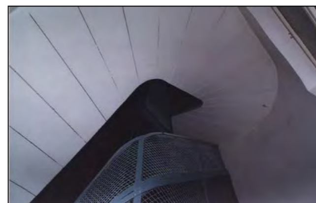
Particolare del corpo scala
