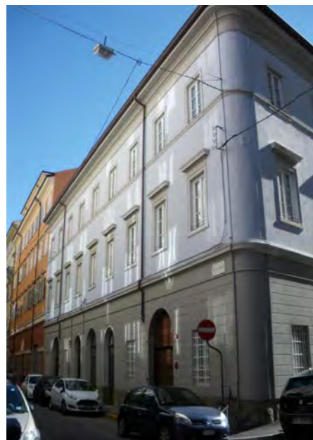
via dei Fabbri 10
