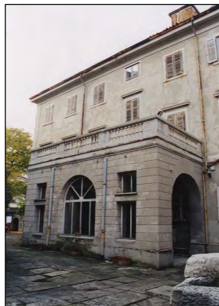
particolare facciata postica
