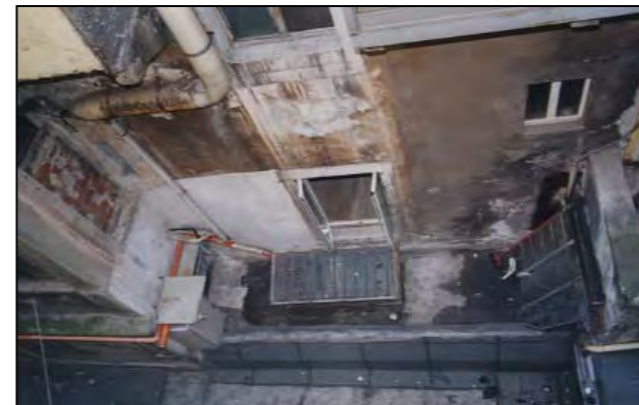
Lo stato della corte interna
