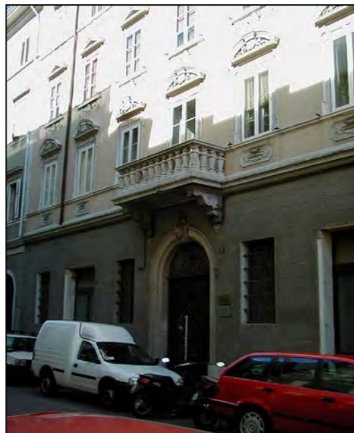
Particolare prospetto su via del Lazzaretto Vecchio
