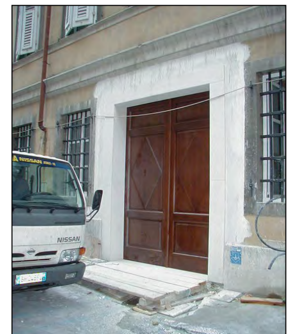
Portone d'ingresso su via Santi Martiri
