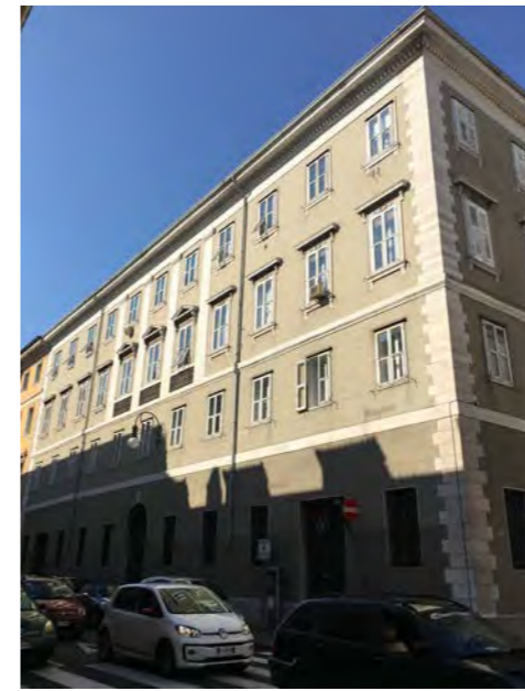
Prospetto su via L. Cadorna
