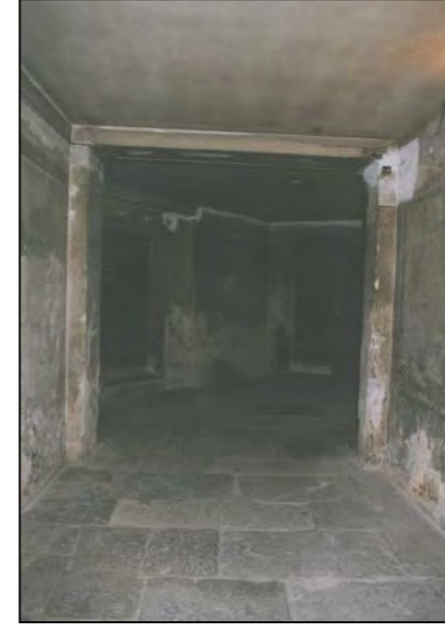
Atrio d'ingresso (alla data del rilievo)
