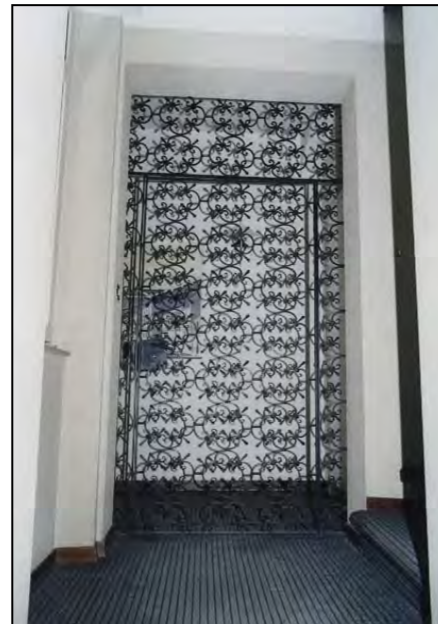
corso Italia 21, interno pianerottoli Tutte le rampe delle scale in pietra sono state rivestite di moquette, come pure la pavimentazione dei ballatoi della corte interna. Questi ultimi sono stati chiusi con serramenti in vetro e pvc
