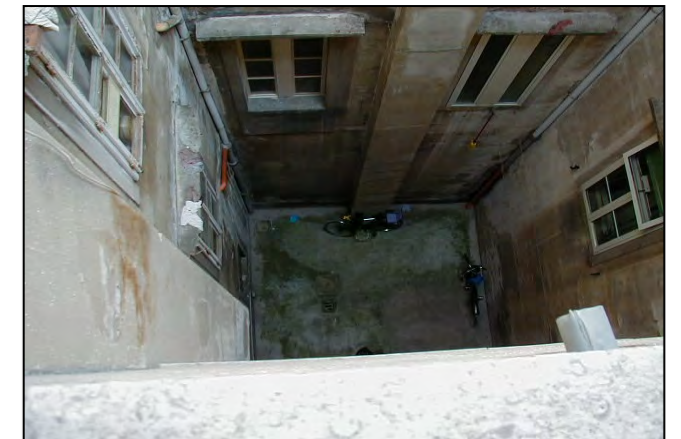
Particolare del cavedio
