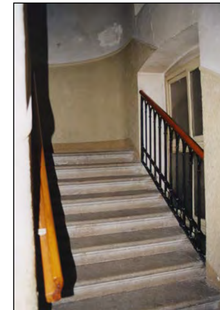
Scala a rampe parallele
