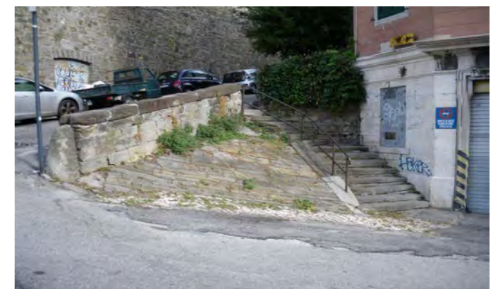
elementi in pietra presso il civico 17 di via Guerrazzi: scala, pavimentazione, paracarro, muretto di delimitazione stradale su via T. Grossi.
