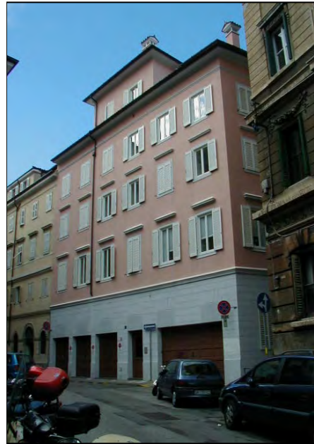
via dei Fabbri 1
