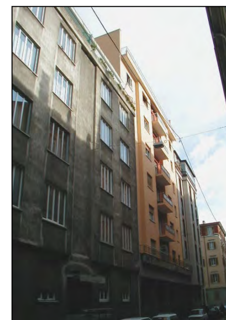
via dei Fabbri 11 - 9
