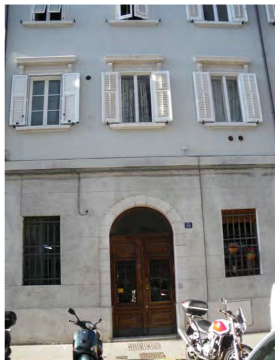
Particolare - serramenti esterni
