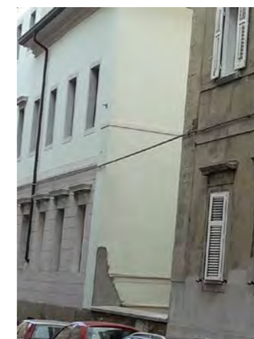
via dell'Università muro di corrispondenza dell'androna
