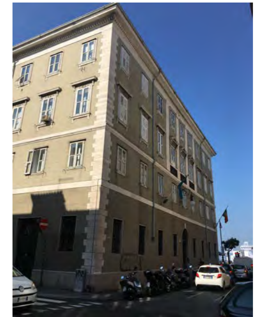
Prospetto su via F. Venezian
