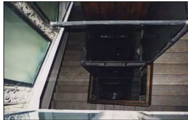
Particolare del corpo scala
