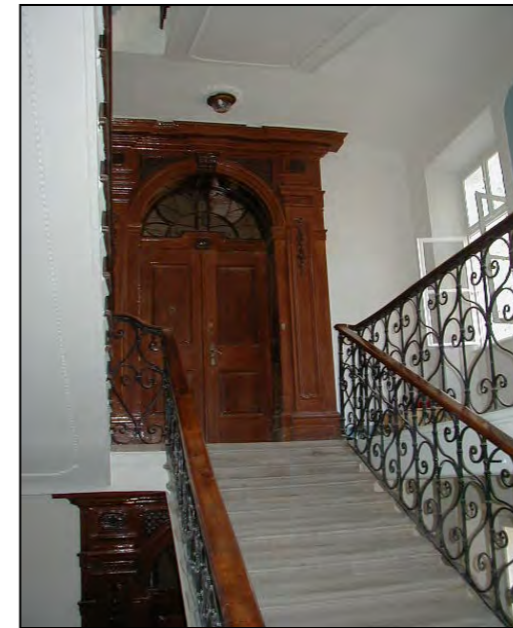
Particolare del corpo scala
