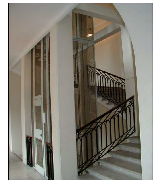
Particolare del corpo scala dell'anagrafico 63
