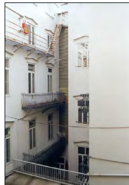
particolare dei balconi prospicienti la corte
