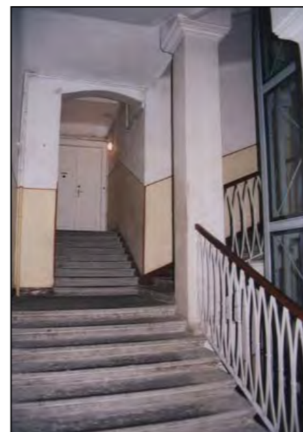
Particolare quarta rampa che parte dal 2° pianerottolo del corpo scala
