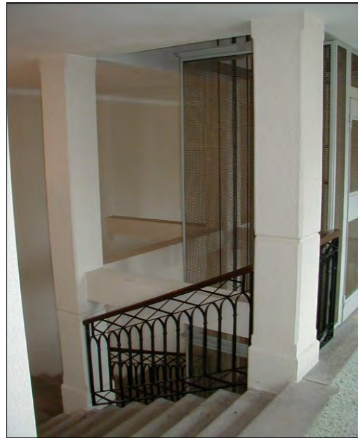
Particolare del corpo scala dell'anagrafico 63
