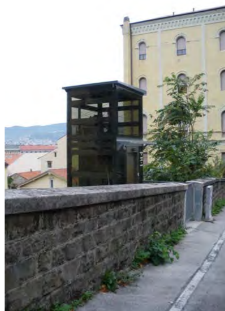
ascensore di collegamento privato tra androne Campo Marzio e via Belpoggio
