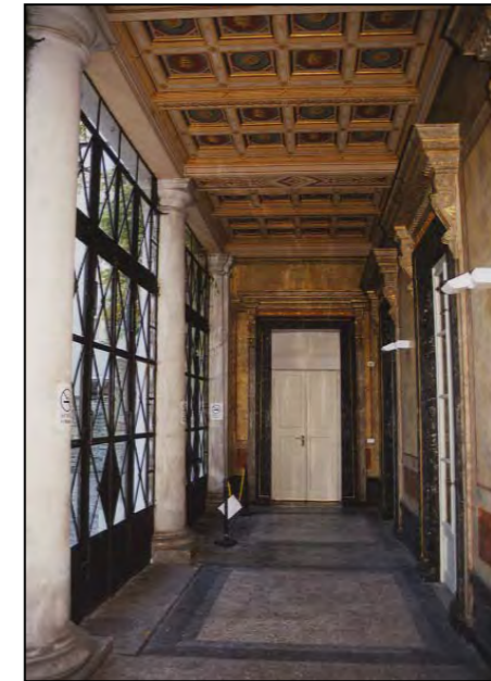
Palazzo "Brambilla - Morpurgo": particolare del portico sul giardino
