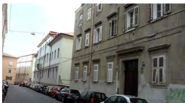
muro in corrispondenza dell'androna - via dell'Università 13
