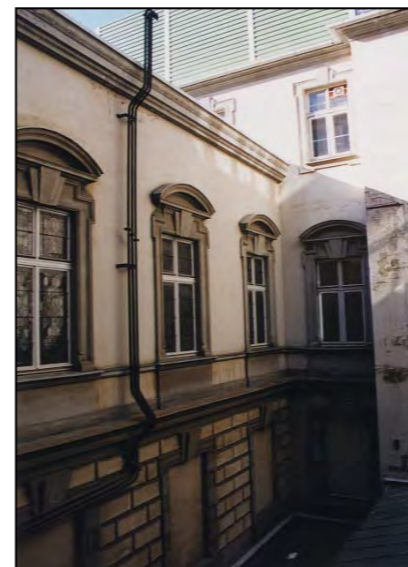
le finestre del vano scala principale
