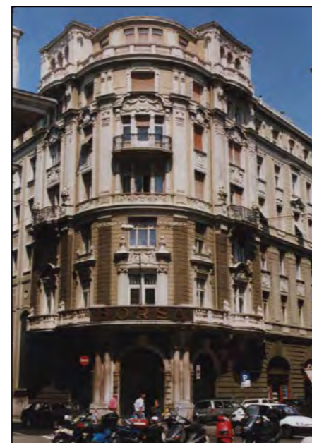
via della Cassa di Risparmio / via del Canal Piccolo
