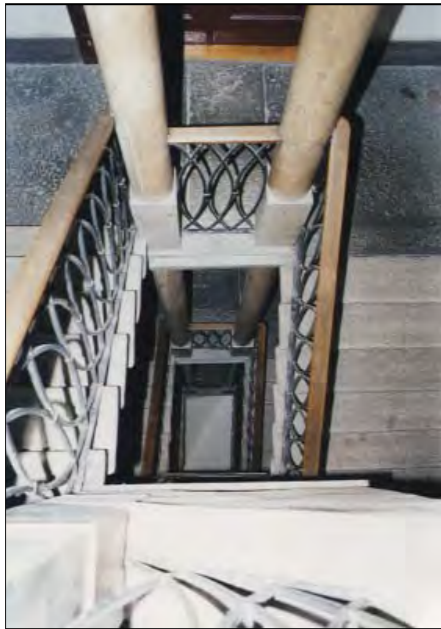
Vano scala a tre rampe ortogonali in pietra
