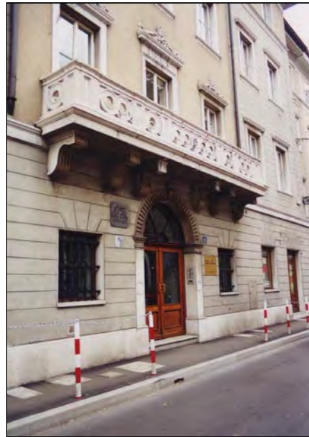
Particolare portale d'ingresso
