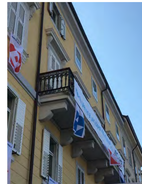
Particolare di facciata su riva N. Sauro
