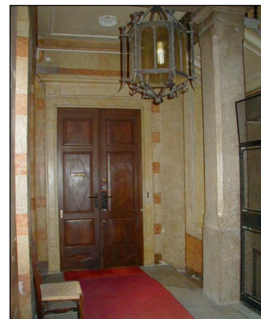
Particolare del pianerottolo
