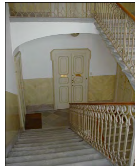
Particolare corpo scala
