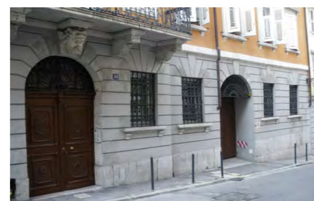
ingresso al fabbricato ed alla autorimessa
