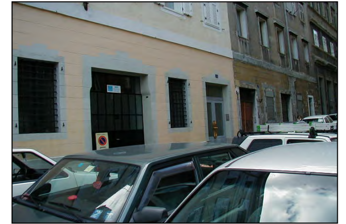
particolare pianoterra, via SS. Martiri 2
