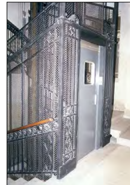
via L. Cadorna 3 - vano scala
