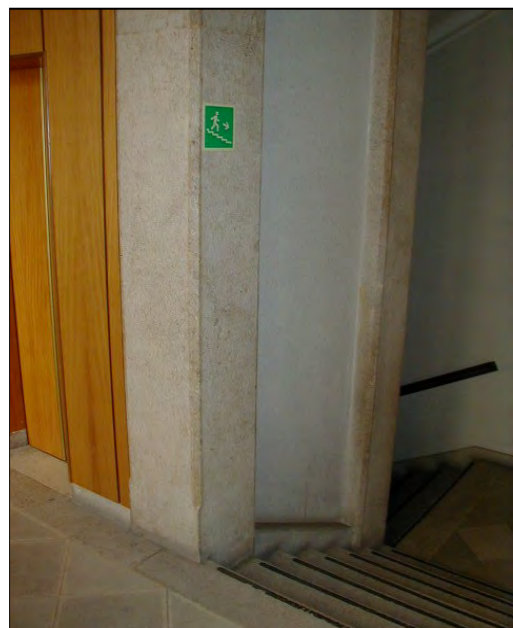
Particolare del corpo scala dell'anagrafico 64
