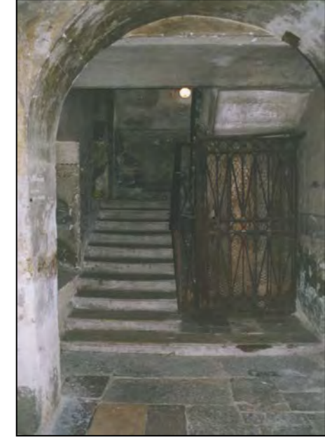
Vano scala (alla data del rilievo)
