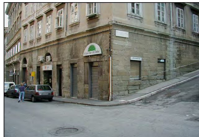
particolare pianoterra, via SS. Martiri 8 angolo via G. Camician
