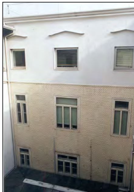
particolare della facciata prospiciente la seconda corte
