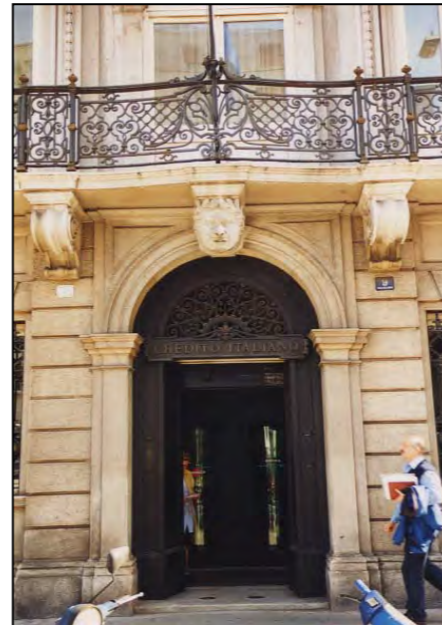
Particolare dell'ingresso principale
