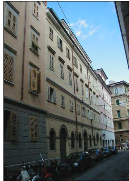
via dei Fabbri 3
