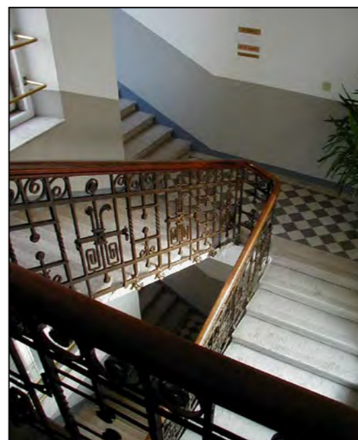
Particolare del corpo scala
