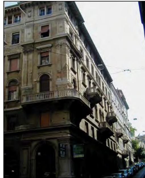
Particolare del prospetto su via Belpoggio
