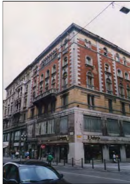
Prospetto su corso Italia
