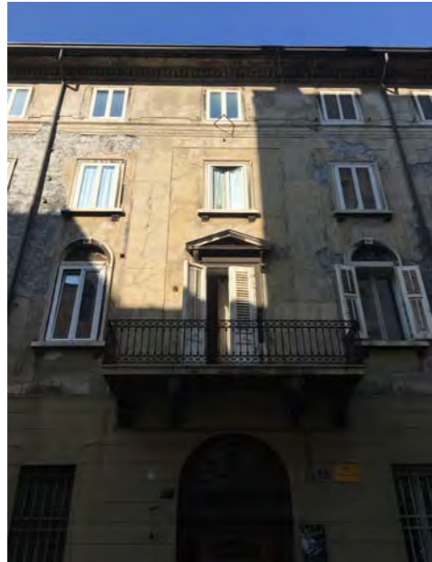
Particolare facciata su via A. Diaz
