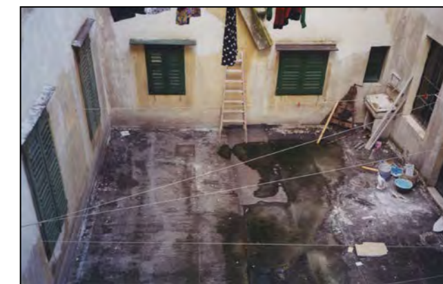
Particolare cavedio grande
