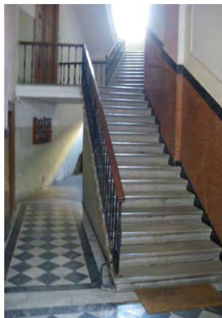
via della Galleria 8 - atrio e corpo scala
