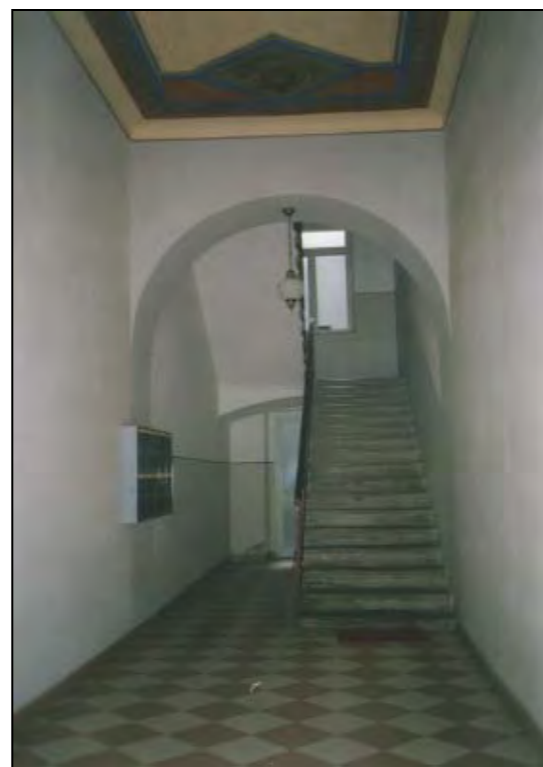
Atrio d'ingresso e scale a rampe parallele
