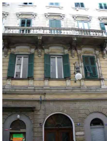
particolare della facciata - via del Lazzaretto vecchio 13
