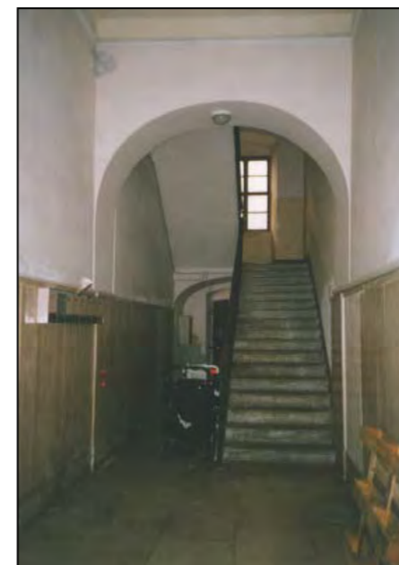
Atrio d'ingresso e scala a rampe parallele
