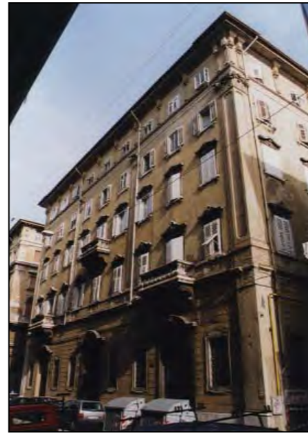
Facciata su via del Lazzaretto Vecchio
