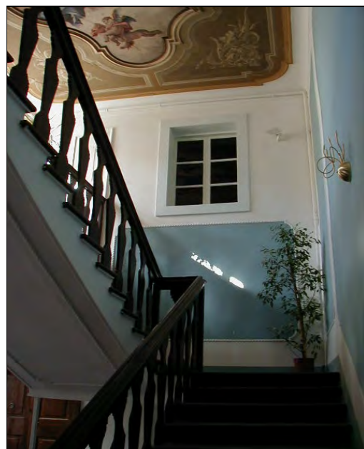
Particolare della scala in legno e dell'affresco al soffitto del corpo scala
