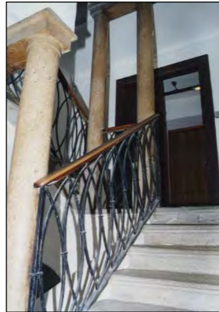
Particolare pianerottolo intermedio
