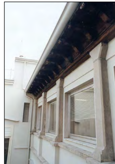
dettaglio della copertura in legno sulla medesima corte
