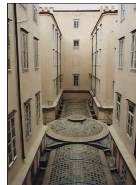
Copertura della galleria vista dalla corte (originale)
