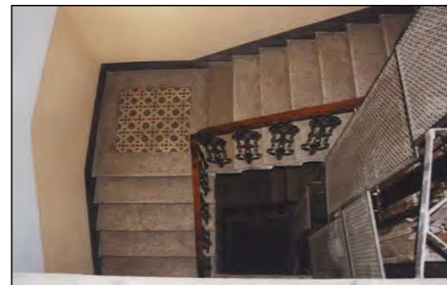
Particolare corpo scala
