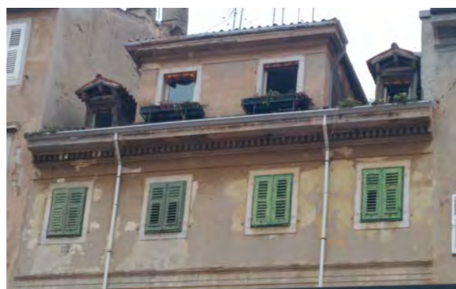
androna Santa Tecla 10 - particolare del luminale ed abbaini a struttura lignea
