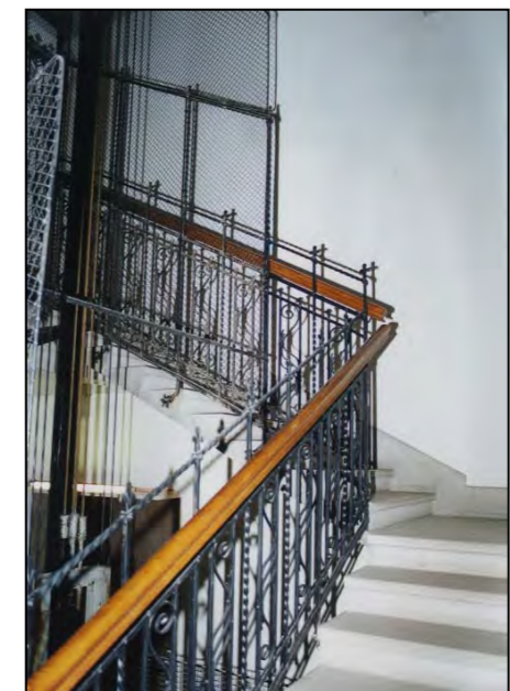
via Santa Caterina 3 - vano scala
