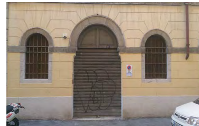
via dei Fabbri 3 - particolare del piano terra
