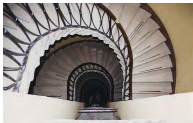
Particolare - scala (vista dall'alto)
