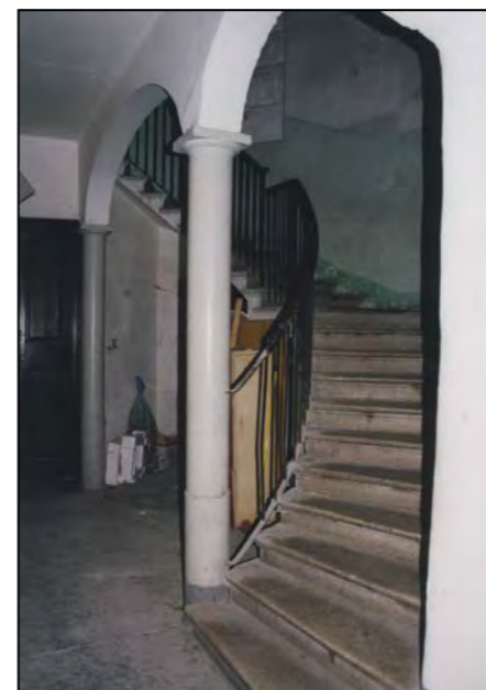
Vano scala anulare semicircolare
