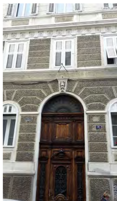
particolare della facciata - via dell'Università 10
