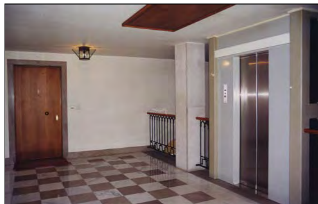
Particolare corpo scala
