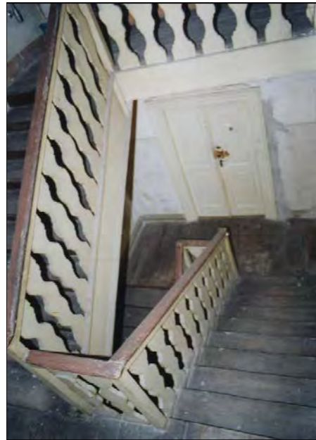
Vano scale in legno
