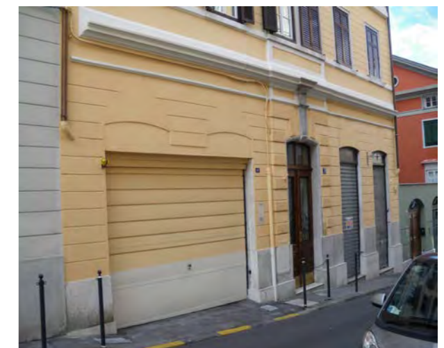
via Madonna del Mare 19 (particolare del piano terra)
