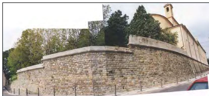
via Capitolina muro di sostegno in blocchi squadri di pietra arenaria
