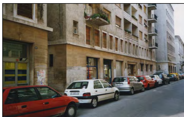
via A. Diaz particolare facciata
