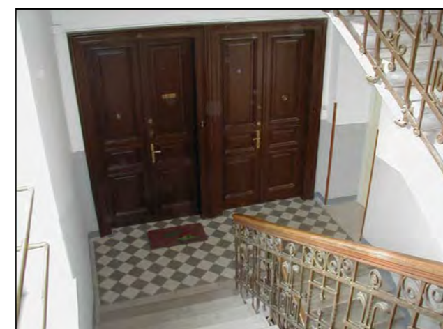
Particolare del corpo scala
