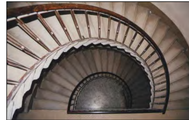
Particolare della scala anulare semicircolare in pietra
