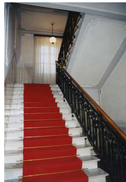
corpo scala a due rampe contrapposte
