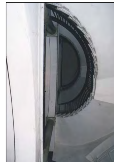
Vano scala anulare semicircolare
