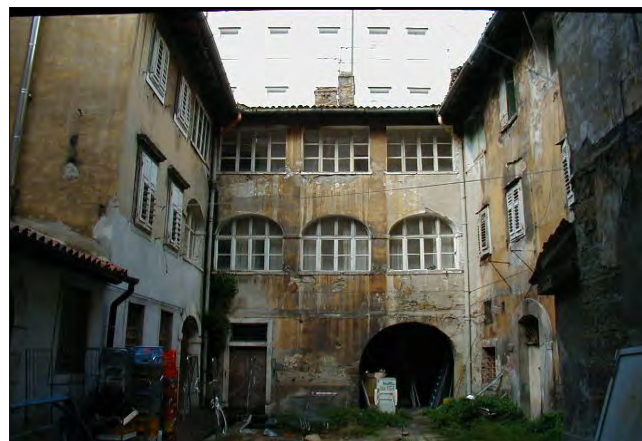
Cortile interno (fotografia alla data del rilievo)
