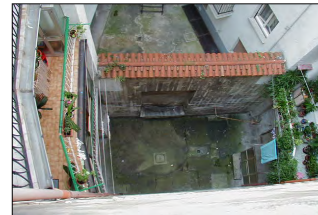
Cortile a confine con l'edificio an. 214
