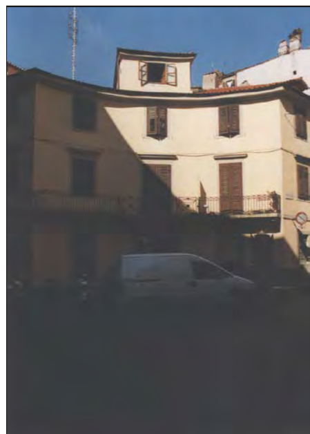
Prospetto su piazza della Valle
