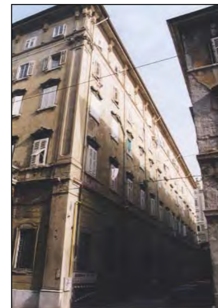
facciata su androna privata
