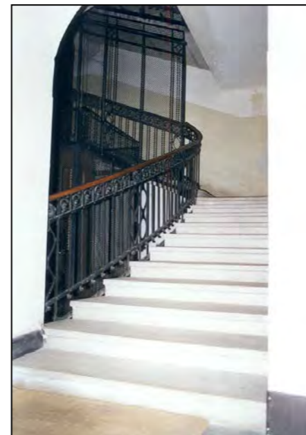
via L. Cadorna 3 - vano scala
