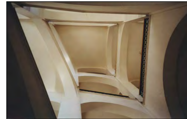
Particolare tromba della scala
