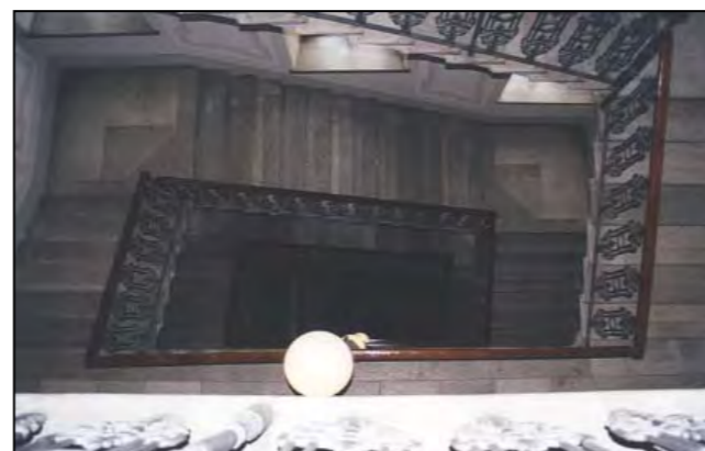
Vano scala (fotografia alla data del rilievo)
