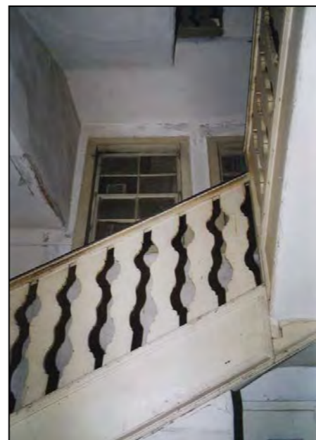
Vano scale in legno
