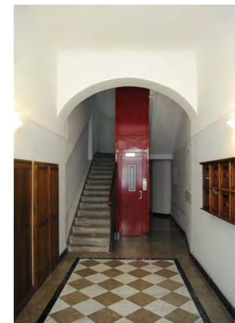
Vano scala e ascensore
