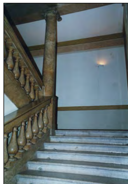
Particolare del corpo scala
