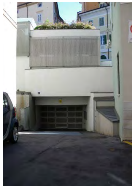
piazzetta Santa Lucia 4 - ingresso garage
