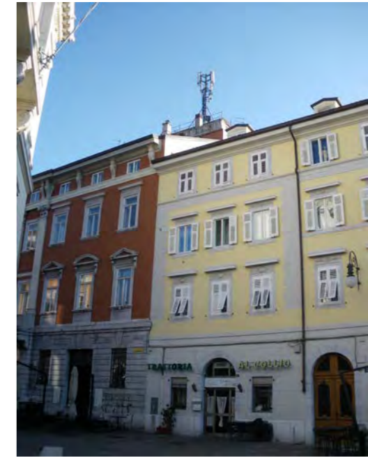
Particolare della copertura
