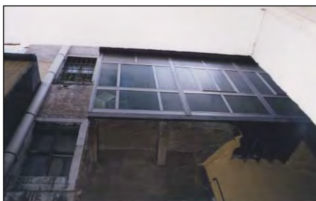
Particolare dei balconi sulla corte interna mensola e soletta a sbalzo in pietra
