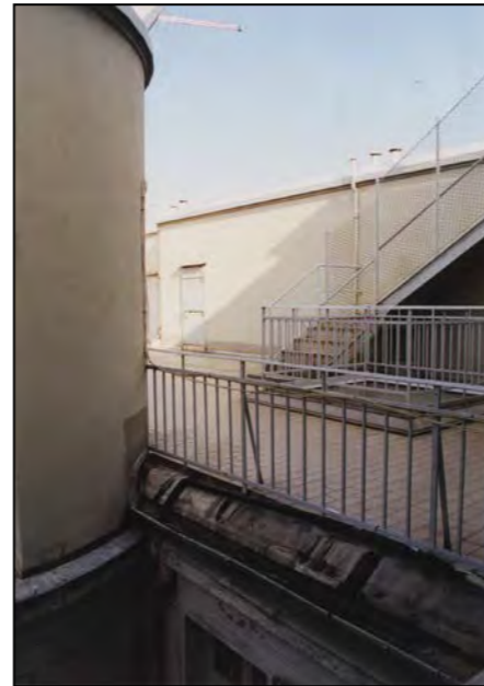
Lastrico solare calpestabile
