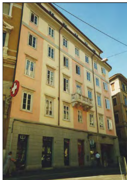
Facciata su corso Italia
