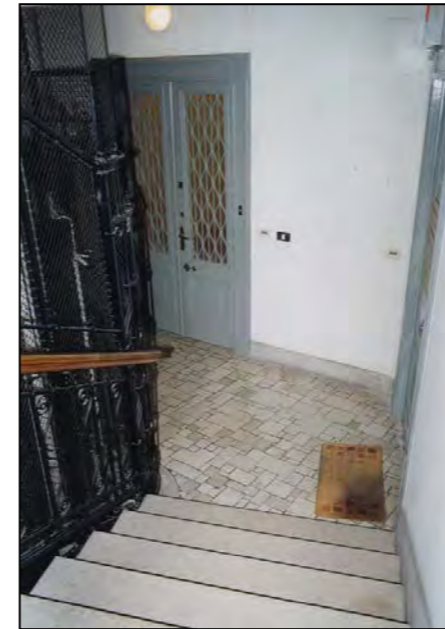
via San Lazzaro 2 - vano scala
