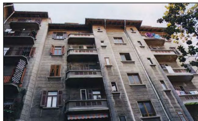
via della Galleria 4 prospetto interno
