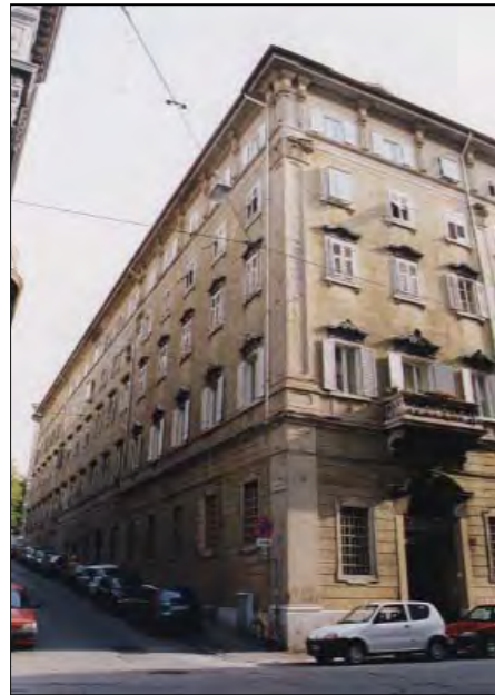
Facciata su via Belpoggio
