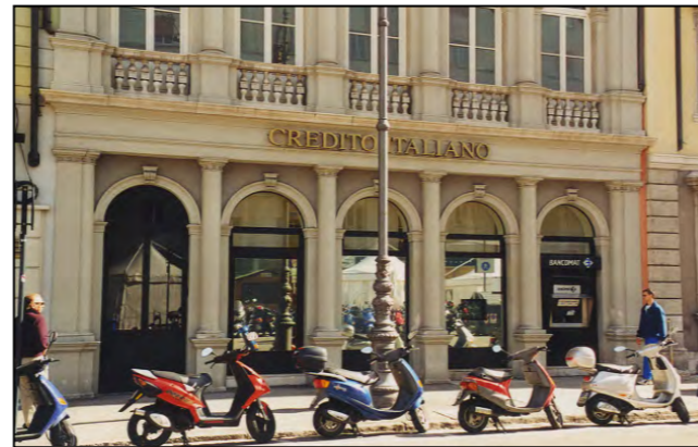
Particolare della sistemazione del piano terra
