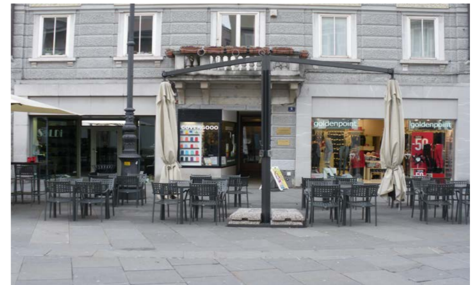
particolare facciata del piano terra (2019)
