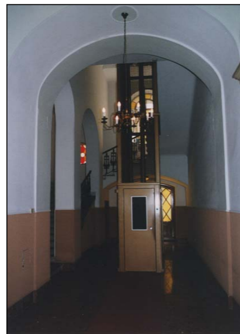
Vano ascensore installato in mezzo al passo carraio che conduce alla corte.
