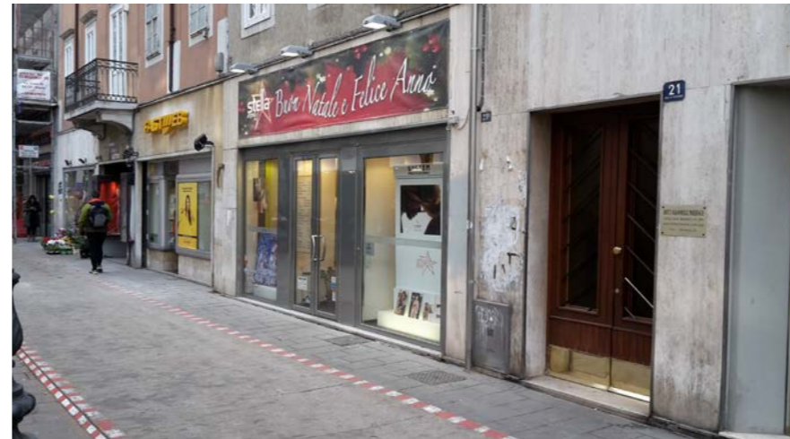
Trasformazione dell'entrata principale del palazzo in un esercizio commerciale con passaggio per i residenti. V.le XX Settembre e alterazioni dei fori al piano terra
