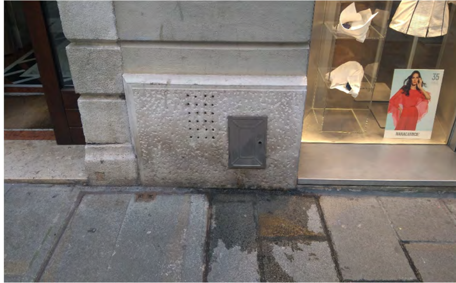
Portellina in metallo di allacciamento su basamento in pietra con forature per l'areazione (via San Nicolò 31 - 2019)
