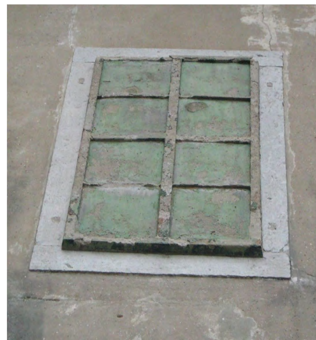
Serramento in malta con tracce di coloritura originale ad imitazione dell'originale e cornice in pietra (vicolo delle ville 16 - 2009)
