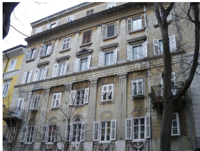
Le tre campate centrali sono scandite da un doppio ordine gigante di ordini sovrapposti (dorico e ionico). La trabeazione del primo ordine e le due campate laterali del primo e del secondo piano, sono trattate con bugnato liscio a fasce continue aggettanti dal paramento (viale XX Settembre 9 - 2019)
