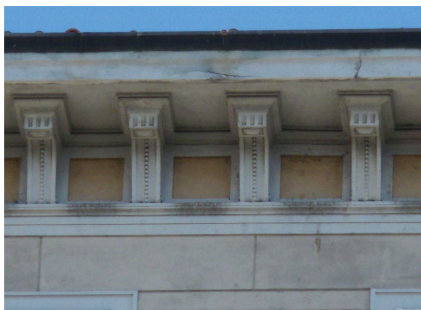
Cornicione bicromatico decorato alla maniera della trabeazione dorica, "metope" e "triglifi", sono richiamati dalle semplici riquadrature e dai modiglioni (via Carducci 16 - 2019)
