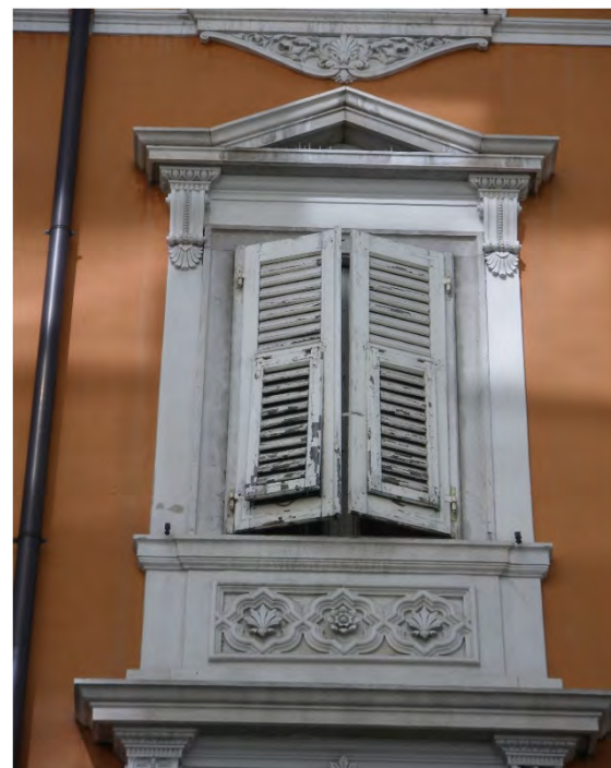
Cornice rettangolare piana inserita in edicola con cimasa a timpano triangolare, davanzale e pannello sottofinestra. La cornice in pietra naturale, riquadra il vano su tre lati ed è delimitata da due fasce verticali in intonaco a piani lisci sulle quali si innestano le mensole a voluta sormontate dalla cimasa. Le fasce verticali poggiano sul davanzale modanato con pannello sottofinestra caratterizzato da un riquadro centrale decorato in rilievo (via Torrebianca 25 - 2019)
