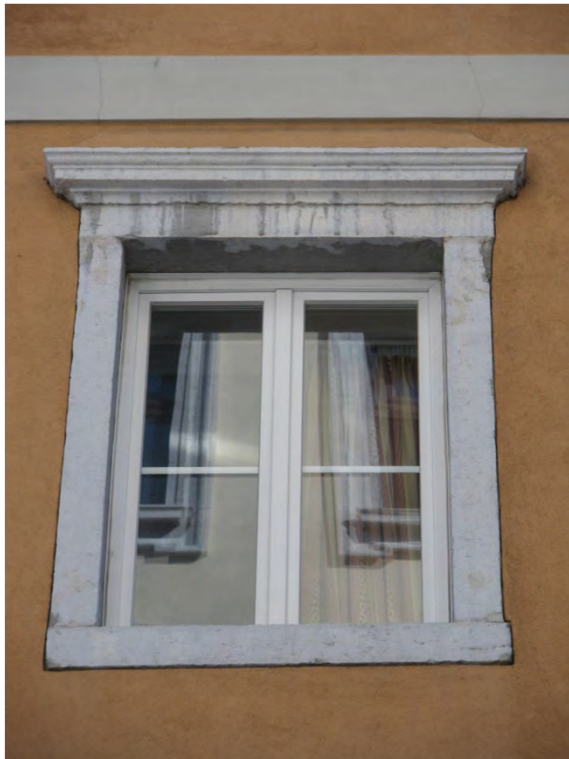
Cornice rettilinea a piani lisci in pietra naturale con cimasa in pietra modanata posta sull'architrave della cornice (via Trento 5 - 2019)
