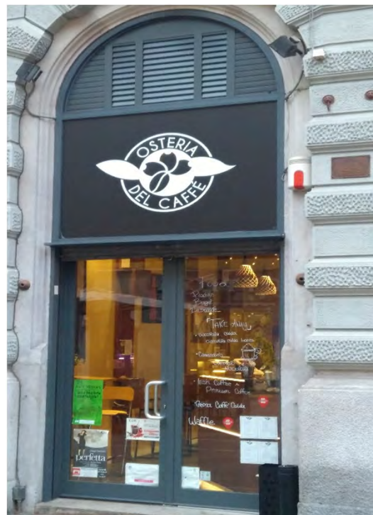
Attività commerciale con sopraluce grigliato per l'occultamento degli impianti tecnologici (via delle Torri 2 - 2019)
