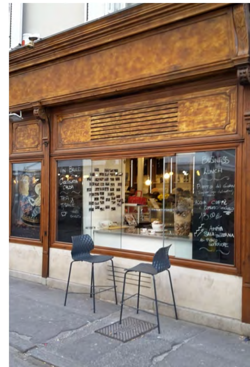
Vetrina liberty. Gli impianti sono stati occultati nel sopraluce pieno e nel nuovo basamento in pietra (via Ponchielli 3 - 2019)
