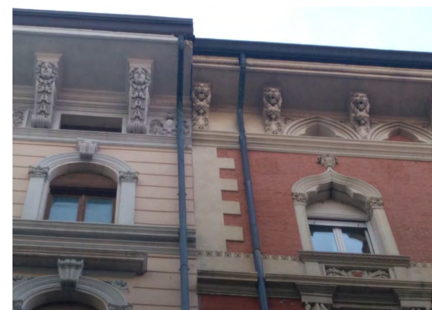
Cornicioni con spioventi semplicemente modanati e sostenuti da modiglioni con fasce sottocornice riccamente decorati secondo lo stile "eclettico" (via Belpoggio 1;3 - 2019)
