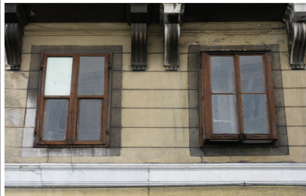
Cornice rettilinea in pietra che riquadra il vano sui quattro lati. La cornice è inserita senza soluzioni di continuità nel rivestimento listato del paramento. Gli stipiti, infatti, presentano le scanalature in corrispondenza dei giunti delle fasce orizzontali. Nella foto si riscontra che la pietra è stata erroneamente messa in vista interrompendo la continuità del trattamento listato (via Mazzini 11 - 2019)
