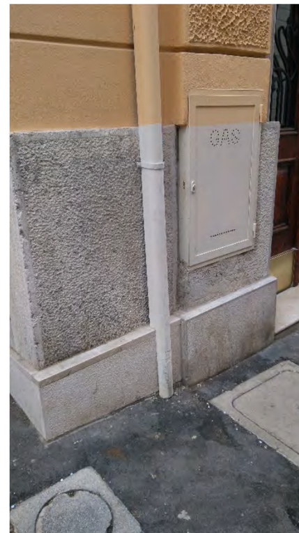
Portellina in metallo nel colore del bugnato liscio; per realizzarla è stata tolta una minima parte del basamento (via San Michele 2 - 2019)
