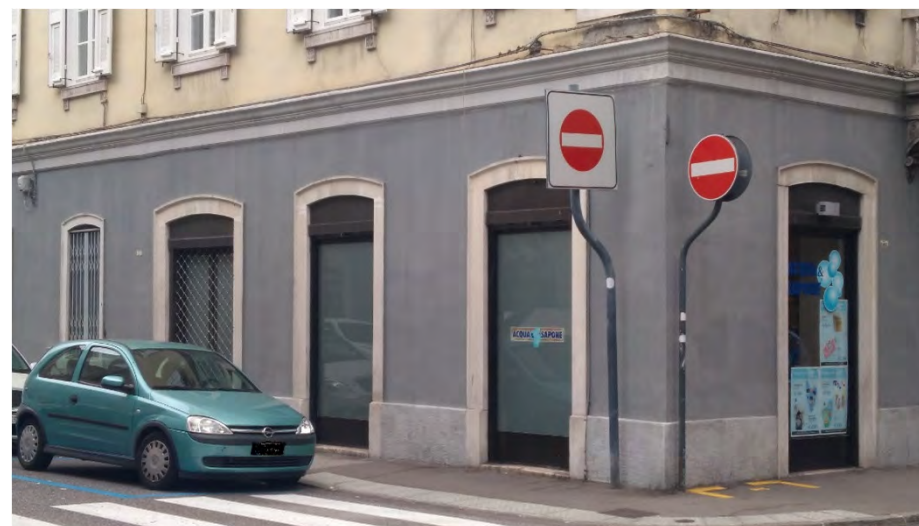
Il rivestimento del basamento si innesta sulla zoccolatura in pietra naturale di circa 60 cm di altezza e termina in corrispondenza della fascia marcapiano che separa il piano terra dal primo (via Roma 22 - 2019)
