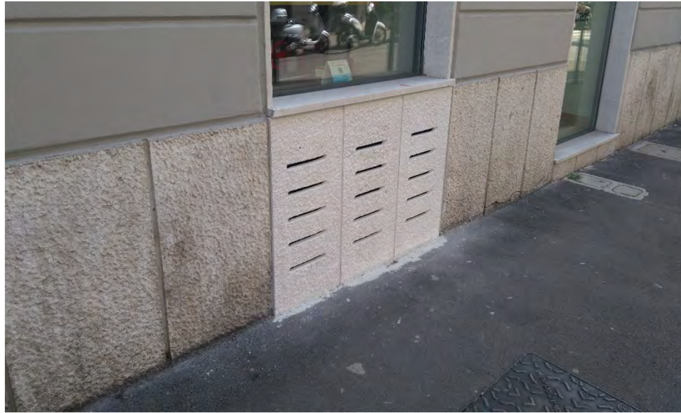
Attività direzionale. Il basamento è stato sostituito con altro composto da tre pannelli in pietra, ognuno a 5 fenditure orizzontali, per l'areazione degli impianti (via Roma 5 - 2019)
