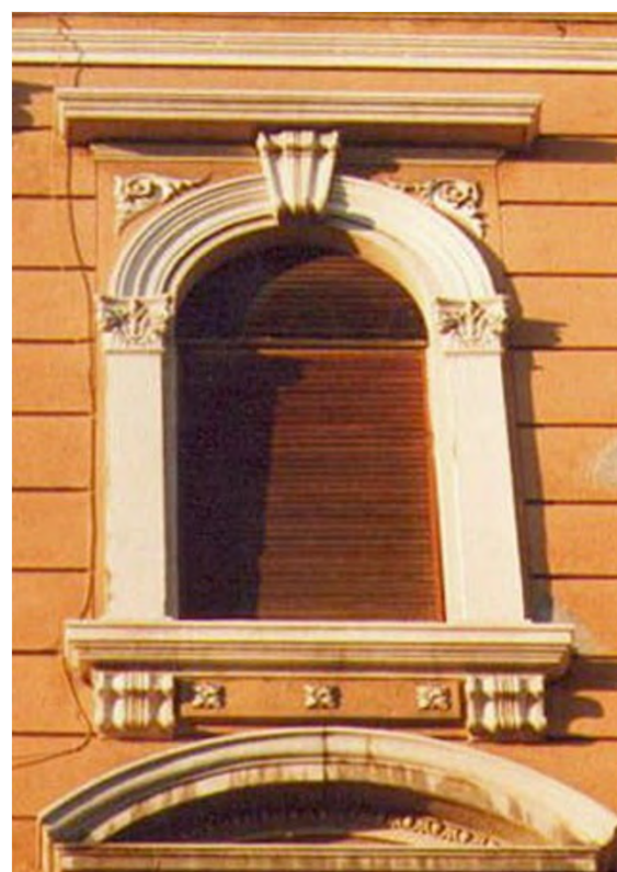
Cornice semicircolare in intonaco tinteggiato con cimasa rettilinea. Gli stipiti della cornice sono costituiti da due lesene con capitelli compositi. L'arco è modanato con chiave a voluta in risalto. La lesena modanata è raccordata all'arco con pennacchi decorati da un fregio centrale. Il davanzale modanato, aggettante e sporgente lateralmente rispetto alla cornice, poggia su mensole a voluta raccordate da una fascia centrale in rilievo con fregi (2001)
