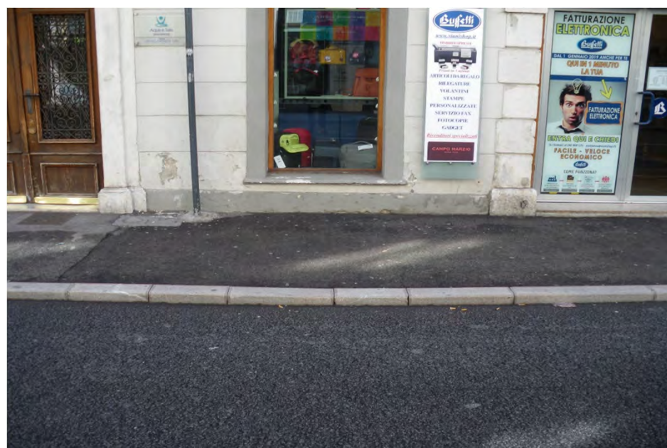
Zoccolatura a piani lisci in intonaco di circa cm 30, inserita tra i piedritti degli stipiti delle aperture a piano terra realizzati in pietra (via Mazzini - 2019)
