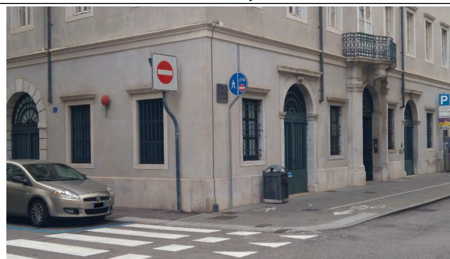
Il rivestimento del basamento si innesta sulla zoccolatura in pietra naturale di circa 60 cm di altezza e termina in corrispondenza della fascia marcapiano che separa il piano terra dal primo (via Trento 8 - 2019)
