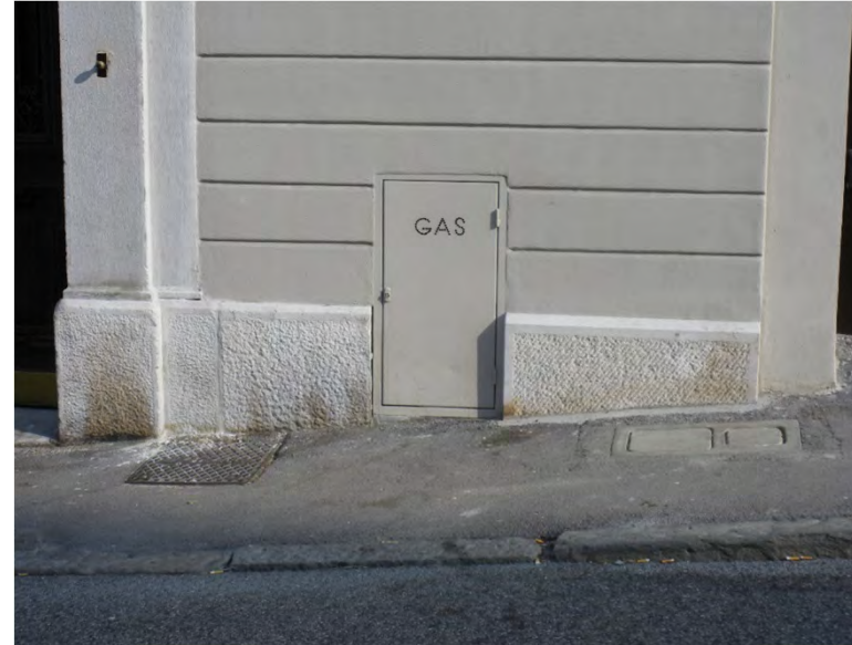
Portellina in metallo nel colore del bugnato liscio; per realizzarla è stata tolta una minima parte del basamento (via San Michele 2 - 2019)
