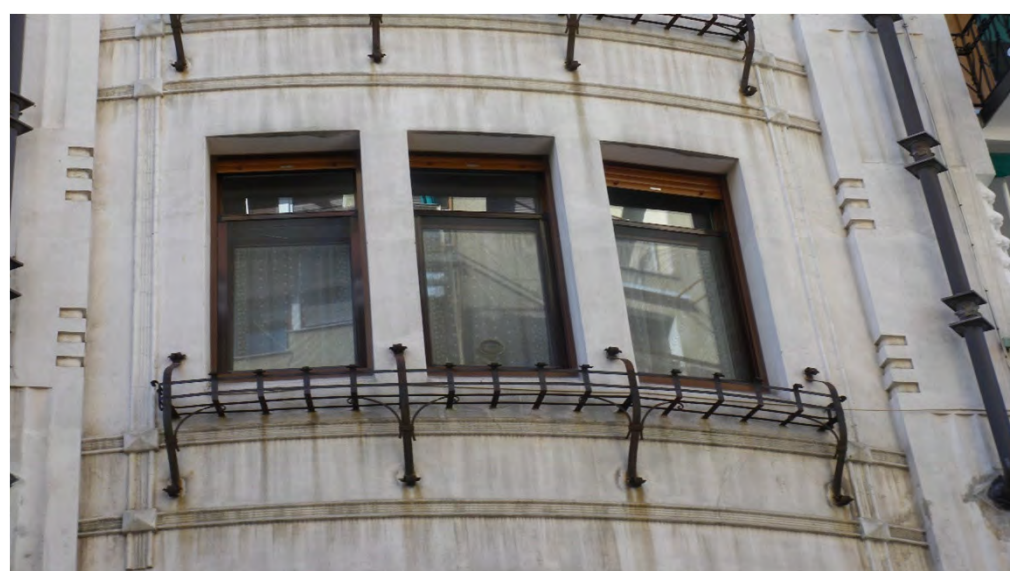
Apertura tripartita da pilastrini a piani lisci complanari al rivestimento liscio della facciata. Inferiormente l'apertura è delimitata da una fascia marcapiano dell'altezza del parapetto arricchita dall'inserimento di un porta fioriera in ferro battuto (via della Galleria 3 - 2019)
