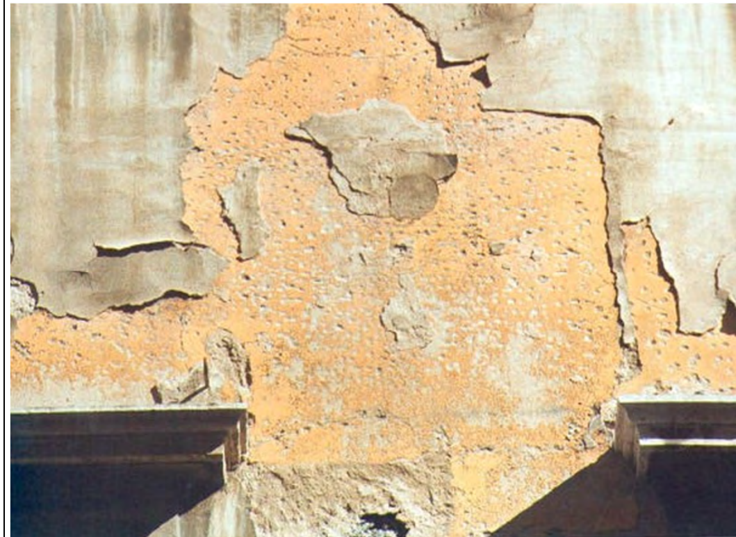
Lacerti di intonaco su un edificio abbandonato con evidente stratificazione di varie tinte.
