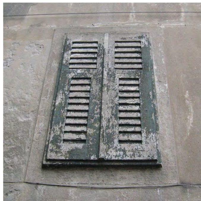
Persiana in malta con tracce di coloritura originale e cornice in malta al tempo colorata ad imitazione della pietra (vicolo delle ville 16 - 2009)
