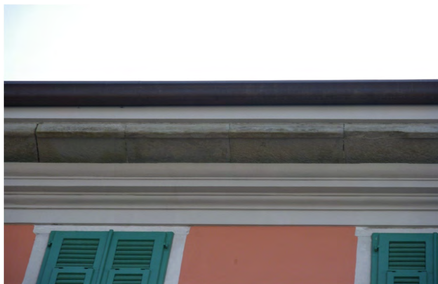
Cornicione con mensole squadrate a sporgere in pietra arenaria a vista (via del Lazzaretto vecchio 8 - 2019)
