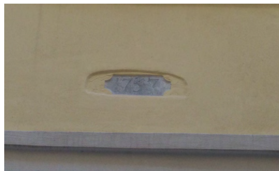
Incisione su pietra forse afferente l'anno di costruzione dell'edificio (via delle Beccherie - 2019)
