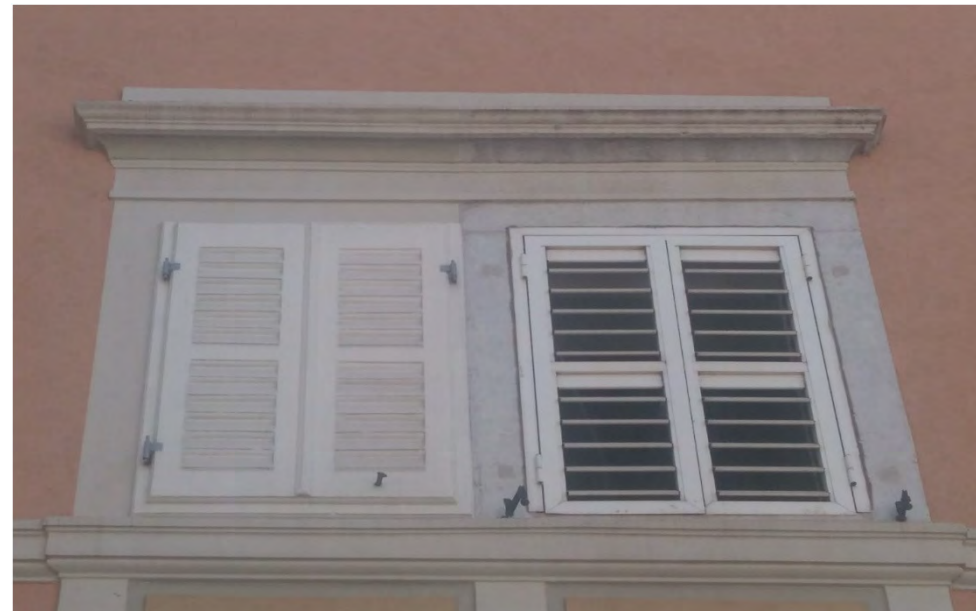
Persiana in malta affiancata da corrispondente in alluminio. Si noti la tinteggiatura in colore bianco e l'imitazione degli elementi in ferro (cardini e ferma-anta); anche parte della cornice e della cimasa modanata è in malta ad imitazione della pietra. (via San Michele 13 / facciata lungo la via della Cereria - 2019)
