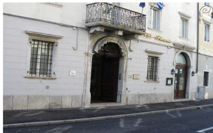
Basamento in intonaco con trattamento cromatico differenziato rispetto al rivestimento dei piani superiori. Il basamento listato liscio si innesta sulla zoccolatura in pietra di circa 60 cm di altezza e interessa il solo piano terra della facciata (via Mazzini 3 - 2019)
