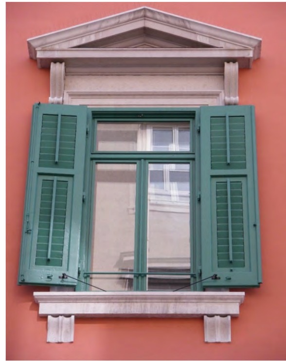
Persiana rettangolare in legno verniciato a due ante bipartite. L'infisso è sporgente dalla cornice della finestra e i battenti sono a questo sovrapposti (piazza Barbacan 2 - 2019)
