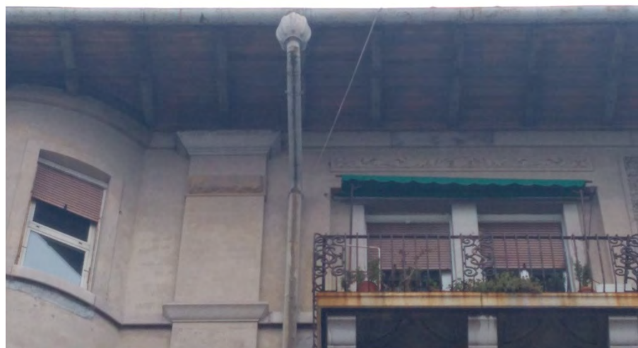
Cornicione in legno con mensole a sporgere e tavolato sovrapposto. Si noti che il legno è lasciato nel suo colore naturale e che gli elementi impiantistici soddisfano anche l'esigenza estetica (riva Grumula 4 - 2019)
