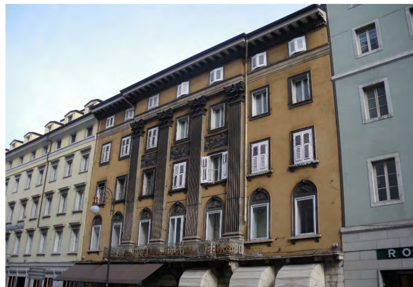
L'avancorpo centrale risulta tripartito da lesene scanalate d'ordine gigante impostate su alti stilobati inseriti nella balconata del piano nobile. La facciata è arricchita da altorilievi opposti al marcapiano centrale tra secondo e terzo piano (corso Italia 4 - 2019)
