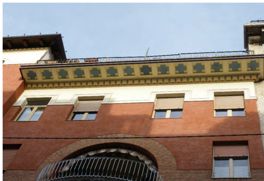
Cornicione a sbalzo con decorazione a cassettoni tinteggiati all'intradosso modanato e decorato (via Canova 2 - 2019)
