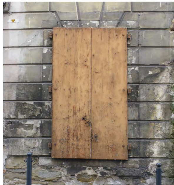
Cornice rettilinea in pietra con gli stipiti scanalati in corrispondenza dei giunti del paramento listato. La cornice è intonacata e tinteggiata in continuità con il paramento (Venezian 25 - 2019)
