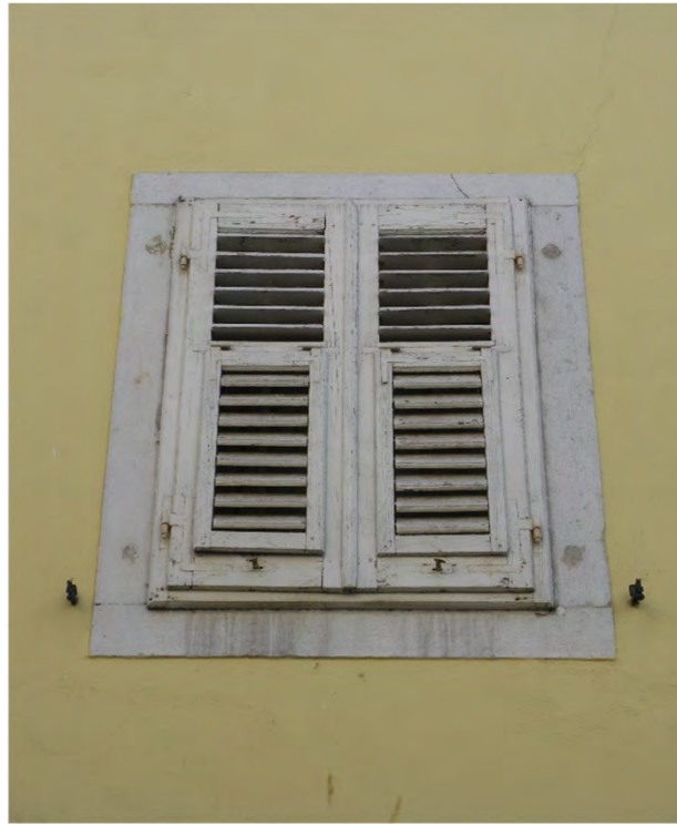
Persiana rettangolare in legno verniciato a due ante bipartite. L'infisso è sporgente dalla cornice della finestra e i battenti sono a questo sovrapposti (piazza Barbacan 2 - 2019)
