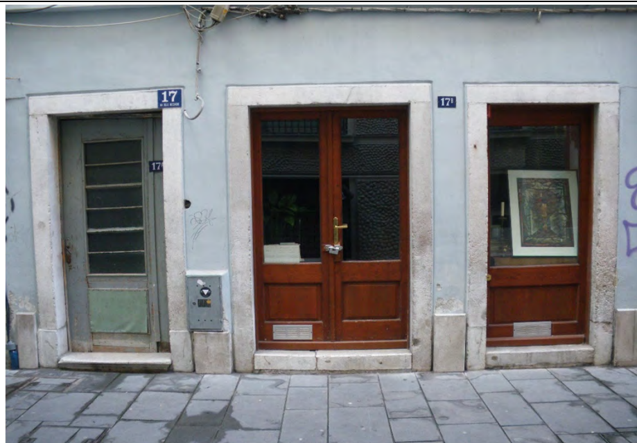
Cornici di tre aperture adiacenti semplicemente lavorate in pietra, con elementi di base sporgenti per l'apertura a sinistra (via delle Beccherie 17 - 2019)
