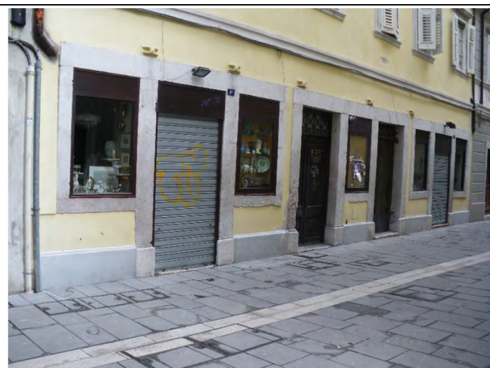
Rivestimento del basamento in intonaco liscio tinteggiato. Il trattamento superficiale è in continuità con il rivestimento dei piani superiori e si innesta sulla zoccolatura, anch'essa in intonaco (via delle Beccherie 8 - 2019)
