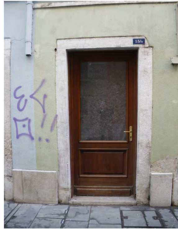
Cornici architravate ad elementi in pietra rettilinei. (via delle Beccherie 15b - 2019)
