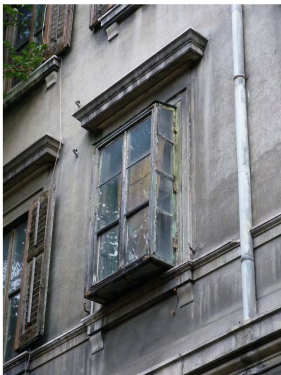
Serramento "a sburto" con pannelli vetrati laterali fissi quadripartiti. I battenti anteriori sono tripartiti (via San Michele 34 - 2019)
