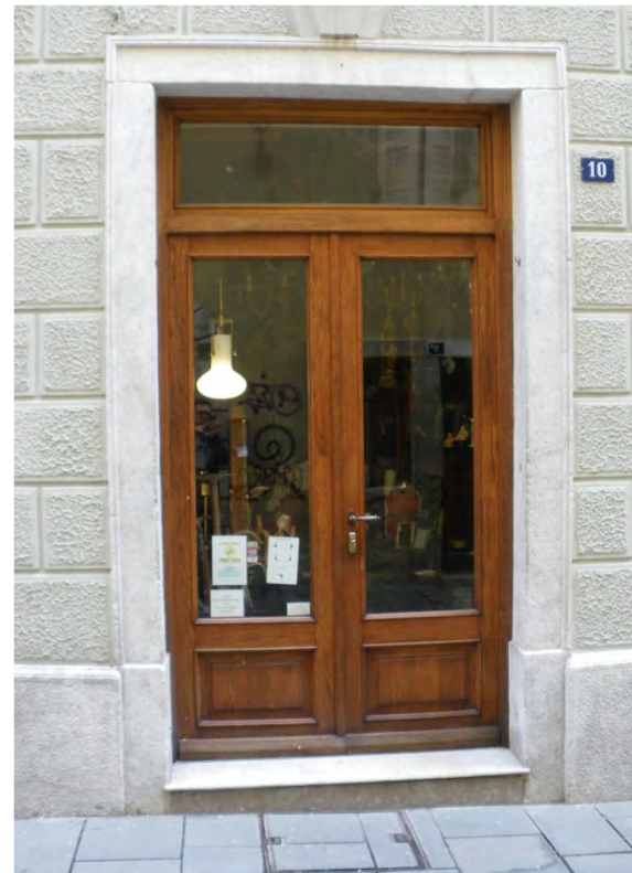
Cornice architravata in pietra modanata con la base dei piedritti sporgente e raccordata alla zoccolatura (via delle Beccherie 10 - 2019)
