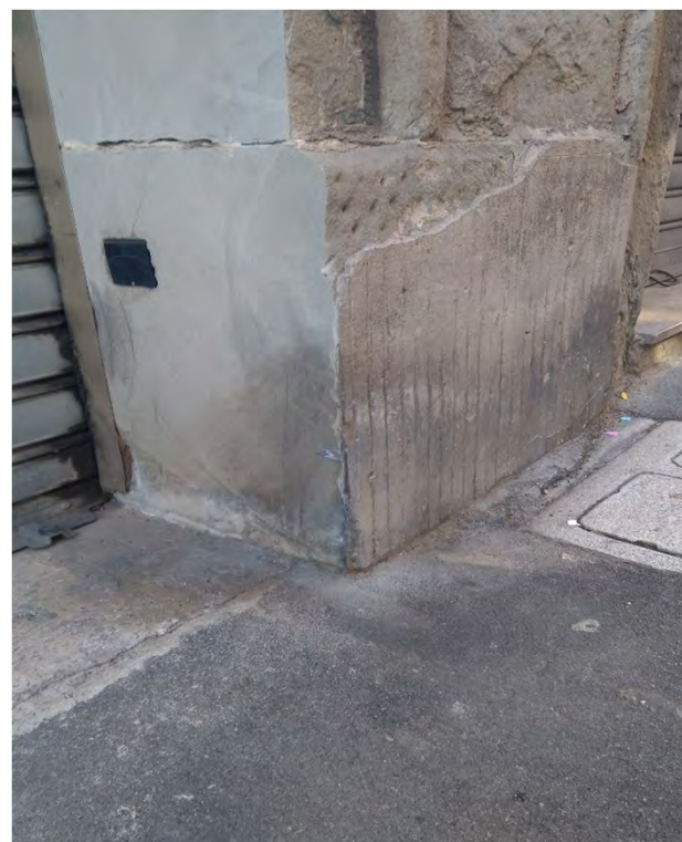
Zoccolatura di circa cm 80 di altezza, realizzata in intonaco con finitura a scanalature verticali (via Santi Martiri 6 - 2019)
