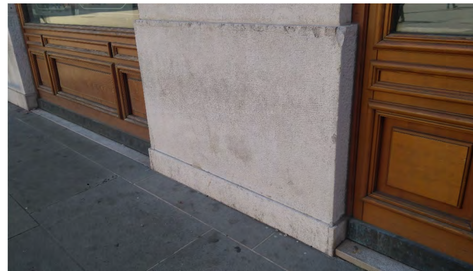
Zoccolatura rettilinea con elemento di base in rilievo, realizzata in blocchi di pietra chiara (piazza della Borsa 15 - 2019).
