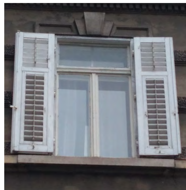
Serramento con soprauce vetrato rettangolare composto da due ante apribili verso l'interno e persiane agganciate in tre punti all'infisso (via Slataper 10 - 2019)
