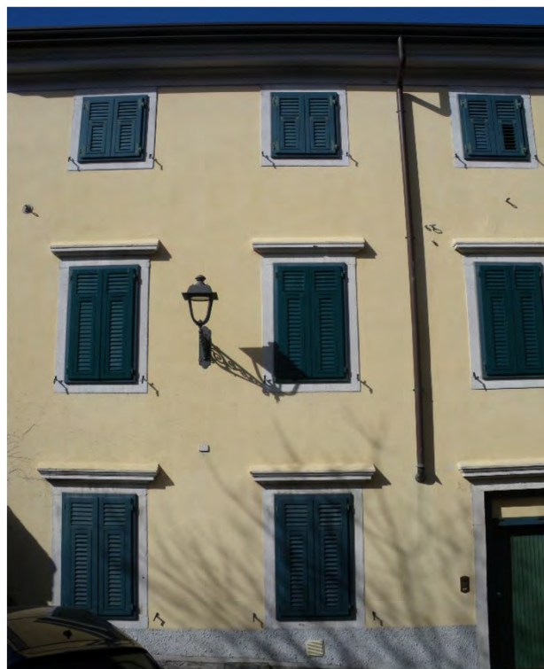
Rivestimento in intonaco liscio (via della Cattedrale 1 - 2019)
