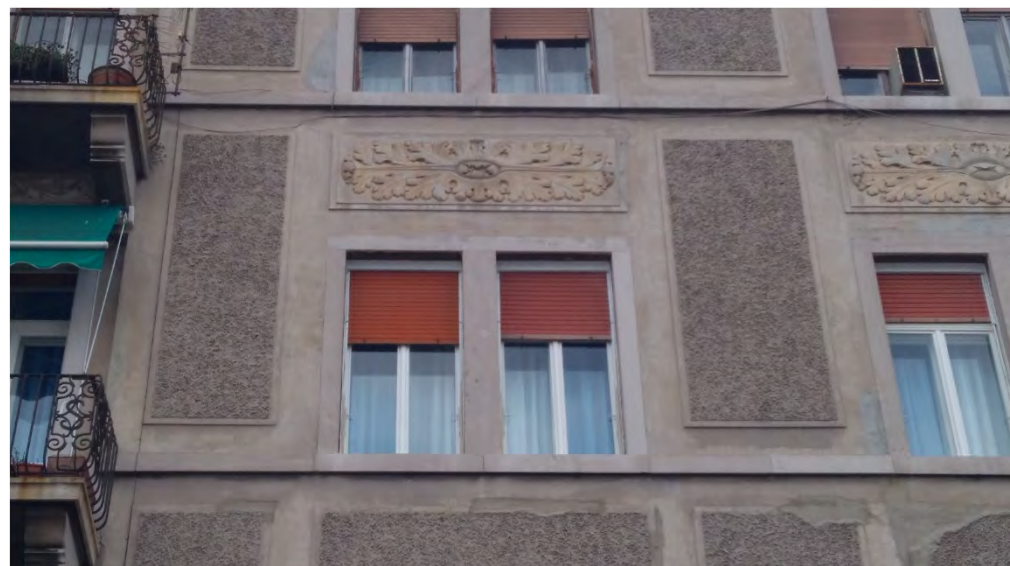
Cornice a piani lisci che riquadra un'apertura bipartita da un pilastrino centrale. La cornice leggermente aggettante si inserisce nel disegno a riquadri della facciata con trattamenti superficiale ad imitazione della pietra. Il davanzale, anch'esso a piani lisci e lievemente aggettante, si innesta nella fascia marcapiano (marcadavanzale). Superiormente la cornice è sormontata da un pannello decorato a motivi floreali in rilievo (riva Grumula 4 - 2019)
