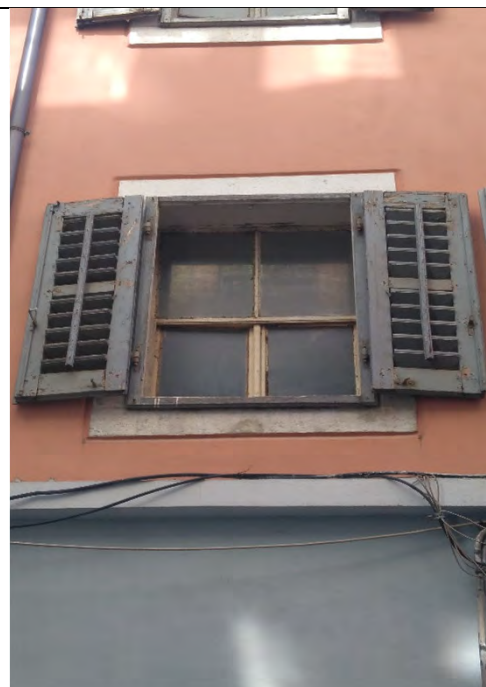
Serramento in legno costituito da una metà superiore fissa e dalla parte inferiore apribile a due battenti (via delle Beccherie 17 - 2019)
