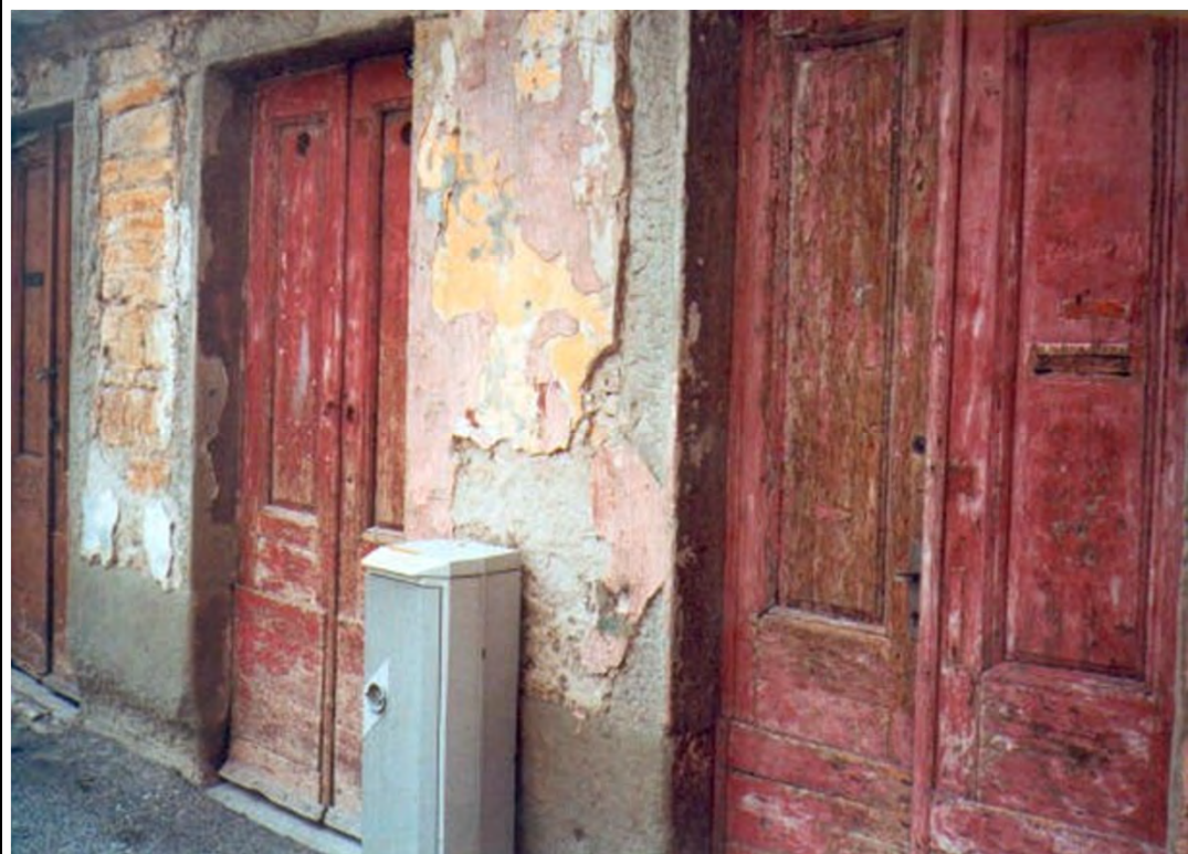
Lacerti di intonaco su un edificio abbandonato con evidente stratificazione di varie tinte.
