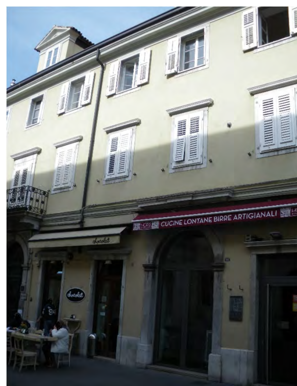
Rivestimento in intonaco liscio tinteggiato e separato dal rivestimento del basamento da una cornice marcapiano modanata (via di Cavana 15 - 2019).
