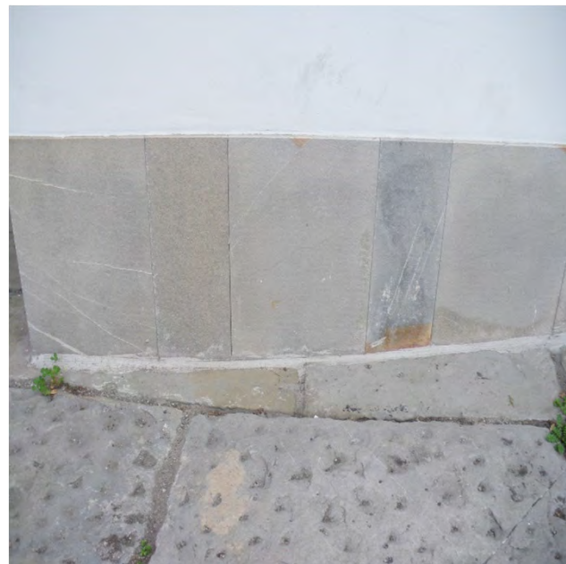
Zoccolatura rettilinea in lastre di pietra arenaria . (piazzetta Riccardo 1 - 2019)
