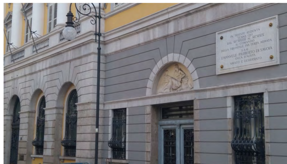
Rivestimento listato a giunti convergenti in corrispondenza delle aperture ad arco. Il rivestimento è in pietra naturale nell'avancorpo centrale ed in intonaco tinteggiato ad imitazione della pietra nei corpi laterali. In corrispondenza dell'imposta degli archi e degli architravi delle aperture corre una fascia modanata in pietra naturale interrotta in corrispondenza delle aperture ad arco dall'avancorpo centrale. Il basamento è coronato dalla fascia marcapiano che divide il piano terra dal primo piano (largo Papa Giovanni XXIII 7 - 2019)
