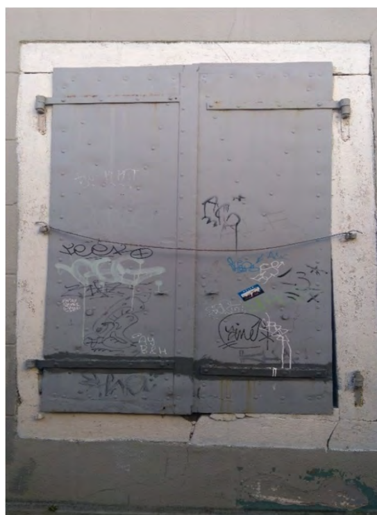
Portellone in ferro a due battenti con due bandelle con cavo metallico esterno di sicurezza (via delle Mura 9 - 2019)
