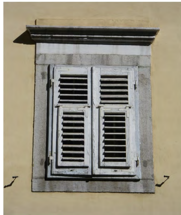
Cornice rettilinea in pietra naturale lavorata a martellina con nastrino liscio perimetrale. La cimasa modanata è raccordata alla cornice da una fascia d'intonaco compresa tra due listelli orizzontali (via Machiavelli 14 - 2019)
