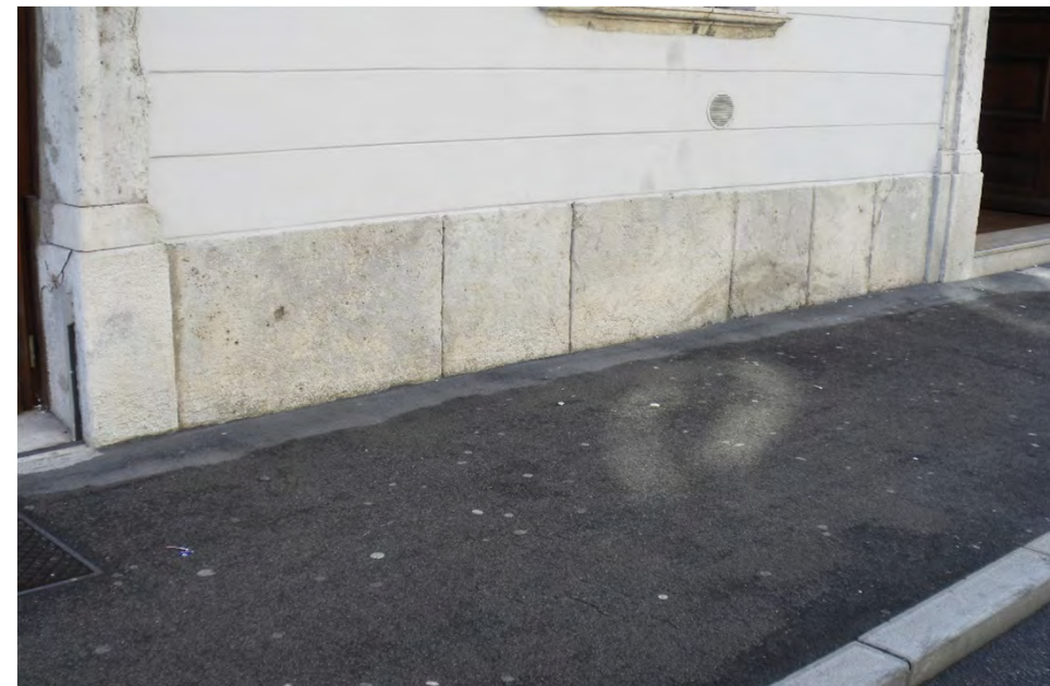
Zoccolatura rettilinea in lastre di pietra chiara ; in prossimità delle aperture la zoccolatura è sagomata in maniera più ricca e forma la base per gli stipiti (via Mazzini 3 - 2019)
