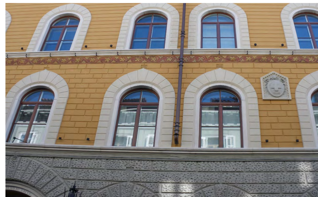
Fasce marcapiano decorata in pietra e in intonaco tinteggiato. La cornice superiore in pietra, posta alla quota bancale delle finestre e sostenuta da elementi in ferro, costituisce l'elemento di protezione per la fascia sottostante decorata con fregi (via San Francesco d'Assisi 3 - 2019)
