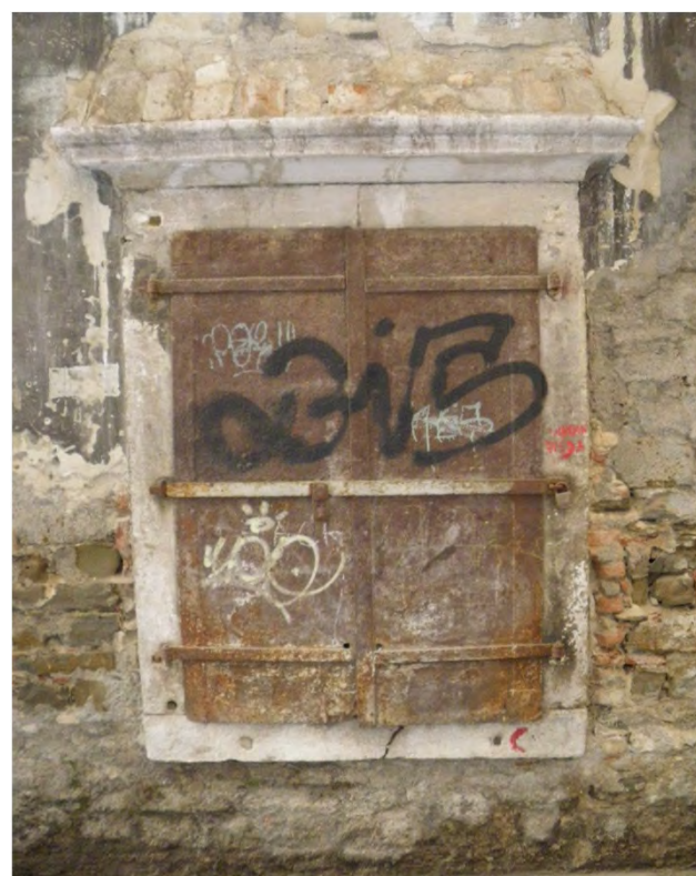
portellone in ferro a due battenti e due bandelle per anta, con sbarra di sicurezza esterna centrale (via delle Beccherie 3 - 2019)
