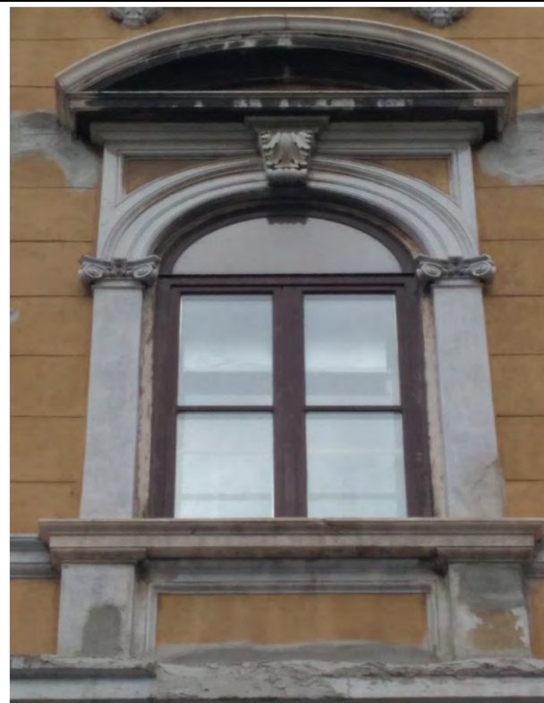
Serramento con soprauce vetrato ad arco composto da due ante bipartite apribili verso l'interno (piazza della Libertà 6 - 2019)
