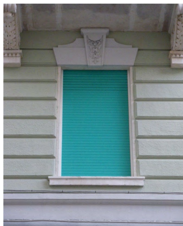
Persiana avvolgibile con telaio fisso (via San Francesco d'Assisi 17 - 2019)
