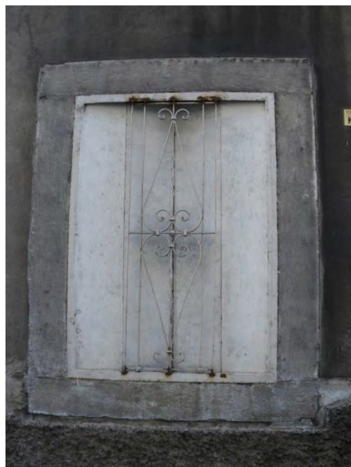
Persiana in metallo verniciato in colore bianco a due ante piene, ognuna composta da due specchiature mobili con inferriata a protezione attestata su cornice metallica (via San Michele 27 - 2019)
