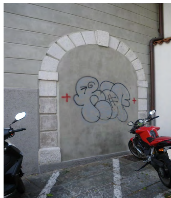
Varco murato ad arco delimitato da conci in pietra con chiave e piedritti (via della Cereria - 2019)
