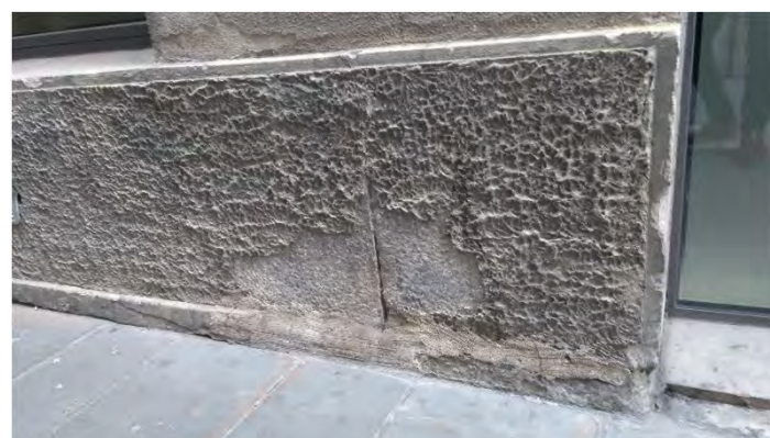
Zoccolatura in intonaco di circa cm 60 di altezza, con finitura a rustico ad imitazione della pietra (via della Pescheria 1 - 2019)
