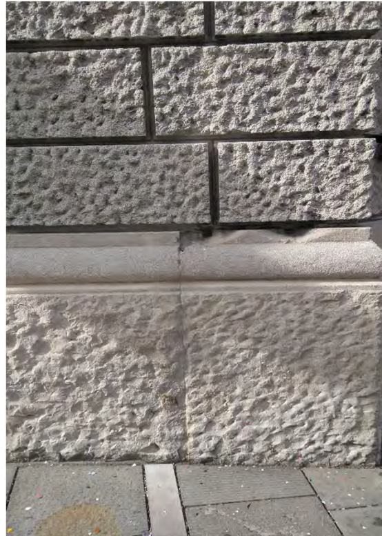
Zoccolatura in lastroni di pietra chiara lavorata al rustico con toro di raccordo al paramento bugnato del basamento. (via di Cavana 1 - 2019)
