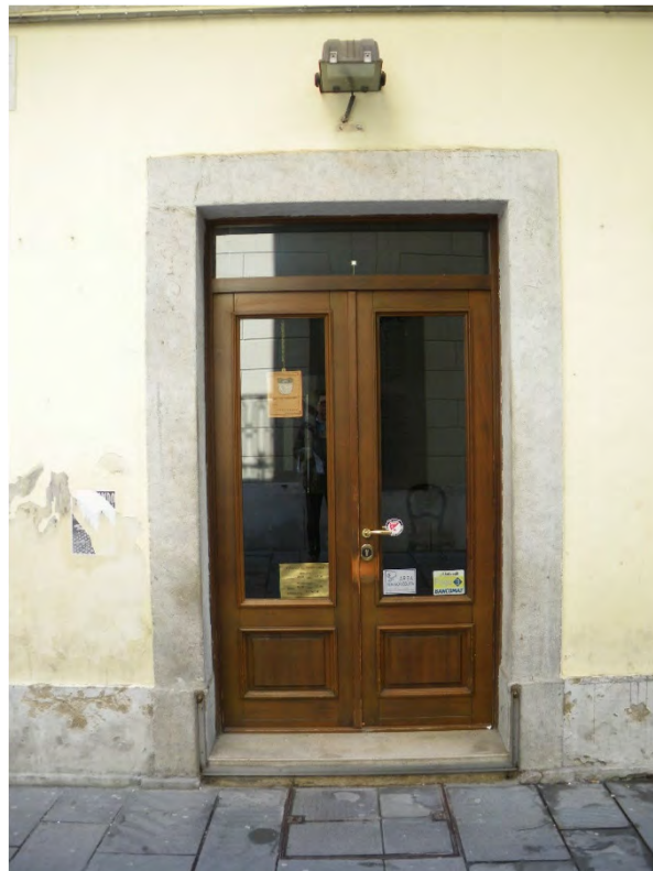
Cornice architravata a piani lisci in pietra con la base dei piedritti sporgente e raccordata alla zoccolatura (via delle Beccherie 11 - 2019)
