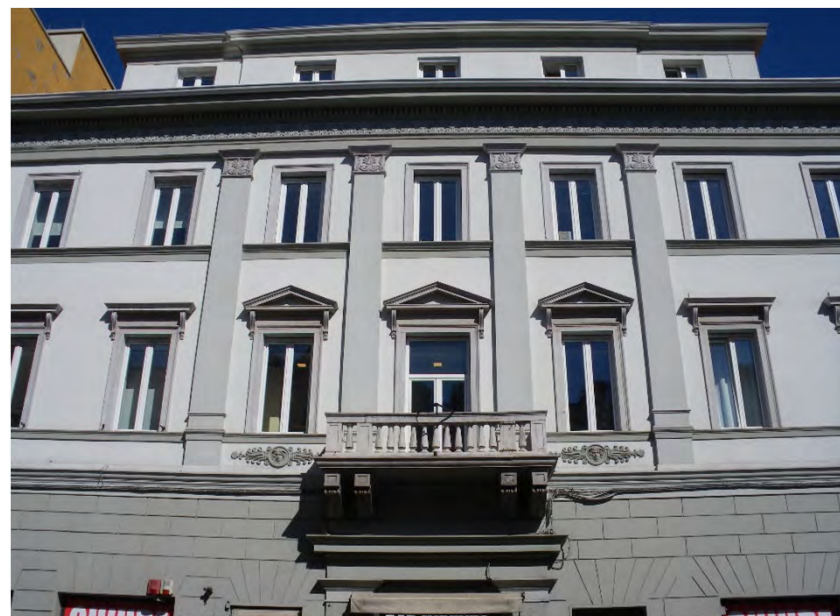
La facciata con rivestimento in intonaco liscio risulta tripartita nella parte centrale da un ordine gigante di lesene impostate su alti stilobati e coronate da capitelli compositi (via Ghega 6 - 2019)
