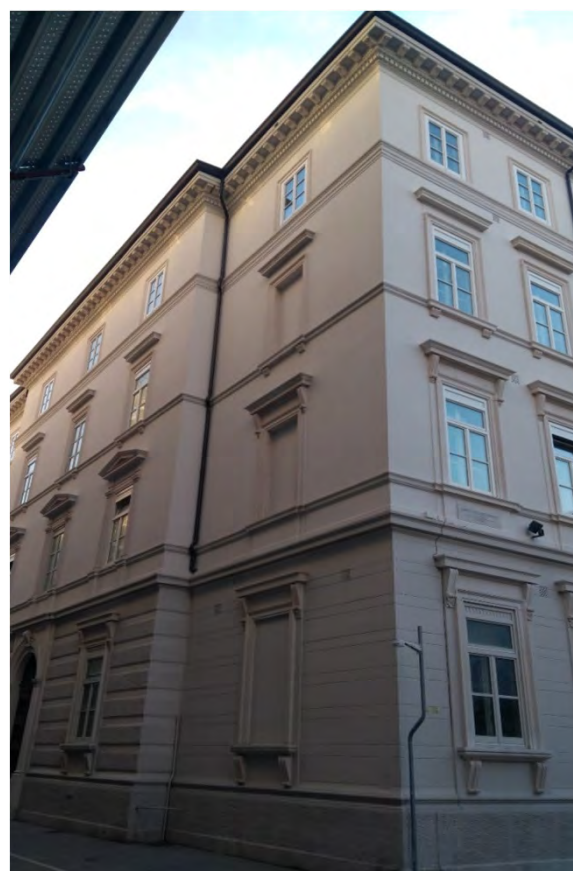
Colonna di foratura murate dal piano terra al penultimo piano (via Trento 14 - 2019)
