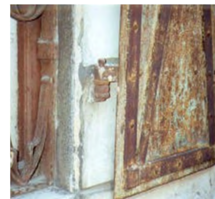
Particolare della cerniera con il perno infisso nella cornice in pietra e vista dell'interno del portellone con gli irrigidimenti in piattine di ferro chiodate
