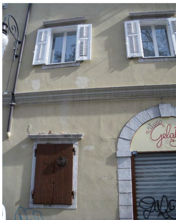
Rivestimento in intonaco liscio tinteggiato e ripartito da una cornice marcapiano modanata (piazza Hortis 6 - 2019).
