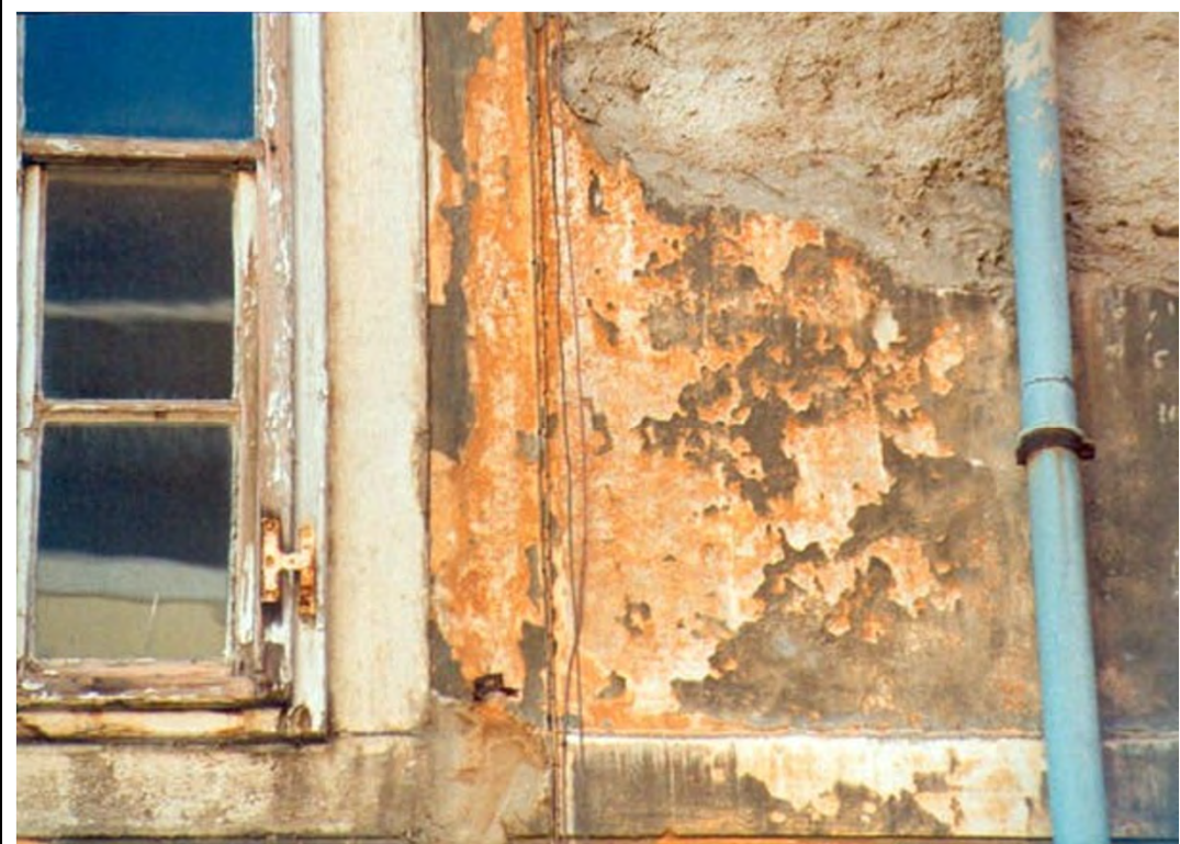
L'esfoliazione ha evidenziato la tinteggiatura giallo ocra. Si noti il rappezzo con malta cementizia.
