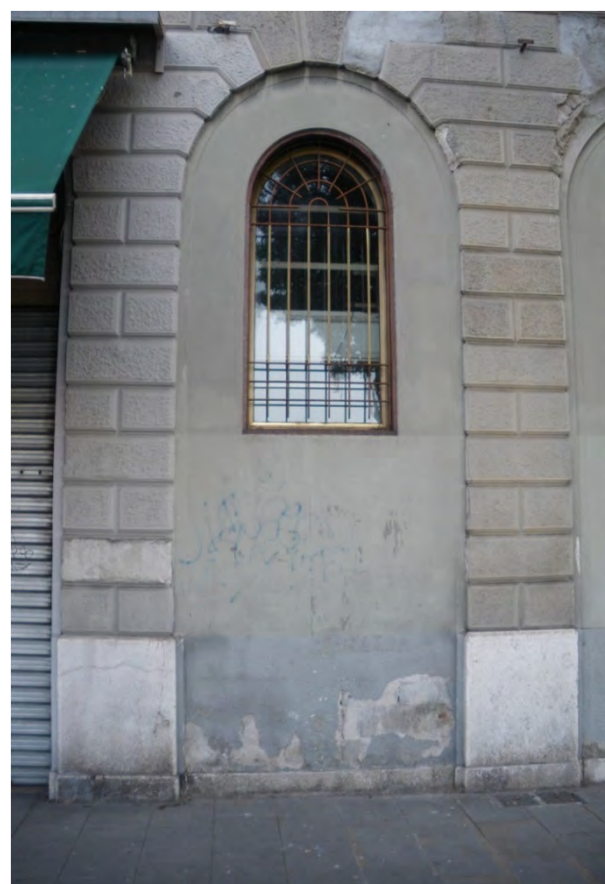
Finestra posticcia inserita in una foratura murata ad arco al piano terra (riva Grumula 2 - 2019)
