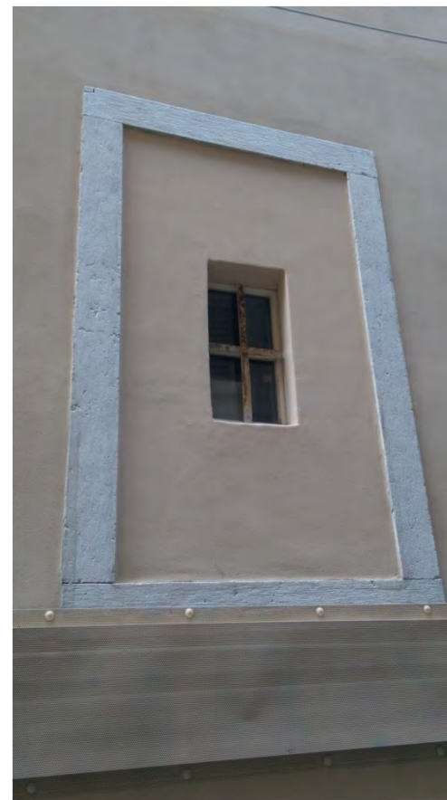
Minuta finestra posticcia con griglia a croce metallica inserita in una foratura murata con elementi in pietra di delimitazione (via delle Mura - 2019)
