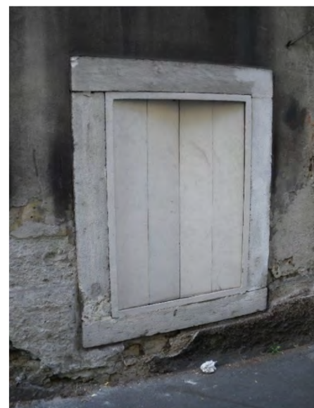
Persiana in metallo verniciato in colore bianco a due ante piene, ognuna composta da due specchiature mobili, inserite in una cornice metallica ed apribili a libro verso l'interno. Su questa sono fissati i cardini dei due battenti. (via San Michele 27 - 2019)
