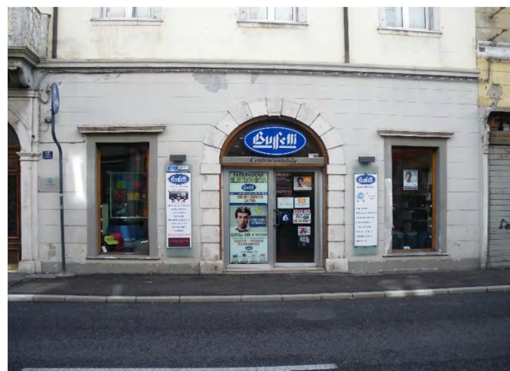
Basamento in intonaco con trattamento cromatico differenziato rispetto al rivestimento dei piani superiori. Il basamento listato liscio si innesta sulla zoccolatura in intonaco a forte spessore di circa 30 cm di altezza e termina in corrispondenza della fascia marcapiano che separa il piano terra dal primo piano (via Mazzini 13 - 2019)
