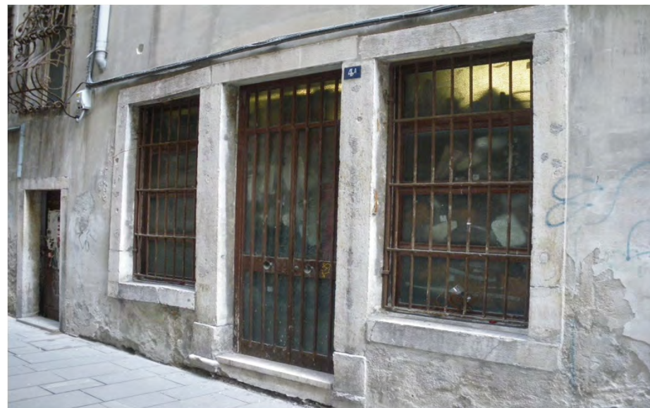
Cornice rettilinea in pietra che riquadra tre aperture affiancate, con stipiti centrali comuni ed architrave continuo realizzato con tre elementi lapidei. I piedritti centrali, che definiscono il vano d'accesso, hanno gli elementi di base sporgenti con modanatura nella parte inferiore (via delle Beccherie 4 - 2019)
