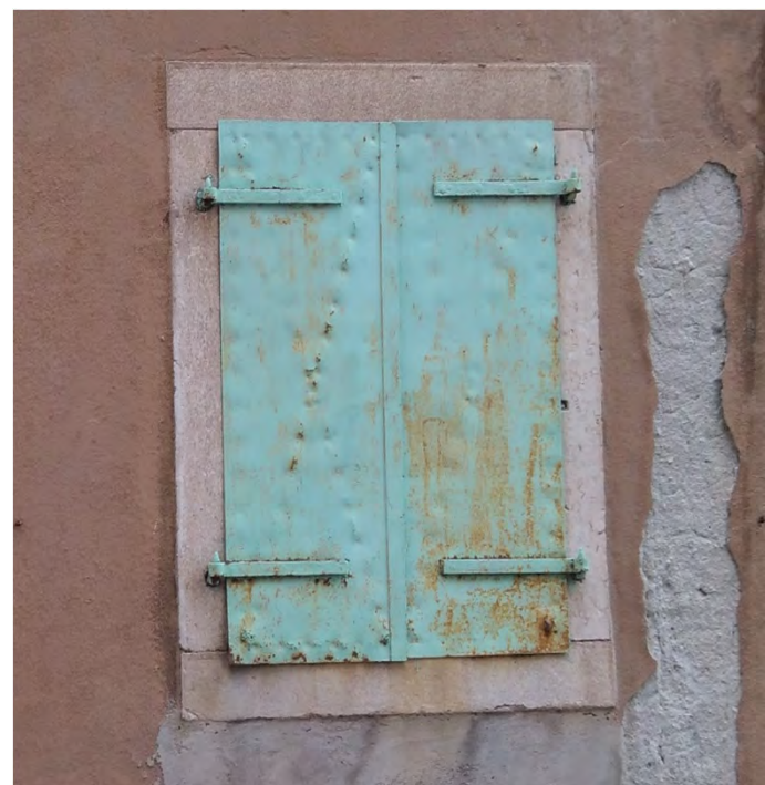
Portellone in ferro a due battenti e due bandelle per anta (via Capitolina 2 - 2019)
