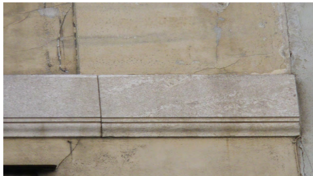
Cornice marcapiano lapidea a piani lisci e con bordi lievemente modanati, impostata alla quota dell'impalcato (via Mazzini 11 - 2019)
