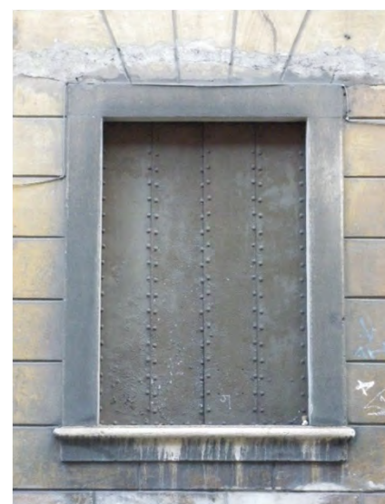
Persiana posta a protezione di un locale non adibito ad abitazione (via San Michele 24 - 2019)
