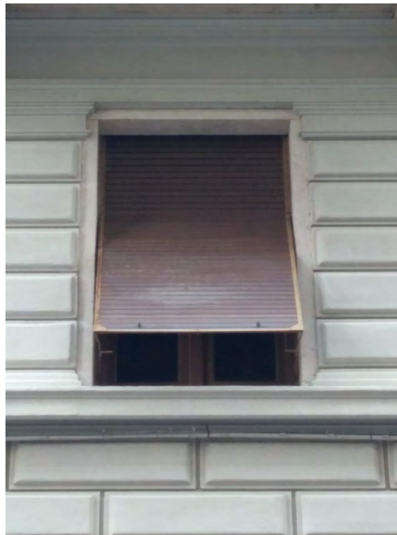
Persiana avvolgibile in legno naturale con sistema basculante (via Genova 11 - 2019)
