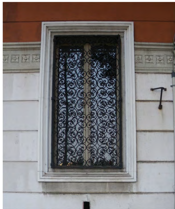
Griglia decorativa incardinata in una foratura rettangolare a protezione di un atrio d'ingresso (riva Grumula 10 - 2019)
