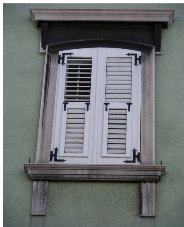
Cornice ad arco ribassato modanata con elemento di raccordo alla cimasa trattato al rustico. La cimasa ed il davanzale modanati poggiano su mensole a voluta (via Valdirivo 11 - 2019)
