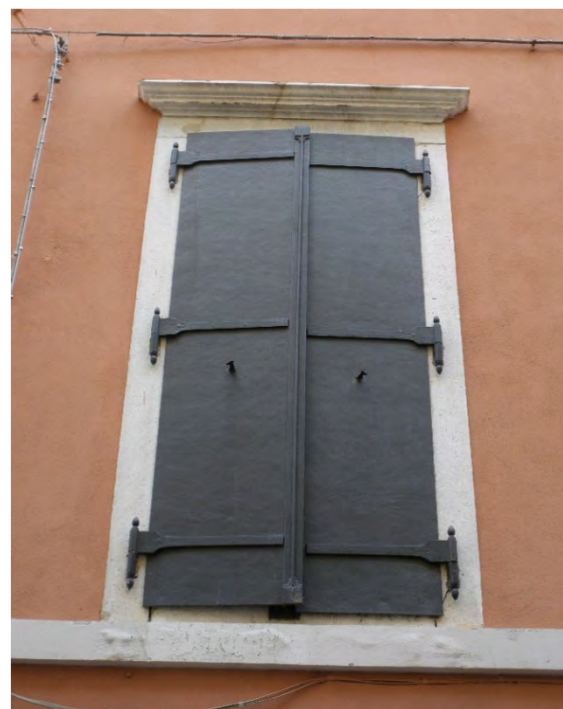
Portellone in ferro a due battenti e tre bandelle per anta (via delle Beccherie 14 - 2019)
