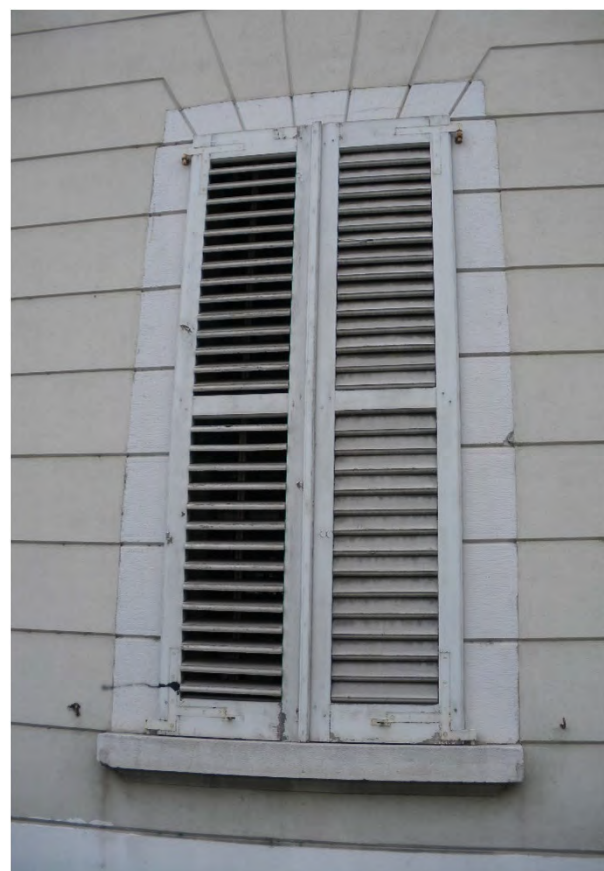
Cornice rettilinea in pietra che riquadra il vano su tre lati, inserita nel rivestimento in intonaco a bugne lisce del paramento. Gli elementi in pietra presentano scanalature in corrispondenza dei giunti tra le bugne. Nella parte superiore le bugne sono sagomate a giunti concentrici con concio in chiave ed elementi laterali caudati. L'elemento che delimita il lato inferiore è un davanzale a piani lisci (largo Papa Giovanni XXIII 6 - 2019)
