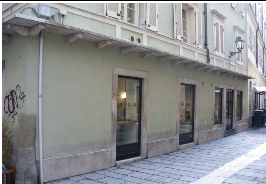
Cornice rettilinea in pietra. La zoccolatura si interrompe in corrispondenza degli stipiti (via del Ponte 2 - 2019)
