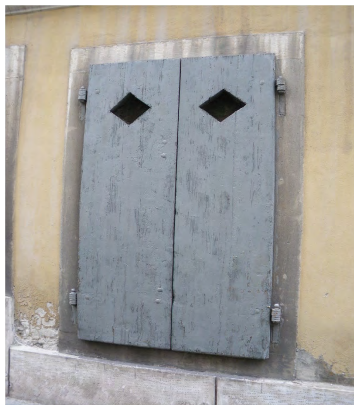
Portellone in legno a due ante, ognuna costituita esternamente da due tavole, sostenuto da un sistema di due cerniere per ciascuna anta (via del Pane 3 - 2019)
