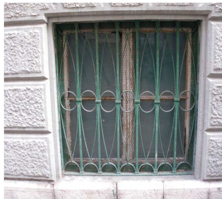
Griglia in metallo con retrostante serramento a protezione dei vani cantina ubicati al piano seminterrato (via della Galleria 8 - 2019)
