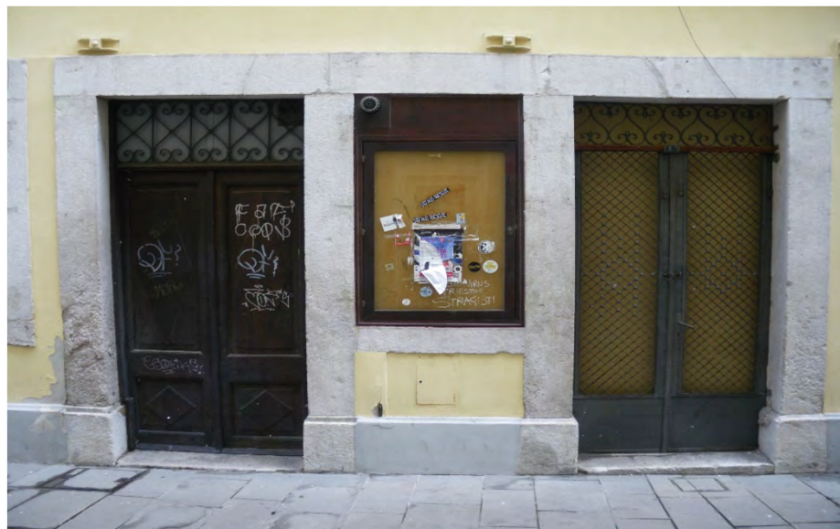
Cornice rettilinea in pietra che riquadra tre aperture affiancate con stipiti centrali comuni ed architrave continuo realizzato con tre elementi lapidei. I piedritti hanno gli elementi di base sporgenti raccordati alla zoccolatura. Il portoncino è in legno verniciato a due ante con specchiature decorate a rombo e sopra luce rettangolare protetto da inferriata (via delle Beccherie 8 - 2019)
