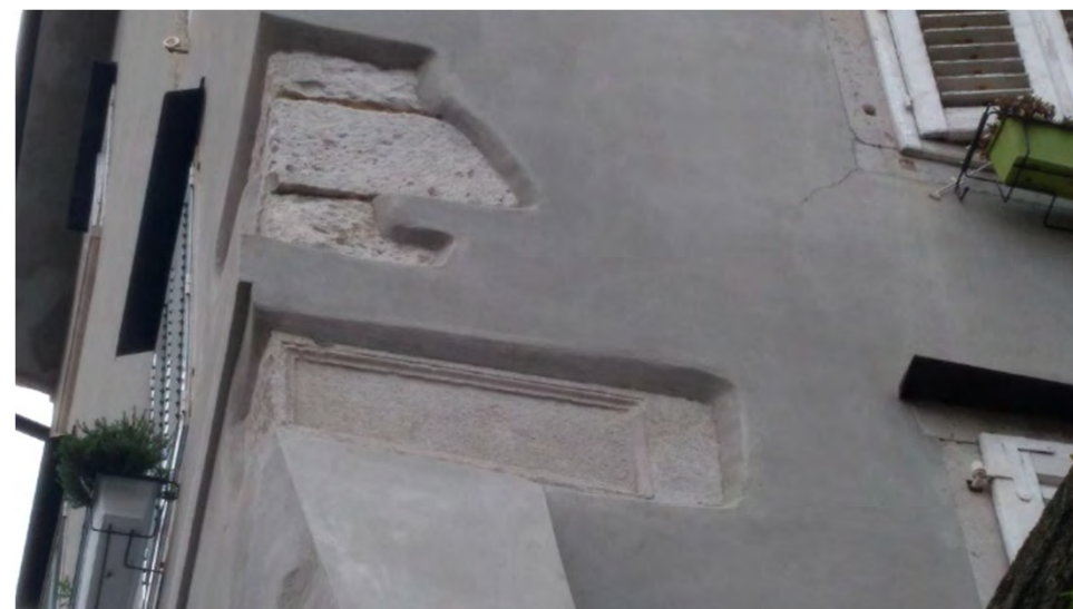
Elemento di recupero in pietra lavorata, scanalata, inserito nel tessuto murario e lasciato a vista (via Rota 1 - 2019)
