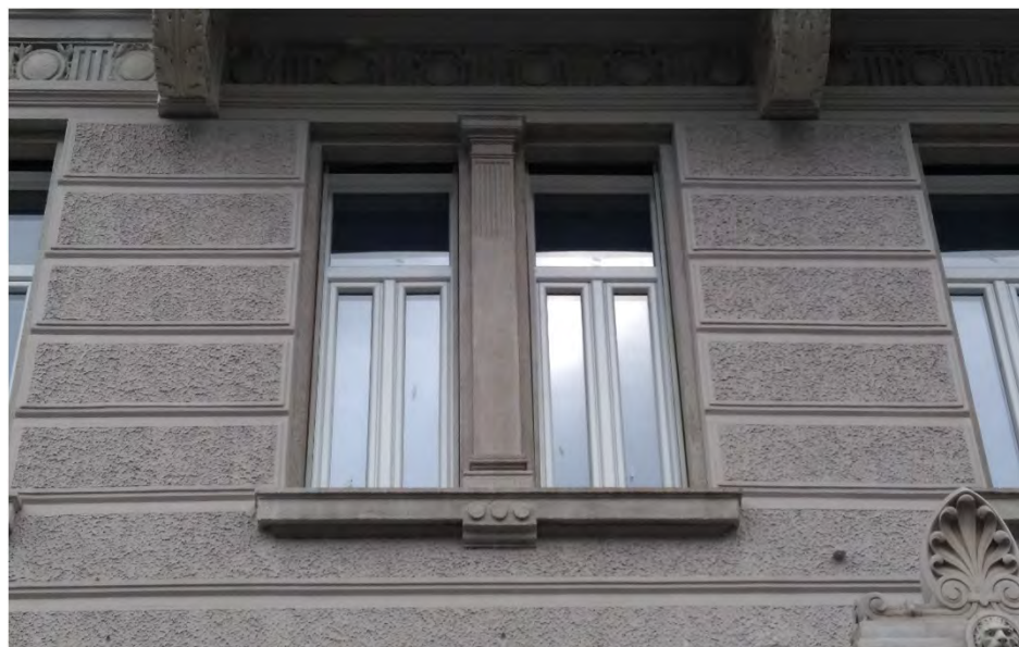
Cornice monocromatica di un'apertura bipartita con pilastrino dorico centrale. La cornice a piani lisci, sottoposta rispetto al piano del bugnato rustico del paramento e del pilastrino, riquadra ciascun foro su tre lati. La parte inferiore dell'apertura è delimitata da un davanzale rettilineo a piani lisci con gocciolatoio e con elemento decorato in lieve aggetto in corrispondenza del pilastrino centrale (via Battisti 18 - 2019)
