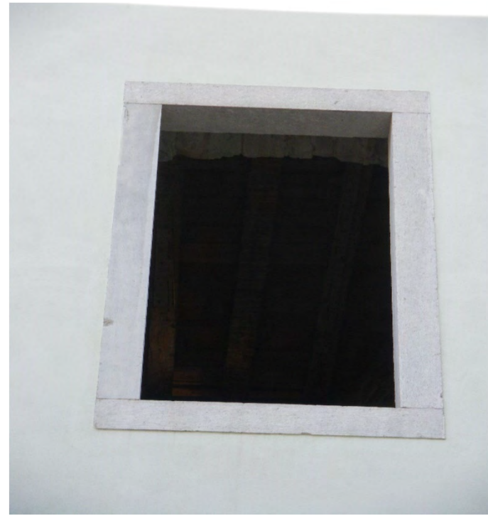
Cornice costituita da quattro elementi di pietra naturale a piani lisci (via dell'Università 15 - 2019)
