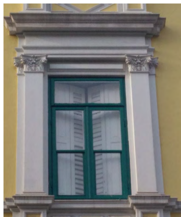
Serramento con soprauce vetrato rettangolare composta da due ante bipartite apribili verso l'interno e "a coulisse" con persiane interne (viale XX settembre 34 - 2019)
