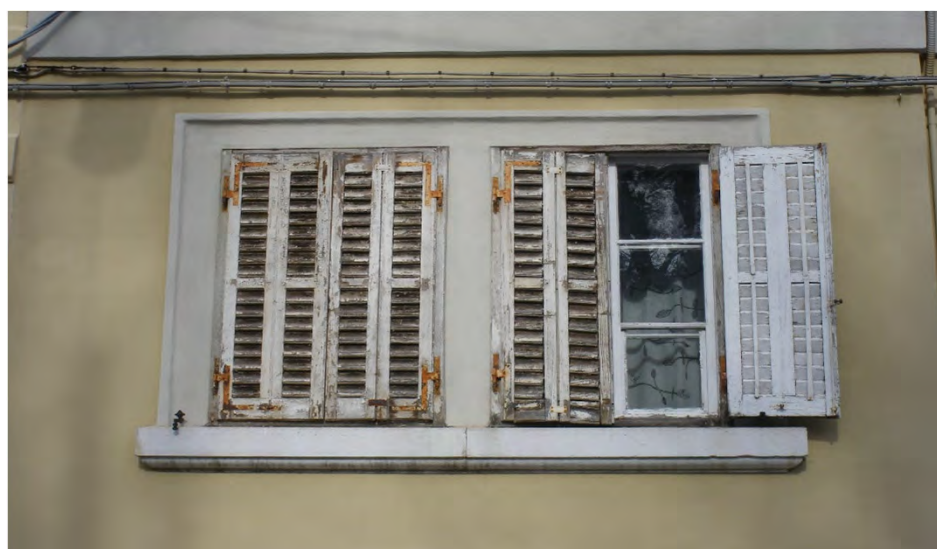
Cornice in intonaco che delimita due fori separati da una colonnina in malta in continuità con la cornice. La cornice è con nastrino perimetrale esterno in risalto. Il lato inferiore è delimitato da un davanzale in pietra modanato che sporge lateralmente dal filo esterno della cornice (via Belpoggio 11 - 2019)
