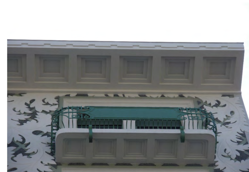
Cornicione monocromatico a sbalzo con decorazione a cassettoni all'intradosso riproposta anche negli sporti dei balconi (piazza della Borsa 7 - 2019)
