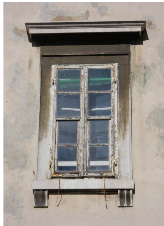
Cornice in pietra modanata con cimasa rettilinea raccordata alla cornice con una fascia lavorata al rustico. Il davanzale lapideo modanato poggia su mensole a voluta con decoro centrale (via dell'Università 1 - 2019)
