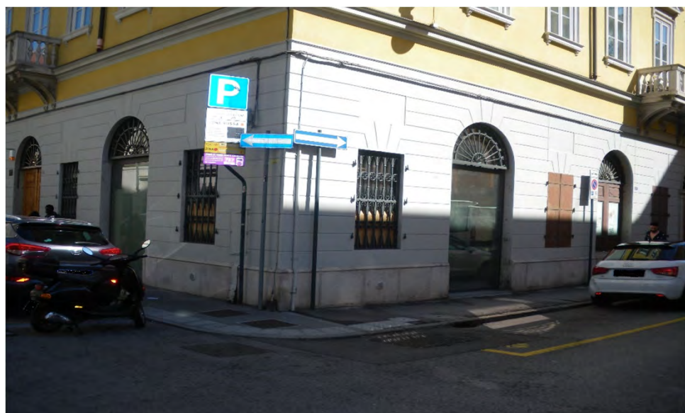
Rivestimento in intonaco liscio listato con giunti convergenti in corrispondenza dei vani di apertura ad arco e riquadri leggermente sotto livello in corrispondenza delle finestre architravate. Il basamento listato si innesta su una zoccolatura in pietra naturale con toro di coronamento di circa 60 cm di altezza e termina in corrispondenza di un'alta fascia marcapiano che separa il piano terra dal primo piano (via di Torre Bianca 8 / via Trento - 2019)
