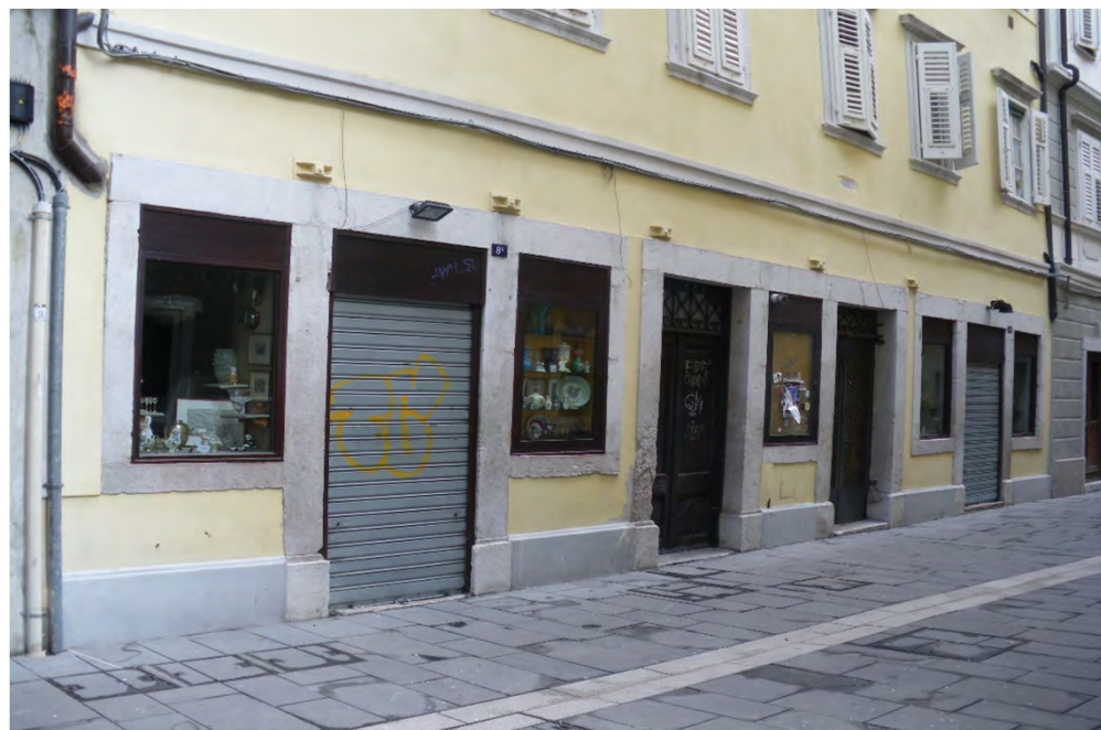
Saracinesche in ferro per porte e finestre architravate al piano terra (via delle Beccherie 8 - 2019)
