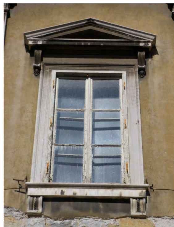
Cornice in pietra modanata con cimasa a timpano triangolare su mensole a voluta. Il davanzale lapideo modanato poggia su mensole a voluta con decoro centrale (via dell'Università 7 - 2019)
