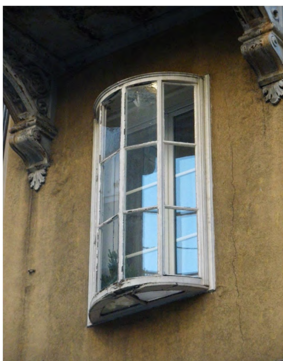
Serramento "a sburto" con quattro pannelli verticali tripartiti apribili e parte aggettante semicircolare bipartita (via Crispi 33 - 2019)
