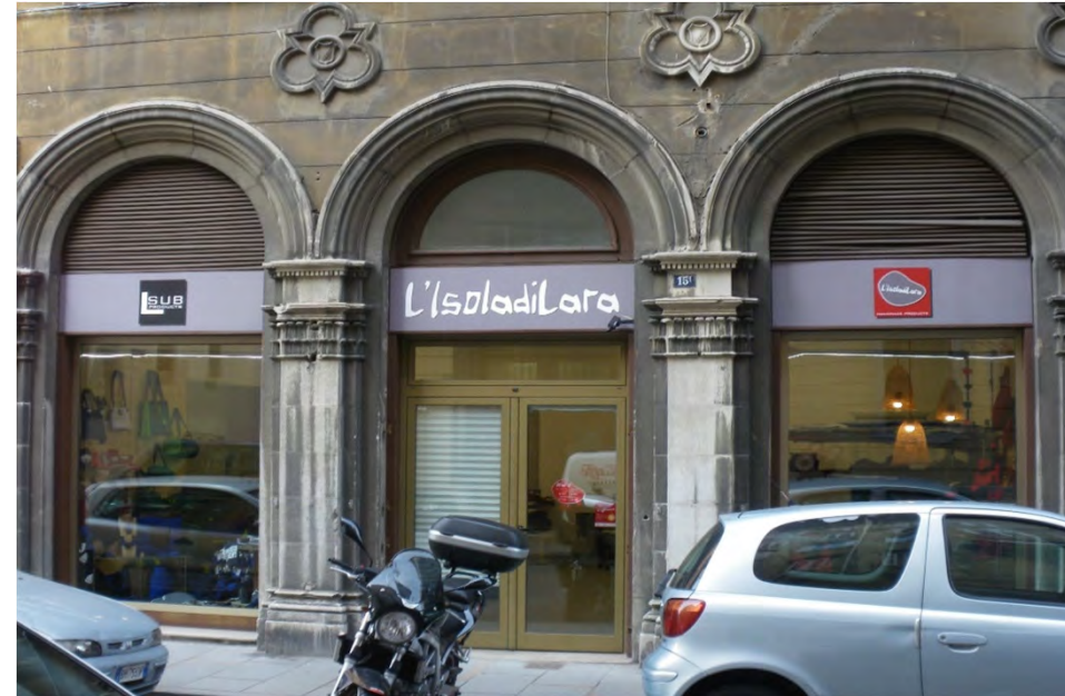
Attività commerciale a due vetrine ed un ingresso. I sopraluce grigliati delle vetrine possono occultare impianti tecnologici (via del Lazzaretto vecchio 15 - 2019)
