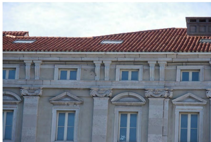
Cornice modanata in pietra, sostenuta da mensole binate, sempre in pietra, poste in corrispondenza delle lesene che decorano la facciata ai piani superiori (piazza dell'Unità d'Italia 3 - 2019)
