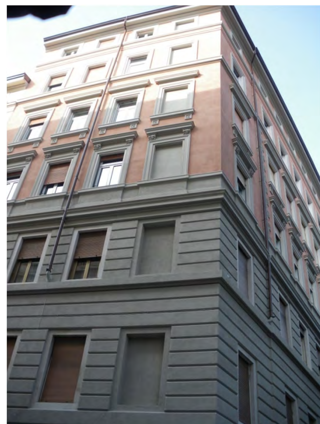
Colonna di forature murate dal primo all'ultimo piano (via di Tor San Lorenzo 4 - 2019)
