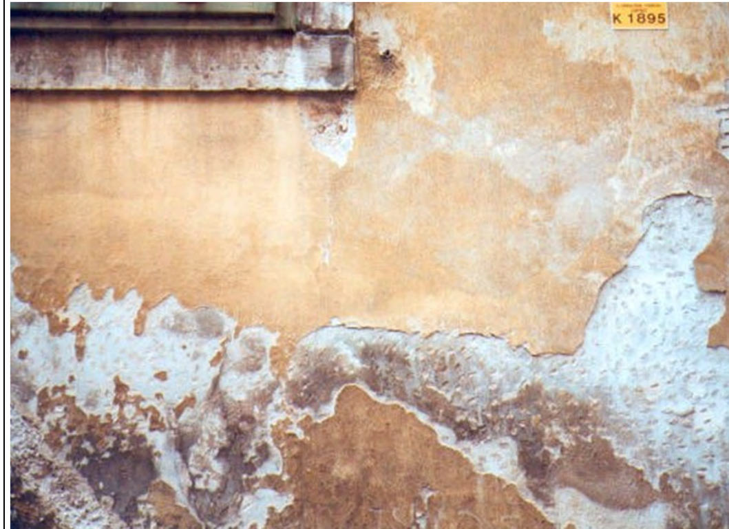
L'esfoliazione ha evidenziato la tinteggiatura giallo ocra. Si noti il rappezzo con malta cementizia.
