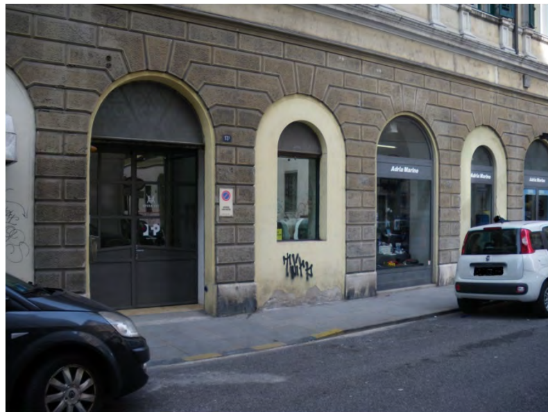
Finestra all'interno di un varco murato al piano terra. (via del Lazzaretto vecchio 13 - 2019)
