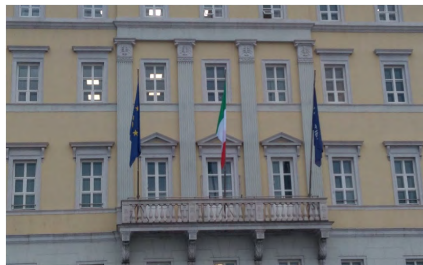
Fondo in intonaco liscio con avancorpo centrale tripartito per due piani da un ordine gigante di lesene scanalate impostate su alti stilobati compresi nell'aggetto del poggiolo centrale. La trabeazione si innesta nella cornice marcapiano modanata dell'ultimo livello. Altre cornici marcapiano, impostate alla base delle finestre, scandiscono la superficie della facciata (corso Cavour 11 - 2019)
