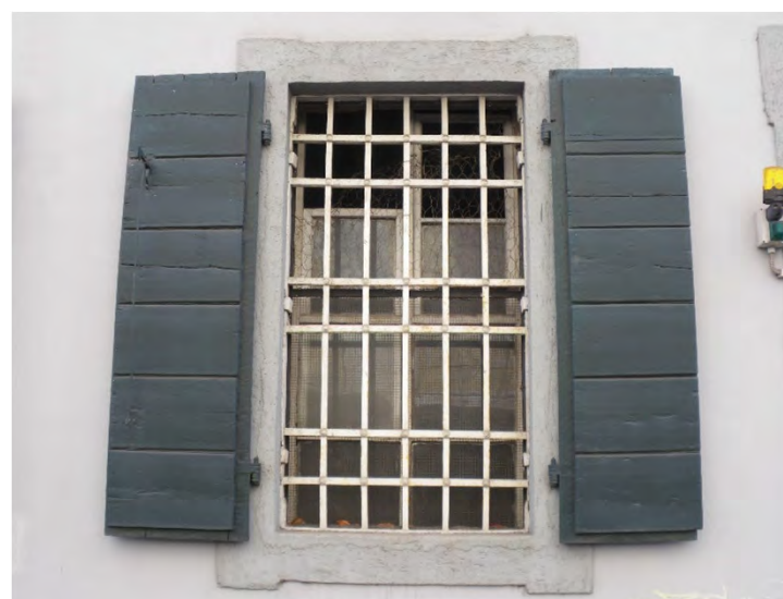
Portellone in legno verniciato; il tavolato interno è costituito da sei tavole per ciascuna anta (via Belpoggio 16 - 2019)
