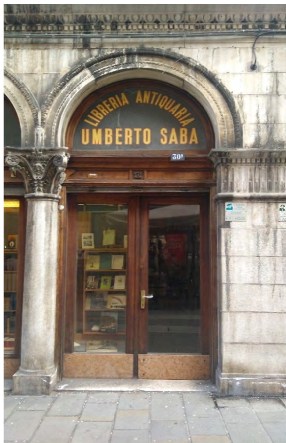
Vetrina storica con sopraluce e denominazione dell'esercizio dotata di due battenti di cui uno adibito ad ingresso (via San Nicolò 30 - 2019)
