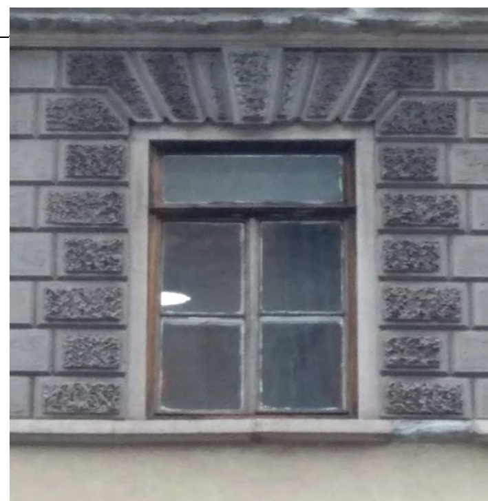
Serramento con soprauce rettangolare vetrato composta da due ante bipartite (via Carducci 27 - 2019)
