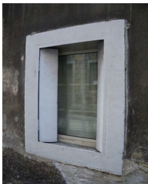
Persiana in fase di apertura. Si notino i due cardini di ogni anta incernierati sulla cornice metallica (via San Michele 25 - 2019)
