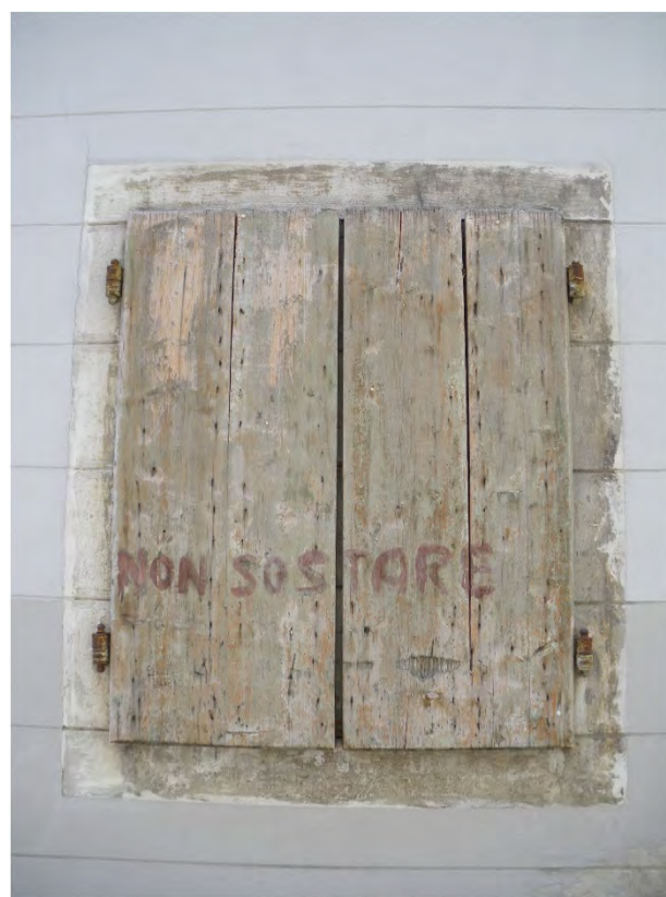
Portellone in legno a due ante, ognuna costituita esternamente da due tavole, sostenuto da un sistema di due cerniere per ciascuna anta (via del Pane 3 - 2019)
