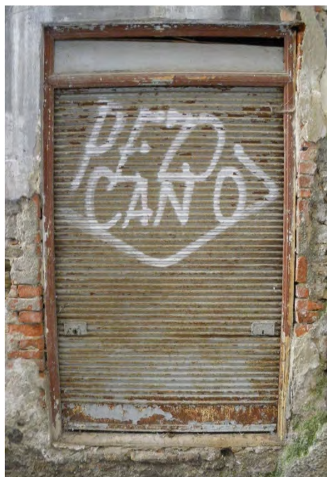
Saracinesca in ferro con mostra e pannello superiore (via delle Beccherie 3 - 2019)
