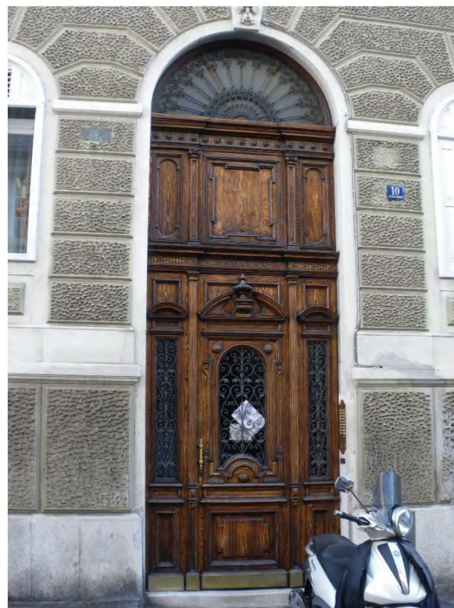
Portale ad arco definito dal rivestimento in bugnato rustico del basamento realizzato in intonaco e tinteggiato ad imitazione della pietra. I bugnato è sagomato con giunti concentrici in corrispondenza dell'arco con concio in chiave decorato in risalto. L'apertura è definita da una stretta cornice a piani lisci rientrante rispetto al filo esterno delle bugne (via dell'Università 10 - 2019)
