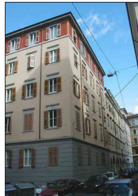
via dei Fabbri 5
