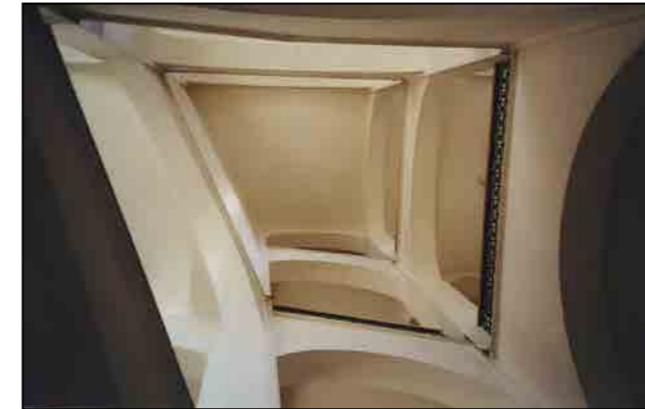
Particolare tromba della scala
