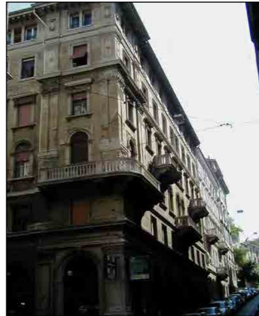
Particolare del prospetto su via Belpoggio
