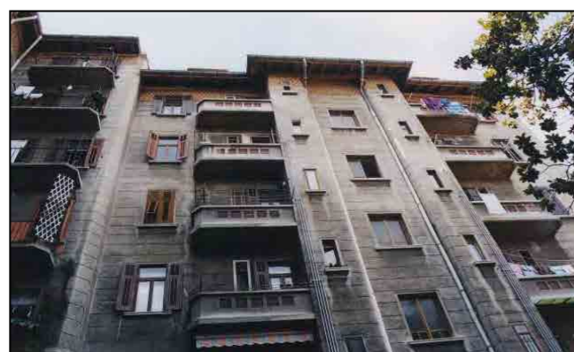
via della Galleria 4 prospetto interno
