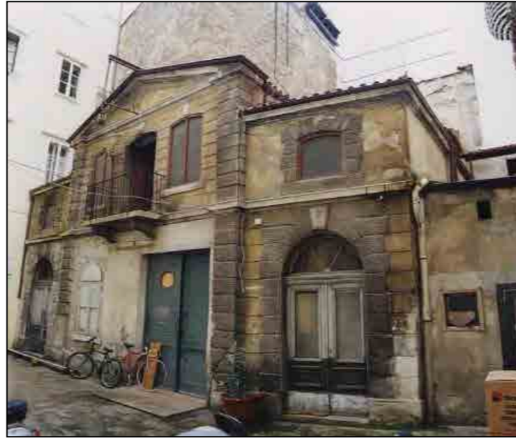
Edificio interno alla corte ( fotografia alla data del rilievo)
