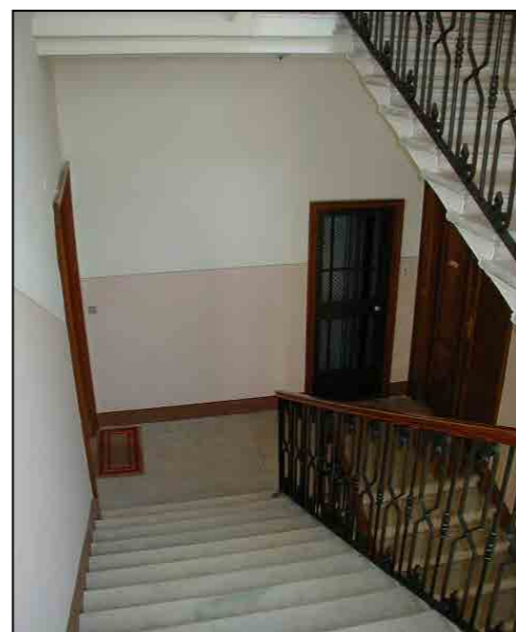
Particolare del corpo scala di via del Lazzaretto Vecchio 13
