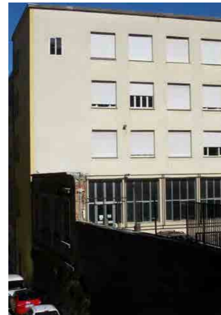
via don E. Marzari 6 - Facciata postica
