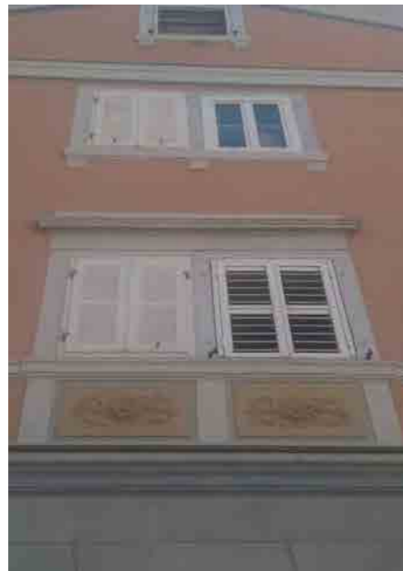
Prospetto su via della Cereria con finte persiane ("scuri") in malta - particolare
