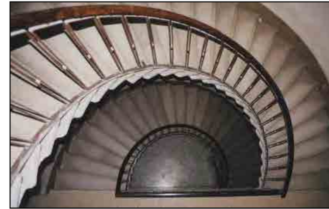
Particolare della scala anulare semicircolare in pietra
