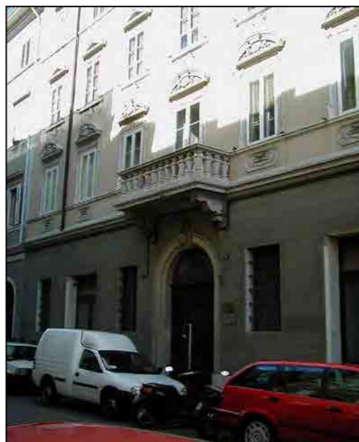
Particolare prospetto su via del Lazzaretto Vecchio
