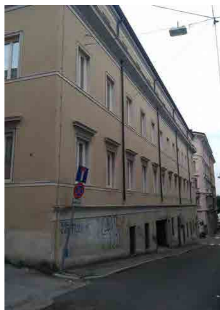
anagrafico 91. Facciata in via Belpoggio 3/1
