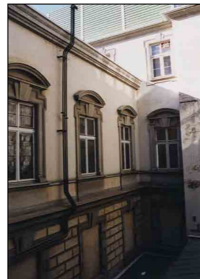
le finestre del vano scala principale
