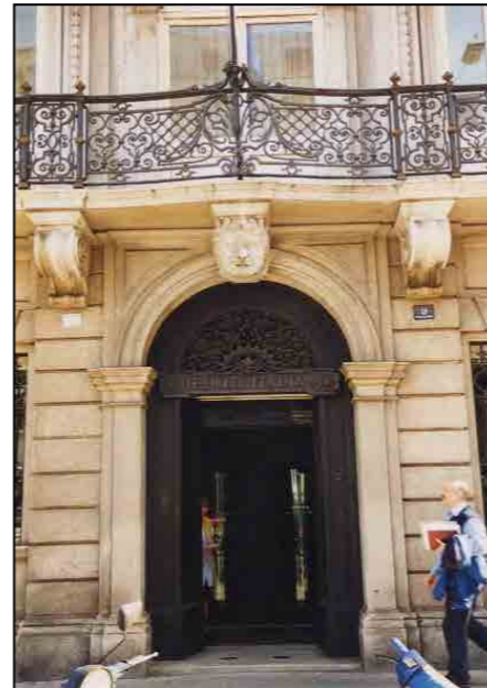
Particolare dell'ingresso principale
