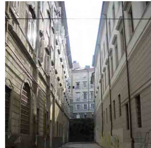
Facciata su androna privata
