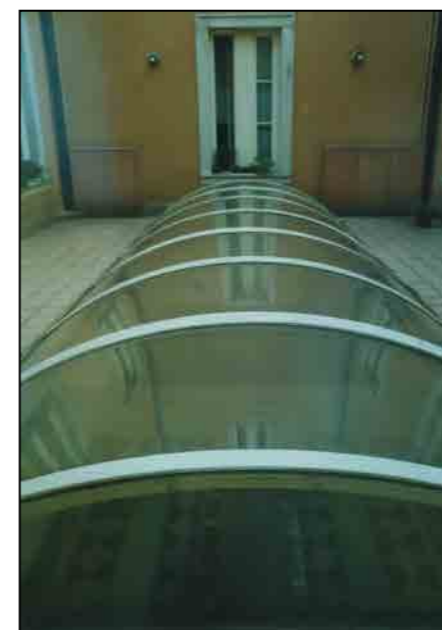
Copertura della galleria dalla corte
