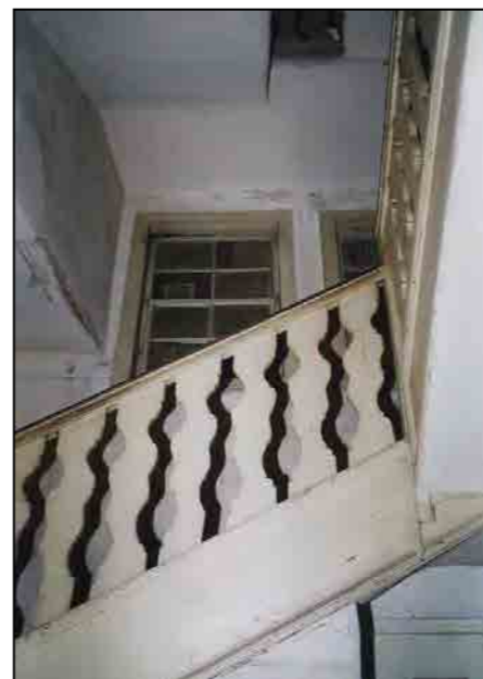
Vano scale in legno
