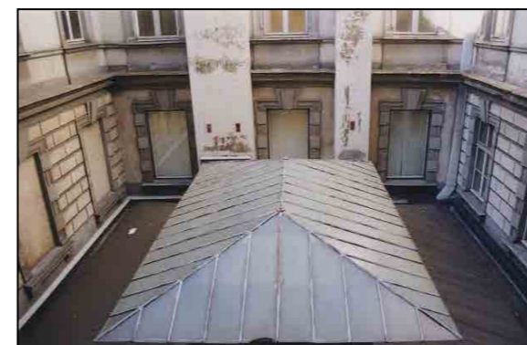
la copertura della galleria
