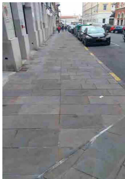
Pavimentazione di pregio lungo parte della via Economo ed il tratto finale di via Lazzaretto Vecchio
