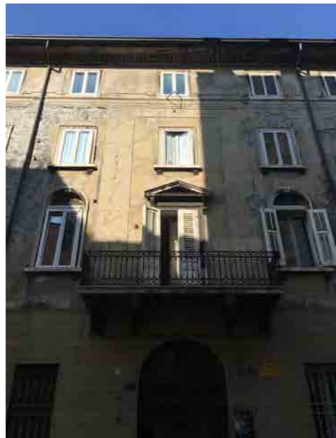
Particolare facciata su via A. Diaz
