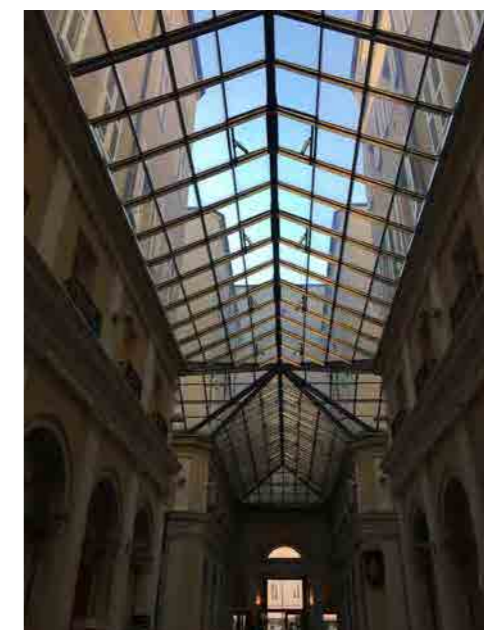
Particolare della galleria
