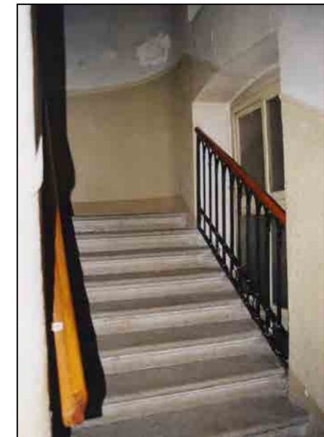
Scala a rampe parallele
