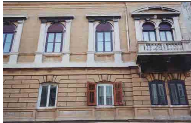
Particolare serramenti esterni
