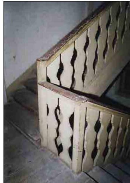
Particolare balastra in legno
