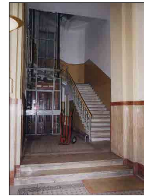
Via S. Lazzaro 3 ingresso
