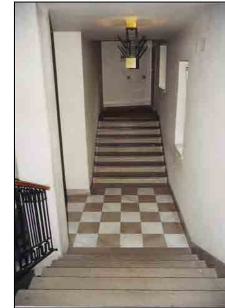
Particolare corpo scala
