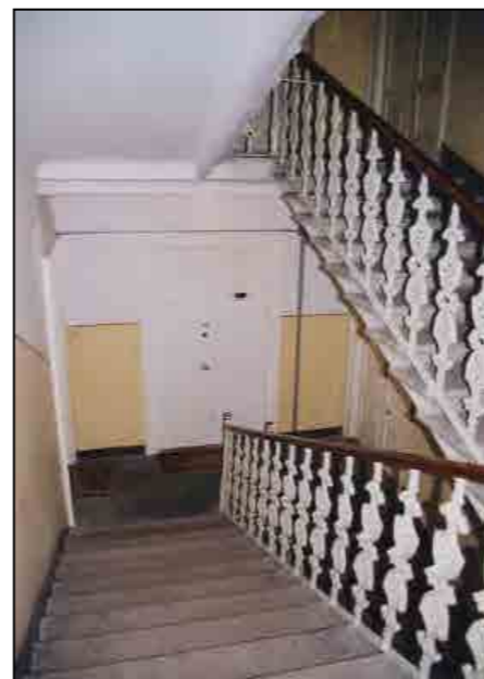
Vano scala an. 81
