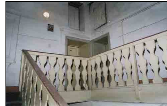
Vano scale in legno
