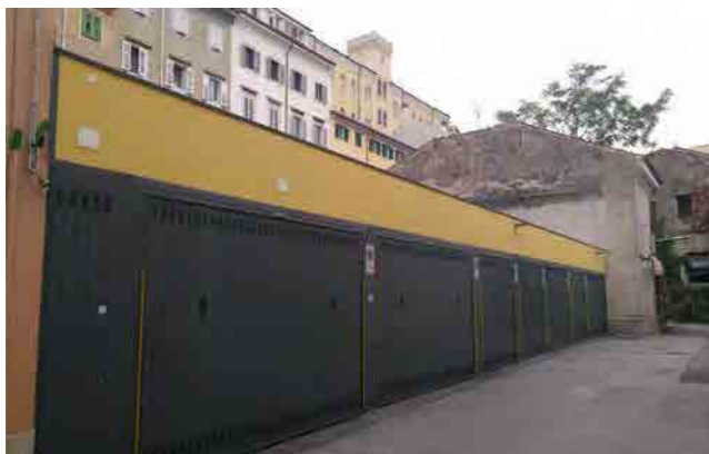
anagrafico 7076 - fronte androna Santa Eufemia e facciata laterale dell'edificio in androna Santa Eufemia 7
