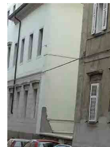
via dell'Università muro di corrispondenza dell'androna
