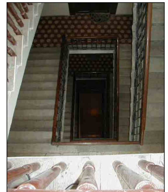
Vano scala visto dall'alto
