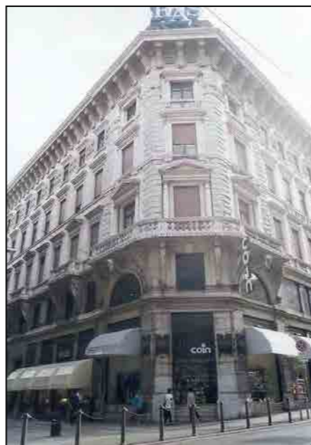
corso Italia / via Dante Alighieri. Particolare della soluzione d'angolo
