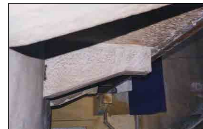
Particolare della mensola e soletta a sbalzo in pietra
