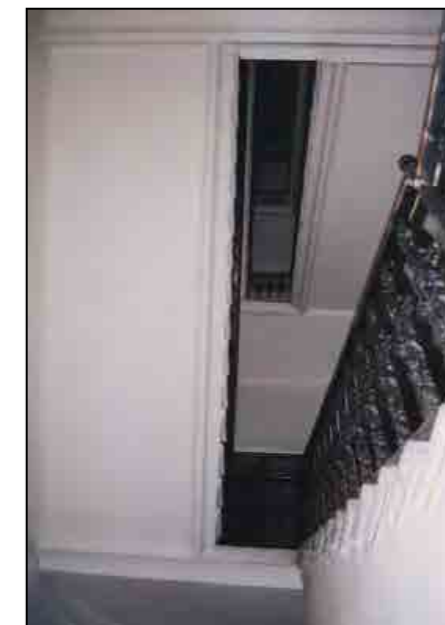
Vano scala an.83
