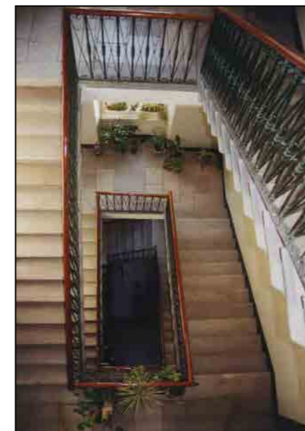
Particolare scala vista dall'alto
