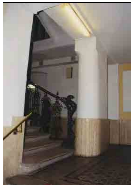
Inizio rampa scala
