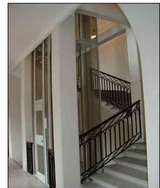
Particolare del corpo scala dell'anagrafico 63
