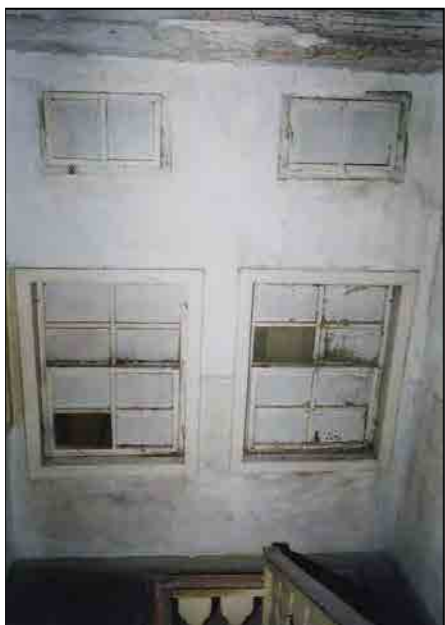
Particolare finestratura pianerottolo
