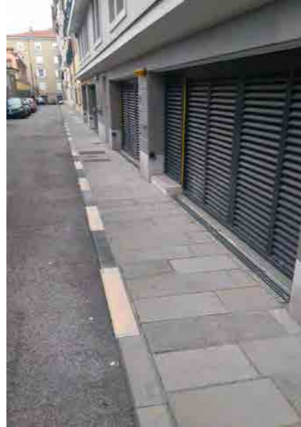
pavimentazione pregiata lungo l'androne Santa Tecla
