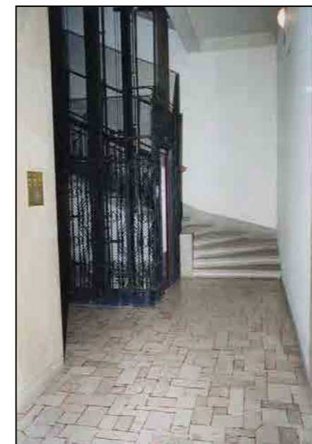
via Santa Caterina 3 - vano scala
