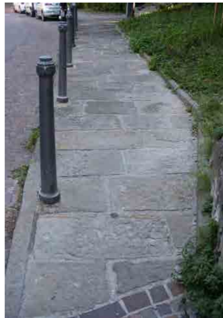
particolare dell pavimentazione in pietra presso via del Monte 21
