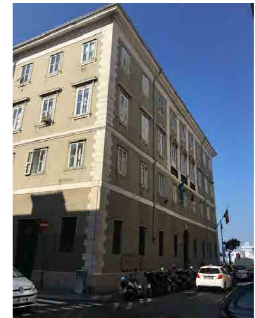
Prospetto su via F. Venezian
