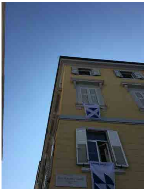
Particolare di facciata su riva N. Sauro
