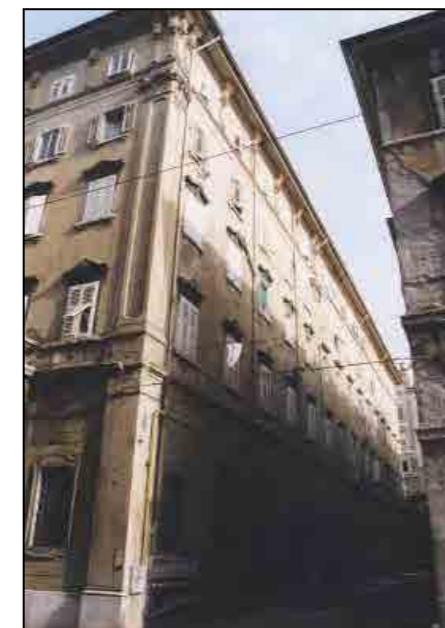
facciata su androna privata
