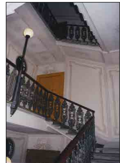
Vano scala (fotografia alla data del rilievo)
