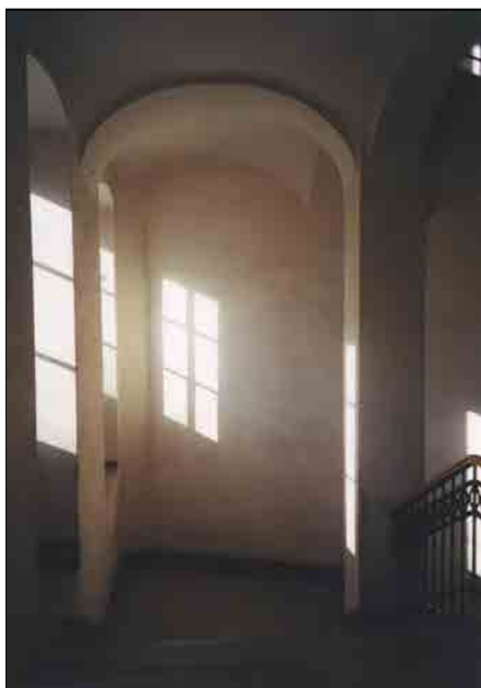
Particolare pianerottolo intermedio
