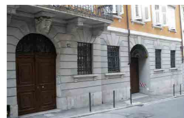
ingresso al fabbricato ed alla autorimessa
