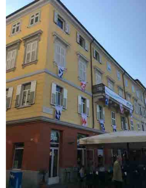
Particolare di facciata su riva N. Sauro
