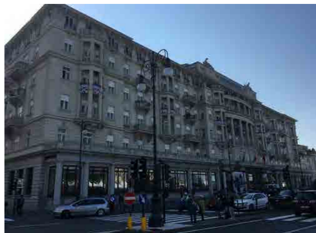
particolare facciata su riva del Mandracchio
