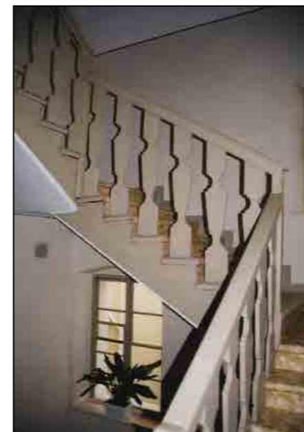
Scala in legno - ultimo piano
