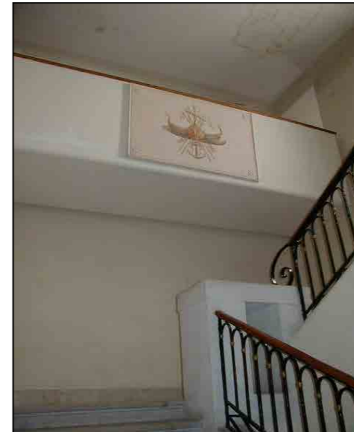
Particolare ultimo piano del corpo scala an. 49
