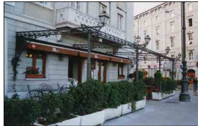
Particolare della tettoia in ghisa originale
