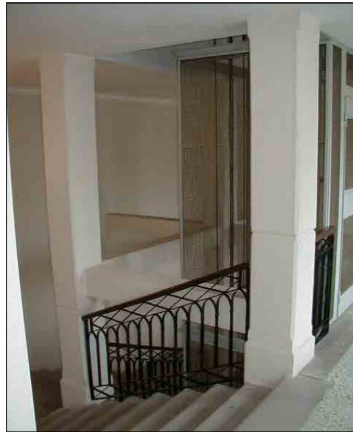
Particolare del corpo scala dell'anagrafico 63
