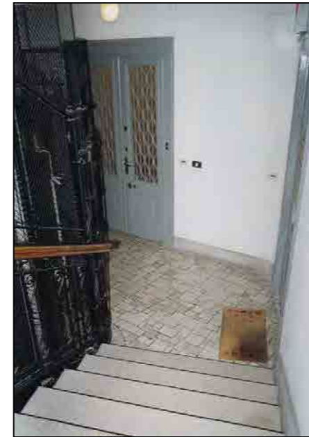
via San Lazzaro 2 - vano scala
