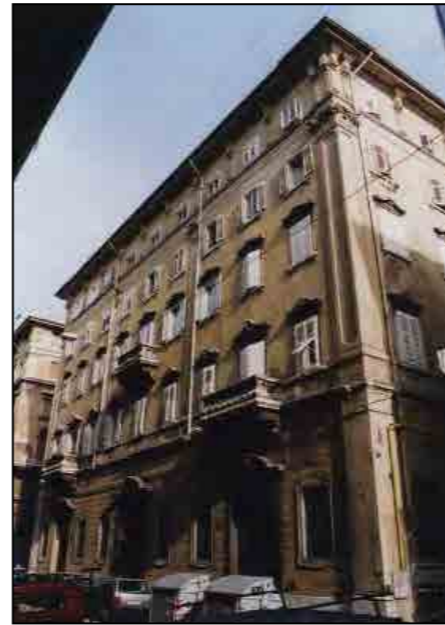
Facciata su via del Lazzaretto Vecchio
