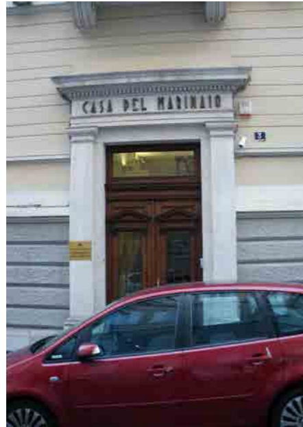
via Principe di Montfort 3 - particolare dell'ingresso
