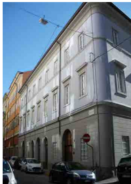
via dei Fabbri 10
