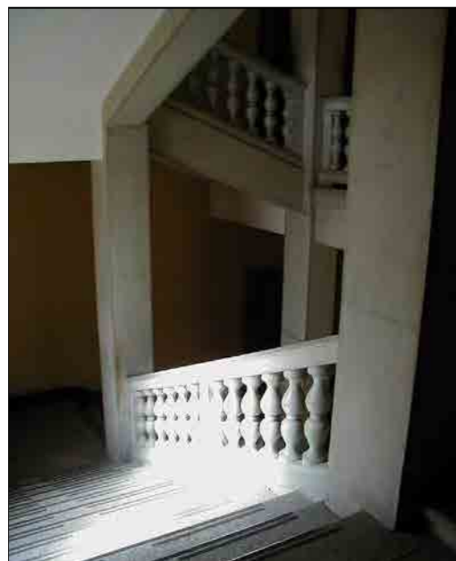
Particolare del corpo scala
