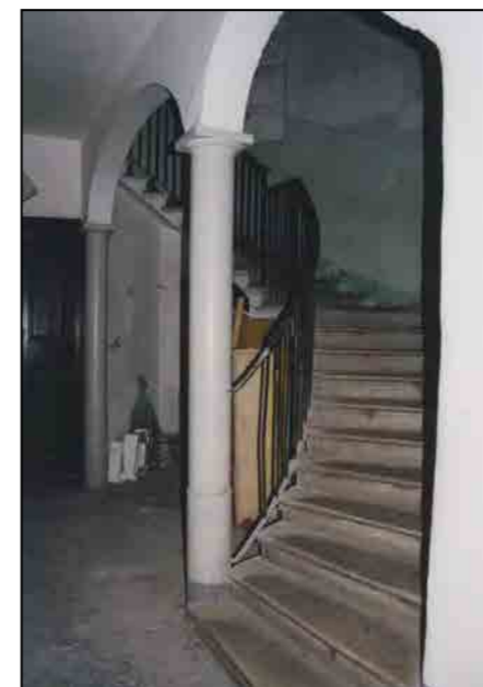
Vano scala anulare semicircolare
