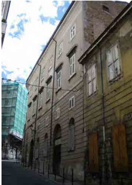
Prospetto su via Venezian
