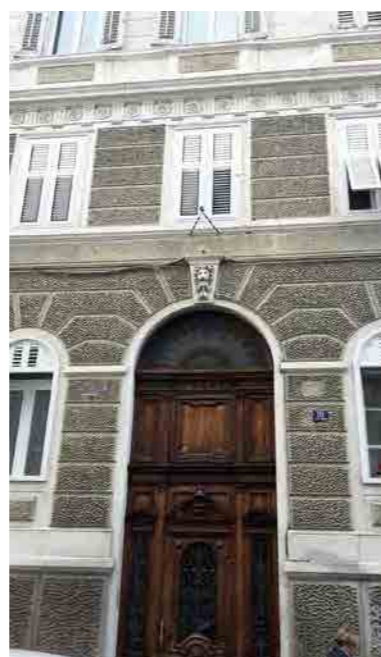
particolare della facciata - via dell'Università 10
