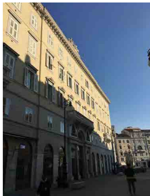
Ingresso alla galleria da piazza della Borsa
