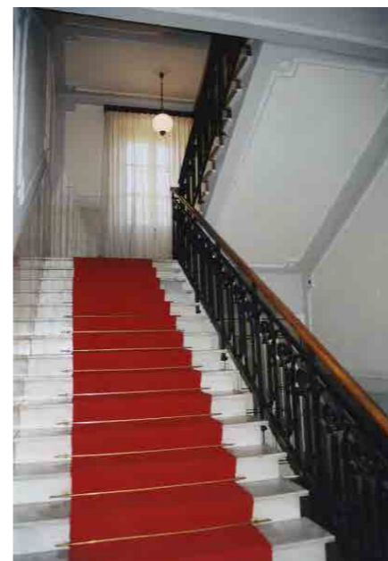
corpo scala a due rampe contrapposte
