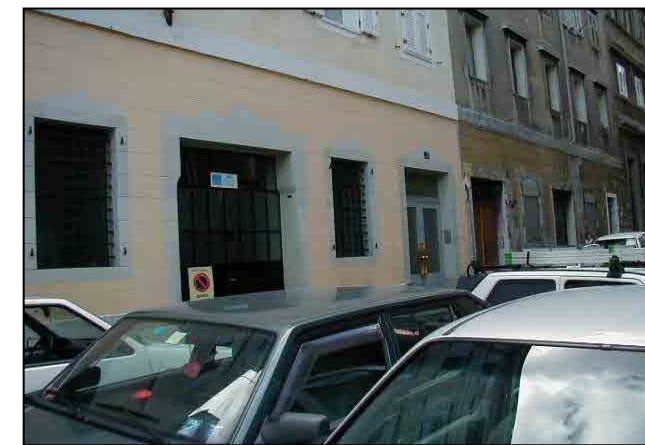
particolare pianoterra, via SS. Martiri 2
