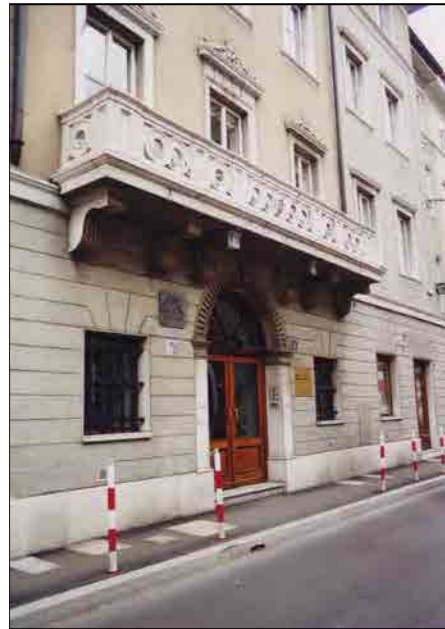
Particolare portale d'ingresso
