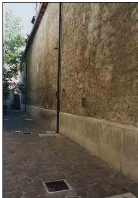
via della Cereria 7 - 5 - 3 prospetto retrostante
