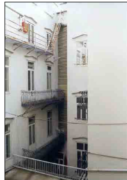
particolare dei balconi prospicienti la corte
