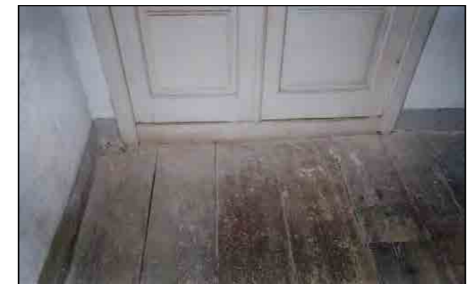
Particolare pavimentazione pianerottolo in tavolato di legno
