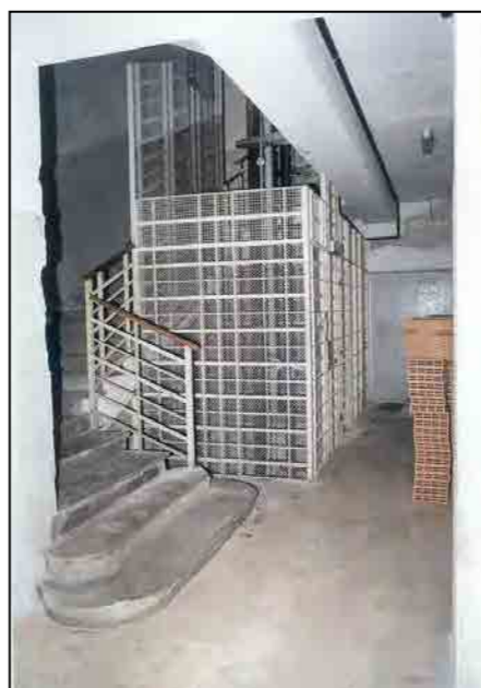
via Mercato vecchio 1 - vano scala
