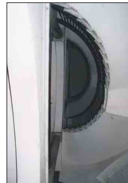
Vano scala anulare semicircolare
