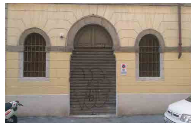
via dei Fabbri 3 - particolare del piano terra
