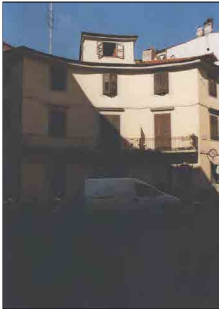
Prospetto su piazza della Valle
