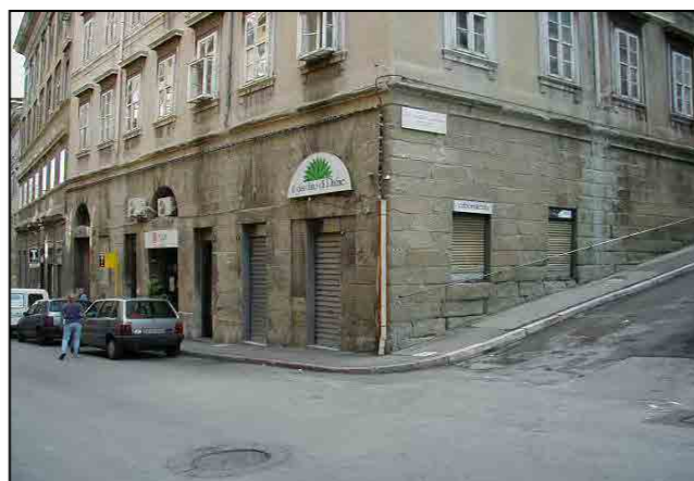
particolare pianoterra, via SS. Martiri 8 angolo via G. Camician
