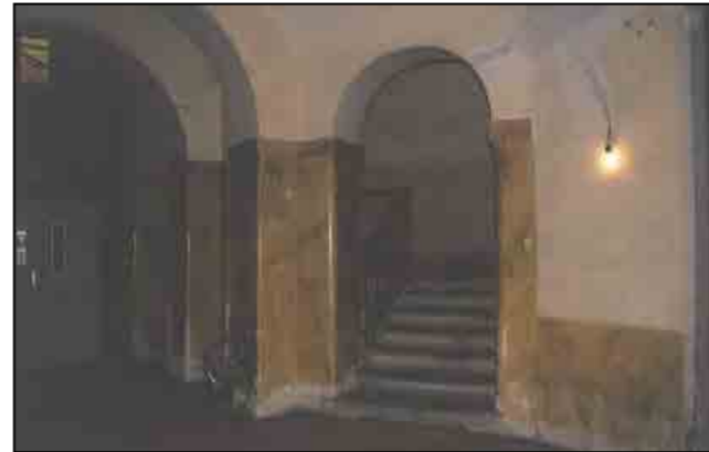
Androne d'ingresso (alla data del rilievo)
