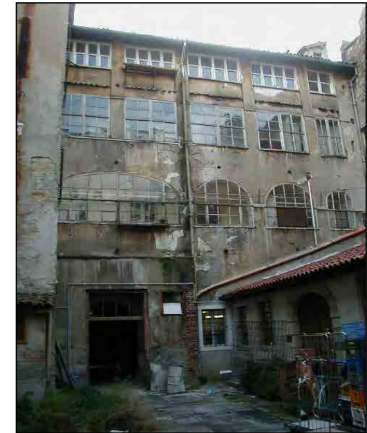
Cortile interno (fotografia alla data del rilievo)
