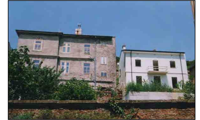
via T. Grossi 16-14 retro delle case; gli spazi verdi sono in parte incolti, in parte destinati a orti.
