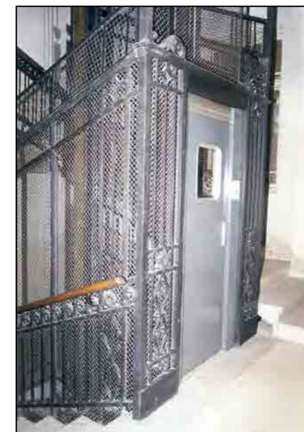
via L. Cadorna 3 - vano scala
