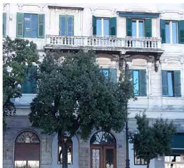
particolare della facciata- riva Grumula 2
