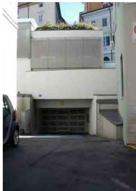
piazzetta Santa Lucia 4 - ingresso garage
