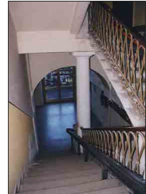
Il vano scala verso l'ingresso
