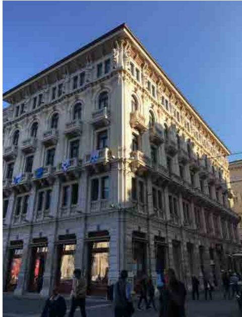
la facciata su via del Teatro
