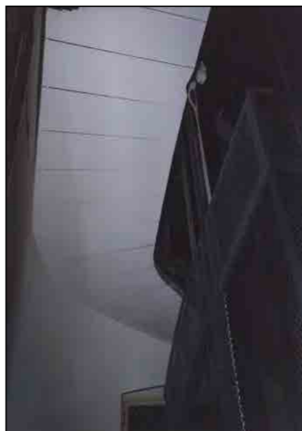
Particolare del corpo scala a sbalzo
