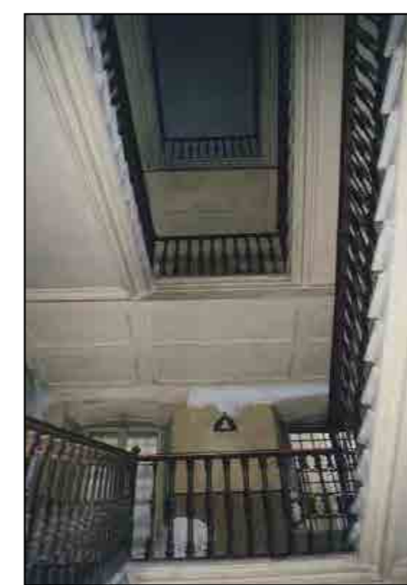
Vano scala (fotografia alla data del rilievo)
