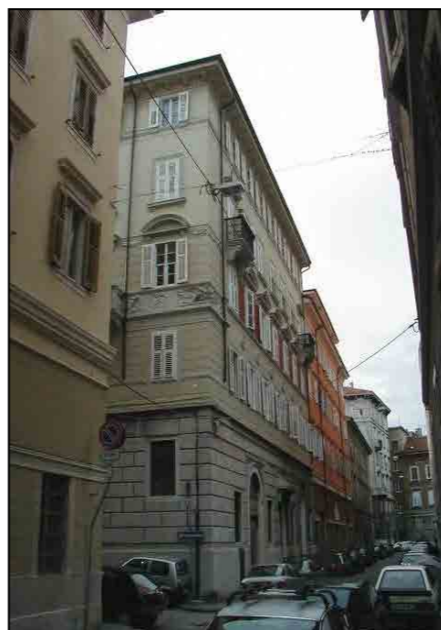
via dei Fabbri 8 - 6
