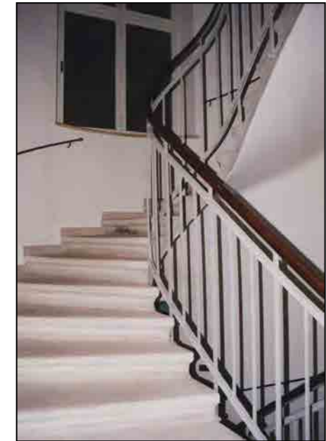
Vano scala secondario
