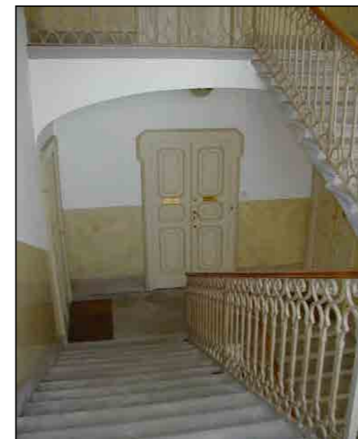
Particolare corpo scala
