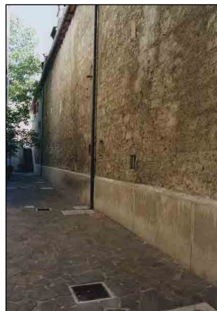
via della Cereria 7 - 5 - 3 prospetto retrostante
