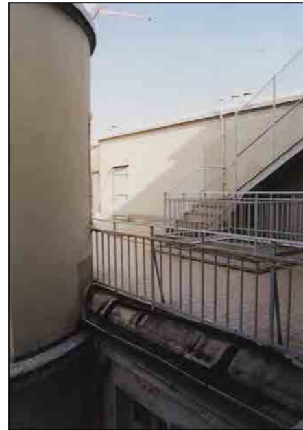
Lastrico solare calpestabile
