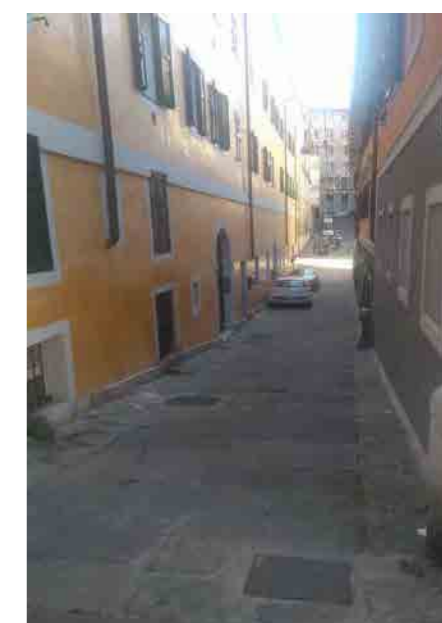
pavimentazione in pietra lungo via Cereria
