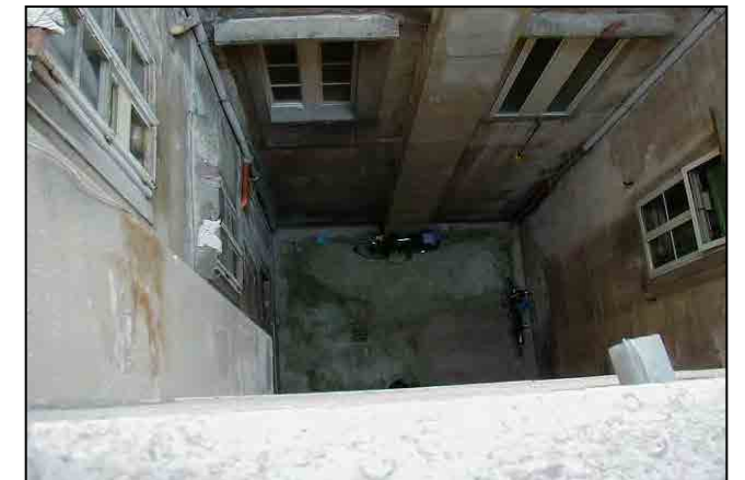
Particolare del cavedio
