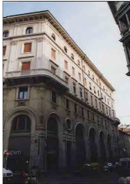
via San Lazzaro 2 e 4 - facciata
