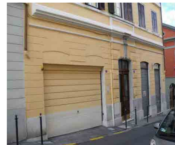
via Madonna del Mare 19 (particolare del piano terra)
