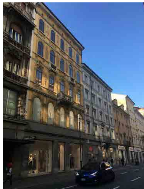
corso Italia 21 - 19 - 17 La facciata del civ. 21, vincolato ai sensi degli artt. 2 e 3 della L. 1089/39, ha subito interventi di manutenzione impropri: dal trattamento del paramento murario esterno, all'impiego dei materiali all'interno
