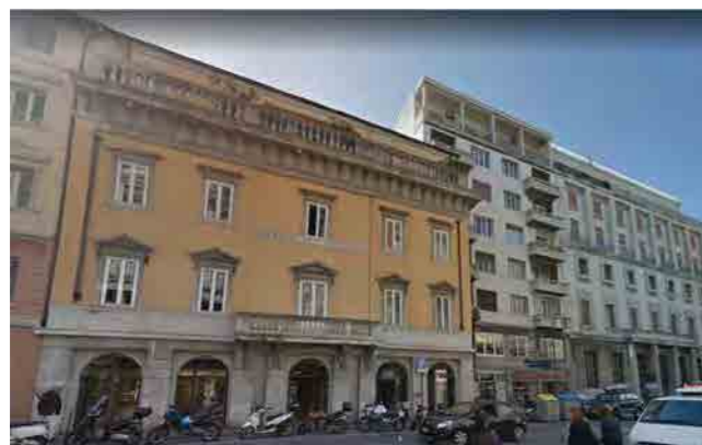
Prospetto su corso Italia 9
