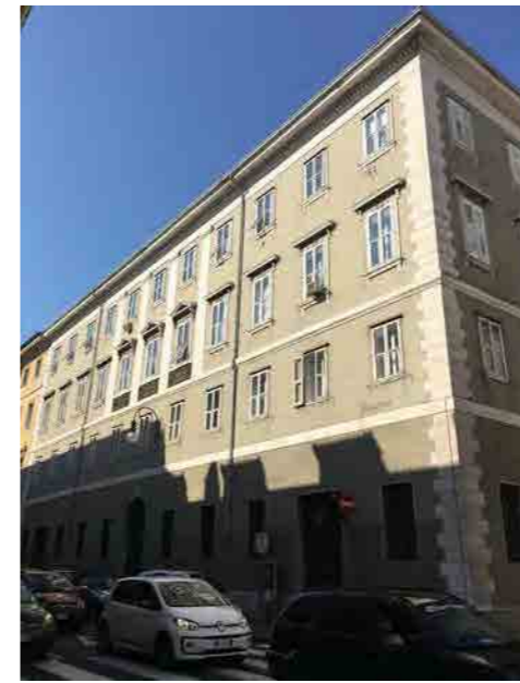
Prospetto su via L. Cadorna
