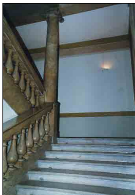
Particolare del corpo scala
