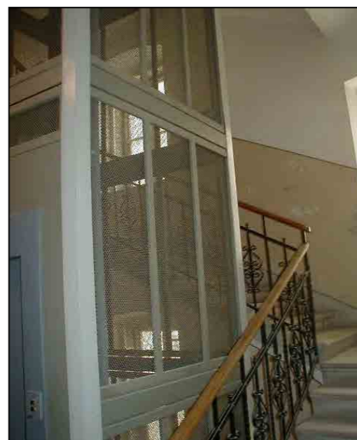
Particolare del corpo scala
