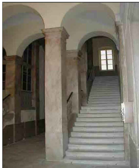
Particolare corpo scala
