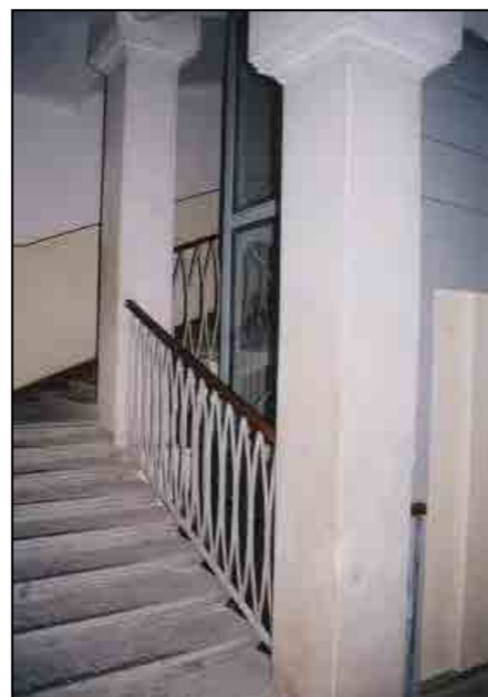
Vano scala an. 82
