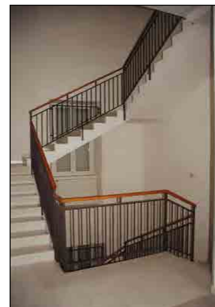
Corpo scala di servizio
