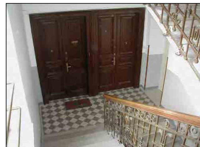
Particolare del corpo scala
