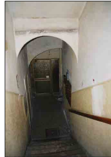
Atrio d'ingresso: parte relativa all'accesso alla scala
