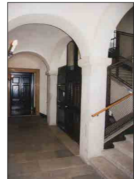
Particolare del corpo scala
