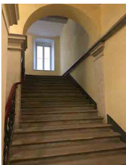
Particolare del corpo scala
