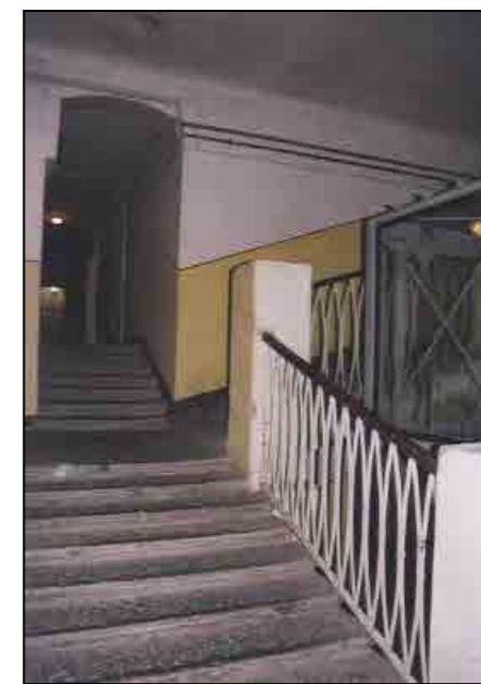
Vano scala ultimo piano
