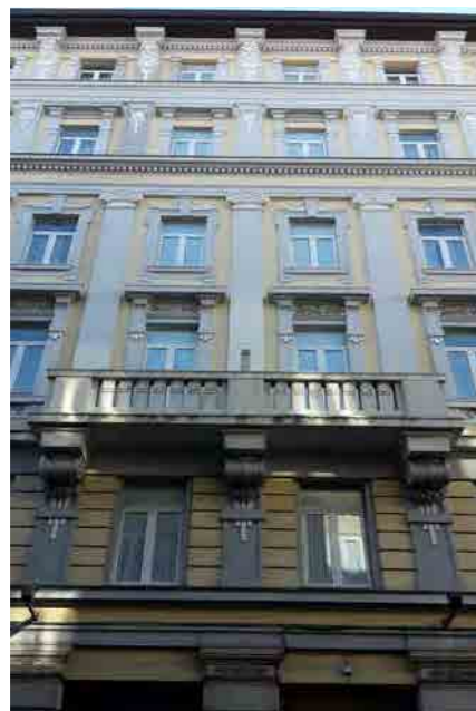
via A. Diaz 14 - particolare della facciata
