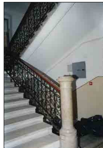
Scala a rampe parallele
