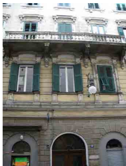
particolare della facciata - via del Lazzaretto vecchio 13
