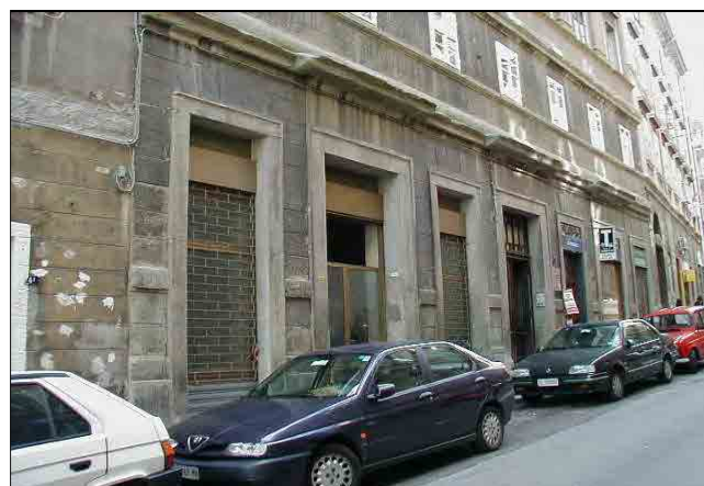
particolare pianoterra, via SS. Martiri 6
