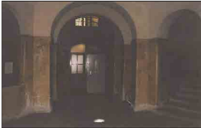
Androne d'ingresso (alla data del rilievo)
