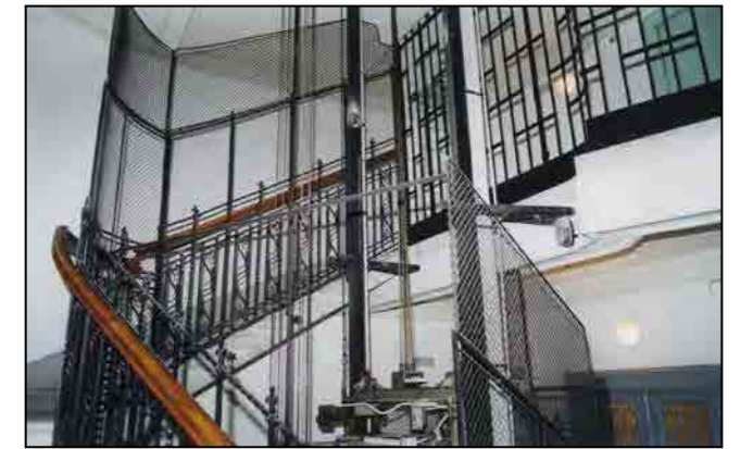
via San Lazzaro 2 - vano scala
