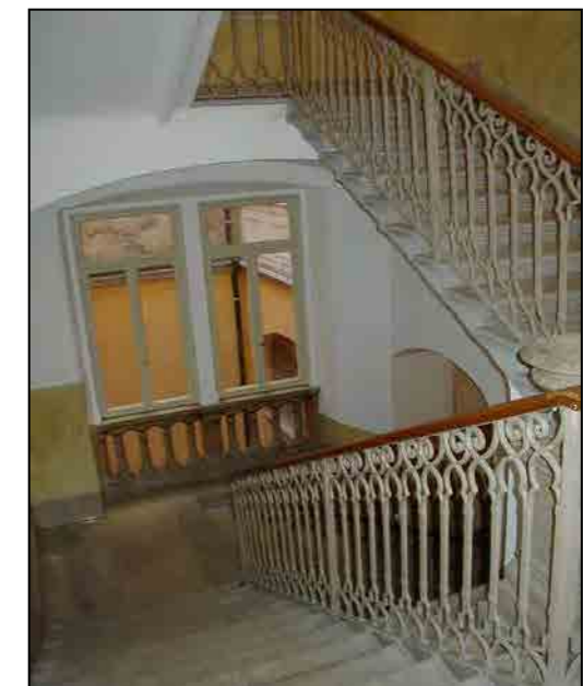
Particolare corpo scala
