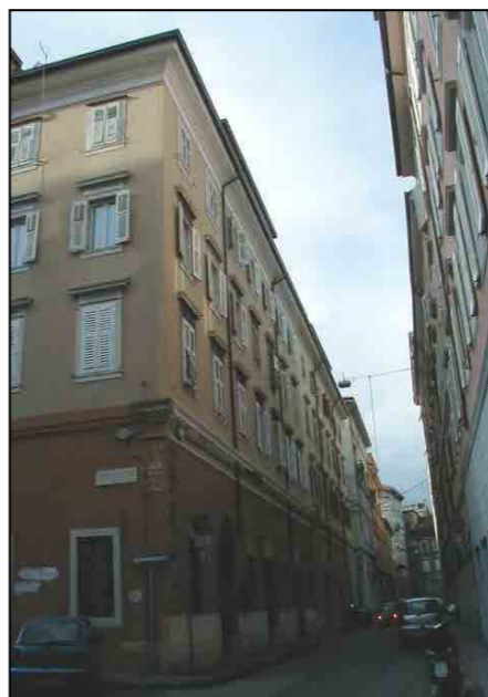
via dei Fabbri 2 - 4
