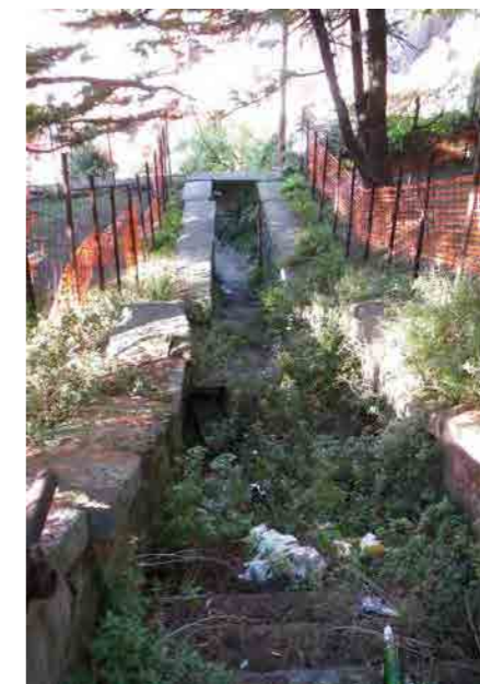
parte finale del percorso pedonale in via di Caboro
