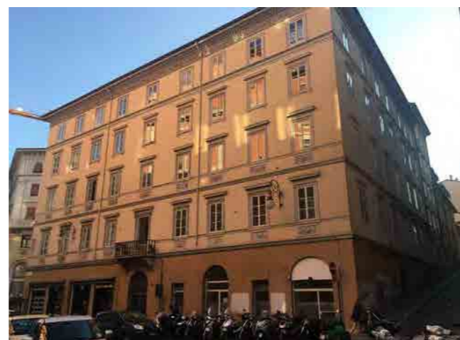
Facciata su piazza S. Benco
