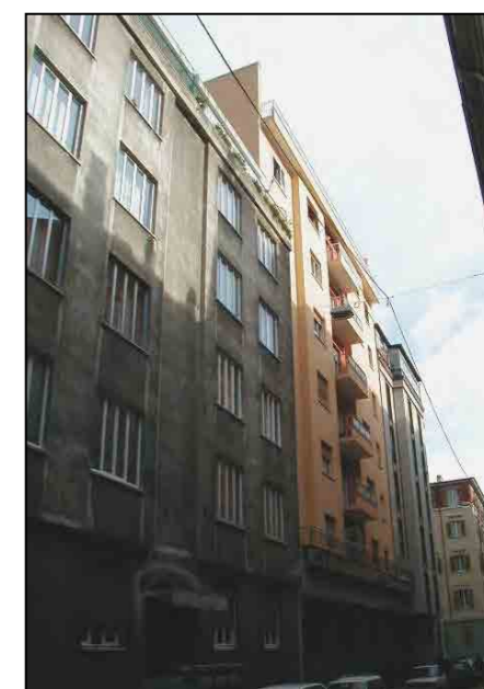
via dei Fabbri 11 - 9
