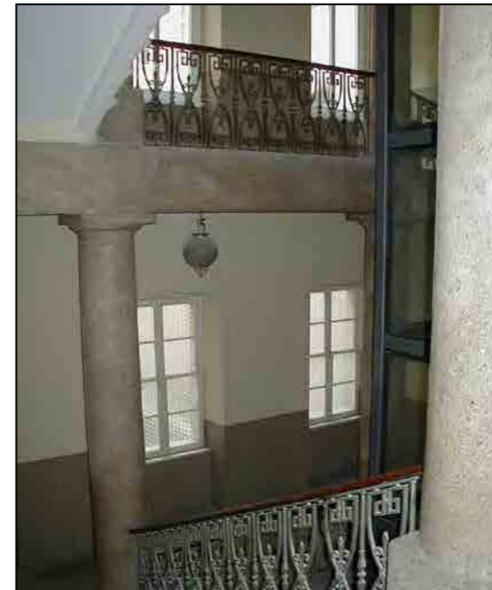
Particolare corpo scala
