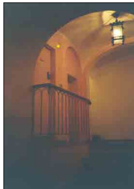
particolari del vano scala
