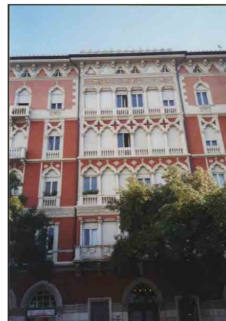
particolare della facciata - riva Grumula 10
