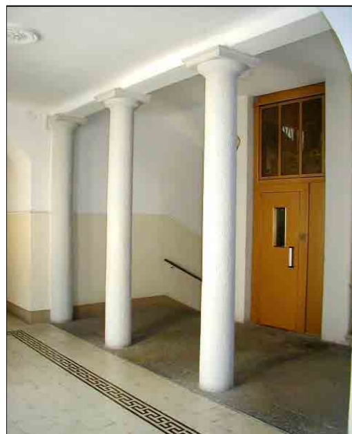
Particolare corridoio e ascensore
