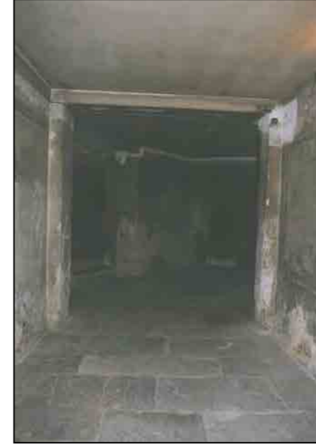
Atrio d'ingresso (alla data del rilievo)
