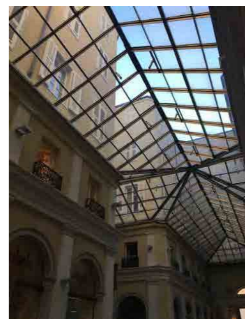
Particolare della galleria
