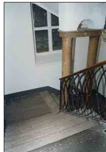
Particolare pianerottolo di giroscala in lastre di pietra
