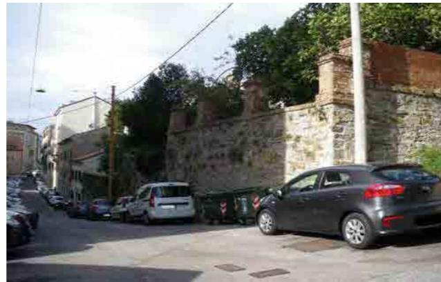
muro di contenimento e di cinta in blocchi di pietra sommariamente squadrate e posti in opera a corsi regolari con sopraelevazione in laterizio.
