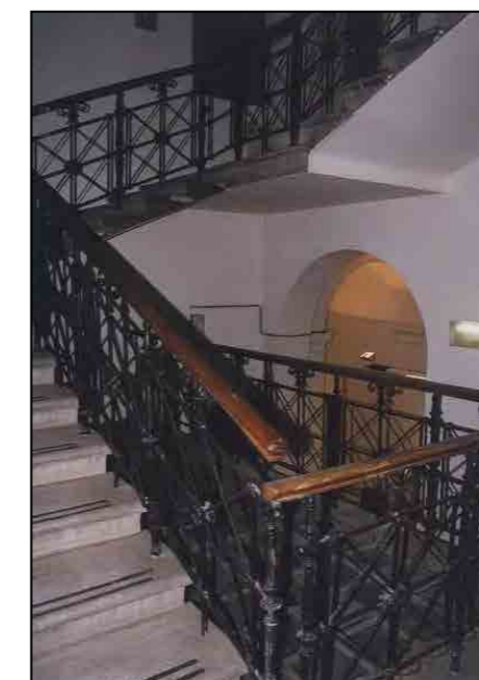
il vano scala a destra dell'ingresso
