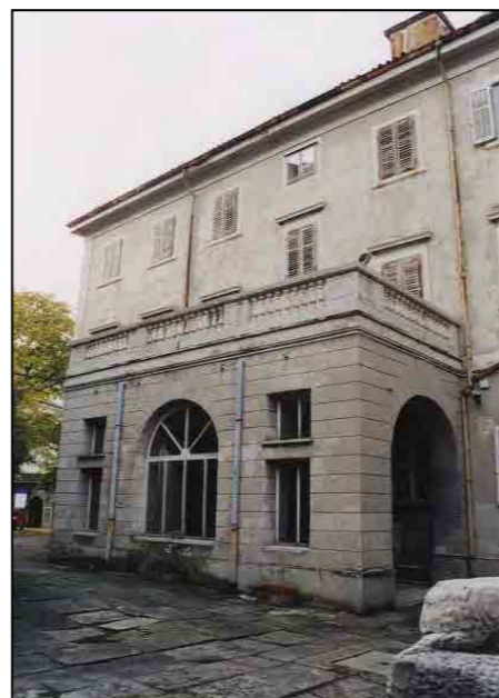
particolare facciata postica
