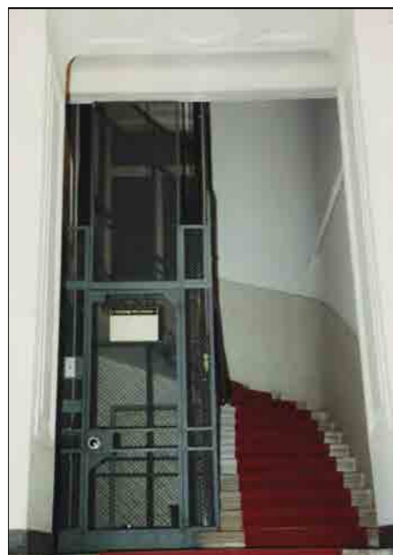
Corpo scala, di tipo anulare, mistilineo, con scalini in pietra
