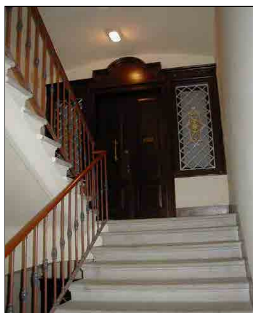
Particolare primo corpo scala
