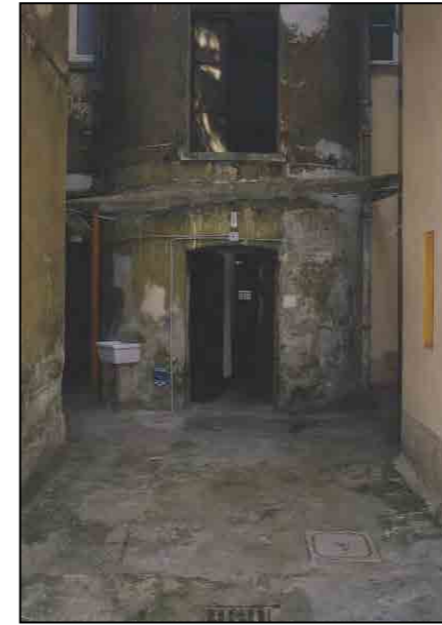
via Madonna del Mare 19 - facciata postica con pianerottolo del corpo scala aggettante e semicircolare (immagine alla data del rilievo)
