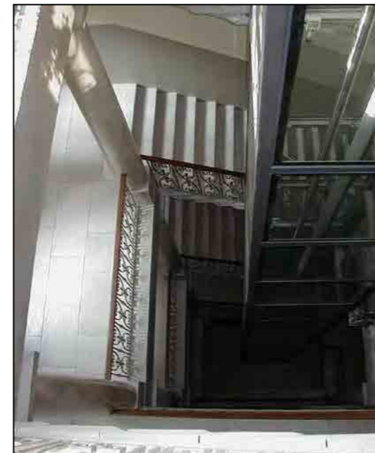
Particolare vuoto interno al corpo scala
