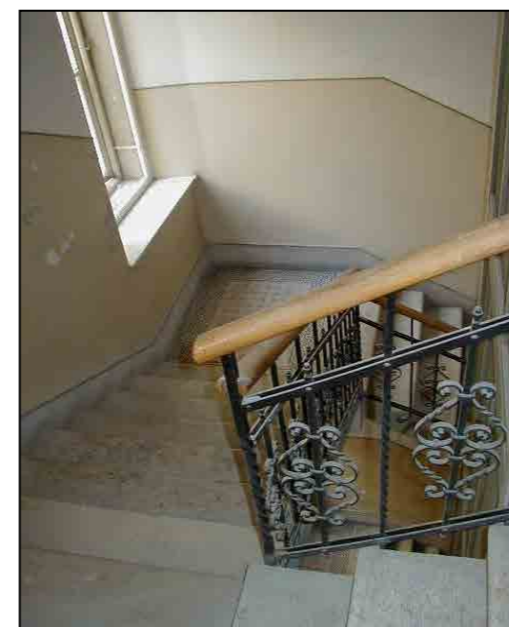
Particolare del corpo scala
