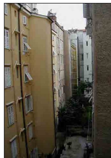
vuoto di risulta tra an. 188 ed an. 192
