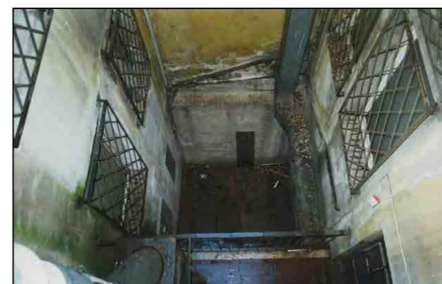
spazi interni di via Donota 2 - 4
