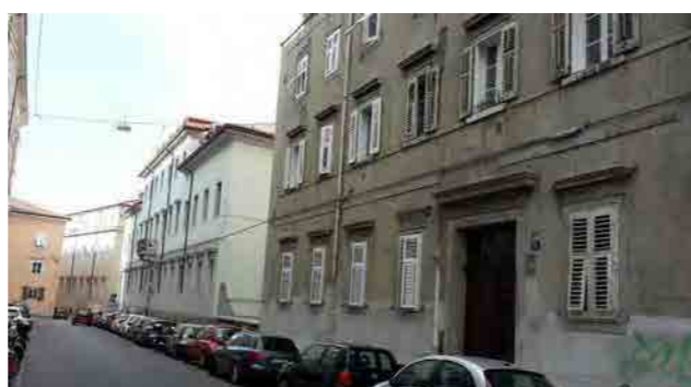
muro in corrispondenza dell'androne - via dell'Università 13
