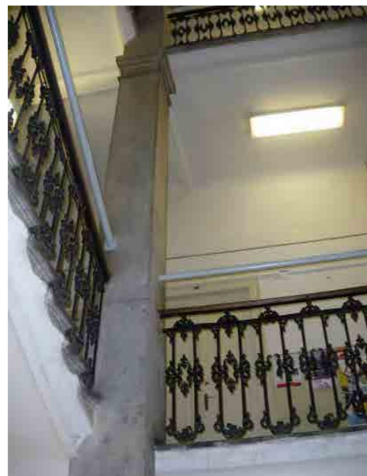
scala B a tre rampe ortogonali
