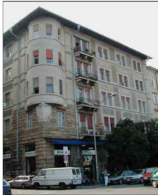
Prospetto su riva Grumula
