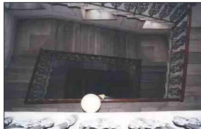
Vano scala (fotografia alla data del rilievo)
