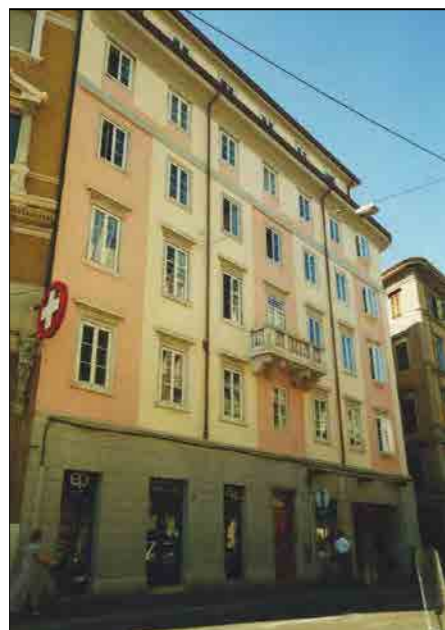
Facciata su corso Italia
