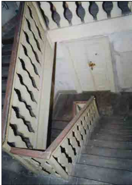
Vano scale in legno
