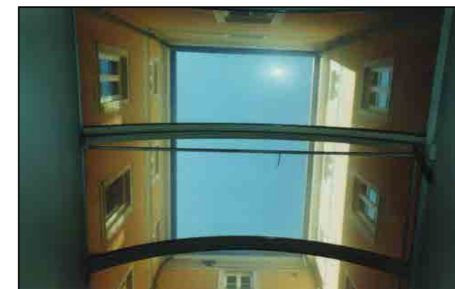
Particolare della copertura della galleria
