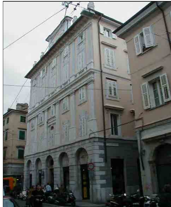
Prospetto principale su via di Cavana
