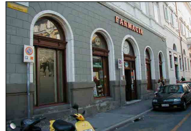
Particolare dei serramenti del piano terra
