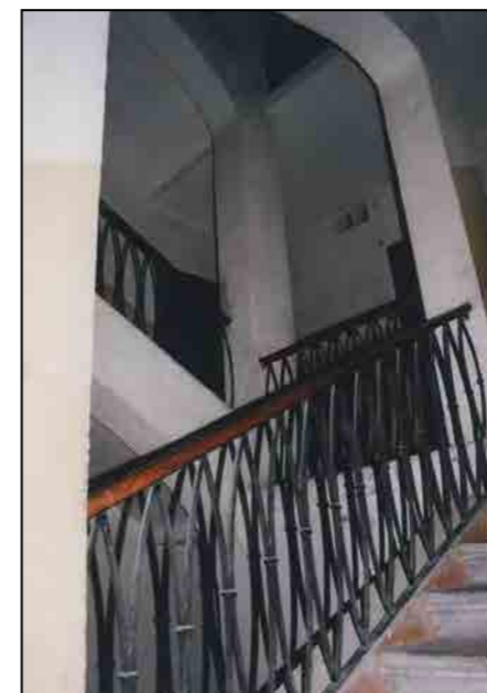
Vano scala a tre rampe ortogonali
