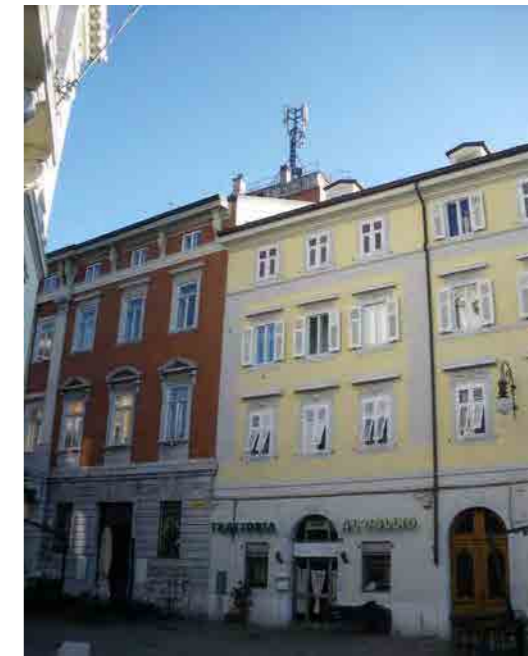
Particolare della copertura
