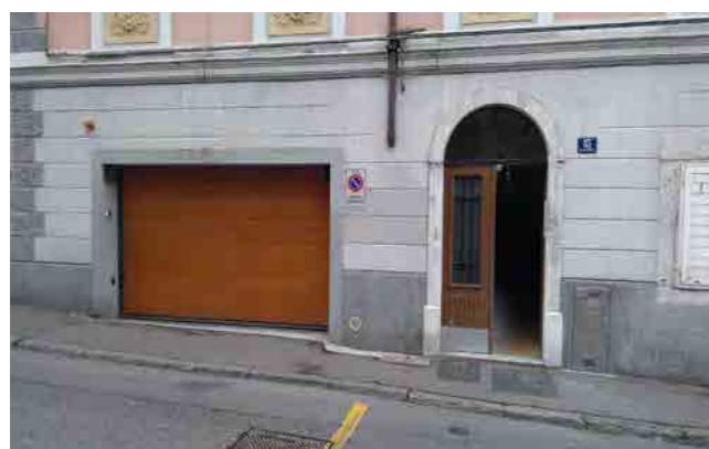
alterazione di forometrie al piano terra
