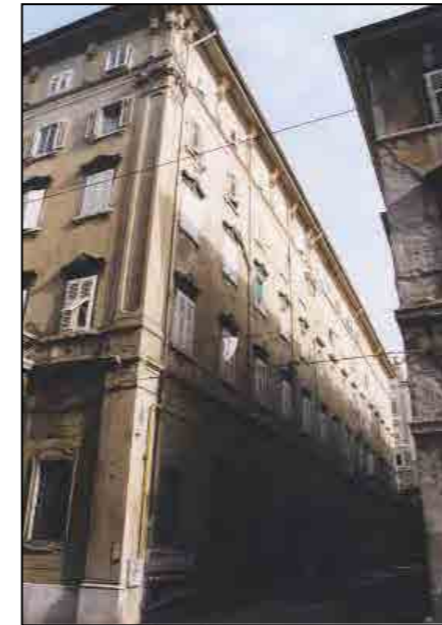
Facciata su androna privata
