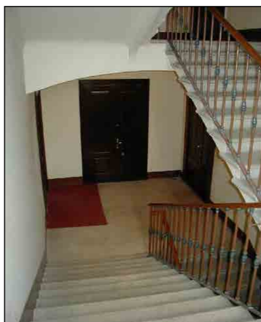
Particolare secondo corpo scala
