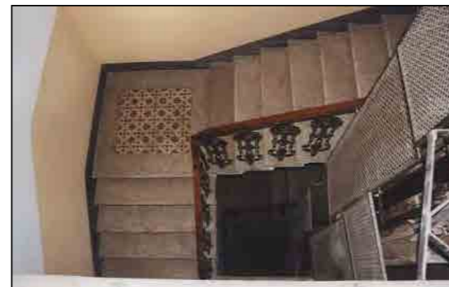
Particolare corpo scala
