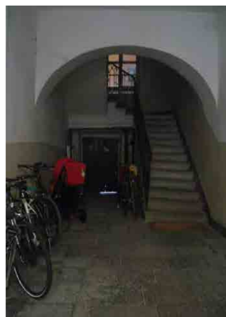
via del Bastione 3 - atrio e corpo scala
