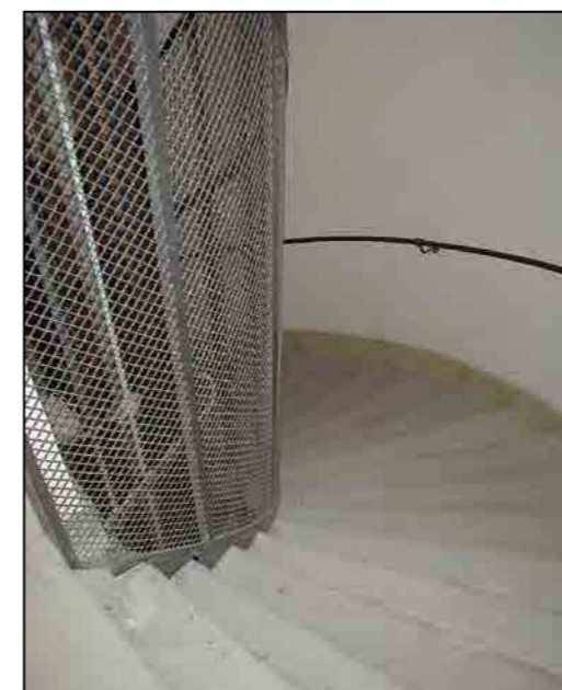
Particolare del corpo scala
