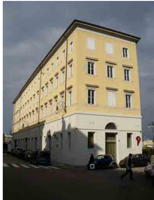
Facciate su via G. e D. Economo e Riva Grumula
