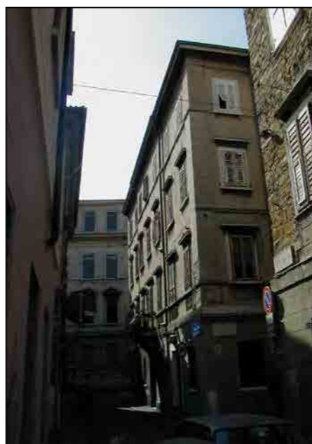
via del Bastione 3 / via F. Venezian 17
