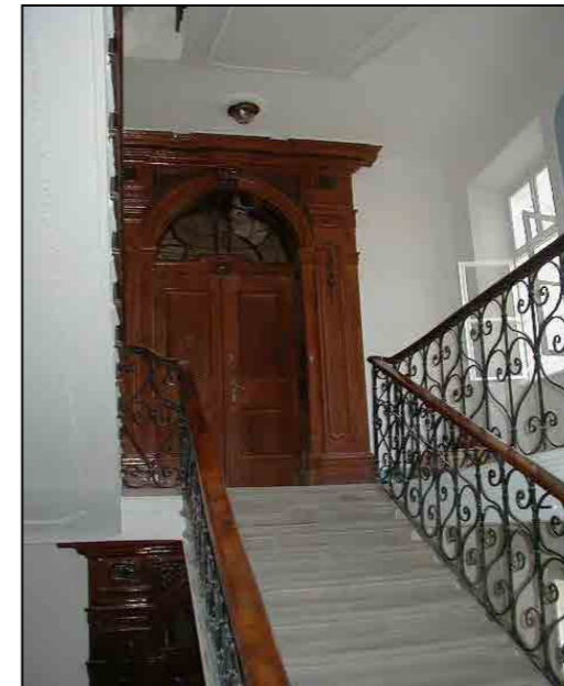
Particolare del corpo scala
