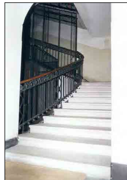
via L. Cadorna 3 - vano scala
