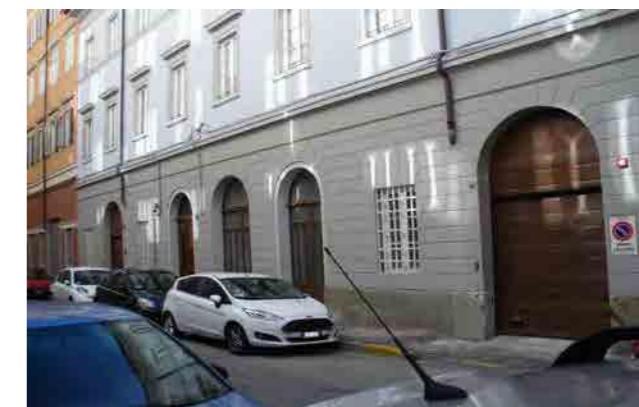
via dei Fabbri 10 - particolare del piano terra
