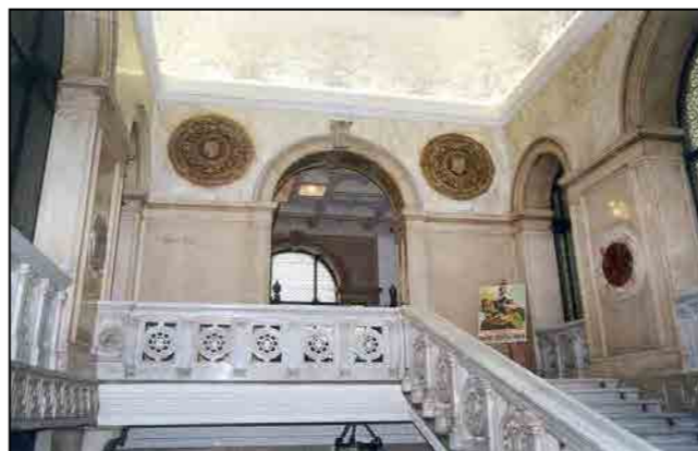
particolare dello scalone che conduce agli uffici della direzione
