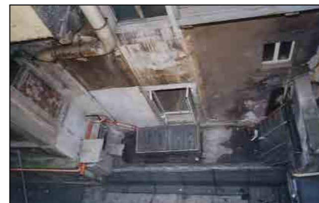
Lo stato della corte interna
