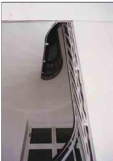
Vano scala secondario
