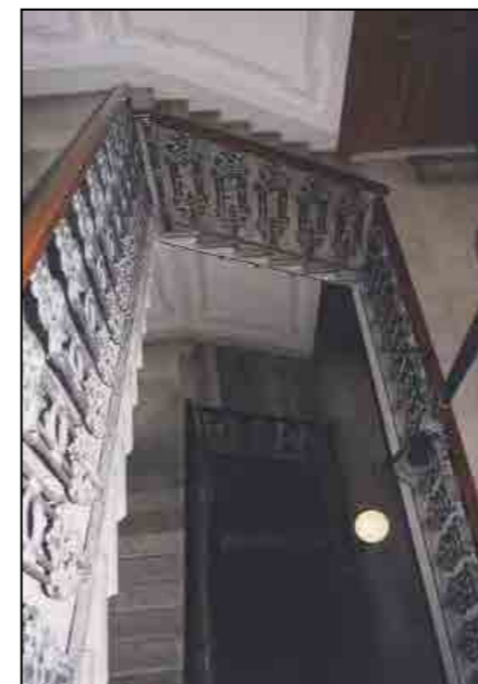
Vano scala (fotografia alla data del rilievo)
