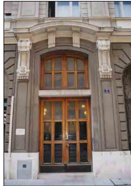
Portone d'ingresso via San Nicolò 7
