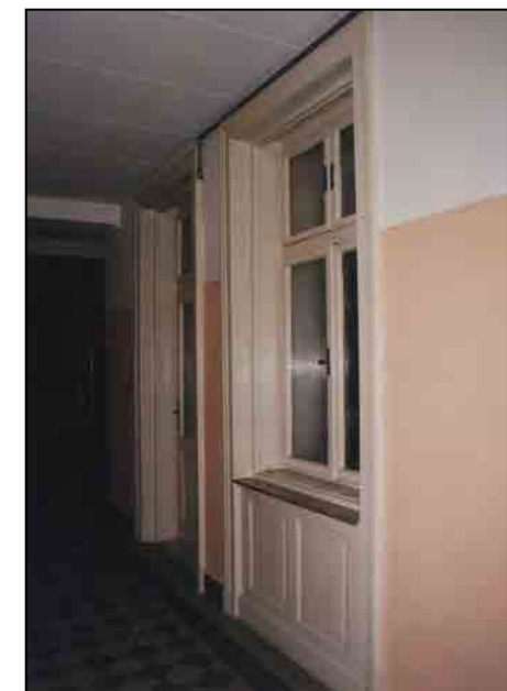
Accesso ai balconi nella corte
