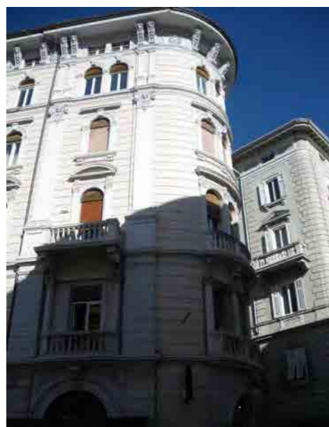
particore della facciata via D. Economo 1
