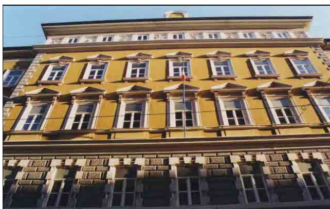
particolare facciata via Diaz
