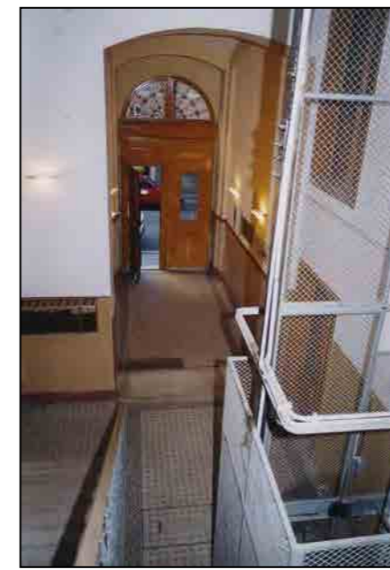
Via S. Lazzaro 3 ingresso
