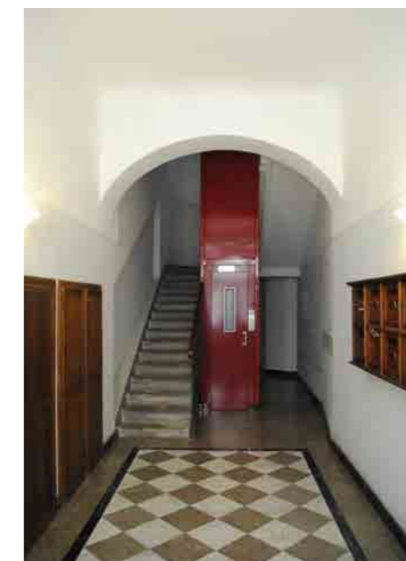
Vano scala e ascensore
