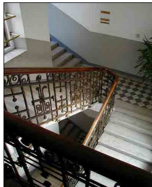
Particolare del corpo scala
