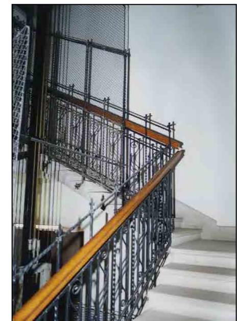
via Santa Caterina 3 - vano scala
