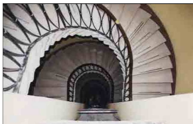
Particolare - scala (vista dall'alto)
