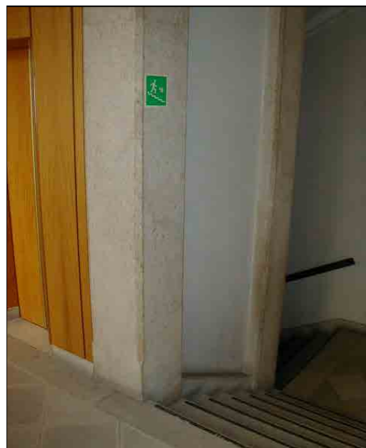
Particolare del corpo scala dell'anagrafico 64
