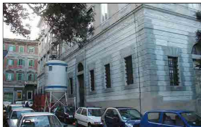
particolare facciata al pianoterra
