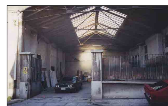
androne Campo Marzio 8 - particolare della tettoia. Immagine dell'anno 2000
