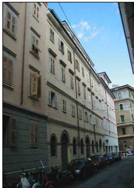
via dei Fabbri 3
