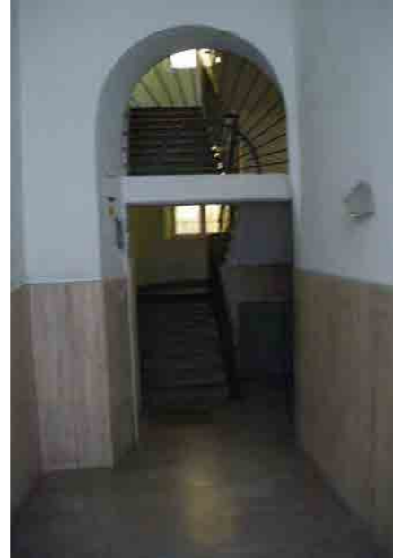
via della Cereria 13 - corpo scala
