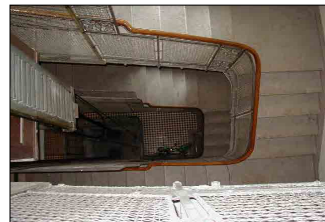
Particolare del corpo scala
