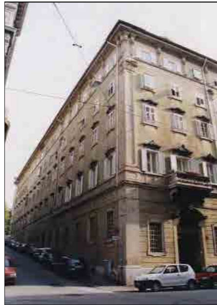
Facciata su via Belpoggio
