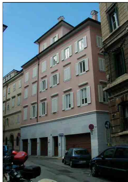
via dei Fabbri 1
