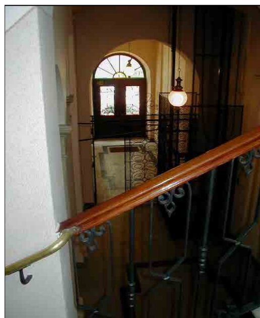
Atrio d'ingresso via del Lazzaretto Vecchio 13 visto dall'alto
