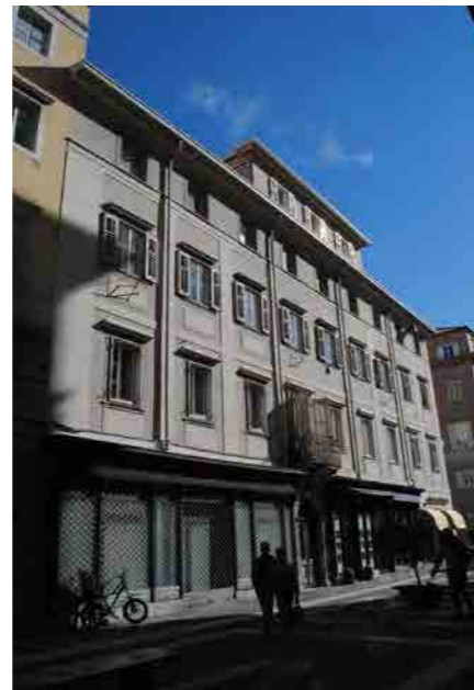
Particolare facciata su via San Nicolò
