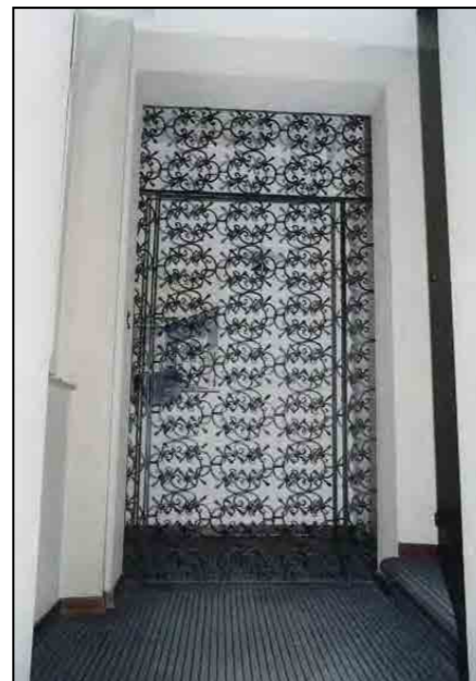
corso Italia 21, interno pianerottoli Tutte le rampe delle scale in pietra sono state rivestite di moquette, come pure la pavimentazione dei ballatoi della corte interna. Questi ultimi sono stati chiusi con serramenti in vetro e pvc
