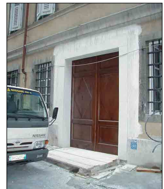
Portone d'ingresso su via Santi Martiri
