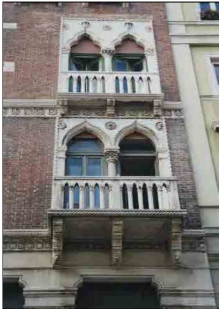
Particolare di una bifora in facciata
