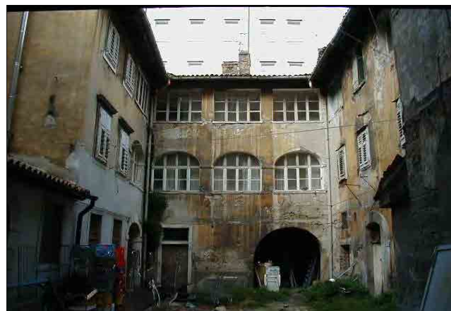
Cortile interno (fotografia alla data del rilievo)
