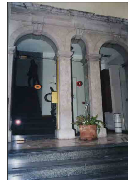
corso Italia 21, corte interna - ingresso edificio All'edificio si accede attraverso la corte, rimaneggiata impiegando materiali incoerenti con le caratteristiche tipologico-costruttive del manufatto
