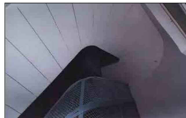
Particolare del corpo scala
