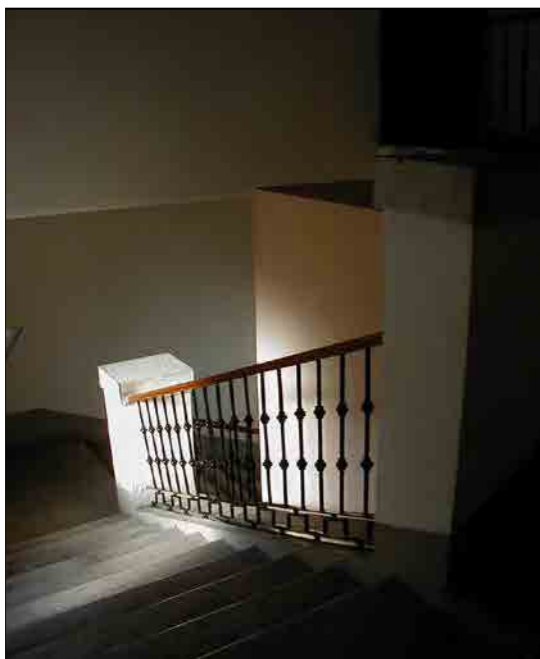
Particolare del corpo scala
