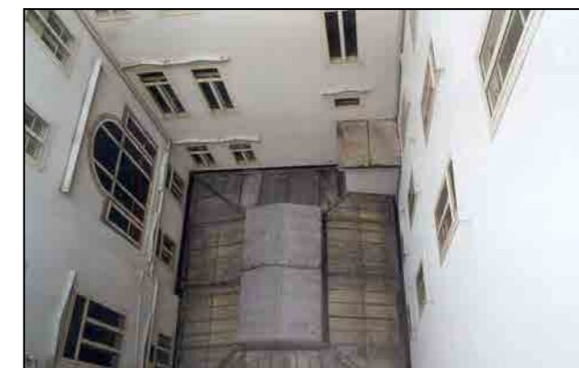
la corte in corrispondenza dello scalone, con la copertura a lucernaio che la illumina
