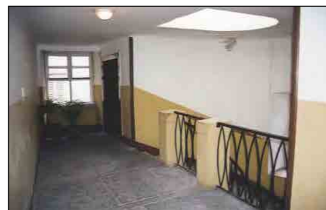
Particolare - pianerottolo dell'ultimo piano e lucernaio
