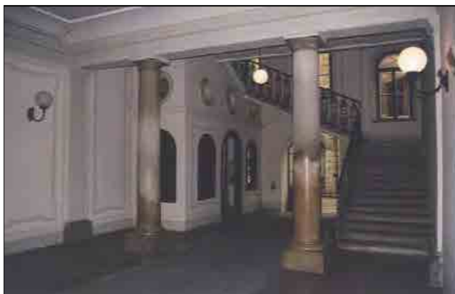
Atrio d'ingresso (fotografia alla data del rilievo)
