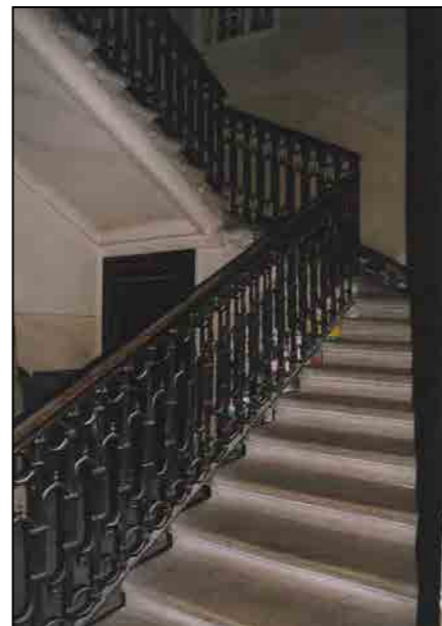
Ampio corpo scala a tre rampe ortogonali (prima del risanamento)
