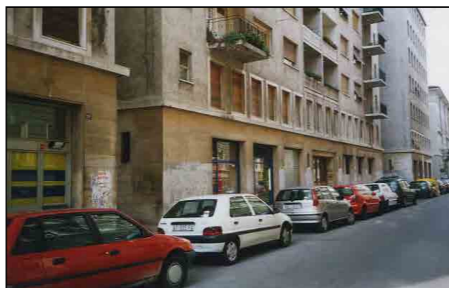
via A. Diaz particolare facciata
