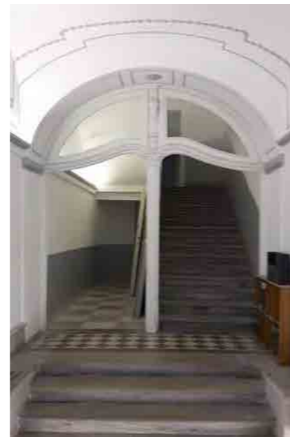
via Mazzini 21 - atrio e corpo scala
