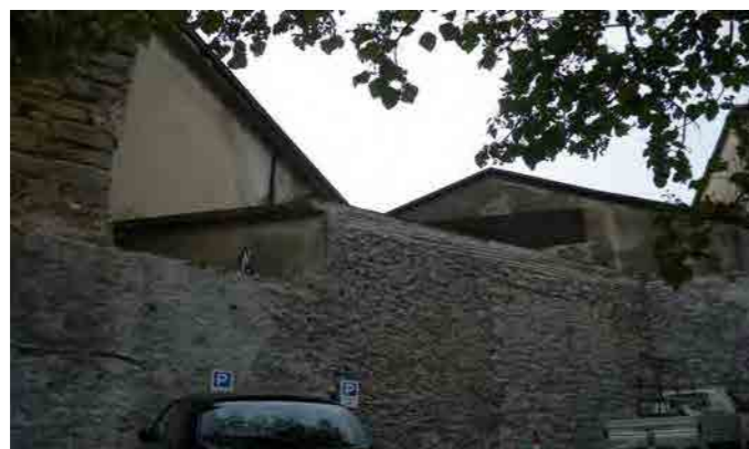
particolare del lato postico in via Economo dell'anagrafico 120
