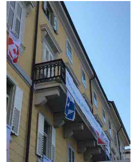
Particolare di facciata su riva N. Sauro
