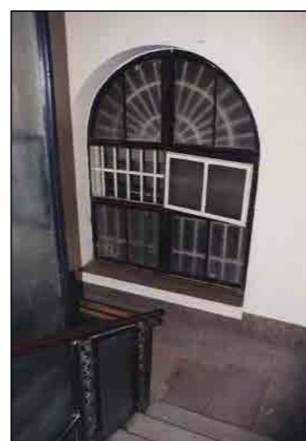
Particolare del corpo scala
