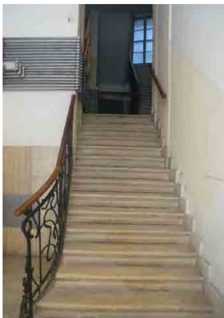
via dei Crociferi 5 - prima rampa del corpo scala
