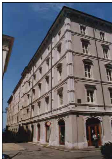
Prospetto laterale su via dell'Arsenale
