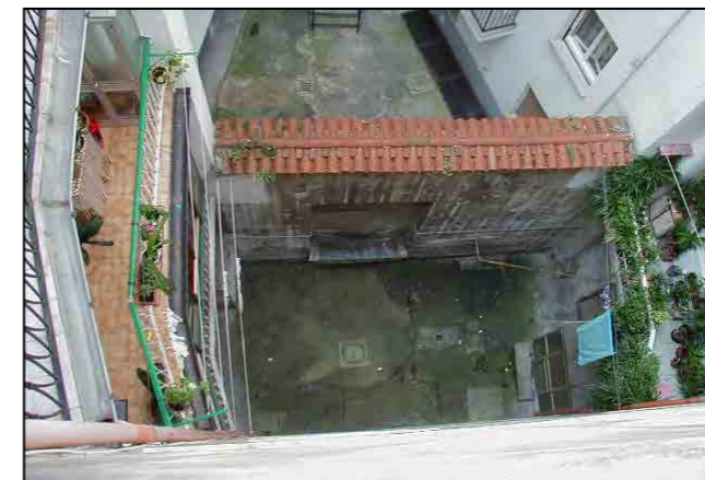
Cortile a confine con l'edificio an. 214
