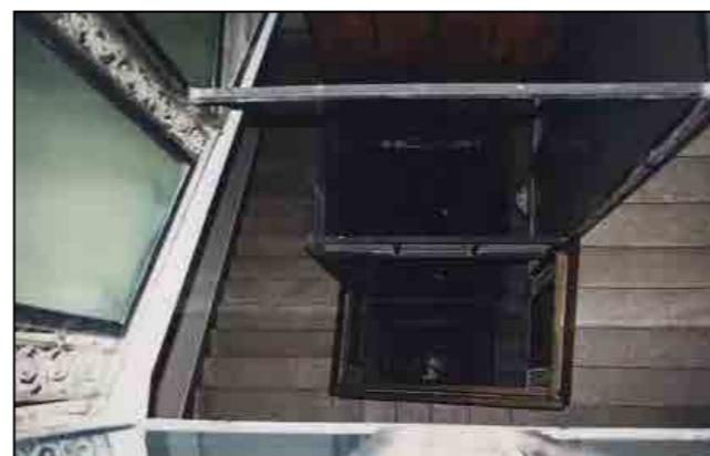
Particolare del corpo scala
