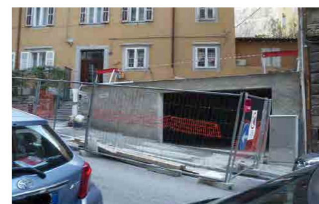
via G. Stampa 7 - box auto pertinenziale in fase realizzativa (immagine gennaio 2019)
