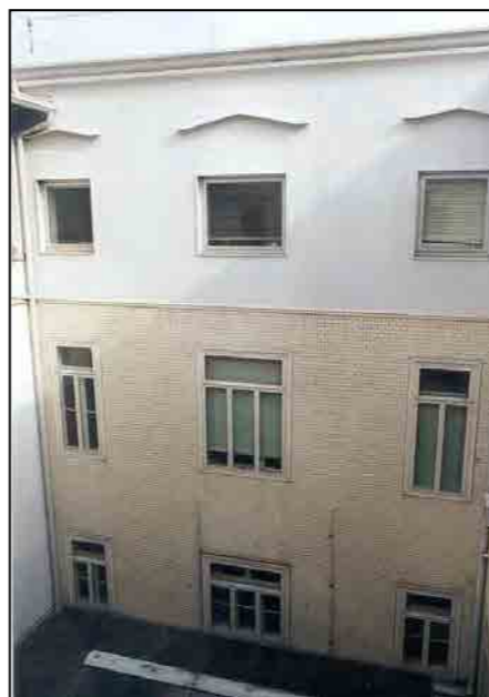
particolare della facciata prospiciente la seconda corte
