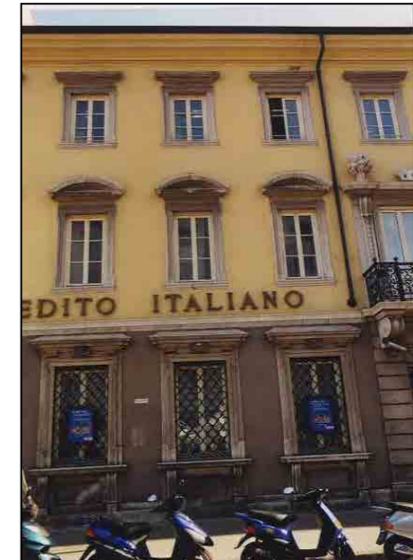
Particolare della facciata principale
