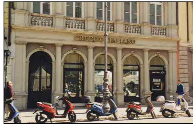
Particolare della sistemazione del piano terra
