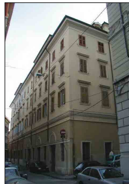
via dei Fabbri 4
