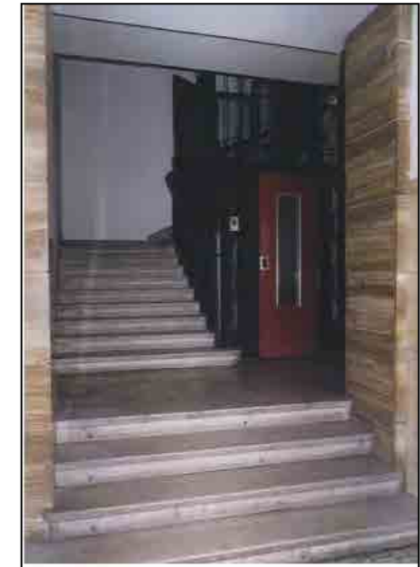
via Santa Caterina 1 - vano scala
