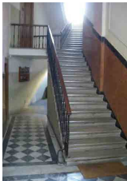
via della Galleria 8 - atrio e corpo scala
