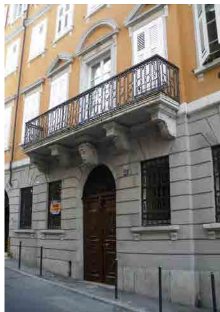
Prospetto su via Venezian 23
