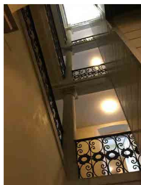
Particolare del corpo scala
