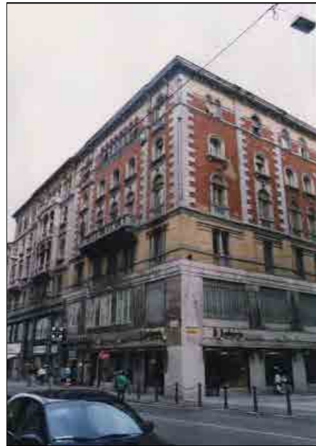
Prospetto su corso Italia
