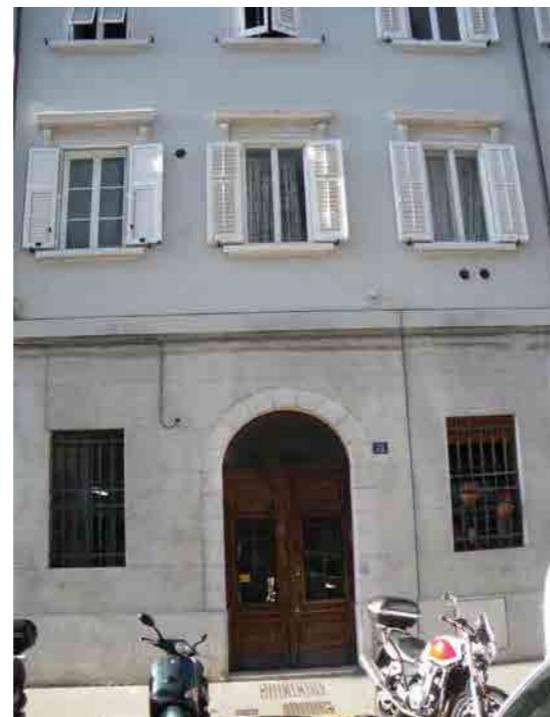
Particolare - serramenti esterni
