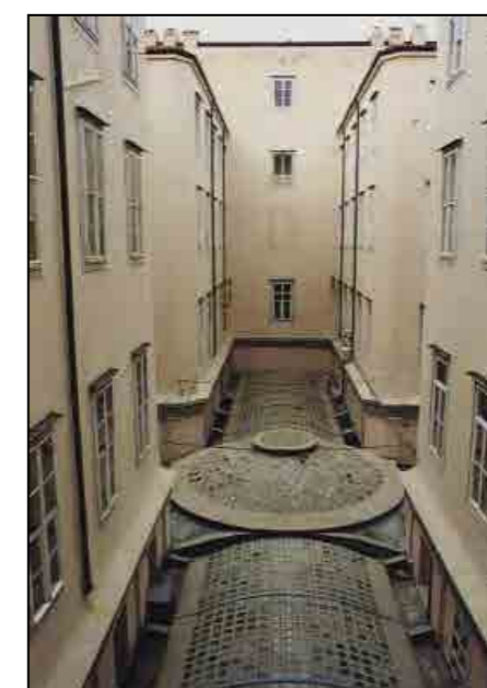
Copertura della galleria vista dalla corte (originale)
