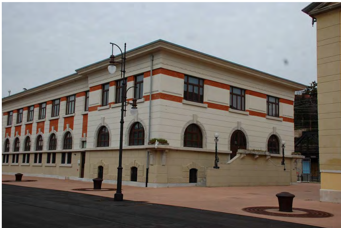
La Sottostazione Elettrica.
