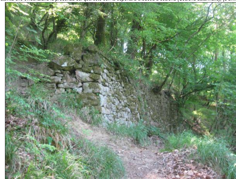
Esempio di muretto a secco di sostegno di un piccolo pastino, con presenza di piante di quercia
