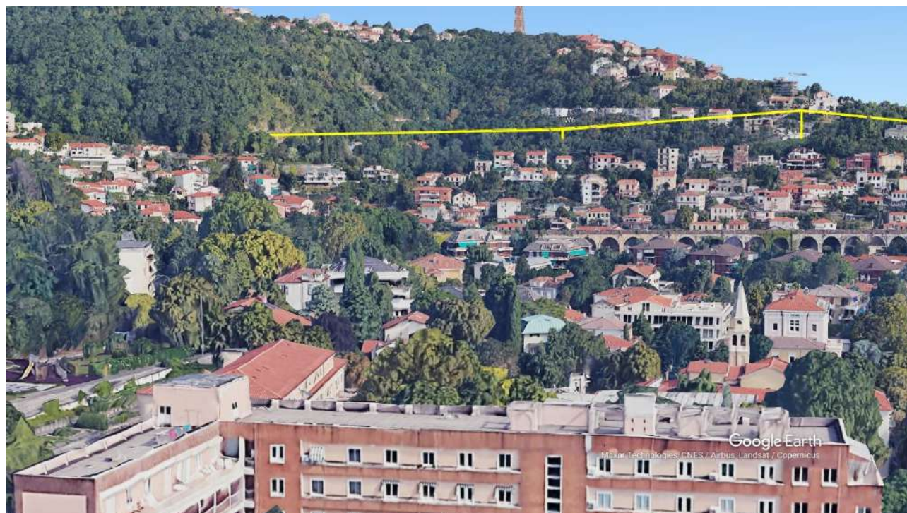
Attraversamento valle del Rio Giuliani, vista da Ovest
