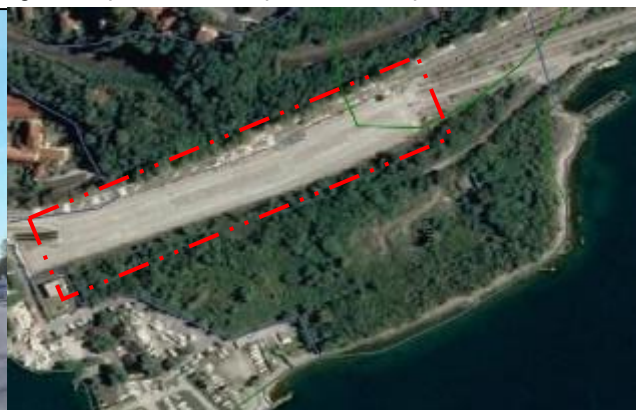
Ortofoto dello stato dei luoghi (area parcheggio)
