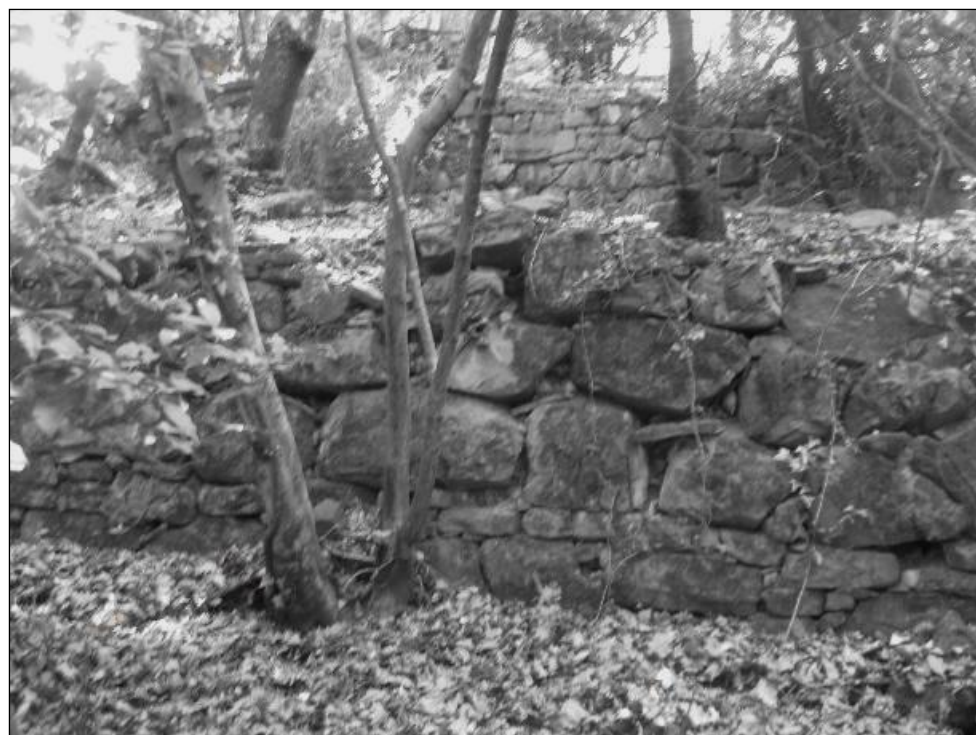
Esempio di muretti a secco dei terrazzamenti, con presenza di piante di quercia, frassino e ciliegi
