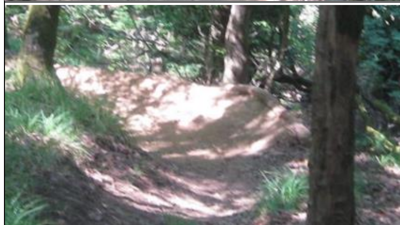
Esempi di sistemazione delle curve mediante tronchi e fascine nei sentieri utilizzati come piste ciclabili
