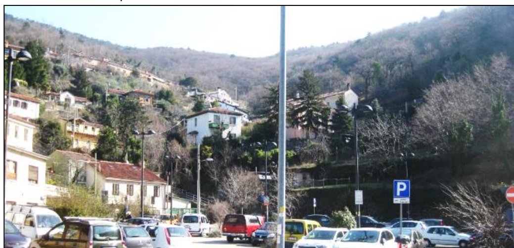
Area a parcheggio sotto la quale è stato intubato il Rio Bovedo nei pressi dell'abitato di Bovedo
