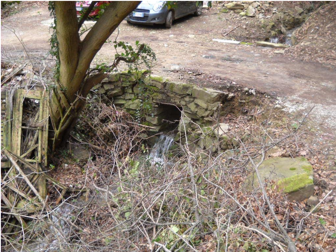
Tavola 44. Opera di canalizzazione in arenaria alla fine della Via Pertsch.
