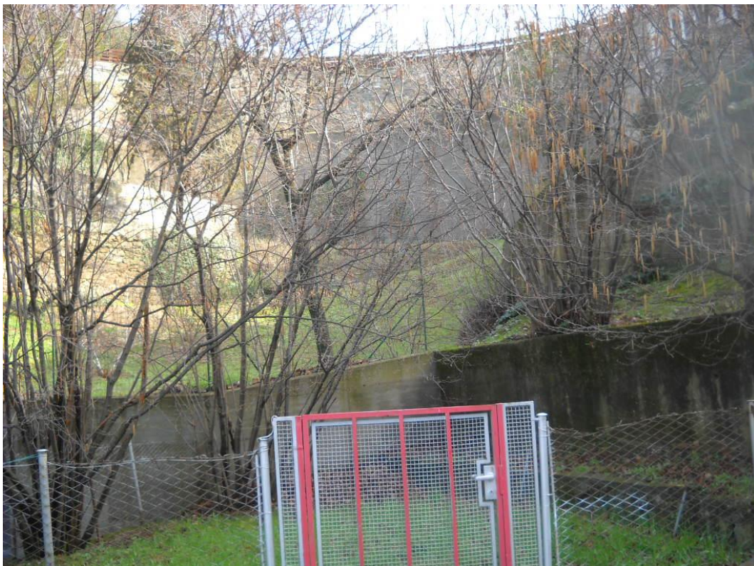
Tavola 41. Il paramento "diga" di sostegno della Strada del Friuli .
