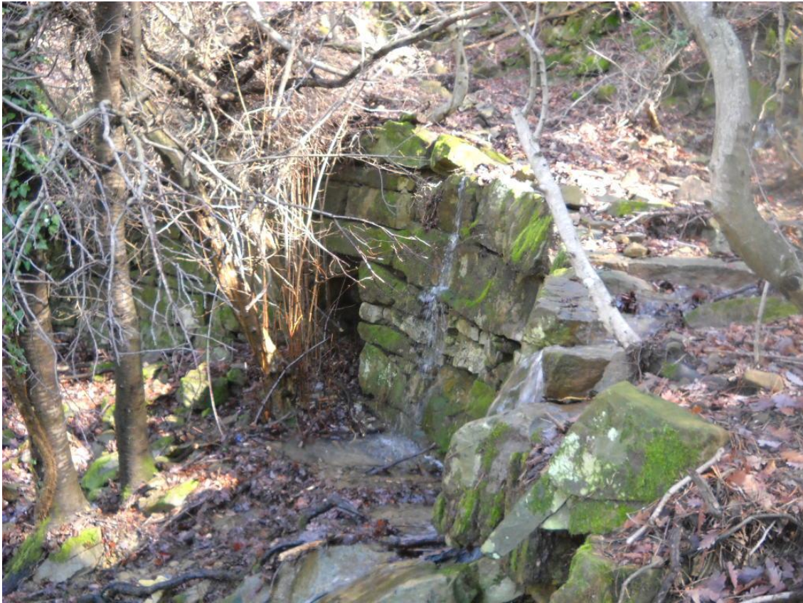
Tavola 42. Opera di regimazione idraulica e di contemporaneo attraversamento in alveo.
