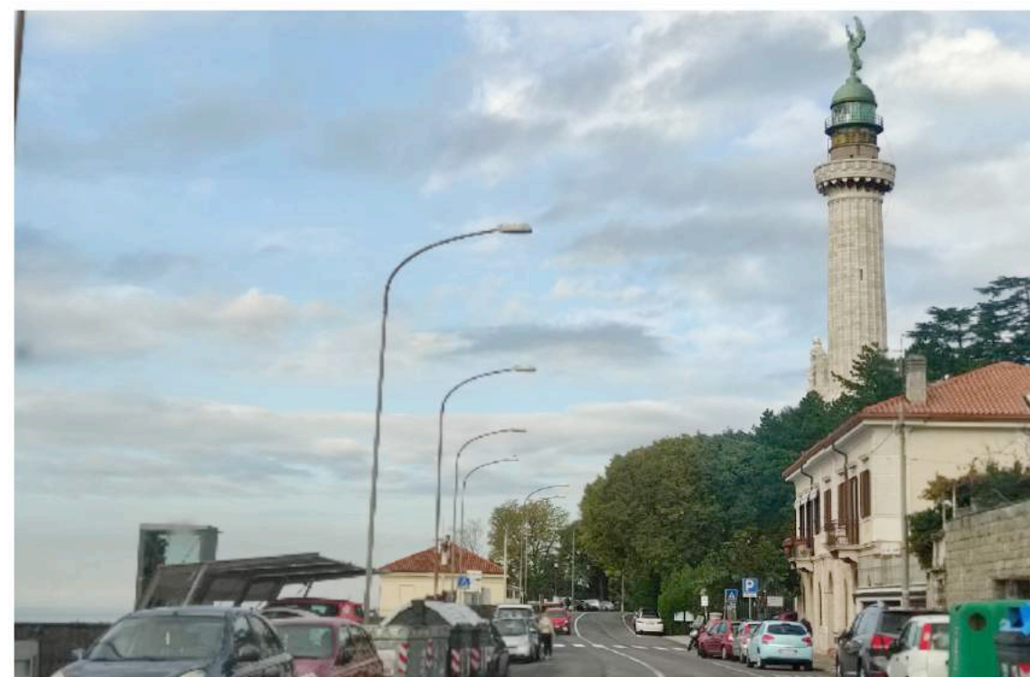
6. Vista da Strada del Friuli – stato attuale
