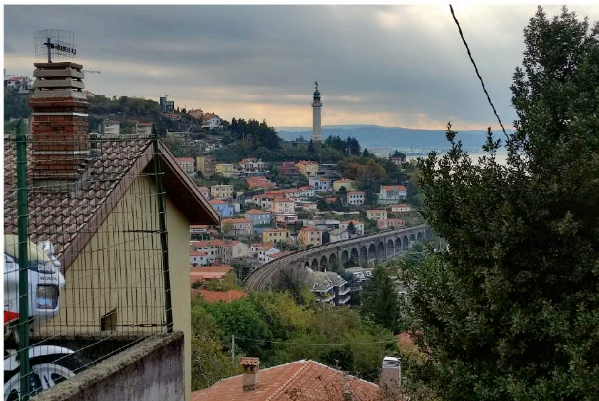
7. Vista da Strada del Friuli – stato attuale
