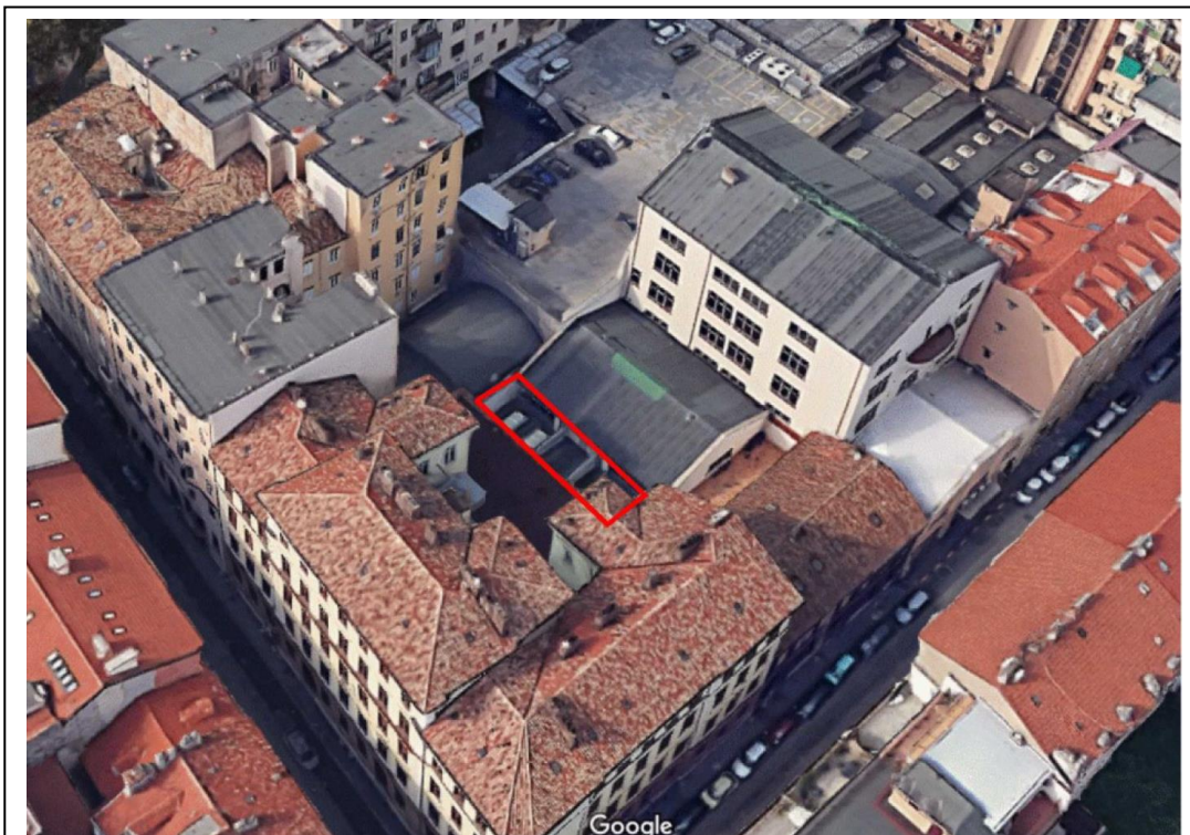
Figura 3.6 b – via San Francesco Indicazione stato di fatto (fonte Google maps)
