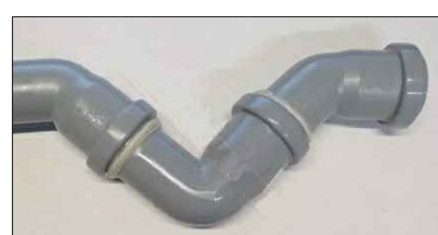
PARTICOLARE ALLACCIO UNITA' INTERNA ALLA RETE DI SCARICO CONDENZA
