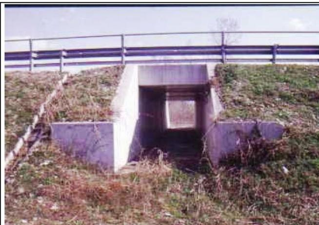
Foto 99 – Sottopasso scatolare per fauna minore (Collegamento Cimpello – Sequals – PN – Foto G. Sauli)
