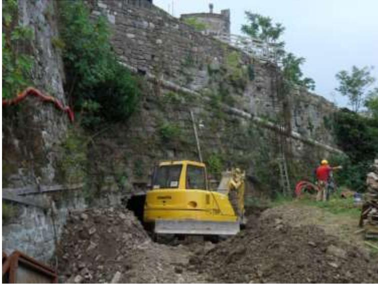
**Figura 12 – Pozzetto geognostico**
